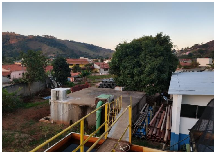
Figura 14 – Pátio da ETA passou por limpeza.
