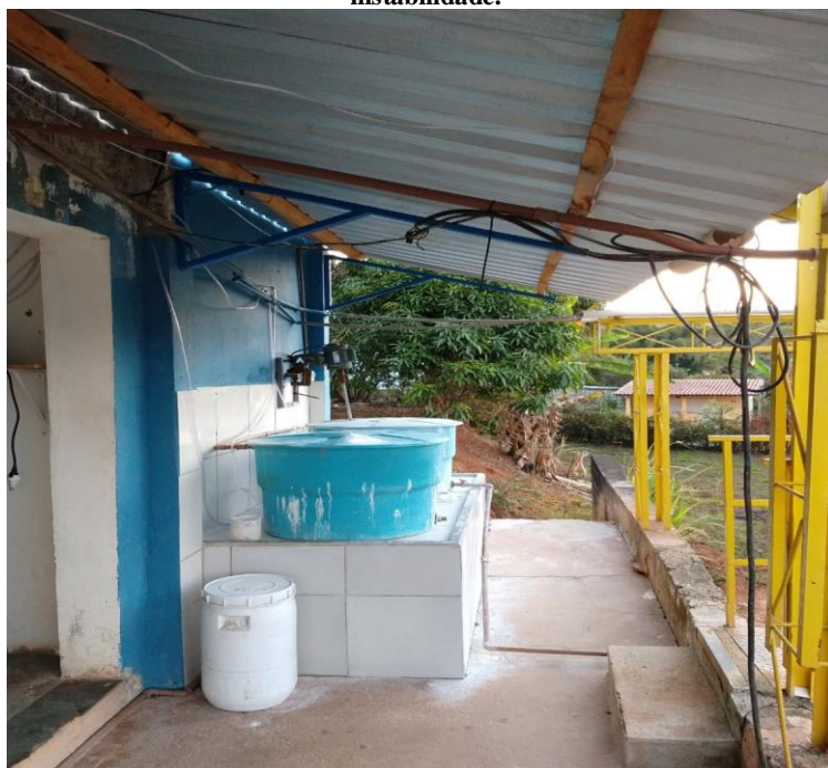
Figura 15 - Hipoclorito de cálcio em um local ao abrigo de luz solar, devido a sua instabilidade.
