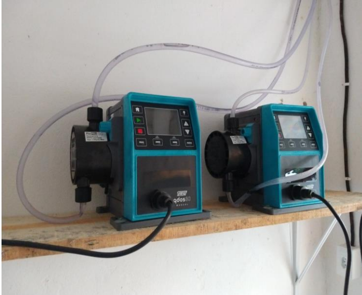
Figura 16 – Bombas Dosadoras adquiridas pelo prestador
