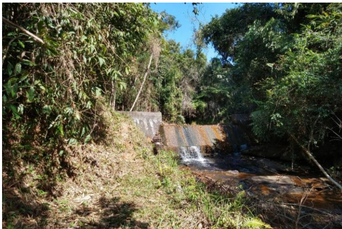
Figura 2 – Barragem na captação do Córrego Samambaia
