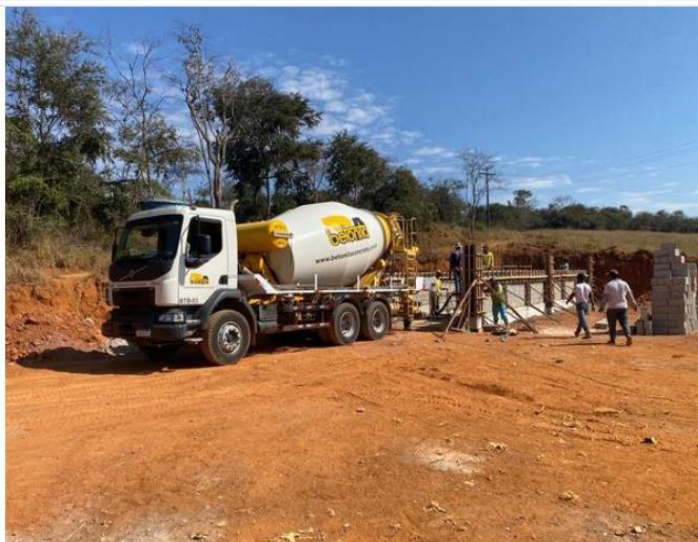
Construção do abrigo para containers
