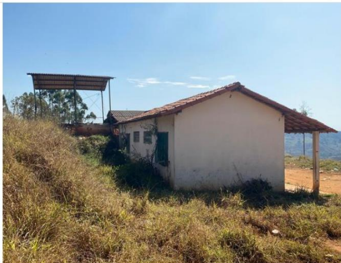
Antiga UTC, mesma local da construção do transbordo
