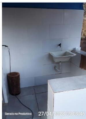
Abrigo do operador da EEAB - Externo
