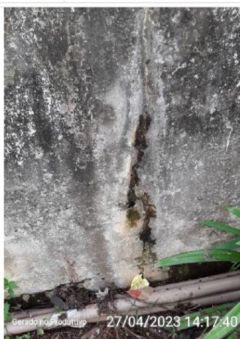
Pontos de infiltração
