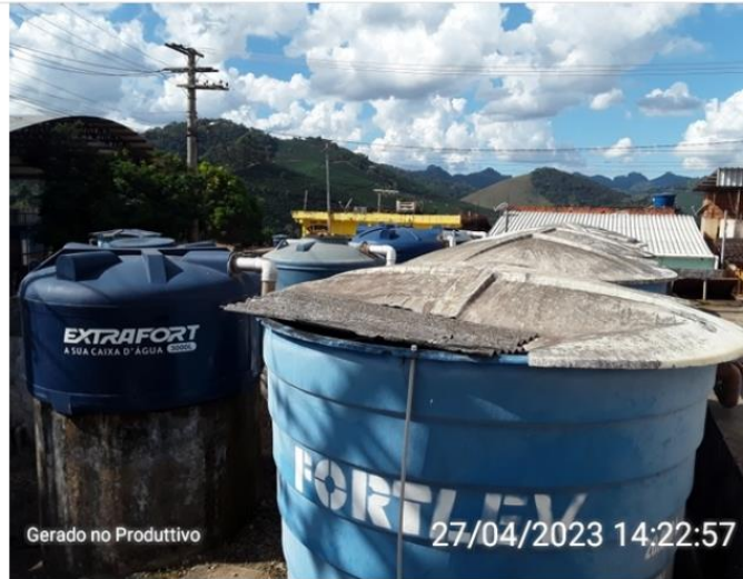
Filtros da ETA Penha
