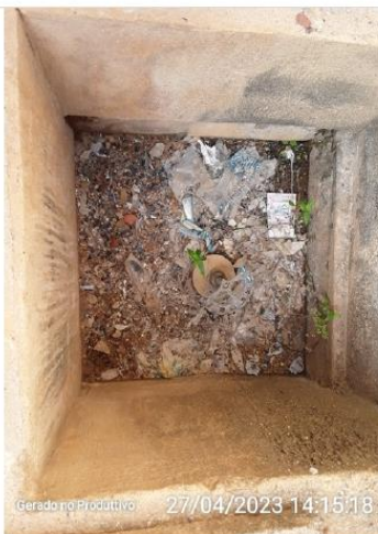
Válvula de saída - Bairro Penha
