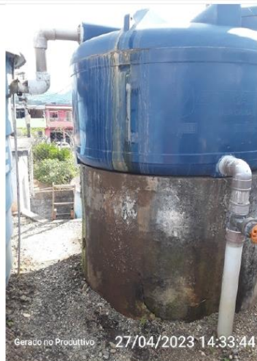
Vazamento aparente
