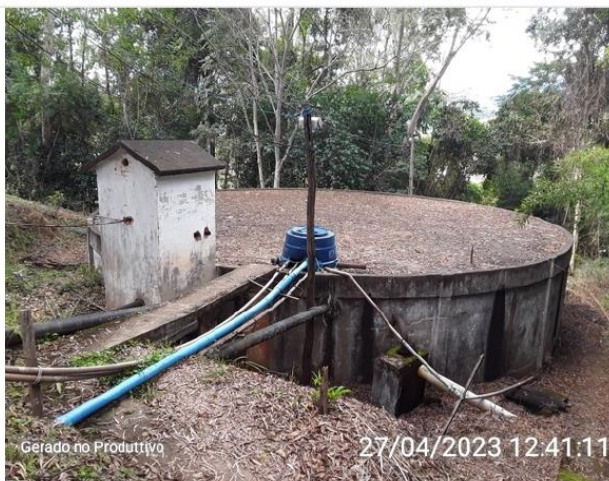
Reservatório ETA Madre Beatriz
