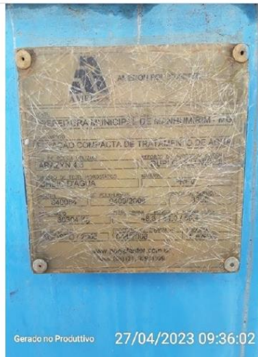
Placa de dados de projeto da ETA (informa vazão máxima de 59,4 l/s)
