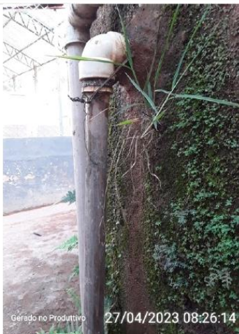
Entrada de água no reservatório
