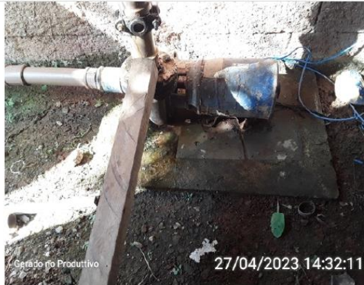
Piso da EEAT
