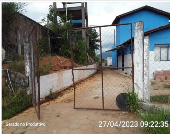
Fechamento da ETA
