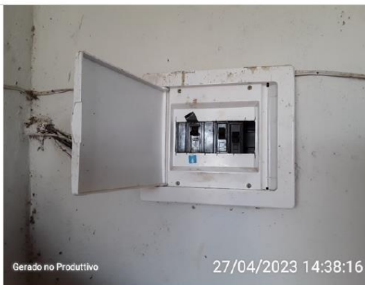
Chaves das bombas
