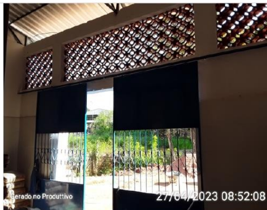
Vãos de ventilação natural
