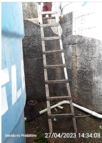
Escada de acesso a área do reservatório
