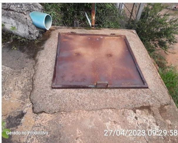
Tampa de inspeção
