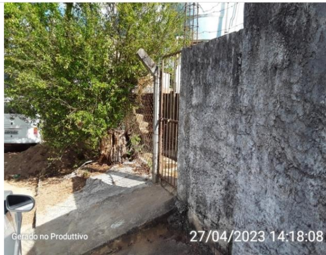
Cercamento em muro
