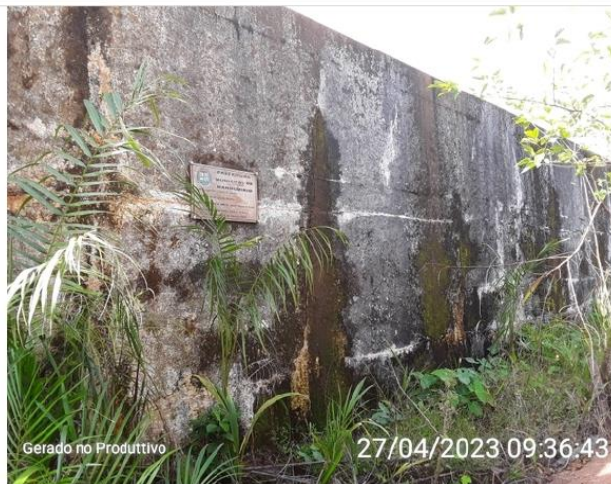
Pontos de infiltração
