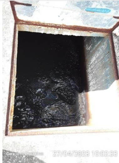
Tanque de contato - Acesso
