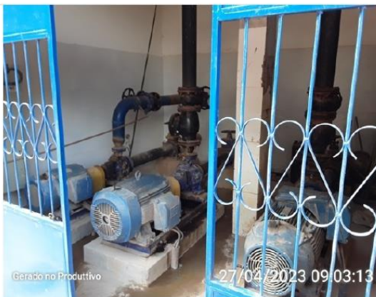
Acesso à EEAB
