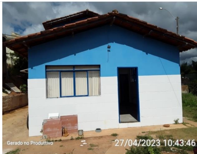
Anexos da ETA
