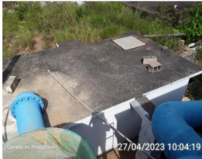
Tanque de contato - Cobertura
