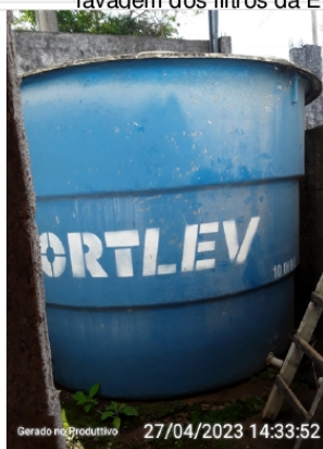
Reservatório de lavagem dos filtros
