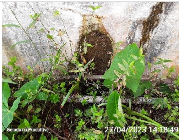
Pontos de infiltração
