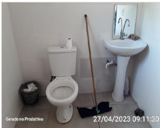
Abrigo do operador da EEAB - Interno
