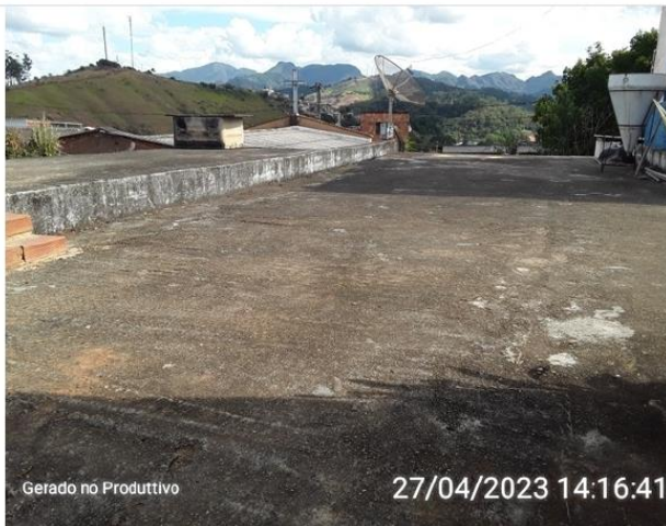
Cobertura do reservatório
