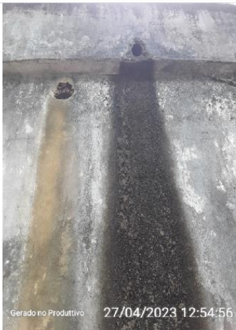
Drenagem da cobertura
