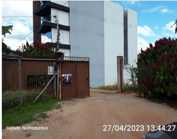
Portão de acesso ao reservatório/ETA
