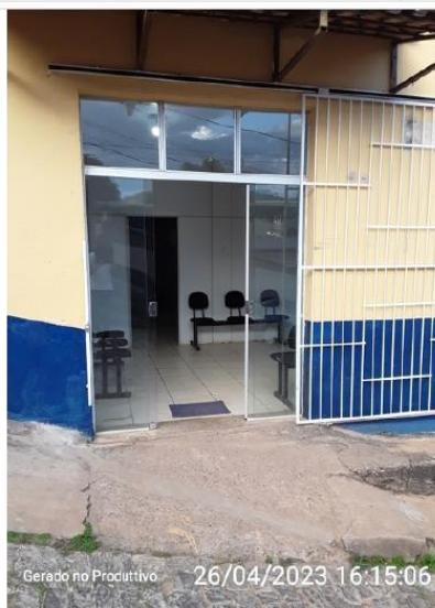
Rampa de acesso
