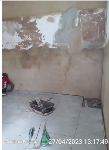
Reforma no anexo de apoio dos operadores da ETA
