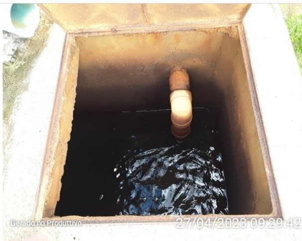
Tampa de inspeção
