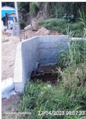
Barragem concluída - à montante do acesso
