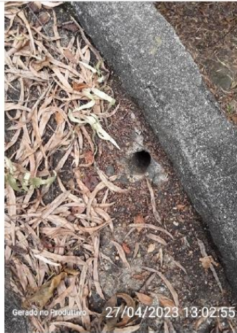
Drenagem na cobertura
