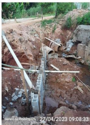
Barragem em construção - à jusante do acesso
