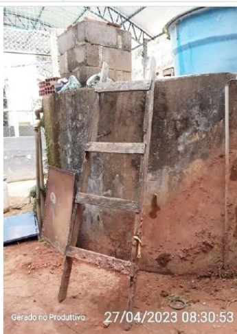
Escada de acesso
