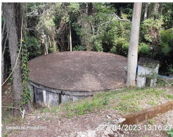
Reservatório ETA Madre Beatriz
