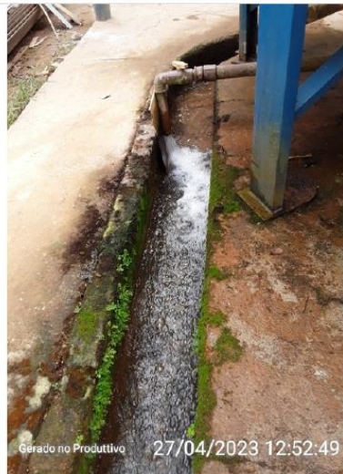
ETA operando acima da capacidade nominal
