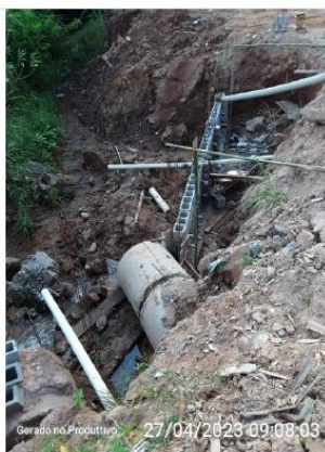
Barragem em construção - à jusante do acesso
