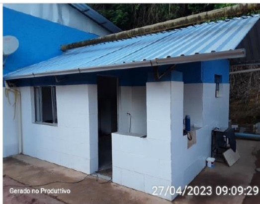
Abrigo do operador da EEAB - Externo
