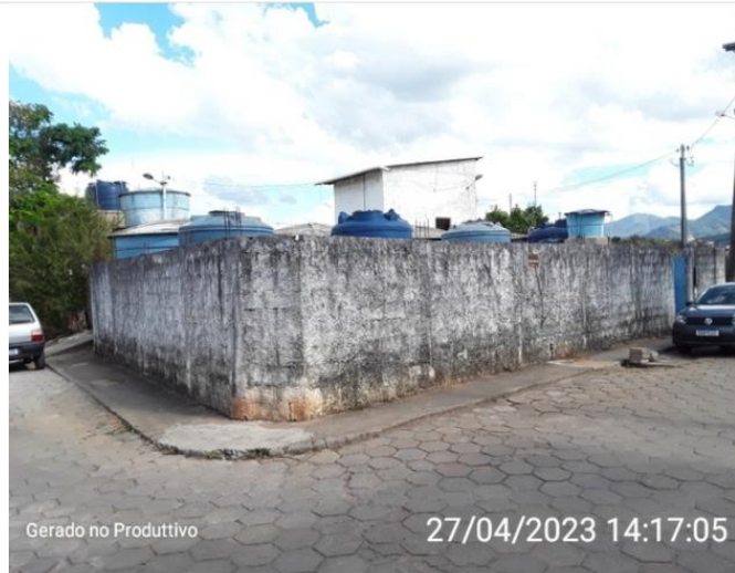
Área da ETA Penha
