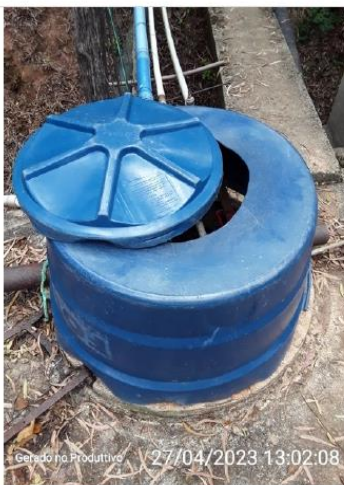
Tampa de inspeção
