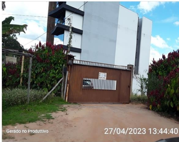
Portão de acesso ao reservatório/ETA
