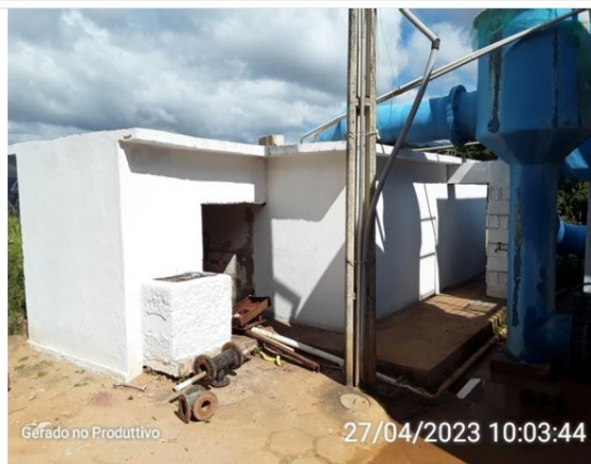
Tanque de contato - Externo
