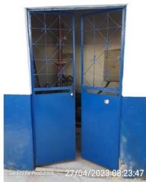
Fechamento da EEAT
