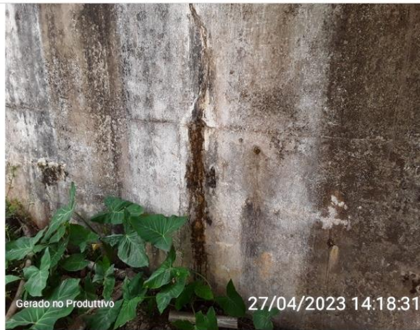
Pontos de infiltração
