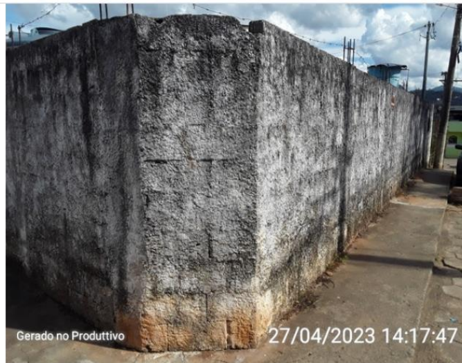
Cercamento em muro
