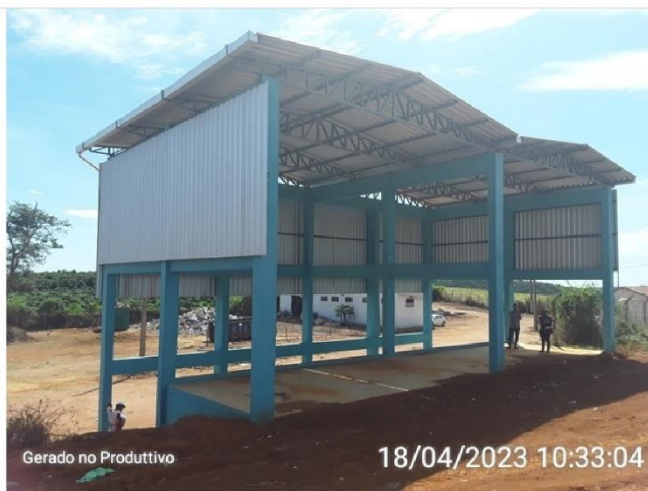
Vista lateral da área de transbordo
