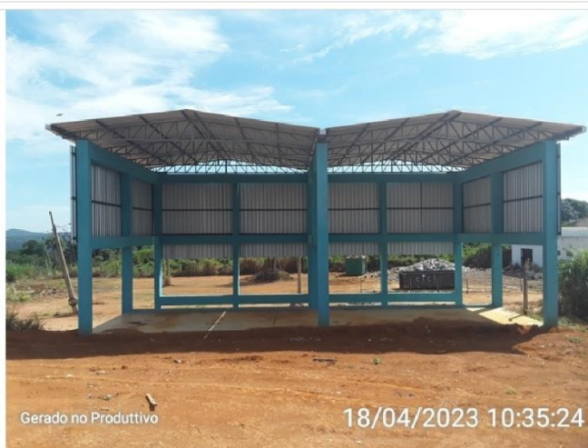
Nova estrutura de transbordo
