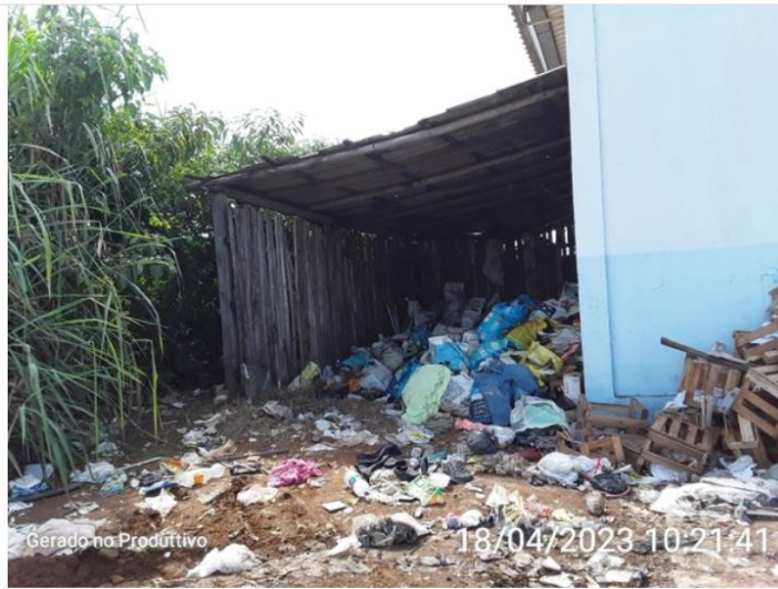
Acúmulo de resíduos nas parte externas da UTC
