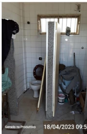
Banheiro em desuso
