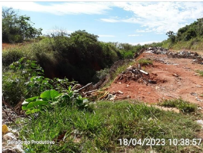
Vala do bota fora
