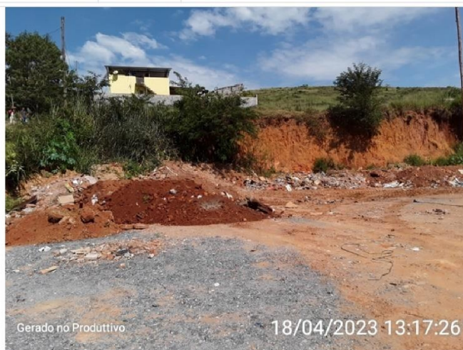
Depósito de resíduos de construção civil
