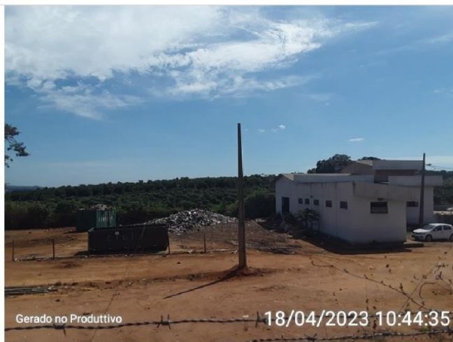
Vista panorâmica da área de transbordo
