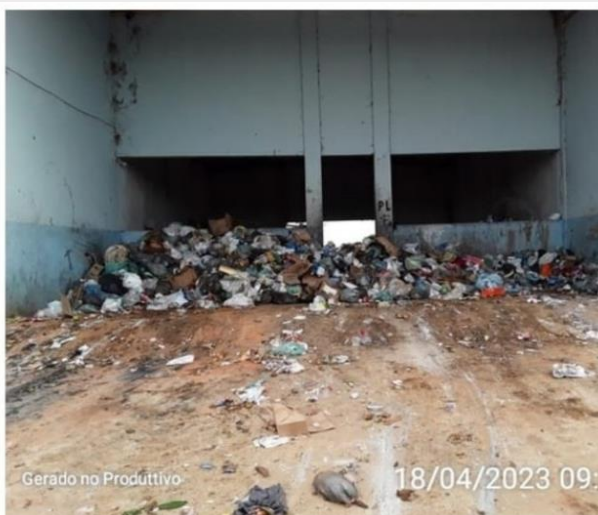
Piso de concreto
