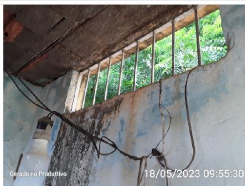
Abertura de iluminação e ventilação
