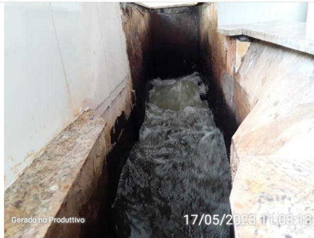
Entrada de água na Calha Parshall
