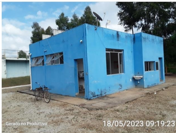
Anexo de apoio e laboratório
