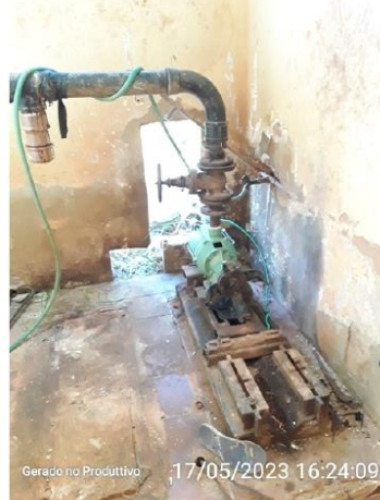
EEAT em manutenção
