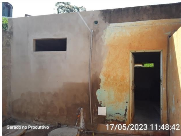
Casa de químicos
