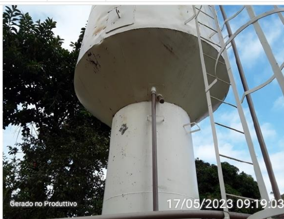
Tubo de descarga de fundo
