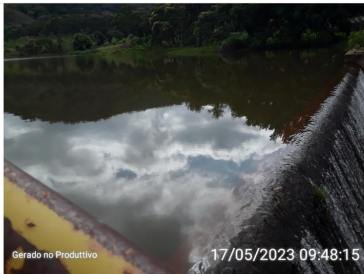
Barragem na captação superficial
