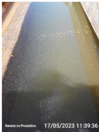
Passagem de flocos para os filtros - Decantador n° 2
