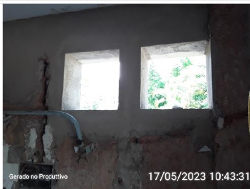
Aberturas de iluminação e ventilação natural
