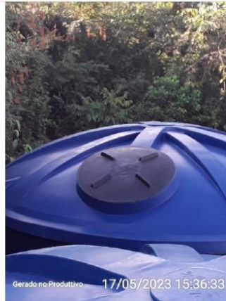
Tampa de inspeção
