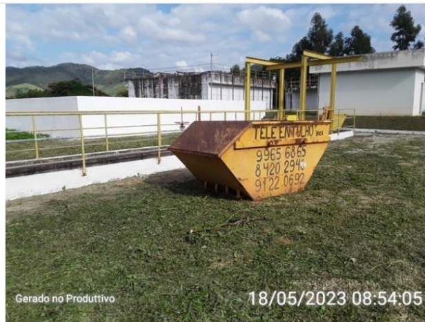
Elevatória e depósito de descarte preliminar
