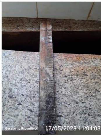
Régua para medição de vazão
