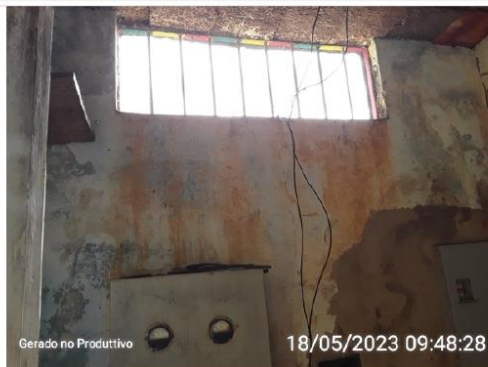
Abertura de iluminação e ventilação
