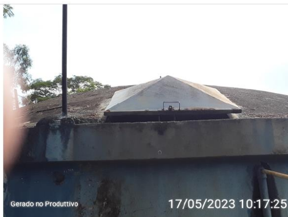
Tampa de inspeção
