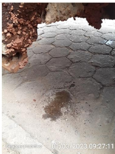
Derramamento de chorume na via pública
