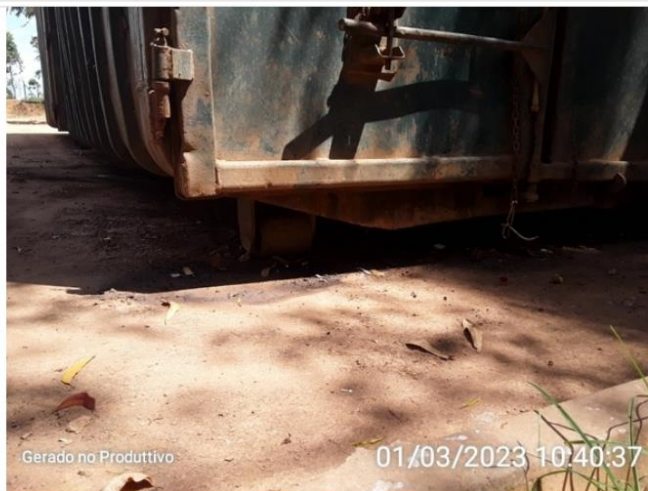
Parte inferior do contêiner
