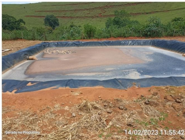
Lagoa de estabilização
