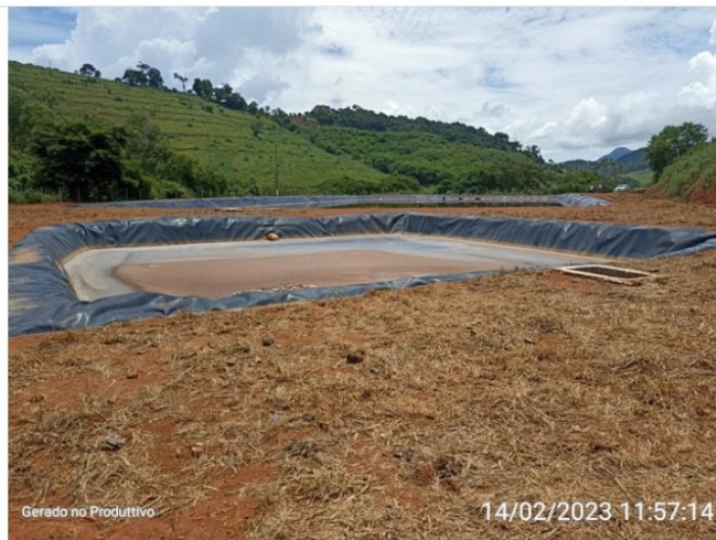
Lagoas de estabilização
