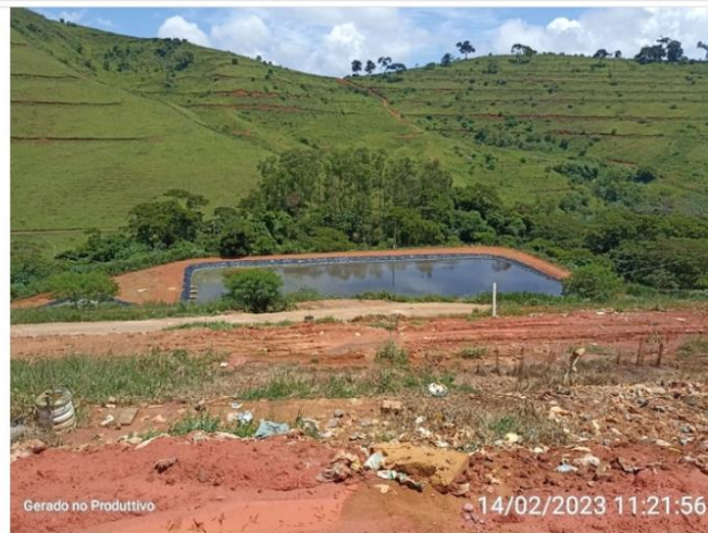
Lagoa de estabilização
