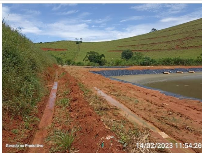
Lagoa de estabilização
