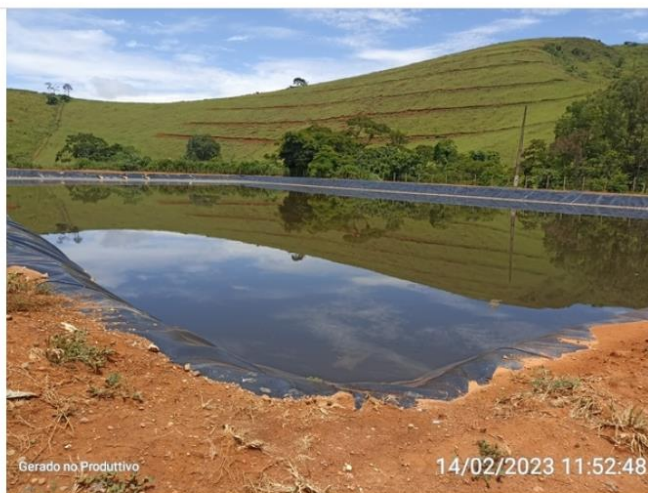
Lagoa de estabilização
