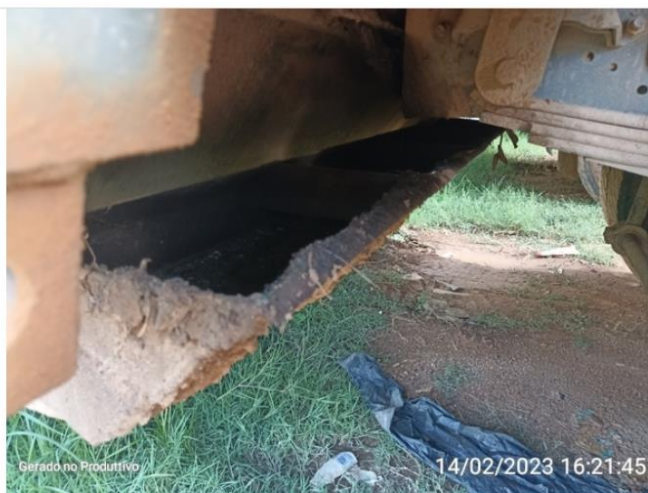
Calha coletora de chorume
