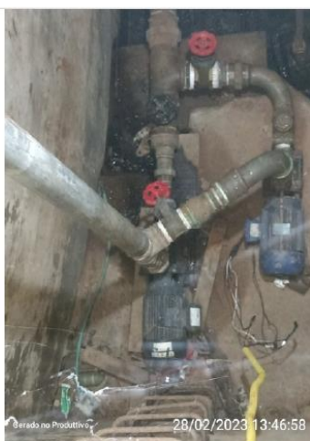
Espaço Interno EEAT
