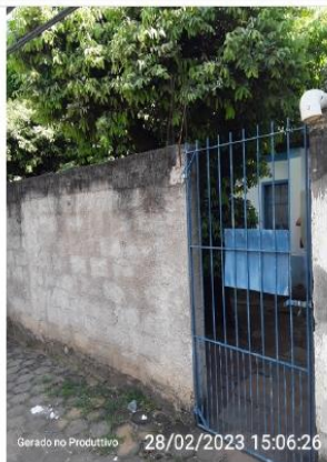
Fechamento da área da EEAT
