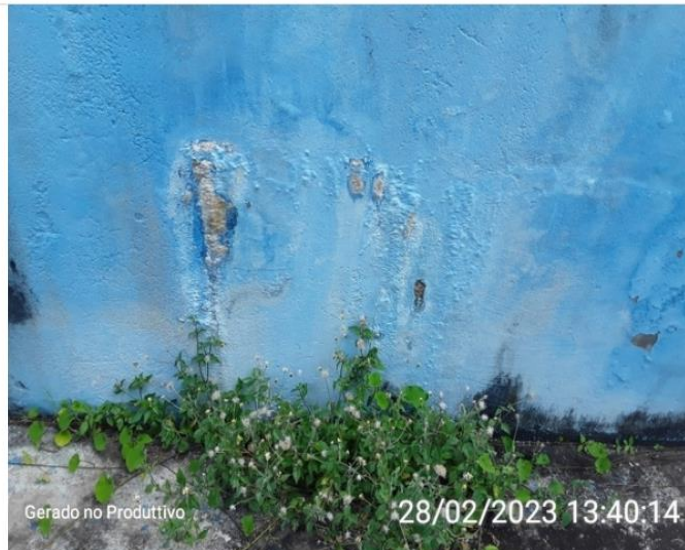
Infiltrações aparentes
