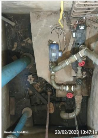
Espaço Interno EEAT
