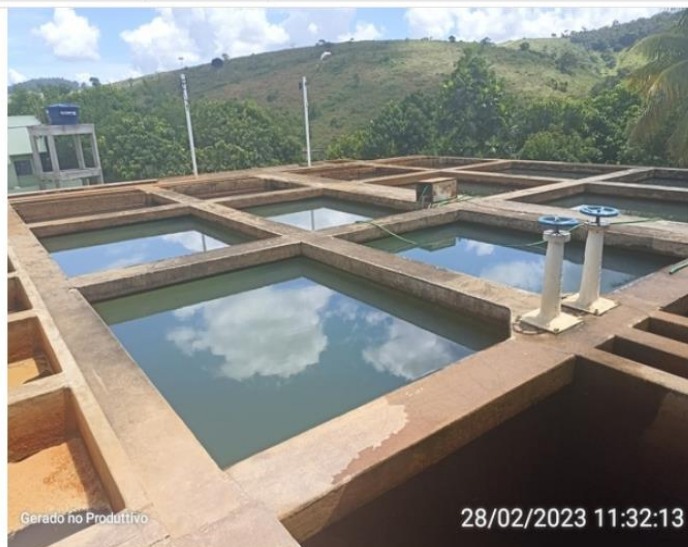
Decantadores sem guarda-corpo
