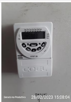
Programador de funcionamento
