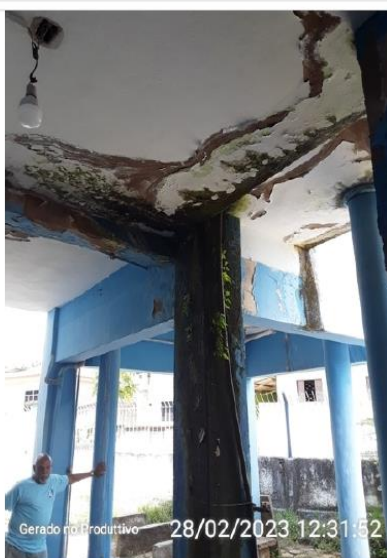
Infiltrações aparentes
