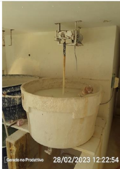
Reservatório de dosagem da cal
