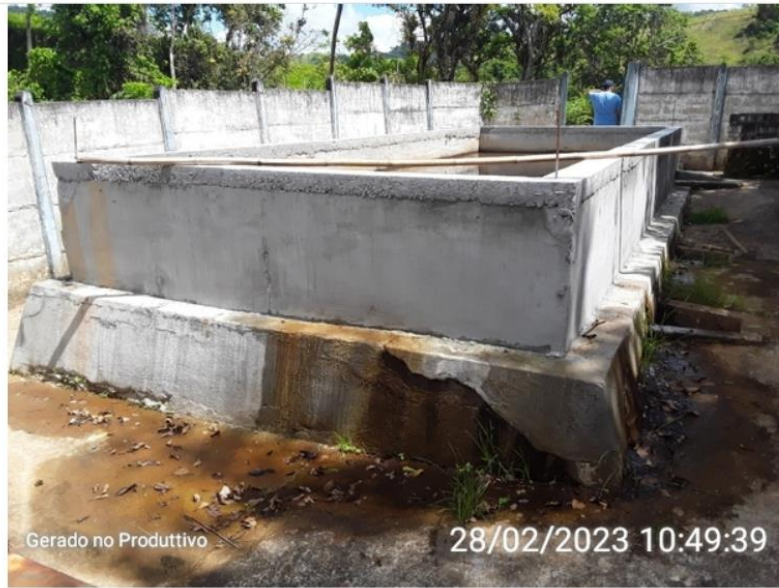
Vazamento existente na estrutura
