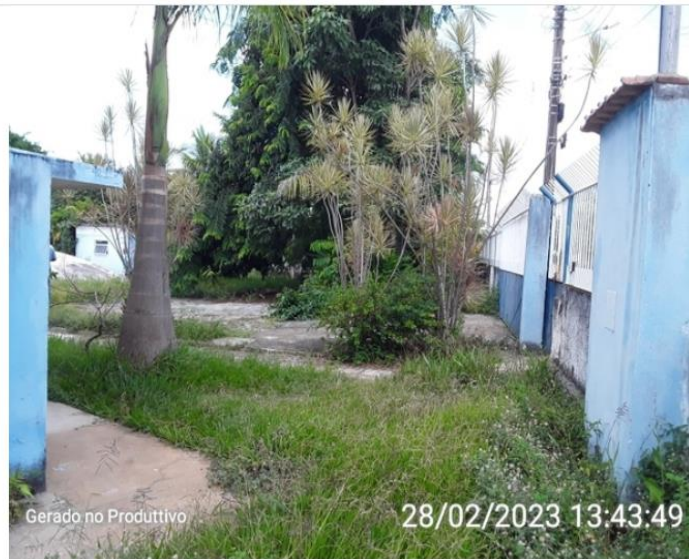
Espaço precisando de manutenção
