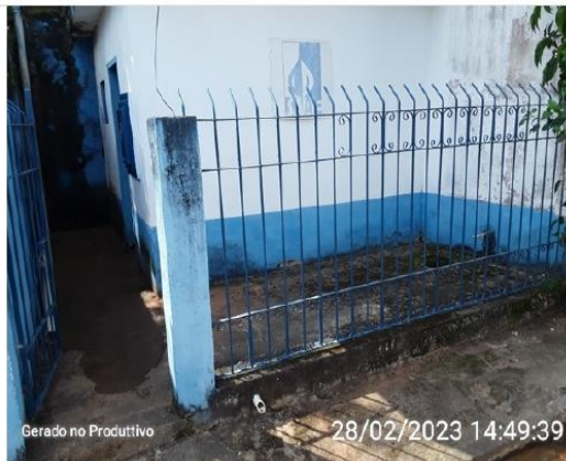
Cercamento da EEAT
