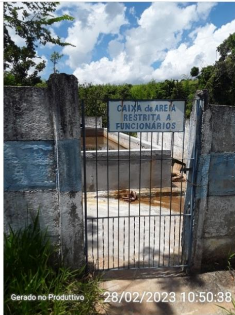
Portão de acesso ao desarenador
