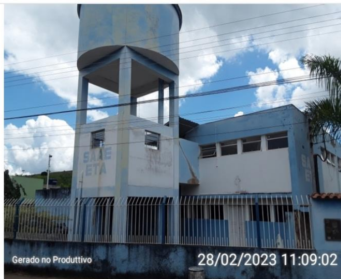
Fachada Frontal ETA
