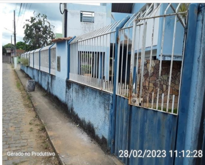
Cercamento frontal da ETA
