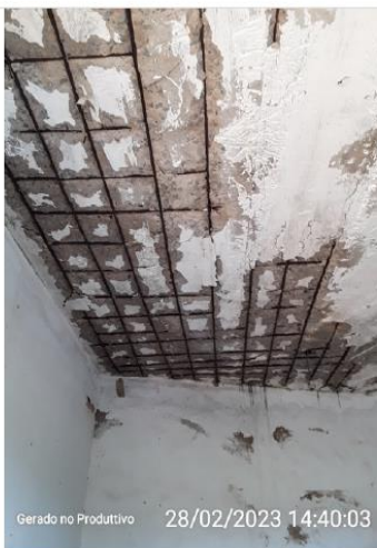
Aço da laje exposta oxidando
