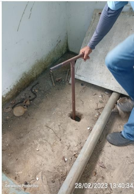
Fechamento na saída do reservatório
