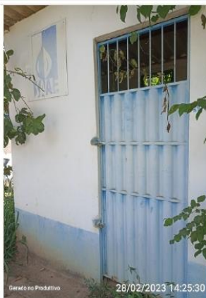
Fechamento da EEAT
