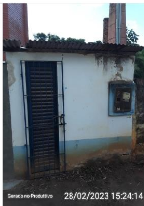
Abrigo da EEAT
