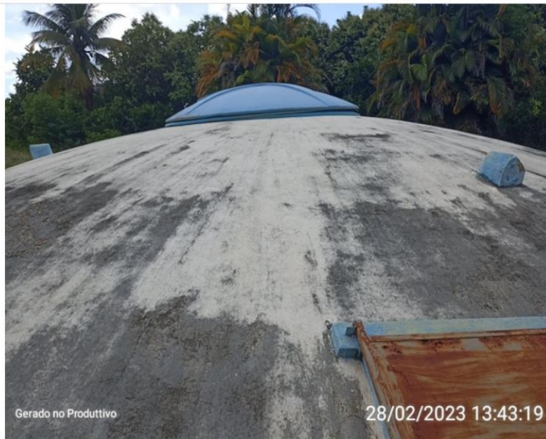
Cobertura do reservatório
