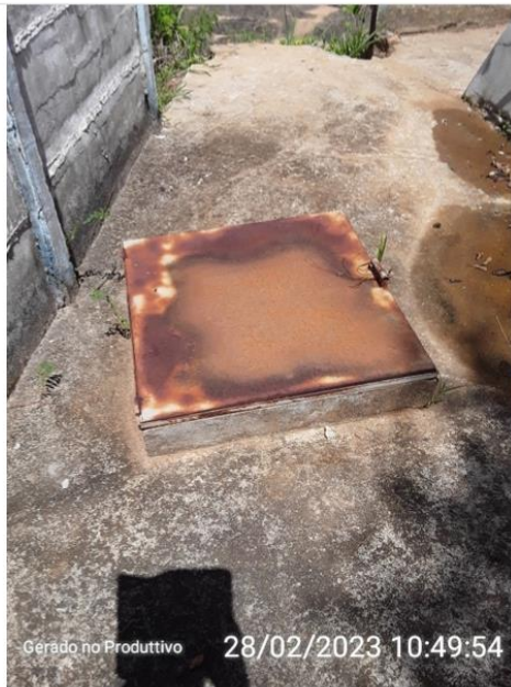
Abrigo para válvula de fechamento na captação
