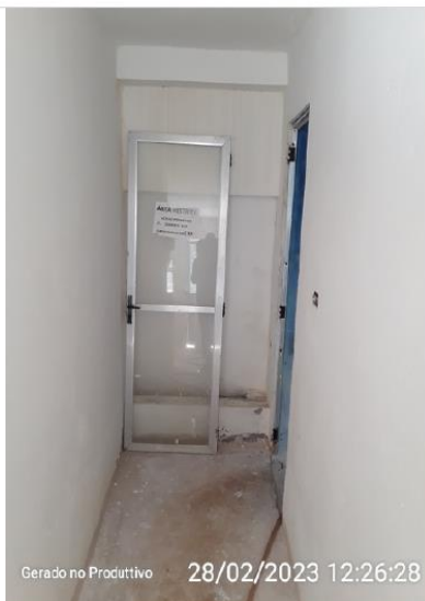
Porta de acesso a casa de química retirada
