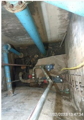
Espaço Interno EEAT
