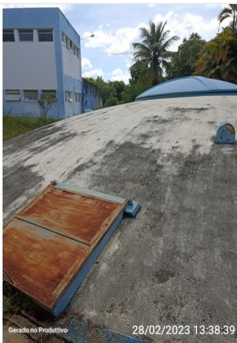
Acesso e ventilação do reservatório
