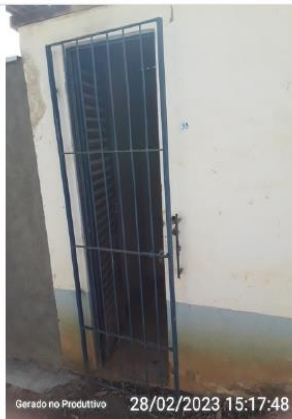
Cercamento do espaço da EEAT
