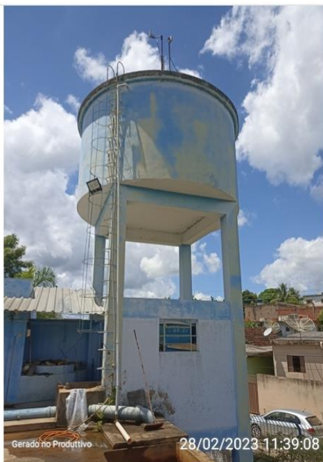
Reservatório Elevado ETA
