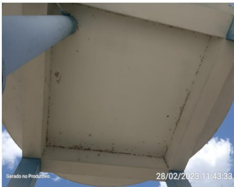
Estrutura aparente do reservatório
