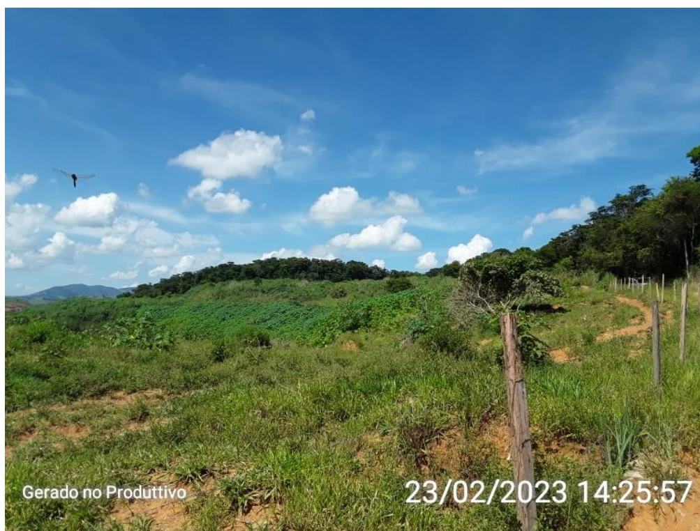
Figura 1 - Área de antigo lixão – cercamento
