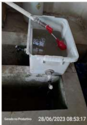
Torneiras de dosagem manual do coagulante
