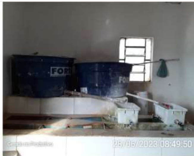
Casa de químicos
