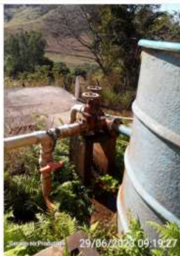
Vazamento nas válvulas dos filtros
