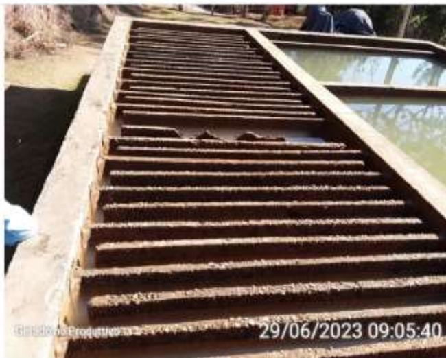
Floculador - Chicanas de fluxo horizontal
