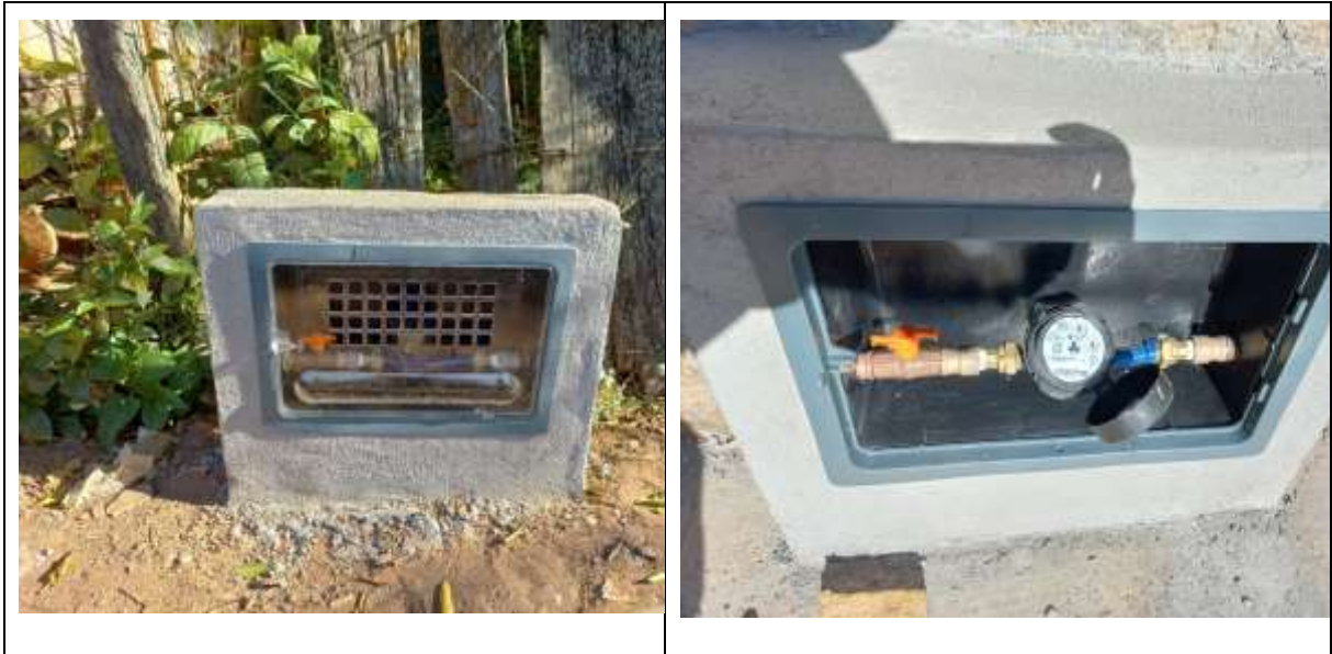
Figura 3 – Instalação de Hidrômetros
