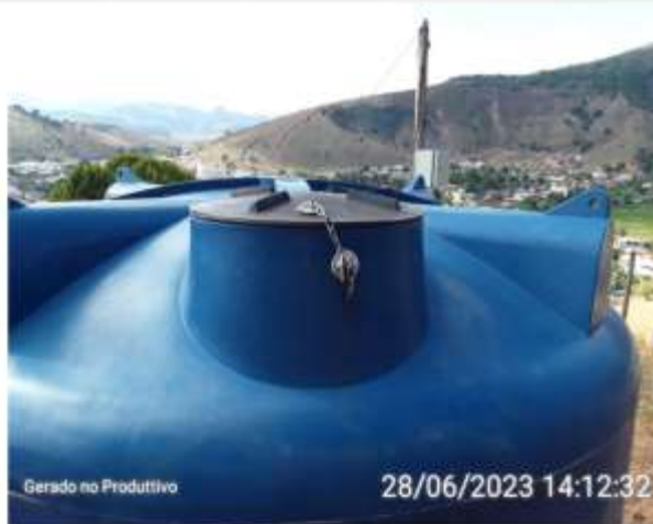
Tampas de inspeção
