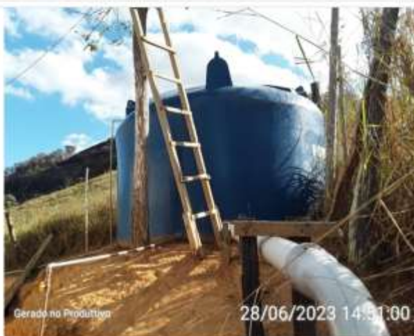
Escada de acesso
