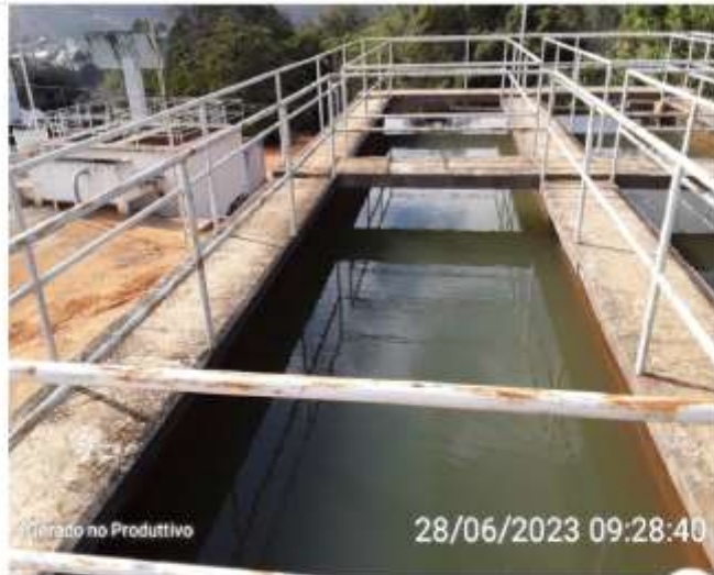
Decantadores - Sistema Retangular
