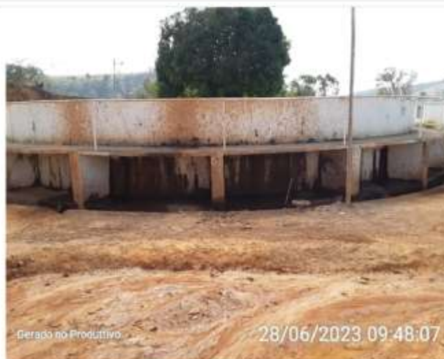
Infiltrações - Sistema circular
