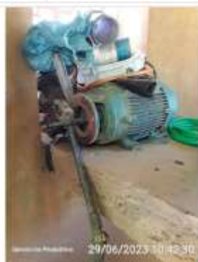
Materiais no local da EEAB
