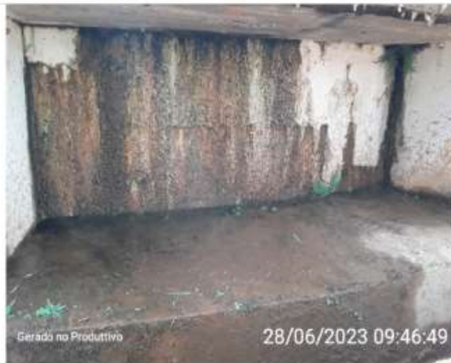
Infiltrações - Sistema circular
