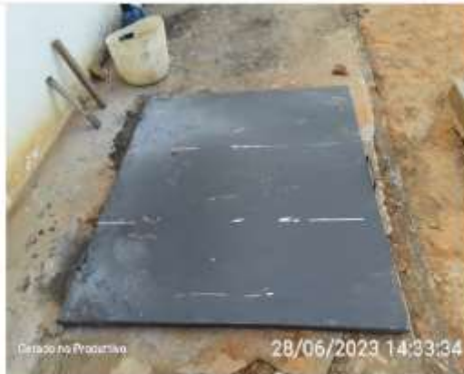
Tampa de inspeção
