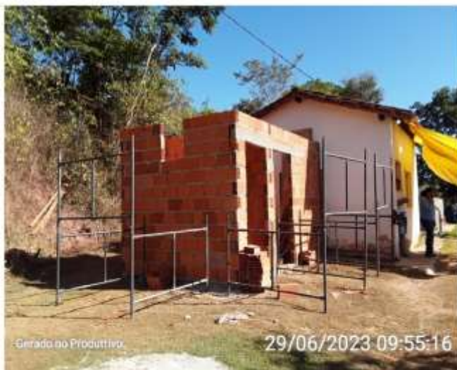
Obras de ampliação
