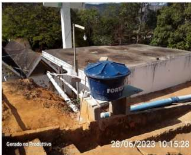
Casa de químicos
