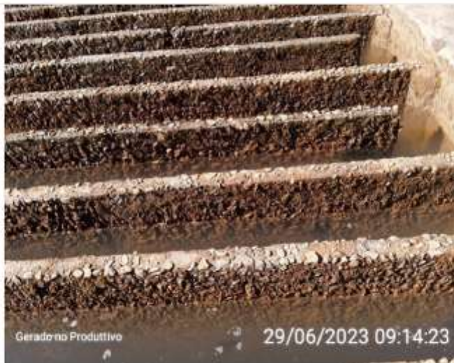
Chicanas de fluxo horizontal
