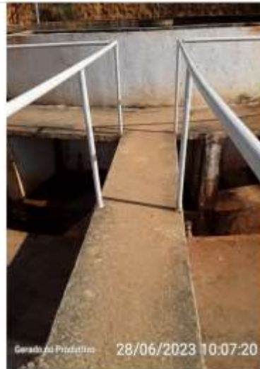
Guarda corpos insuficientes
