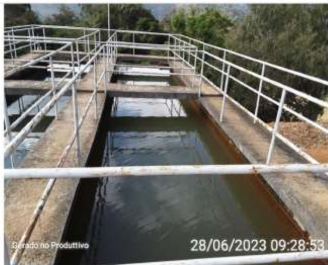
Decantadores - Sistema Retangular
