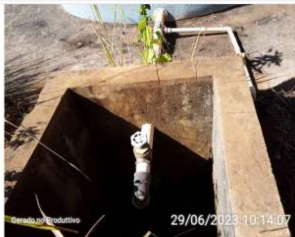
Tubo de descarga de fundo
