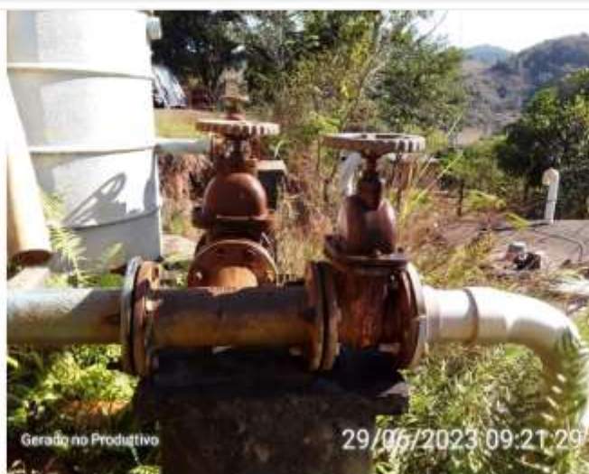
Vazamento nas válvulas dos filtros
