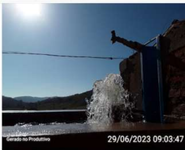
Chegada de água na entrada da ETA
