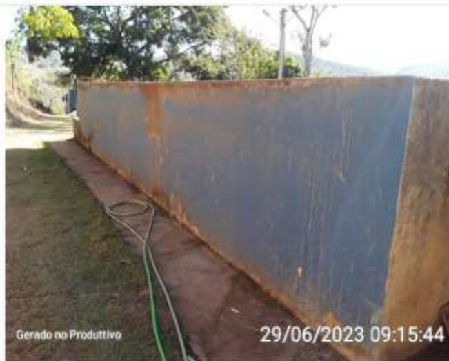
Estrutura da ETAP
