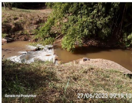
Manancial de captação
