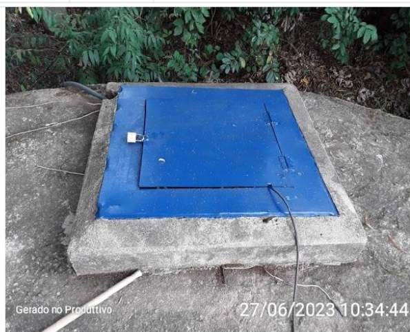
Tampa de inspeção
