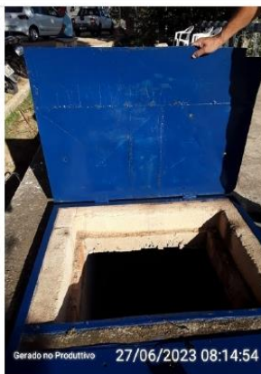
Parte interna da tampa de inspeção
