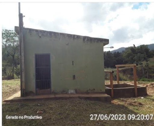
Casa de bombas
