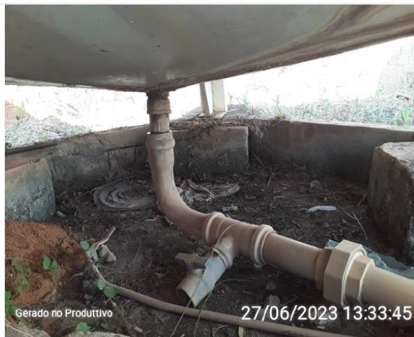
Tubo de descarga do fundo
