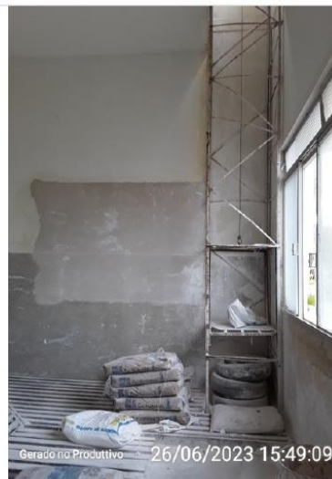
Elevador de produtos químicos
