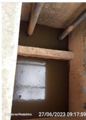
Poço de sucção
