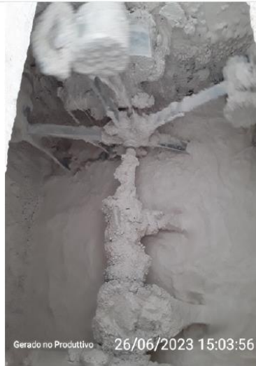
Parte interna do tanque de contato
