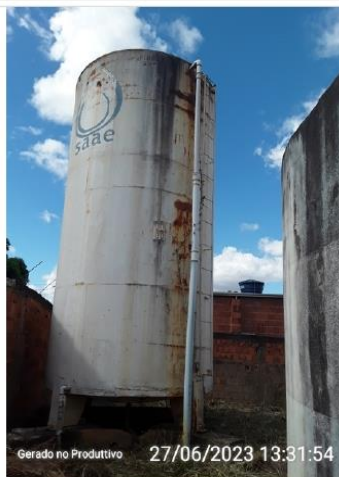
Tubulação da chegada de água
