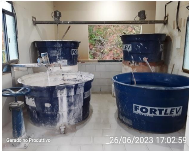
Casa de químicos
