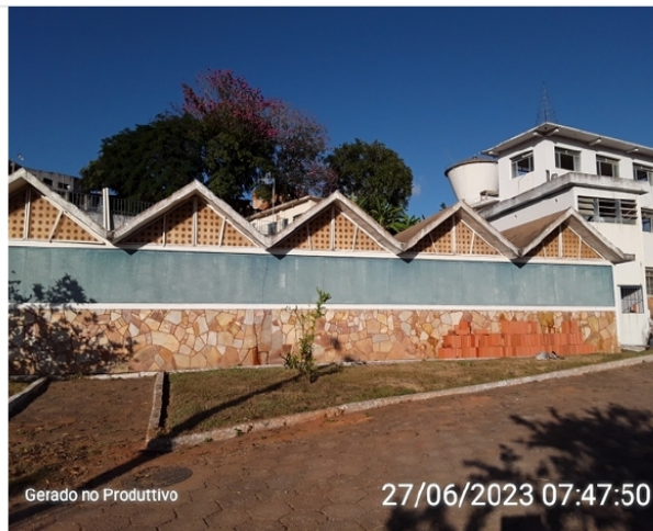
Vista lateral do reservatório
