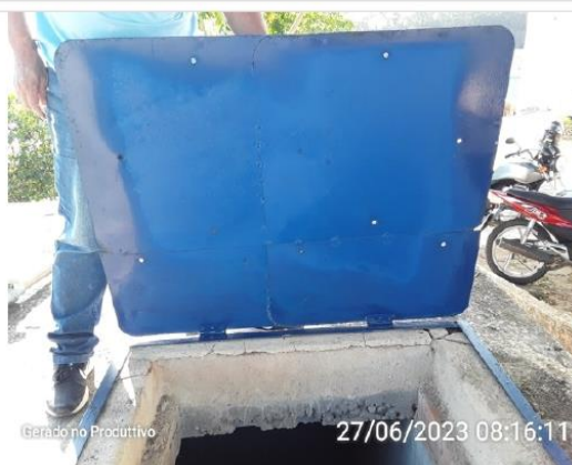
Parte interna da tampa de inspeção
