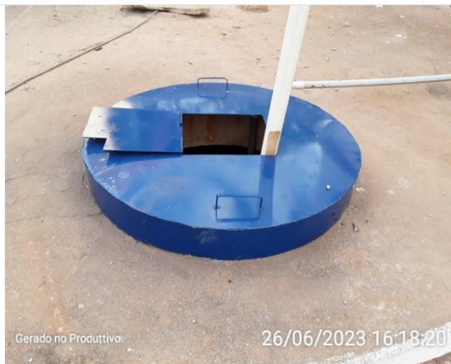
Tampa de inspeção
