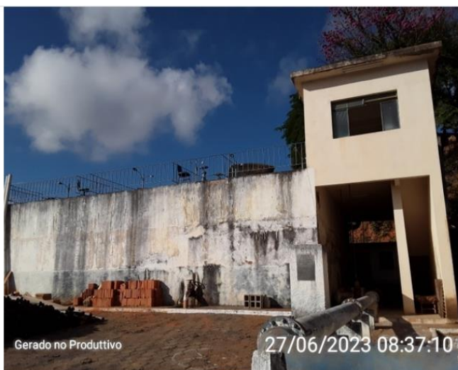
Vista Lateral da ETA
