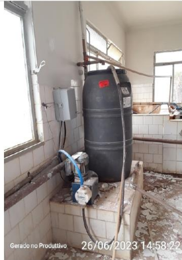
Casa de químicos
