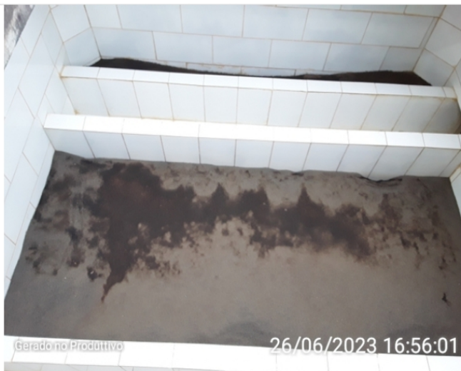
Filtro II - Material filtrante
