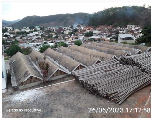
Vista Superior do Reservatório
