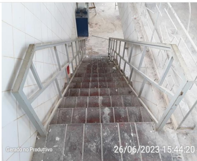
Escada de acesso no segundo piso
