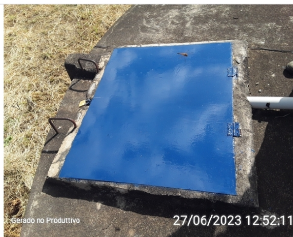
Tampa de inspeção
