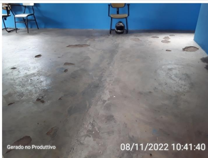
Piso da cozinha
