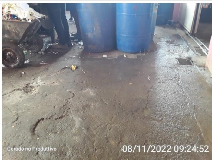
Piso interno do galpão impermeabilizado
