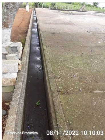
Canaletas de drenagem
