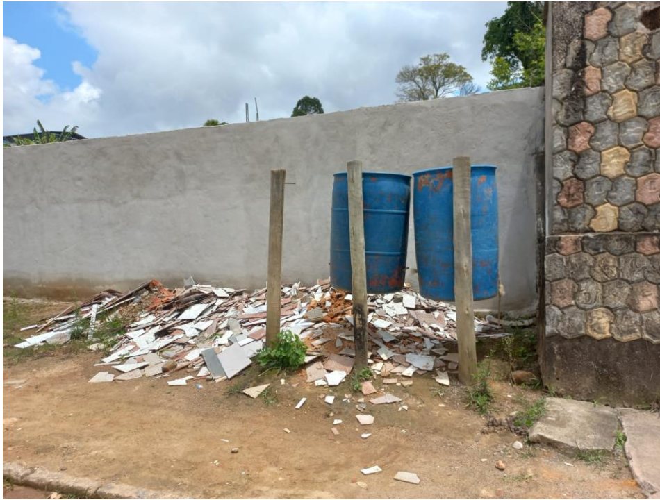
Figura 3 – Resíduos de Construção Civil
