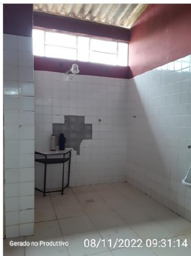
Vestiário e cozinha (antigo banheiro masculino)
