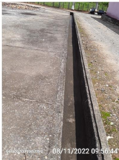
Canaletas de drenagem pluvial
