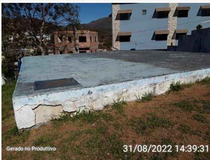
Cobertura do reservatório
