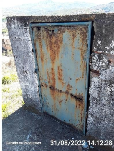
Tampas de inspeção
