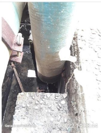
Descarga dos filtros
