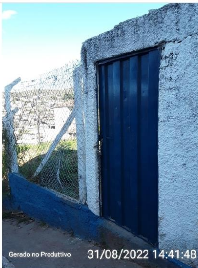
Portão de acesso com cadeado
