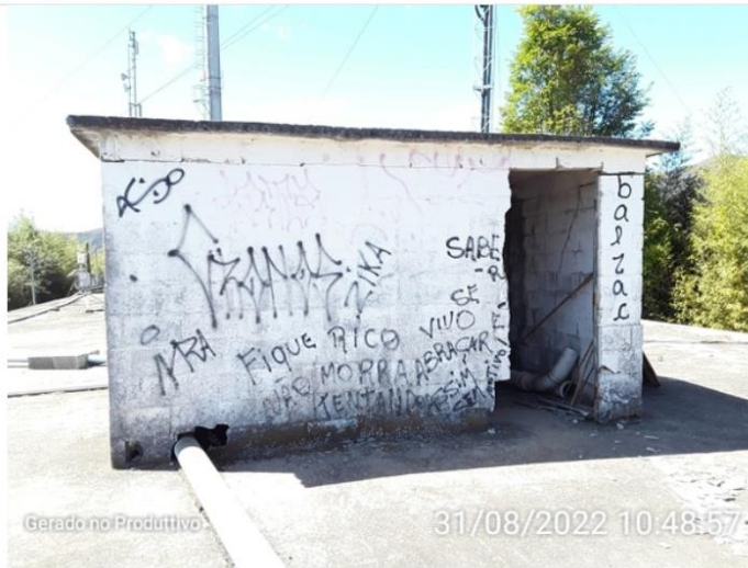
Acesso a área interna do reservatório
