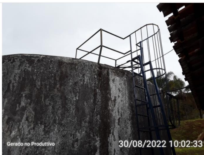
Cobertura do reservatório
