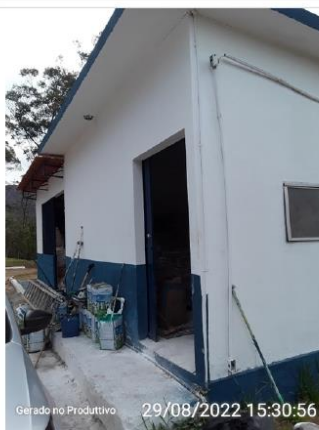
Depósito de produtos químicos
