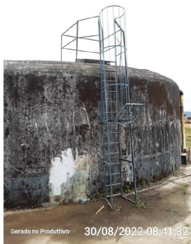
Guarda-corpo entorno da abertura de inspeção
