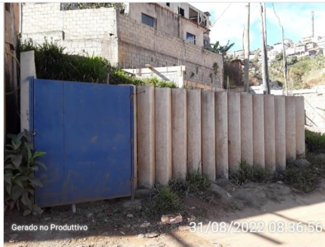
Área da captação subterrânea
