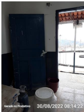
Porta da sala de preparo de produtos químicos
