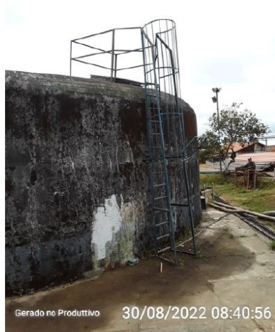
Escada para acesso a cobertura
