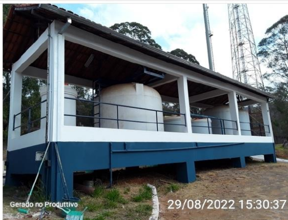
Depósito de produtos líquidos
