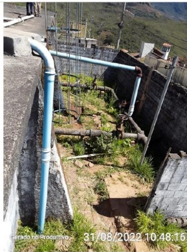
Escada para acesso a cobertura
