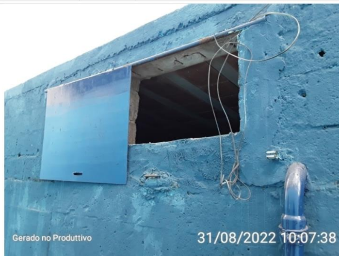
Abertura de inspeção
