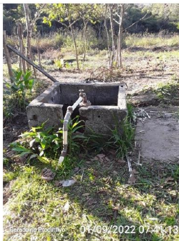
Poço Jardim Santana
