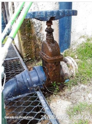
Registro próximo ao vertedouro
