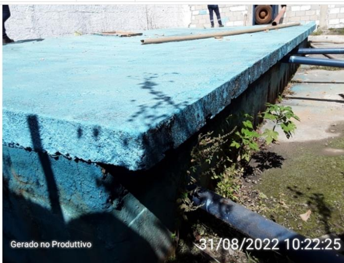
Cobertura do reservatório
