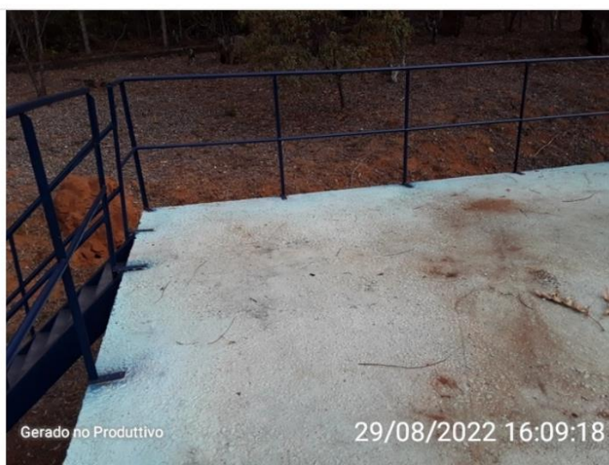
Reservatório ETA Sul
