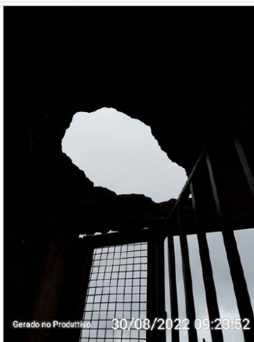
Abertura na laje
