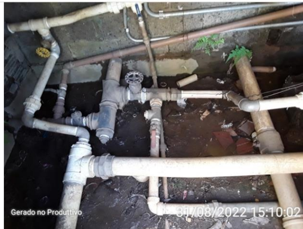
Piso da EEAT
