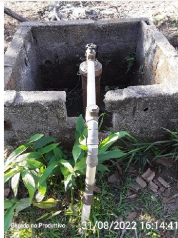
Poço Jardim Santana
