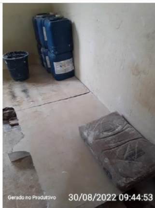
Depósito de produtos químicos
