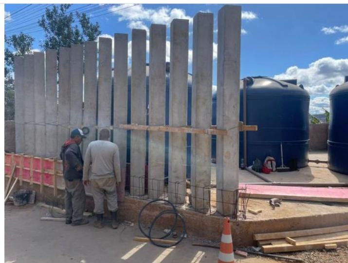
Cercamento do reservatório
