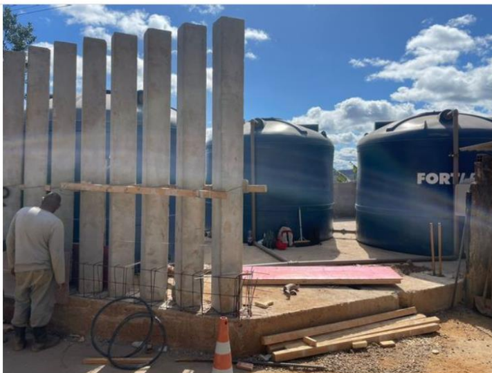
Cercamento do reservatório
