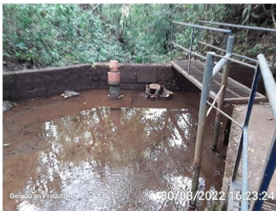
Área da captação
