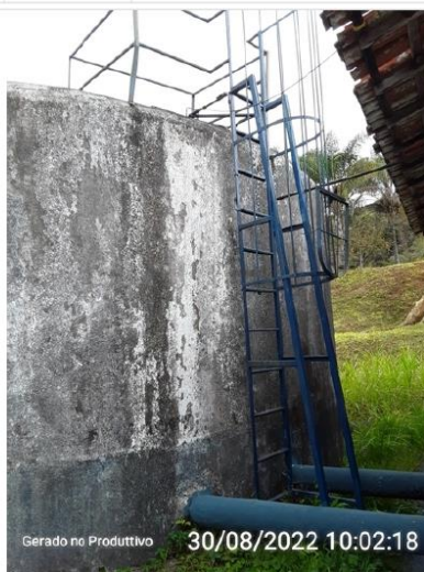
Escada para acesso a cobertura
