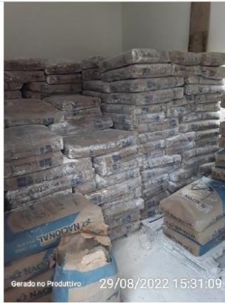
Depósito de cal
