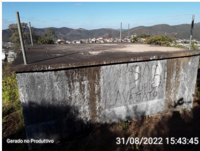
Cobertura do reservatório
