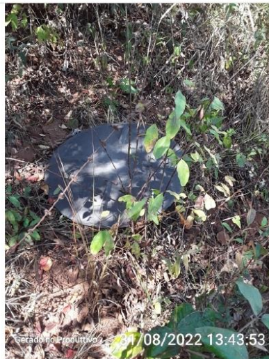
Tampa do reservatório
