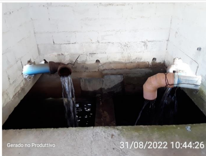
Abertura de inspeção do reservatório
