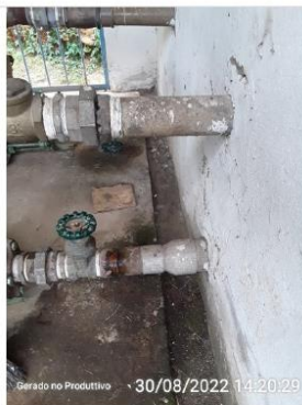
Sistema de drenagem no piso
