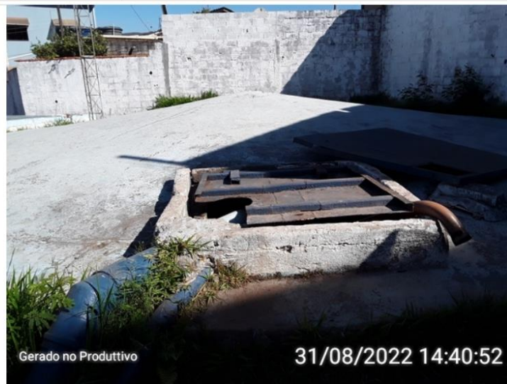
Cobertura do reservatório
