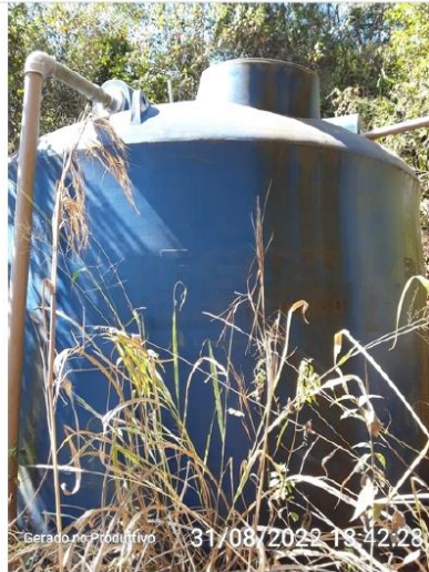
Cobertura do reservatório
