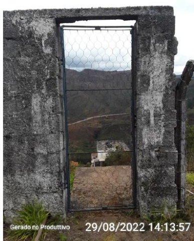
Portão de acesso
