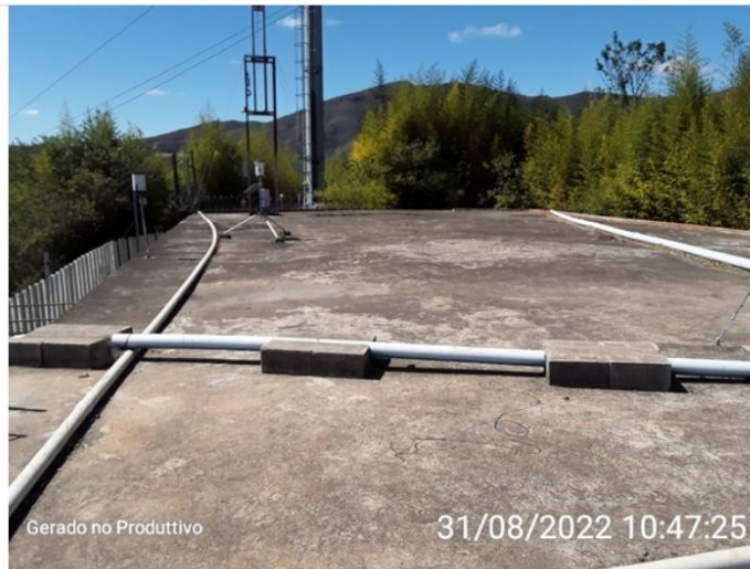
Cobertura do reservatório
