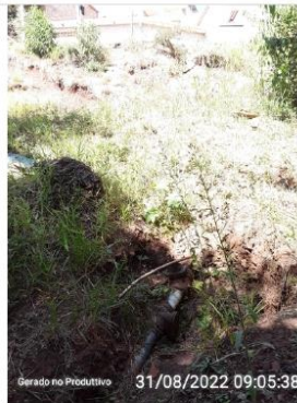
Área acima da EEAB
