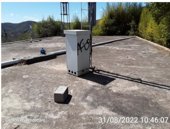
Cobertura do reservatório
