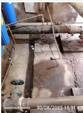
Piso da EEAB
