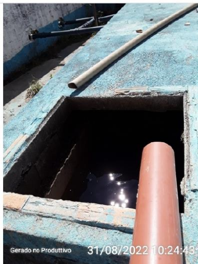
Abertura de inspeção
