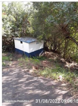
Área da EEAB
