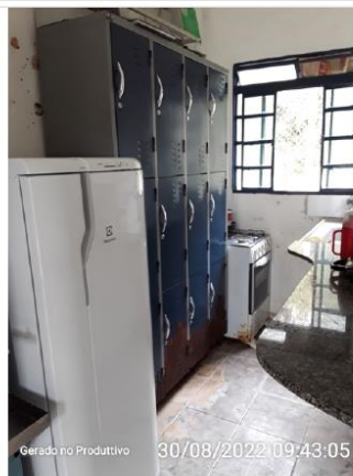
Cozinha e armários da casa de química
