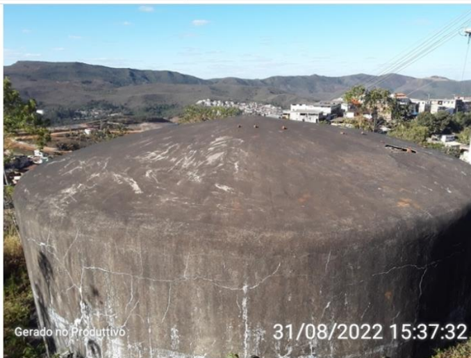
Cobertura do reservatório
