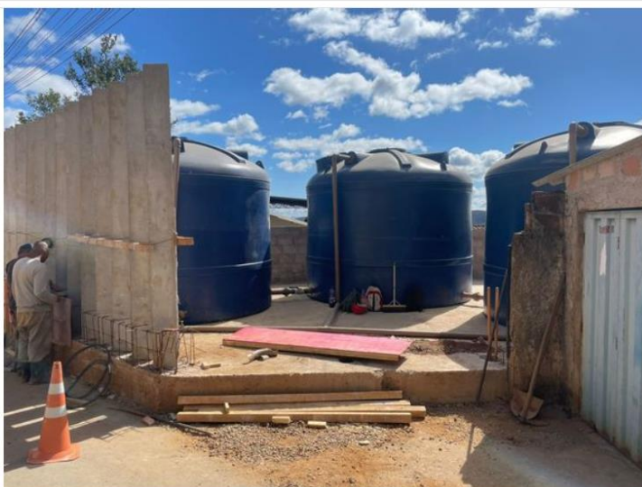
Cercamento do reservatório
