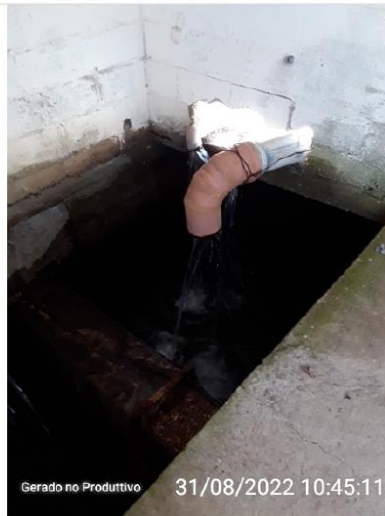
Abertura de inspeção do reservatório
