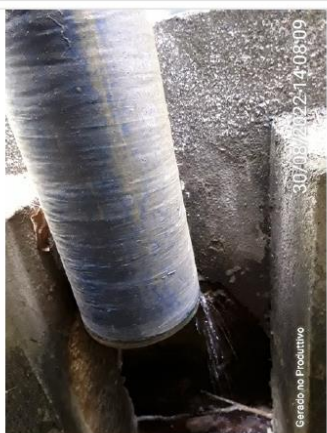
Descarga dos filtros
