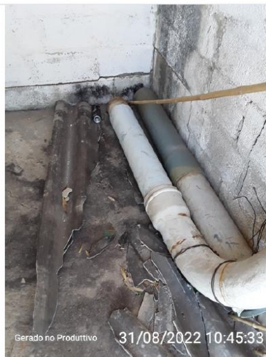
Abertura de inspeção do reservatório
