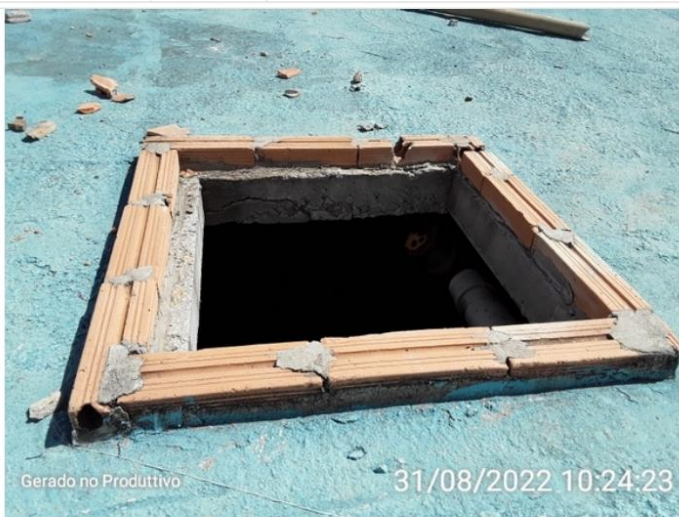
Abertura de inspeção
