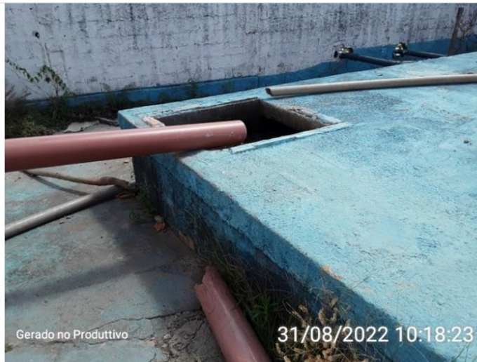
Abastecimento por Caminhão pipa
