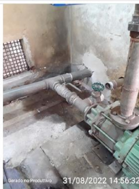
Piso da EEAT
