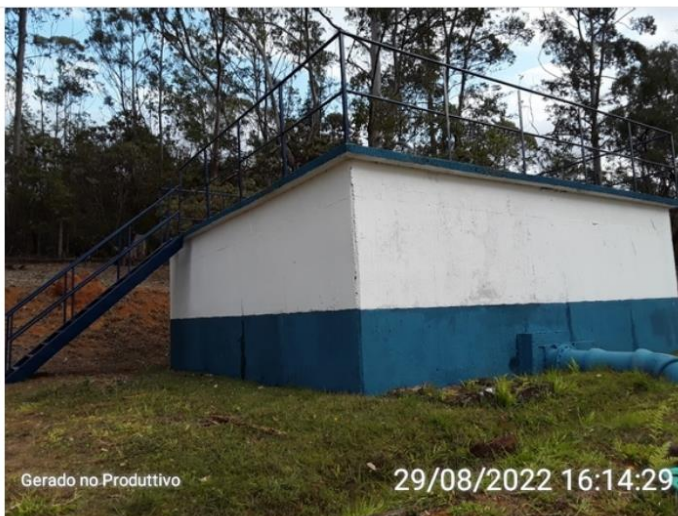
Reservatório ETA Sul
