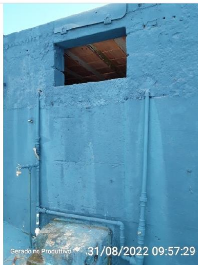
Abertura do reservatório
