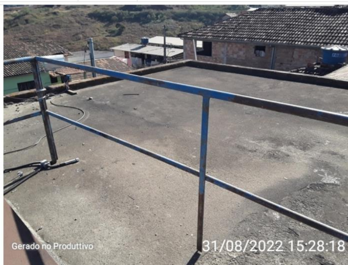
Cobertura do reservatório
