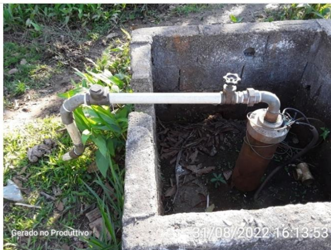
Poço Jardim Santana
