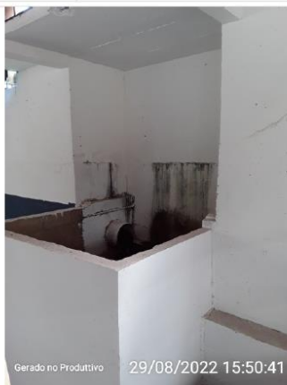
Descarga dos filtros
