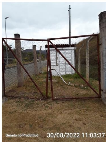
Área do poço Nossa Senhora do Carmo
