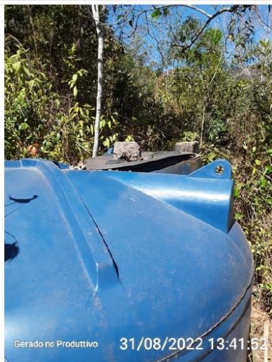
Cobertura do reservatório
