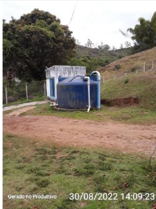
Reservatório na área da ETA
