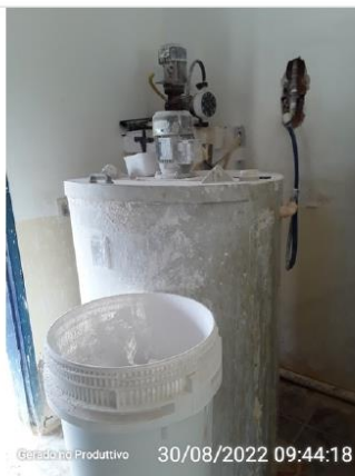
Tanques de agitação
