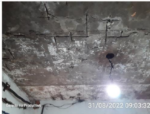
Laje da EEAB
