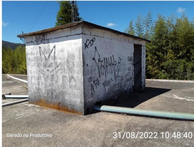
Acesso a área interna do reservatório
