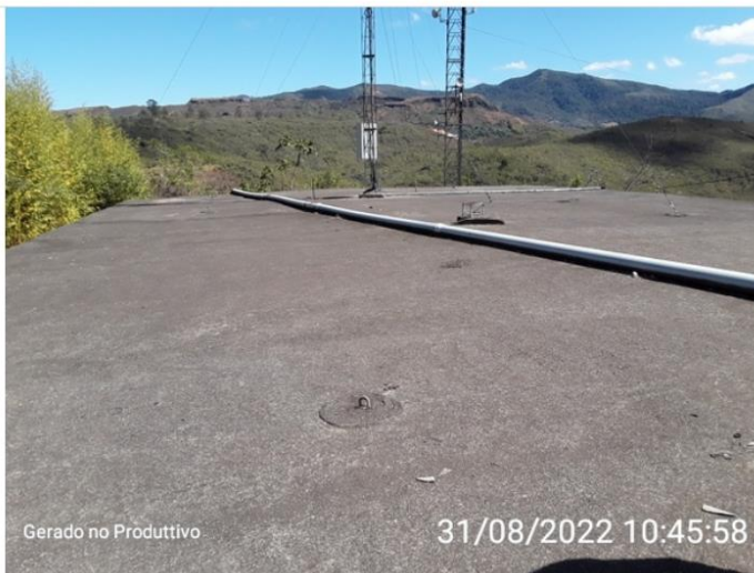
Cobertura do reservatório
