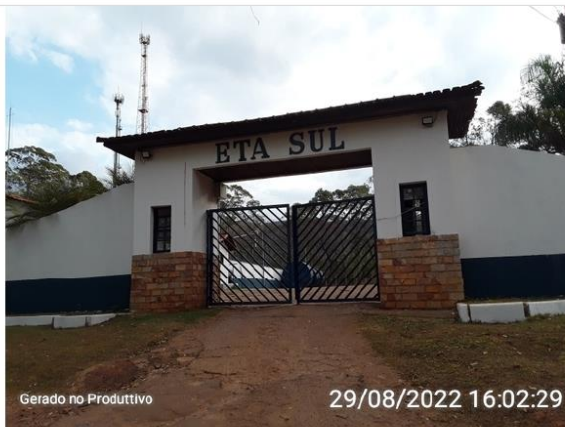
Entrada da ETA Sul
