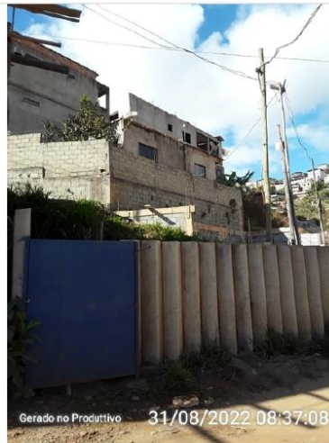
Área da captação subterrânea
