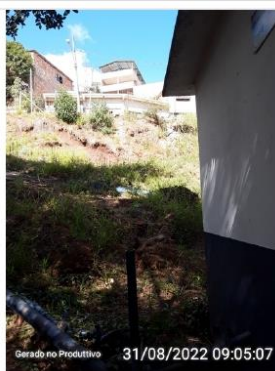
Área acima da EEAB
