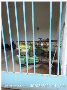
EEAT ETA Matadouro
