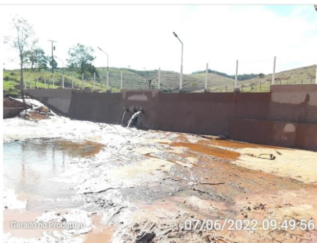
Tubo extravassor de água.
