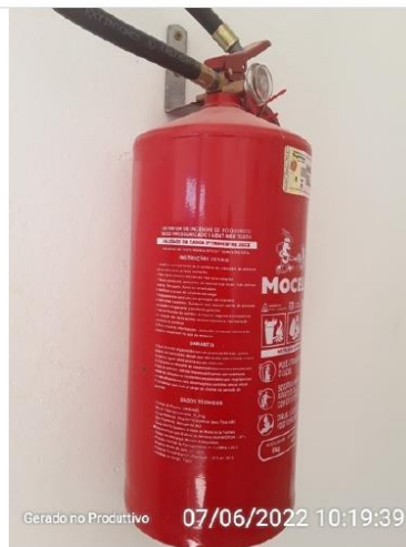
Extintor dentro do prazo de validade na data da fiscalização.
