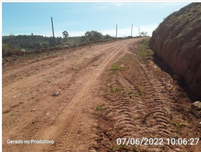
Estrada de acesso da ETA
