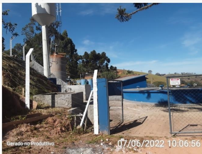
Cercamento da área
