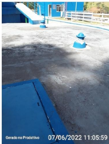
Cobertura com piso impermeável.
