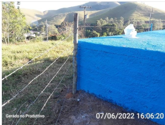
Cercamento em boas condições.
