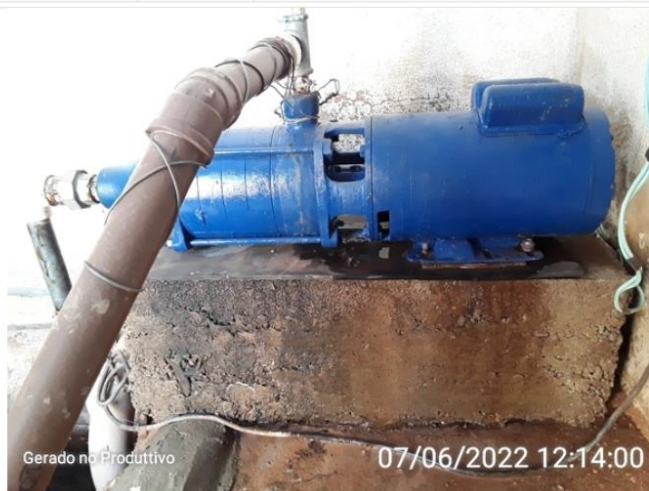
Vazamentos aparentes.
