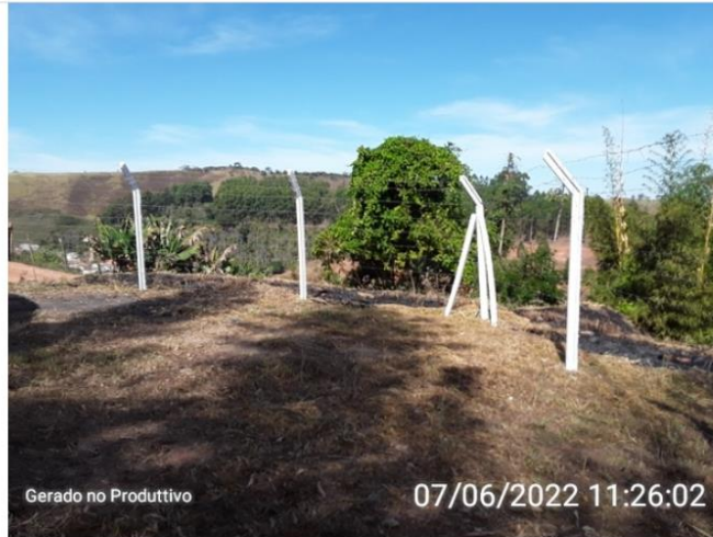
Cercamento do reservatório.
