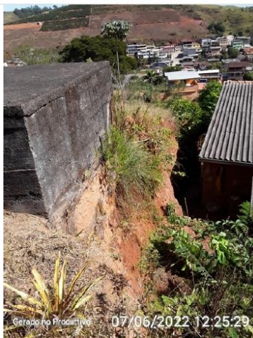
Talude onde se encontra o reservatório.
