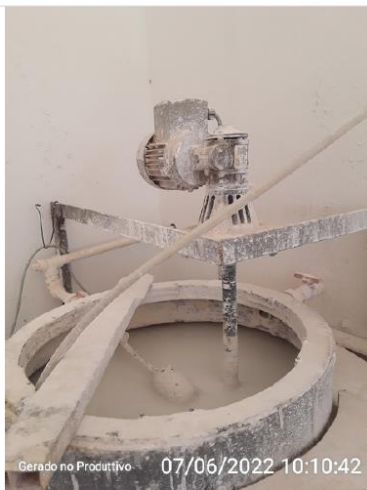
Preparo do cal manual, agitador mecânico não esta funcionando.
