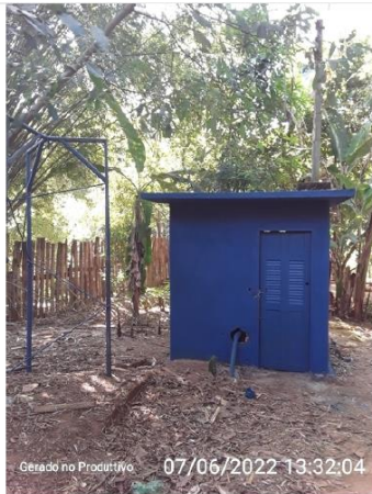
Estruturas em bom estado de conservação.
