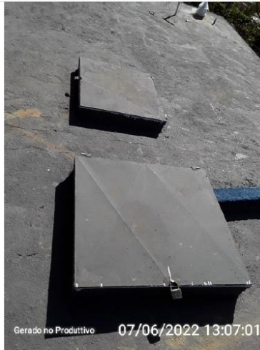
Tampas de inspeção em boas condições de uso.
