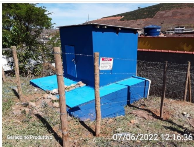
Cercamento da casa de bombas.
