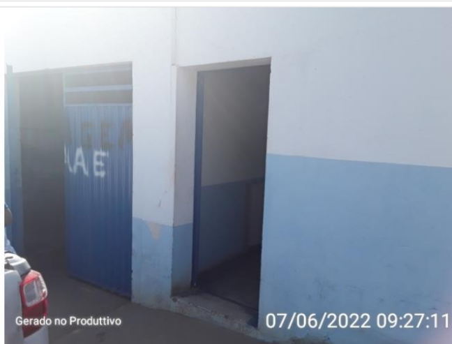
Entrada do local de atendimento ao público.
