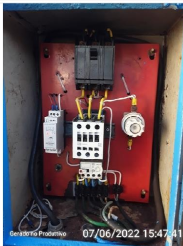
Cabos elétricos conservados.
