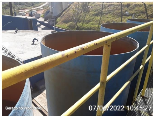
Estruturas da ETA com guarda-corpo
