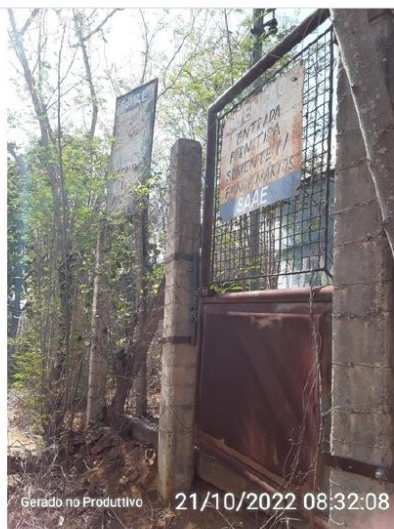
Portão de acesso
