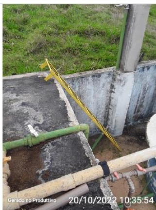
Local sem guarda - corpo e escada
