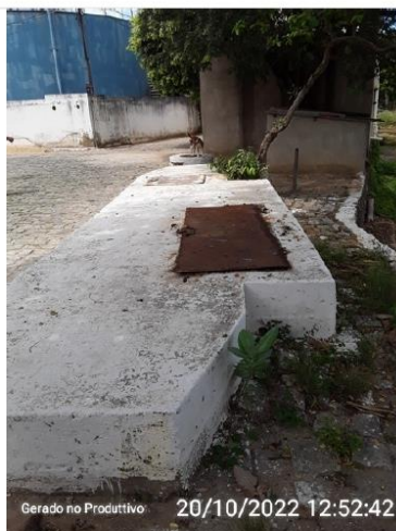
Tampa de inspeção em processo de oxidação
