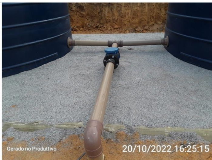
Válvula de retenção
