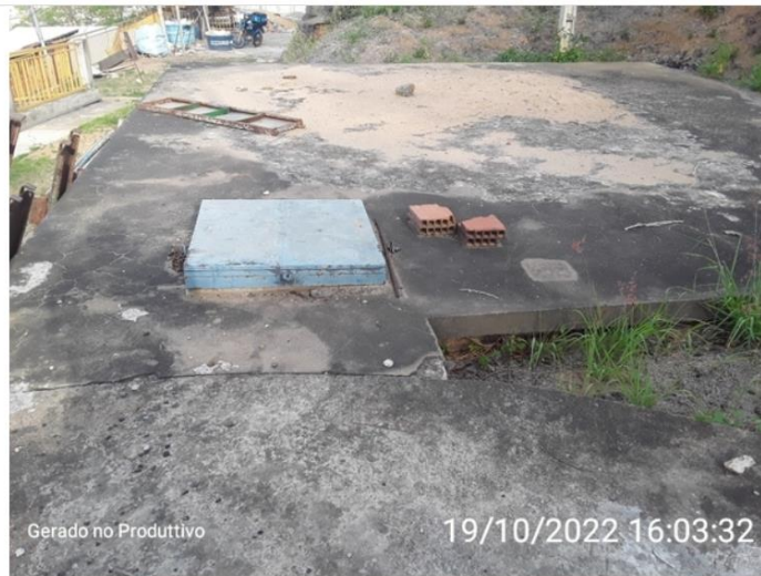
Tampa de inspeção - Reservatório quadrado
