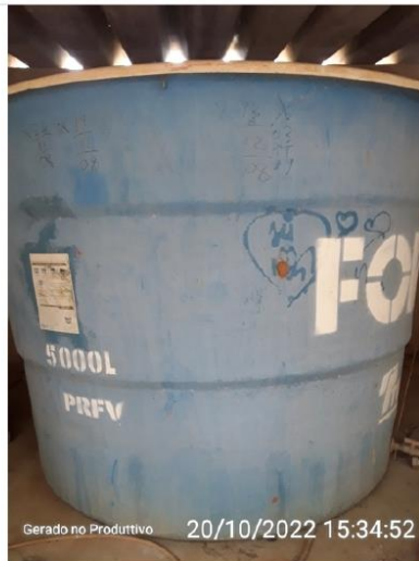
Reservatório de sucção
