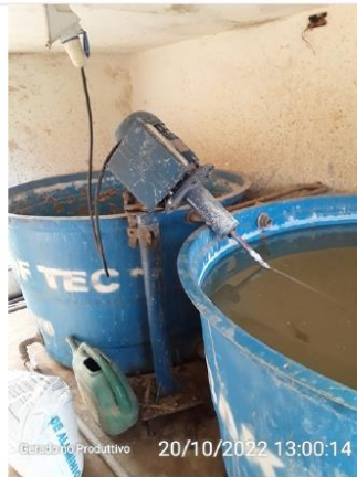
Tanques de preparo e bomba de agitação
