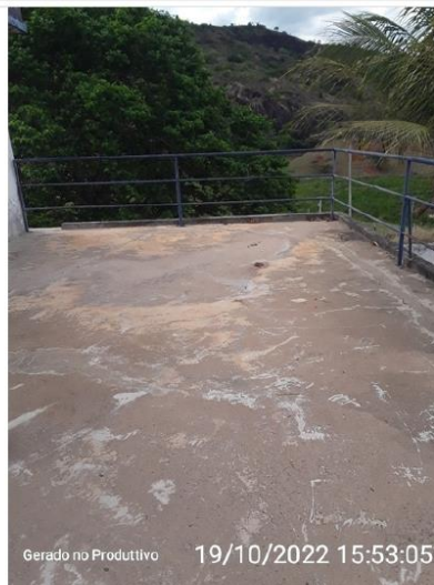
Cobertura do Reservatório
