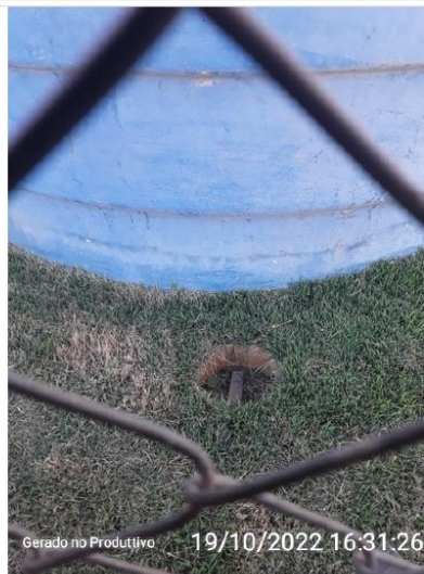
Válvula de fechamento na saída do reservatório
