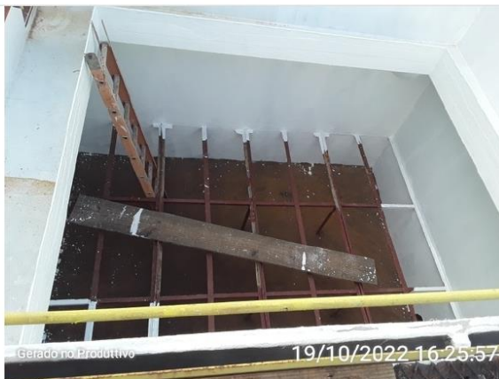
Parte Interna dos decantadores
