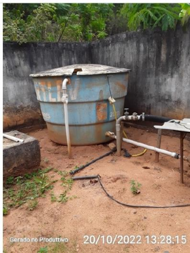
Reservatório da EEAT
