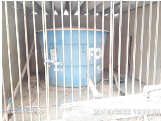
Cercamento do local
