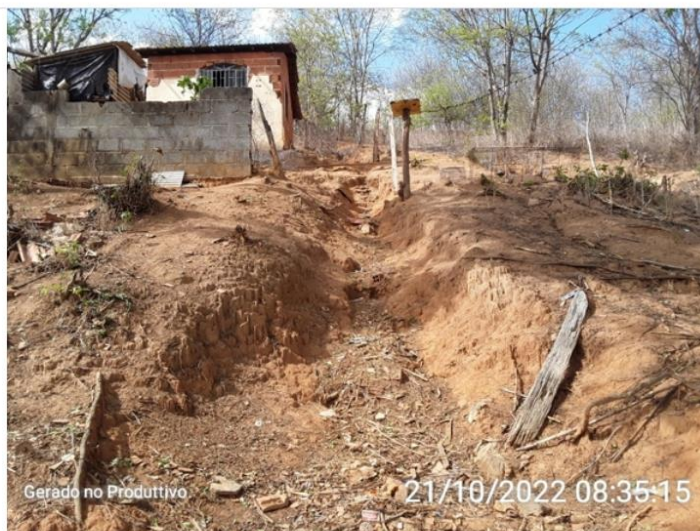
Estrada de acesso ao reservatório
