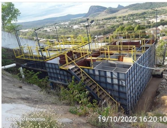
Vista Superior da ETA
