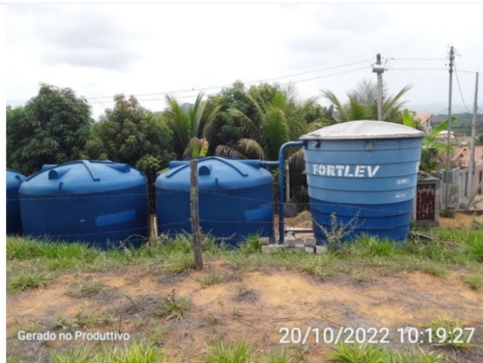
Reservatórios Nilton Freire
