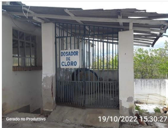
Antigo local de dosagem do Cloro
