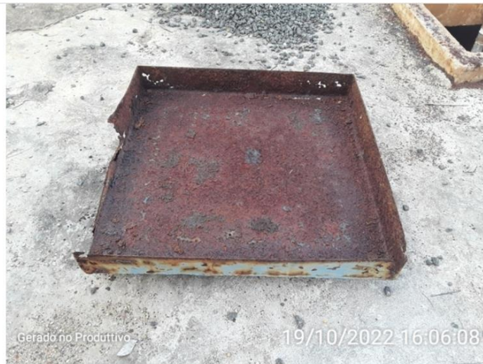
Tampa em corrosão - Reservatório redondo
