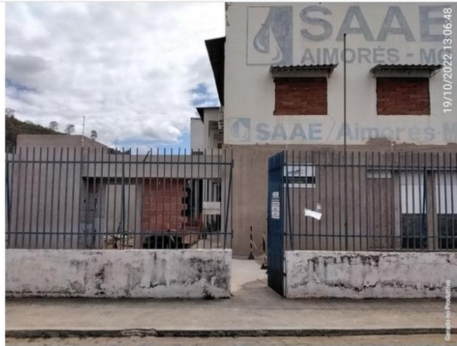
Entrada sem acessibilidade
