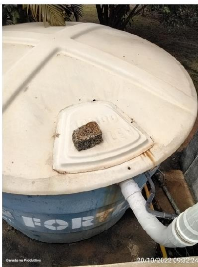
Cobertura do reservatório do SAAE de Mariana
