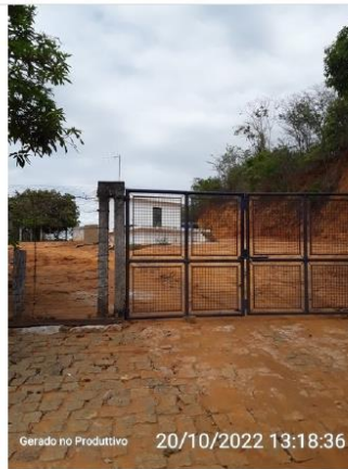
Portão de acesso
