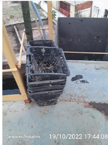
Cestos de remoção de sólidos
