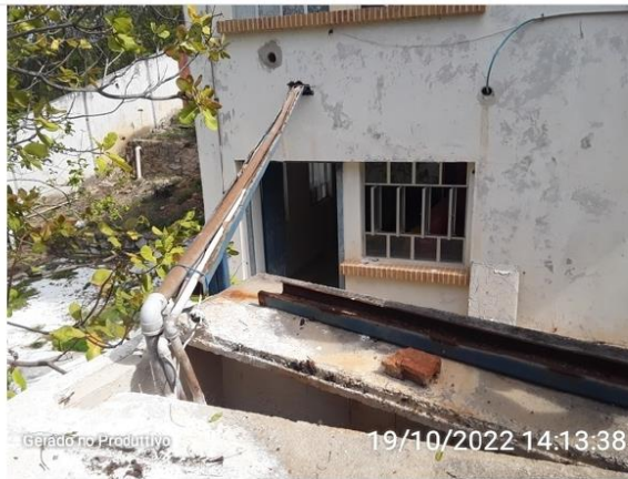
Chegada dos produtos químicos no tanque de contato
