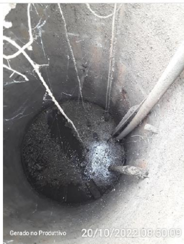
Poço de sucção
