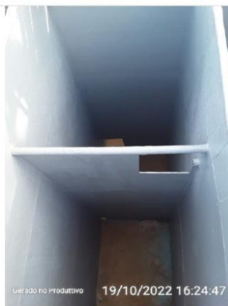
Parte interna do floculador impermeabilizada
