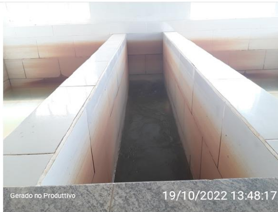
Canal de chegada da água decantada
