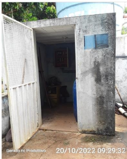
Portão de acesso
