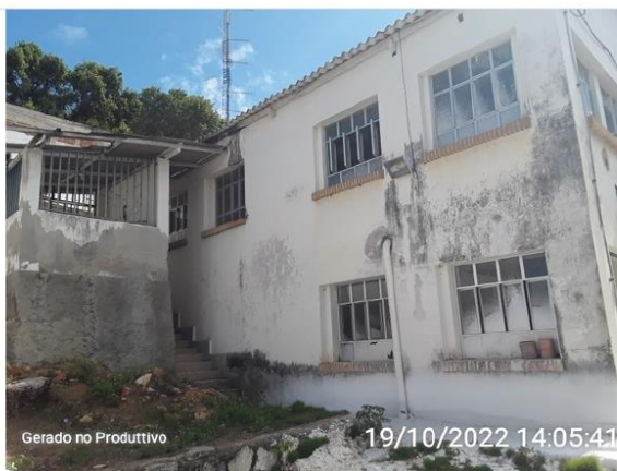
Descarte do Cal na parte externa da ETA.
