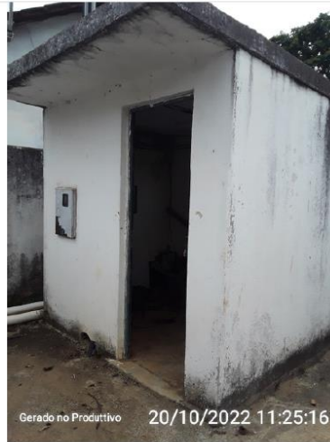
Local de abrigo do painel de controle
