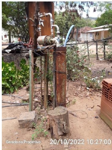
Poço da localidade de Santa Terezinha
