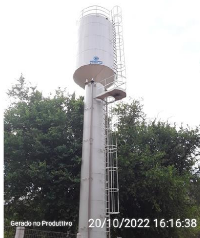
Escada para acesso a cobertura
