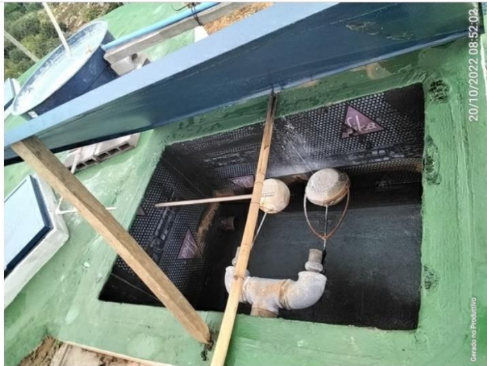
Tampa de inspeção do reservatório
