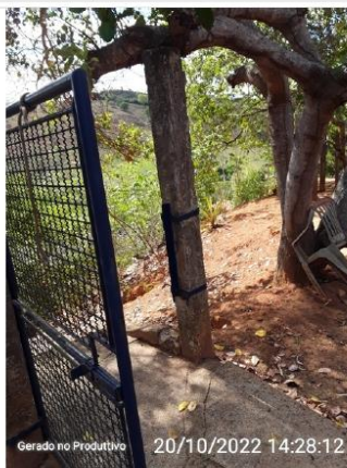
Área da unidade de tratamento sem cerca
