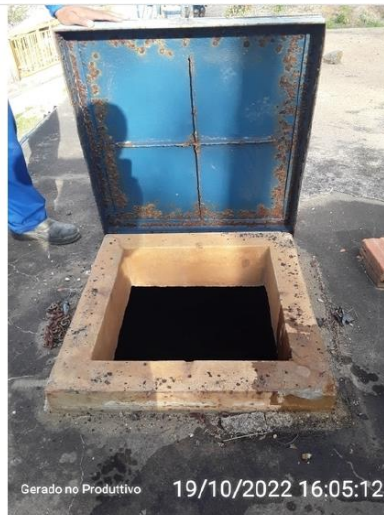
Parte interna - Reservatório quadrado
