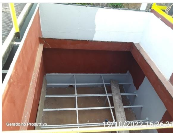
Impermeabilização dos decantadores
