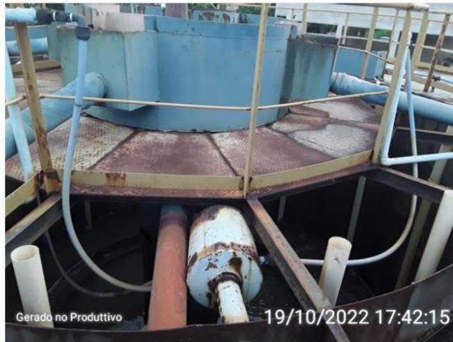
Sistema de injeção de ar
