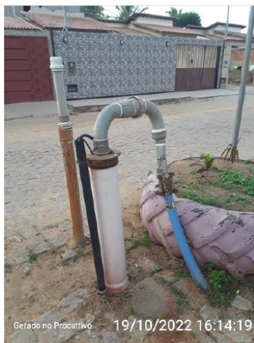
Poço São Sebastião da Vala
