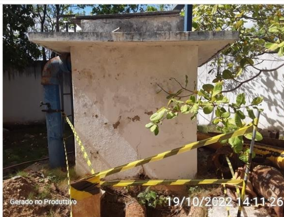
Tanque de contato em reforma
