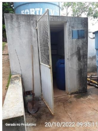
Local de armazenamento e dosagem do hipoclorito de cálcio
