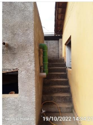
Escada de acesso ao aerador e filtros
