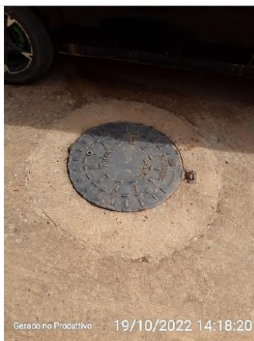
Área de captação
