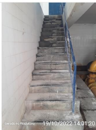
Escadas com guarda-corpos
