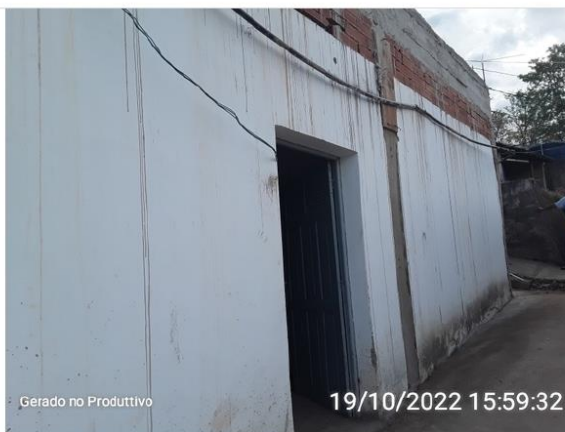
Construção do novo local de depósito de produtos químicos
