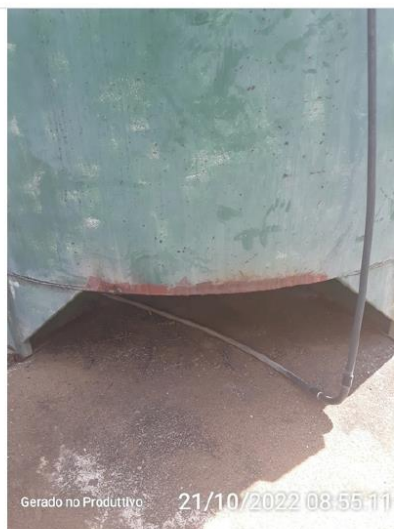
Estrutura do reservatório
