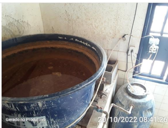
Tanque de preparo de produto químico
