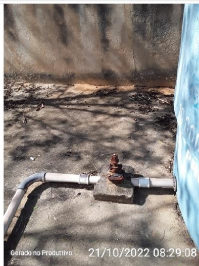
Válvula de entrada e saída
