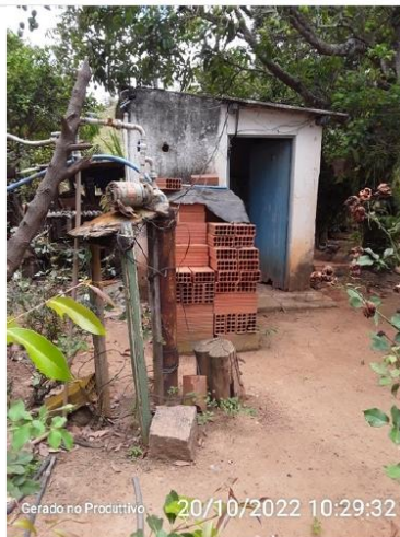
Poço da localidade de Santa Terezinha
