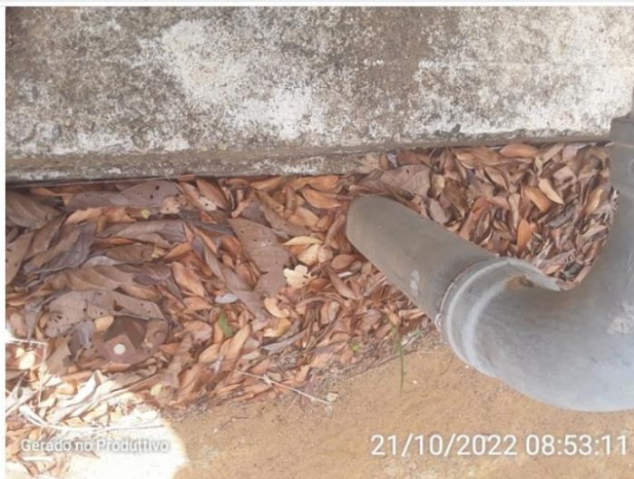
Válvula de fechamento na entrada do reservatório
