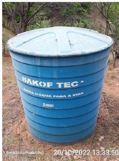
Cobertura do Reservatório
