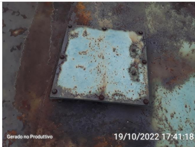
Caixa de gordura
