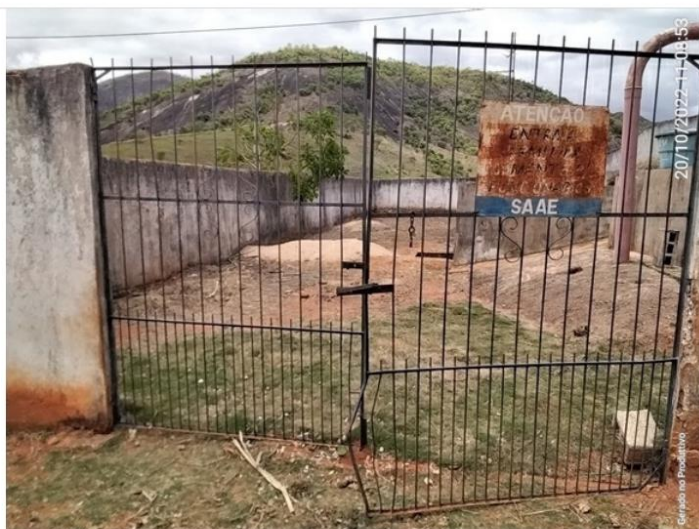
Portão de acesso
