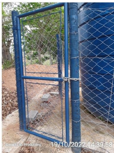
Portão de acesso a área do reservatório
