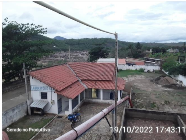
Tubos para descarga dos sólidos coletados
