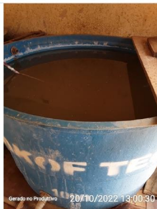
Tanque de preparo de solução
