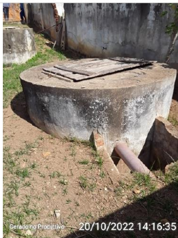
Poço de sucção
