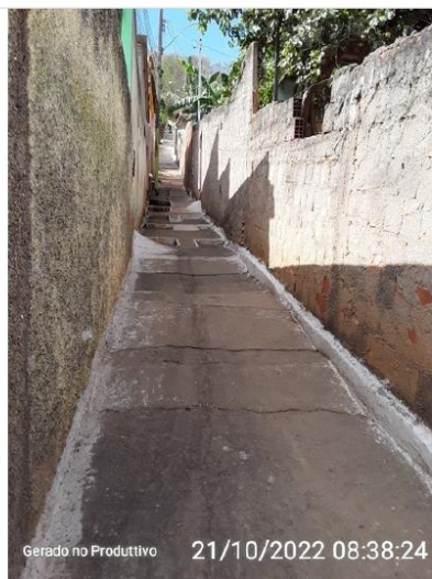
Escada de acesso
