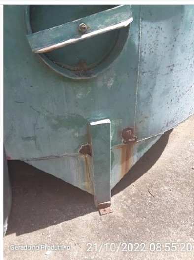
Estrutura do reservatório
