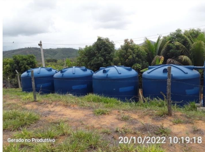
Reservatórios Nilton Freire
