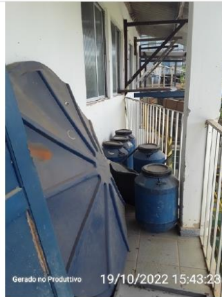
Materiais dispersos na área externa da casa de químicos
