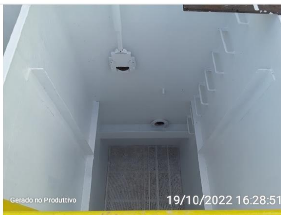
Impermeabilização e instalação de vigas para suporte na parte interna dos filtros.
