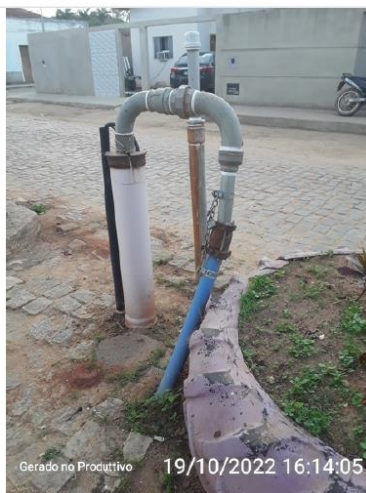
Poço São Sebastião da Vala
