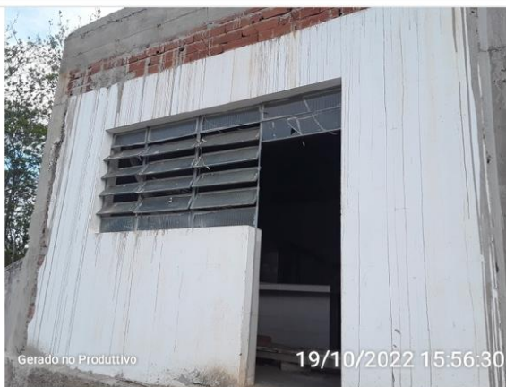
Construção do novo laboratório microbiológico
