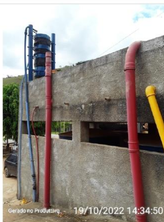
Área do local de tratamento da água
