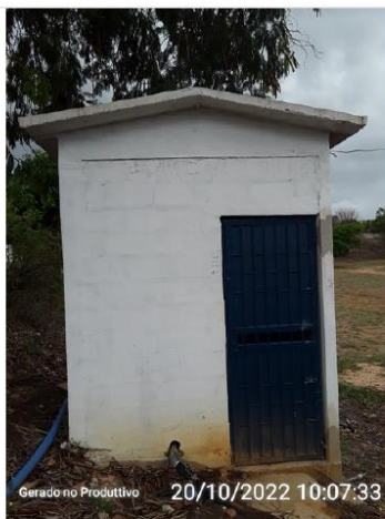
Portão de acesso
