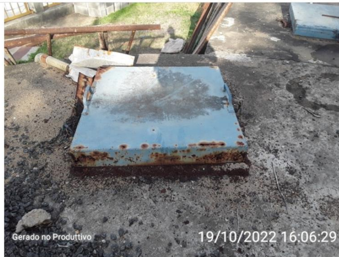
Tampa de inspeção - Reservatório redondo
