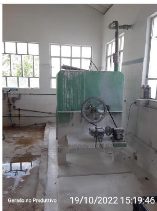
Vista Lateral - Agitador de Cal
