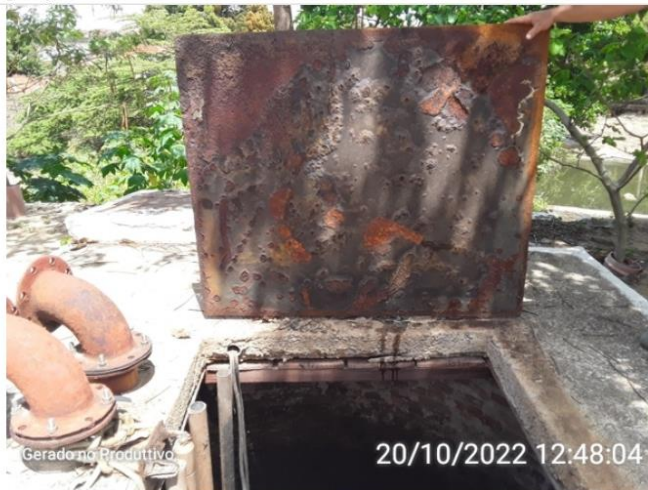
Tampa de inspeção em processo de oxidação
