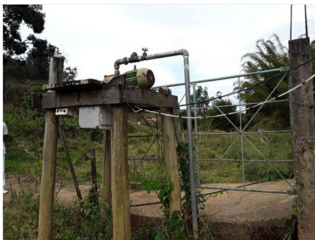
Estrutura de apoio
