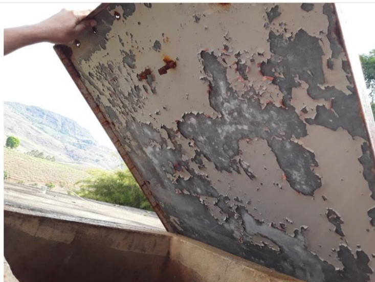
Parte interna da tampa de inspeção
