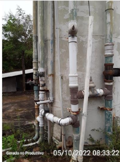
Válvulas de fechamento na entrada
