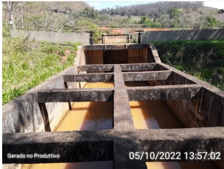
Tanque de sedimentação
