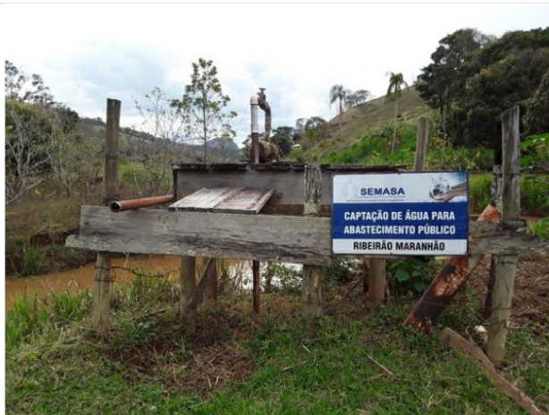
Estrutura da EEAB
