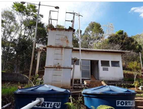
ETA - Distrito de Alvorada
