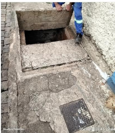
Tampa de inspeção
