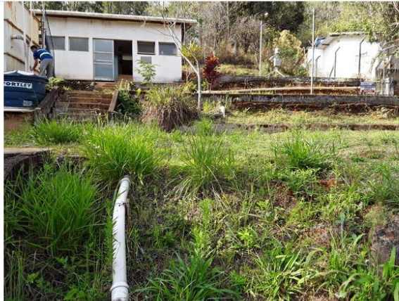
Vegetação alta no local da ETA
