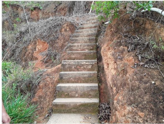
Escada de acesso a ETA
