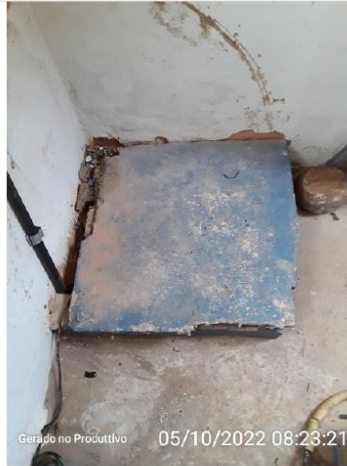
Tampa de inspeção
