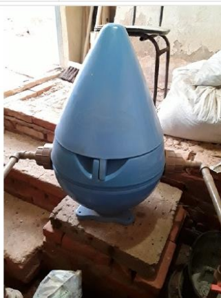
Clorador automático
