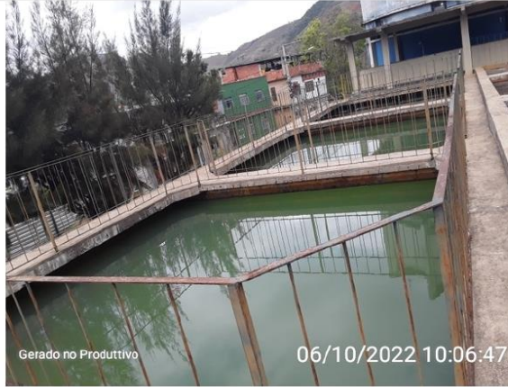
Proteção com guarda corpo
