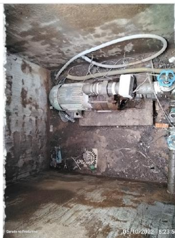
Piso com sistema de drenagem
