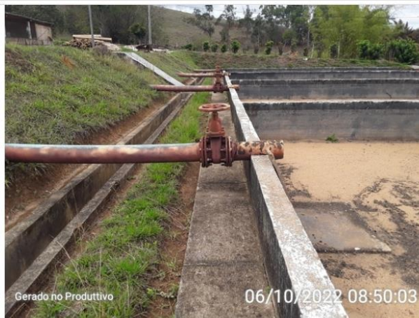
Descarga do lodo no leito
