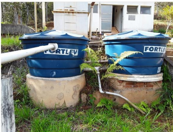
Tanques de contato - Fluoração e Correção de pH
