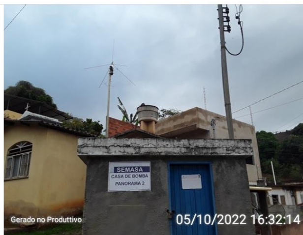
Antena de telemetria
