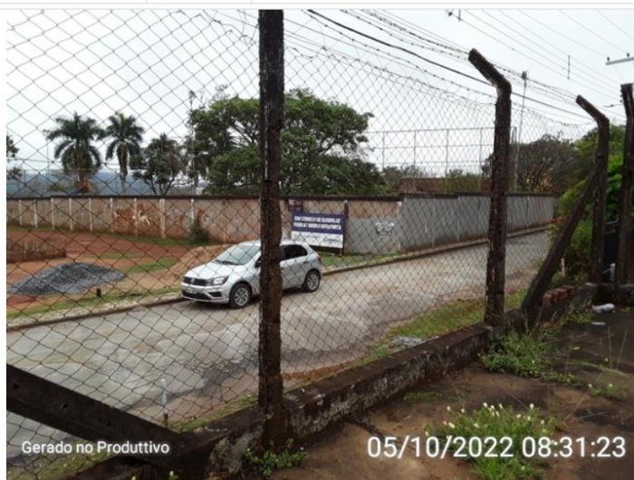
Cercamento do reservatório
