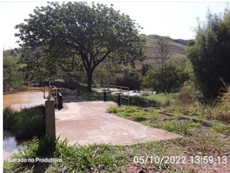
Estrutura de captação superficial
