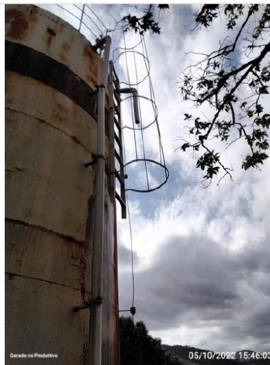
Escada de acesso
