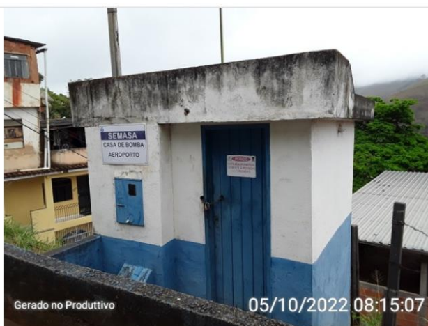
Casa de bombas
