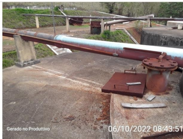
Saída de gases inativo
