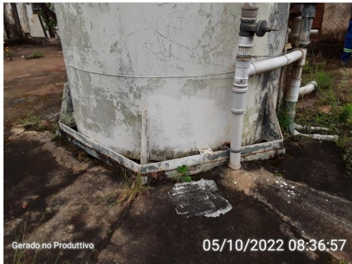
Estrutura do reservatório
