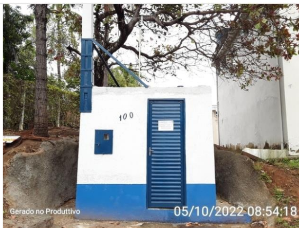
Casa de bombas
