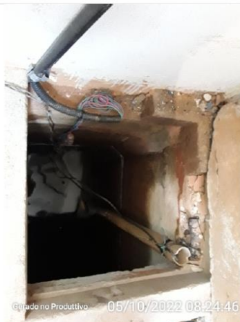
Boia de nível e dispositivo de telemetria
