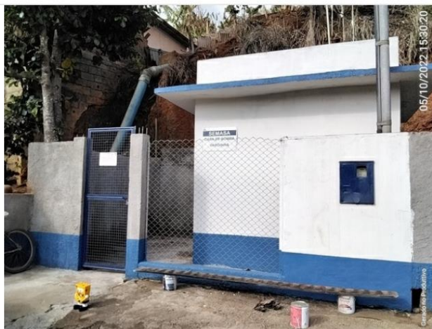
Casa de bombas
