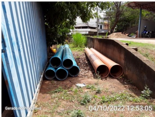
Tubos dispostos na área da garagem sem codificação
