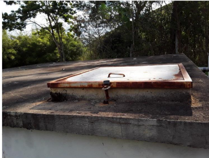
Tampa de inspeção
