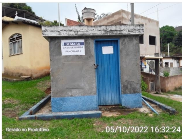
Casa de bombas
