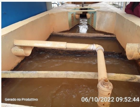
Barreiras para ajudar na mistura do coagulante na calha
