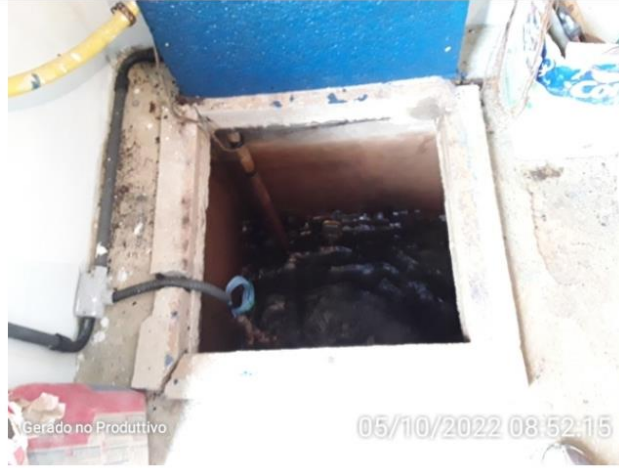
Poço de sucção
