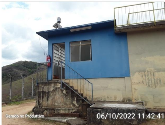
Casa de bombas
