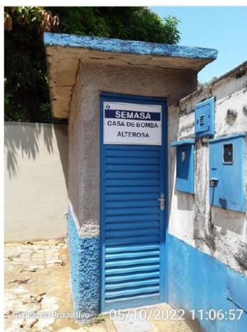
Casa de bombas
