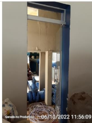
Porta saída de emergência
