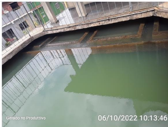
Passagem da água decantada para os filtros
