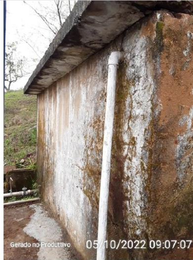
Entrada de água no reservatório
