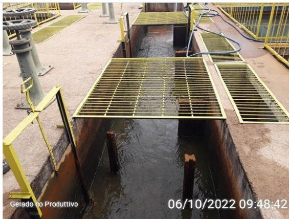
Descarga dos filtros
