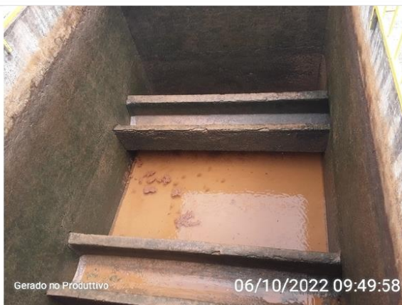
Limpeza dos filtros
