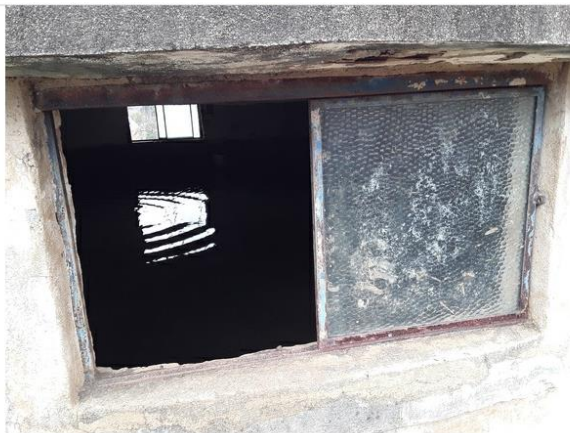
Local de inspeção com abertura
