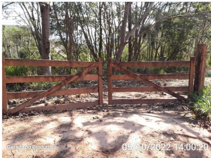
Portão de acesso
