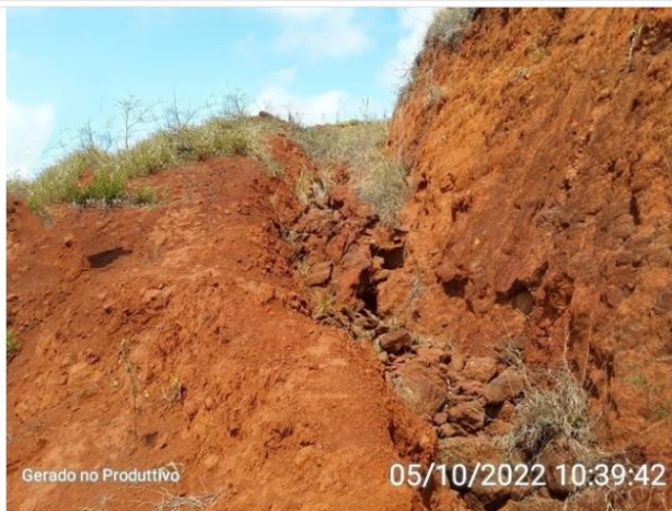
Acesso a casa de bombas
