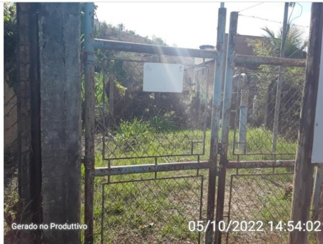
Portão de acesso
