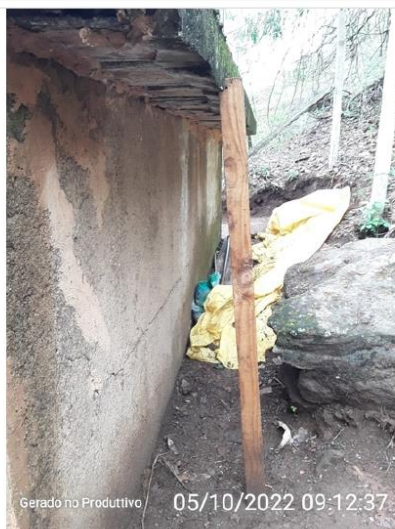
Ancoramento da parte superior do reservatório
