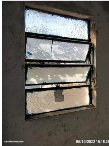
Sistema de ventilação e iluminação natural
