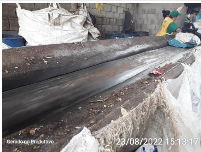
Esteira de triagem de resíduos em funcionamento
