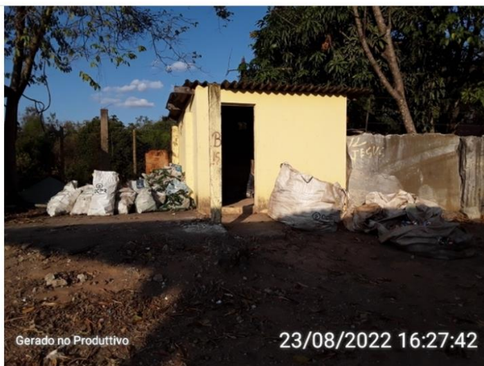
Vias de acesso sem pavimentação
