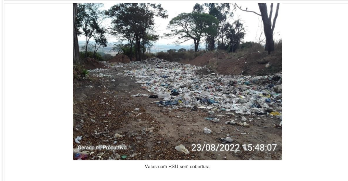
Valas de rejeitos sem cobertura
