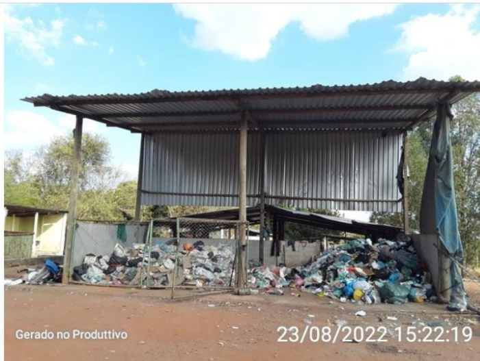
Cobertura com altura adequada
