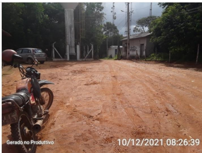
Via sem pavimentação
