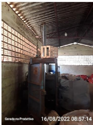
Prensa hidráulica no local da UTC desativada
