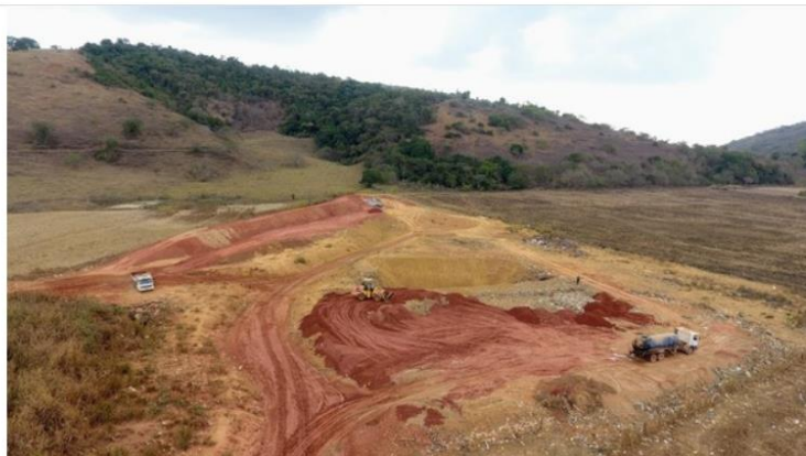
Aterro controlado de Raul Soares
