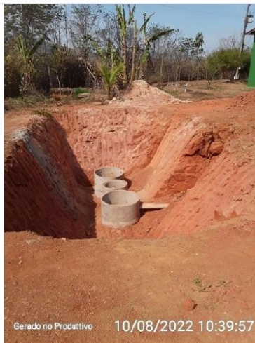
Fossa séptica em construção
