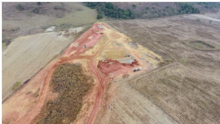
Aterro controlado de Raul Soares
