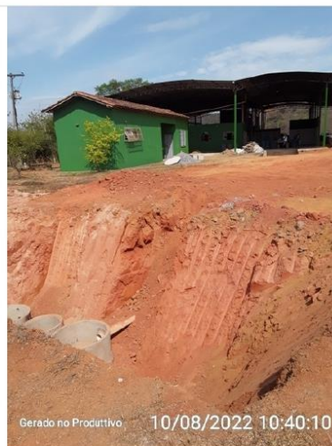
Fossa séptica em construção
