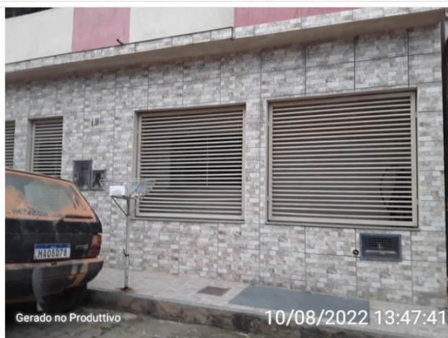
Acondicionamento de resíduos
