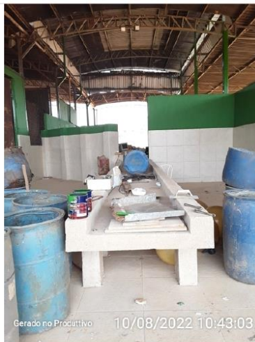
Fossa séptica em construção
