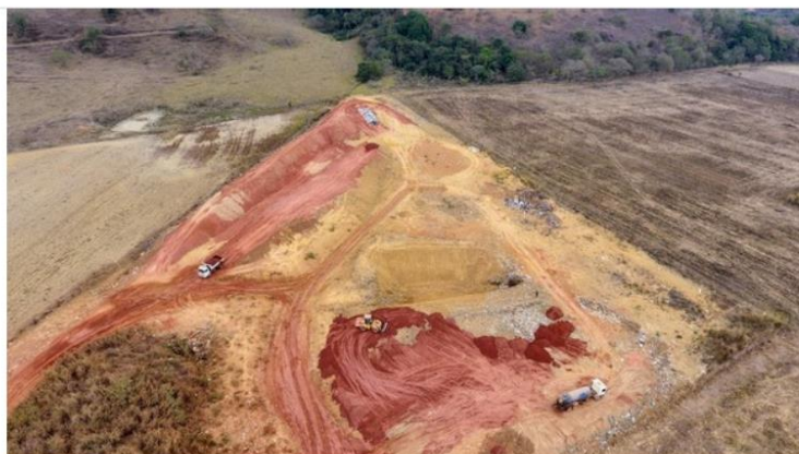
Aterro controlado de Raul Soares
