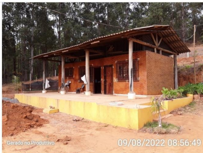
Área administrativa, cozinha e sanitários
