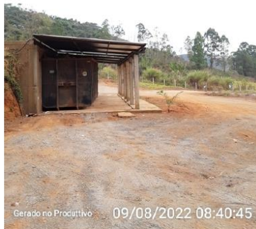
Cobertura do container
