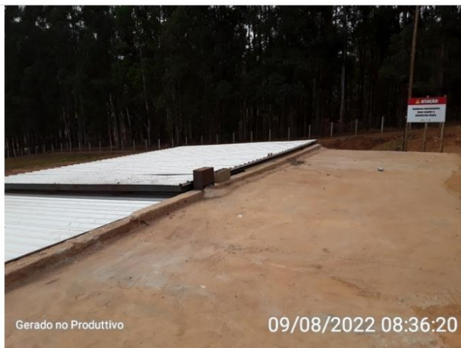
Cobertura do container
