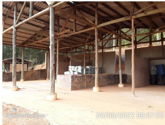
Estrutura da UTC
