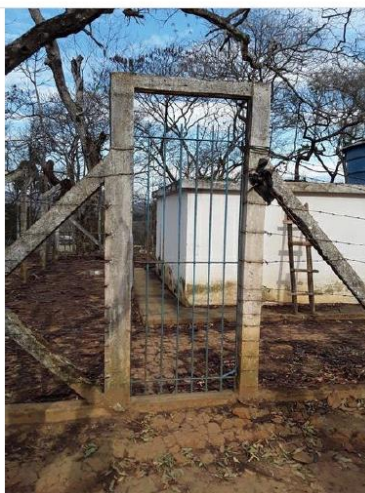
Reservatório Concreto - Conceição da Boa Vista
