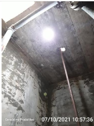
Iluminação para trabalhos noturnos
