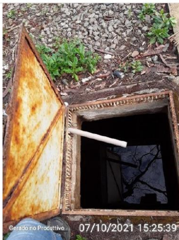
Tampas de inspeção do reservatório.
