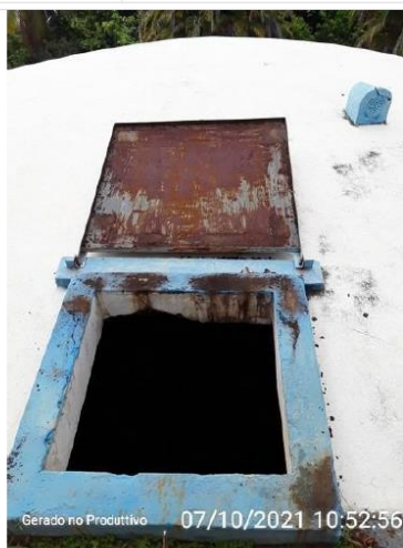
Tampa de inspeção do reservatório.
