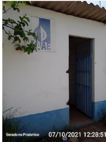
Acesso à EEAT
