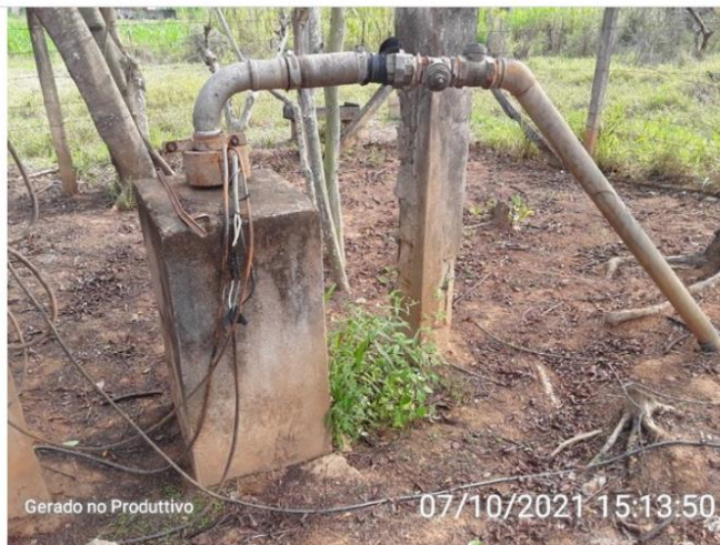
Ausência de laje sanitário de 1,5 m x 1,5 m
