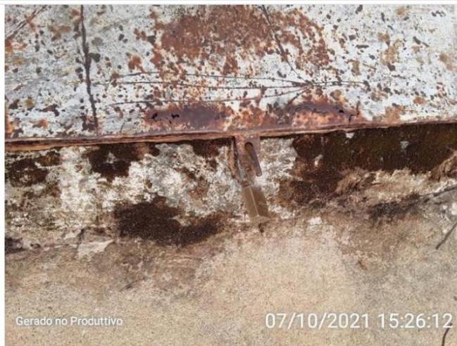
Cadeado da tampa de inspeção.
