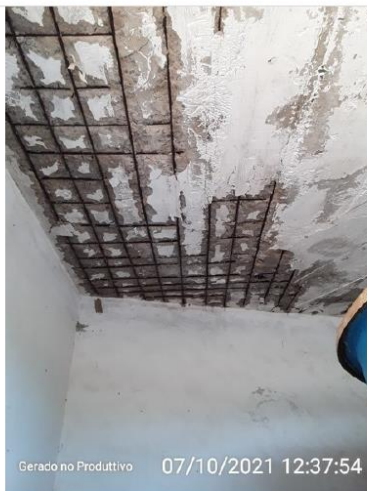
Armadura exposta na laje da casa de bomba.
