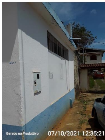
Vista do acesso à elevatória.
