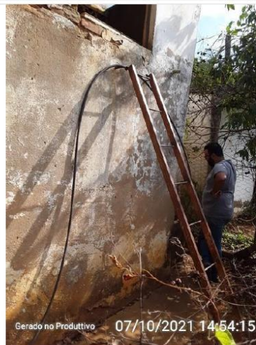
Escada de acesso ao reservatório.
