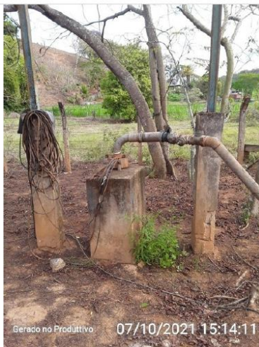
Vista do Poço
