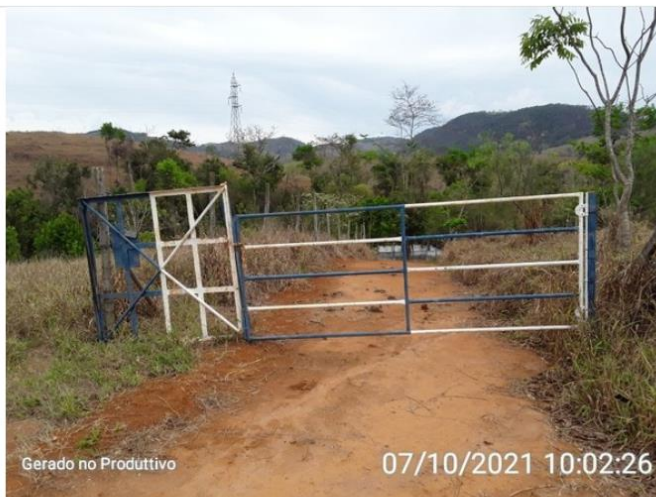
Acesso à captação.
