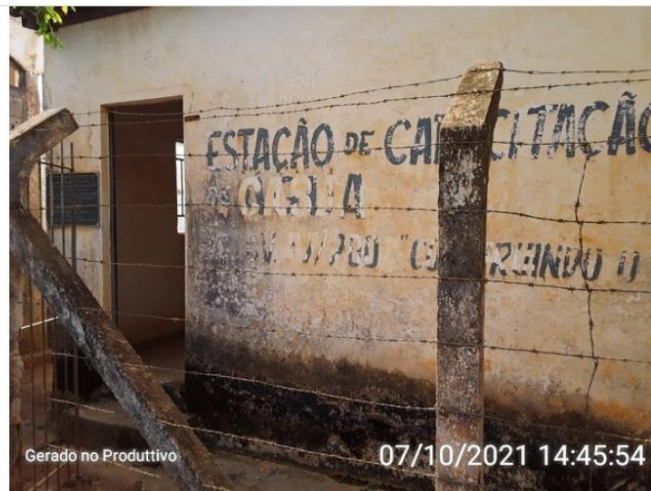
Acesso à área da EE.
