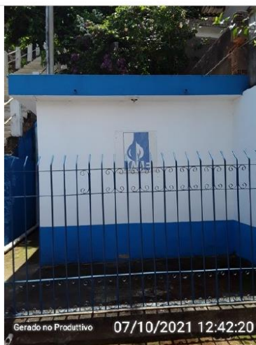
Acesso à EEAT Canto dos Ferreiras
