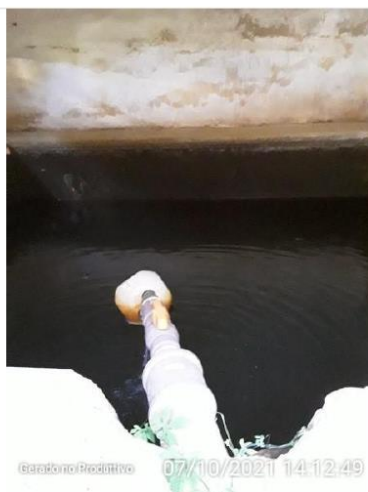
Interior do Reservatório.
