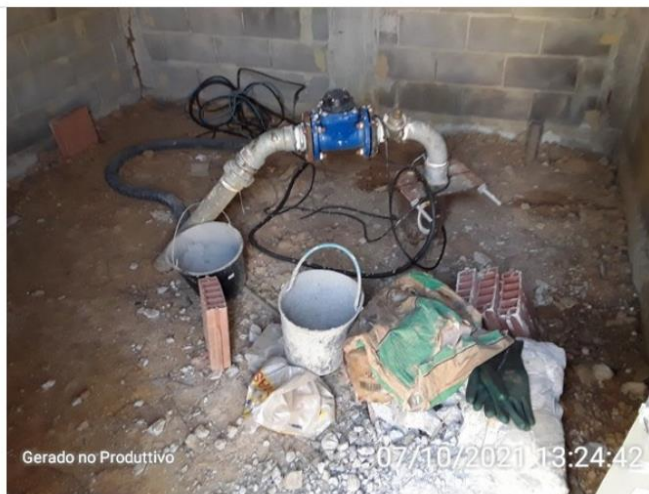
Materiais de construção armazenados junto ao poço (2) .
