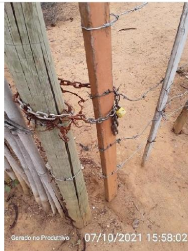
Portão de acesso com cadeado.
