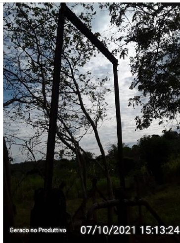
Estrutura de apoio para o içamento da bomba.
