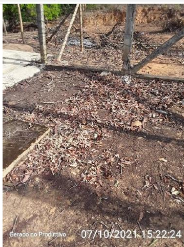
Necessidade de limpeza da área.
