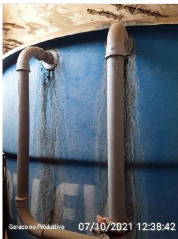
Vazamento no reservatório de sucção.
