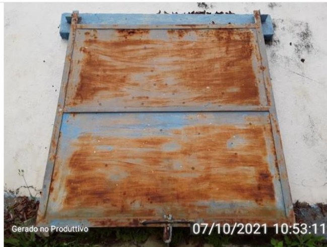
Tampa de inspeção do reservatório (2).
