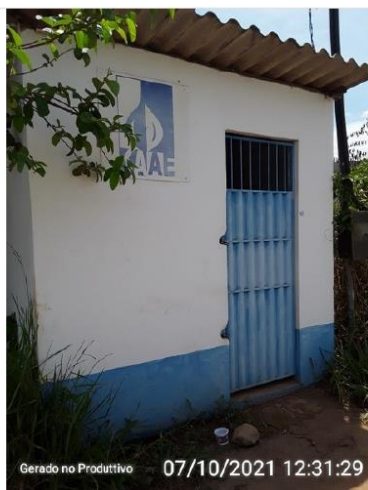
Vista da EEAT.
