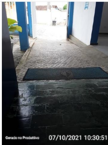
Rampa de acesso ao ponto de atendimento.
