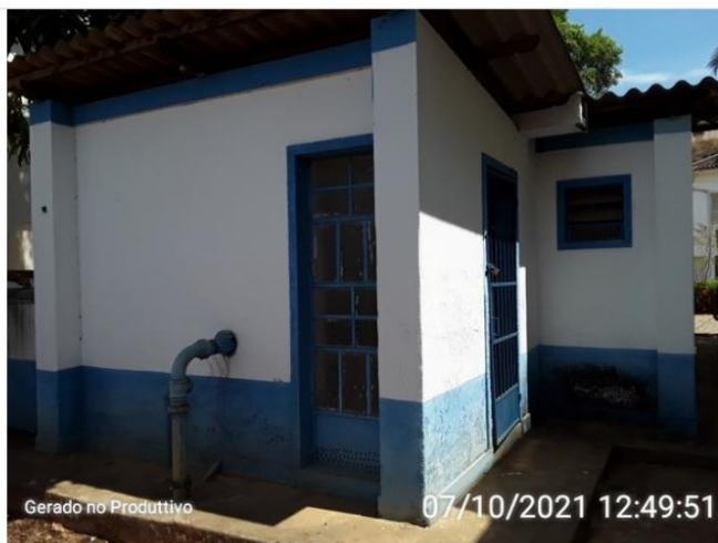
Acesso à EEAT
