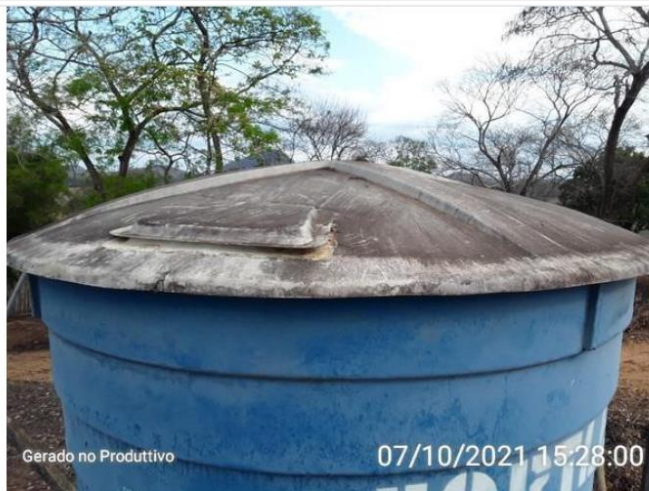
Tampa de inspeção do reservatório.
