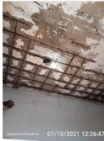
Iluminação utilizada para trabalhos noturnos.
