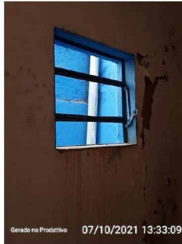
Janela para ventilação e/ou renovação do ar.
