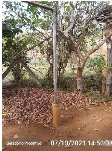
Vista do poço.
