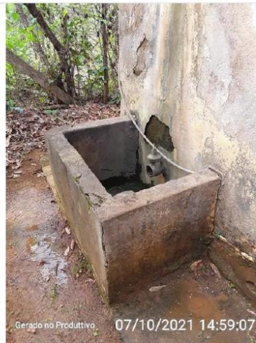
Caixa de descarga para o tubo extravasor.
