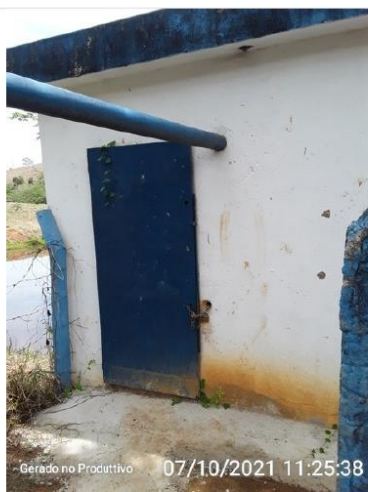
Área de acesso à EE.
