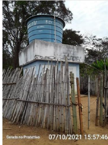
Cercamento da área do reservatório.
