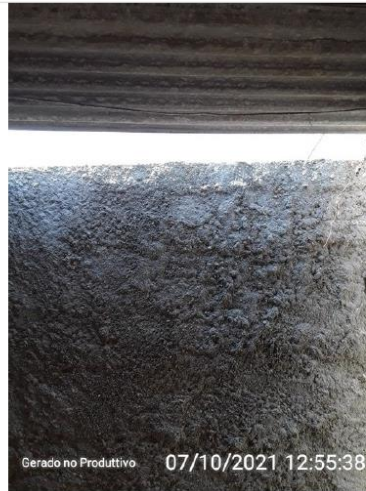
Dispositivo de ventilação e/ou renovação do ar.
