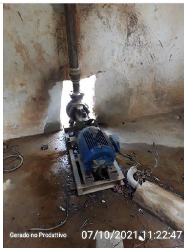
Vista da EE.
