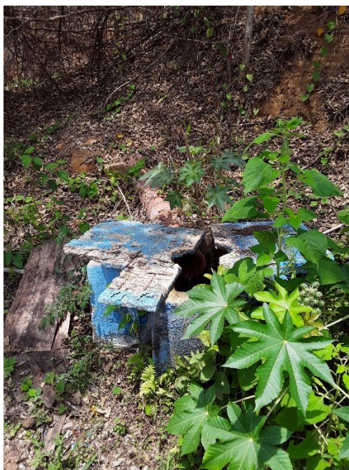
Figura 6 – Chegada do efluente na ETE.
