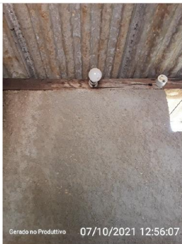
Iluminação para trabalhos noturnos.
