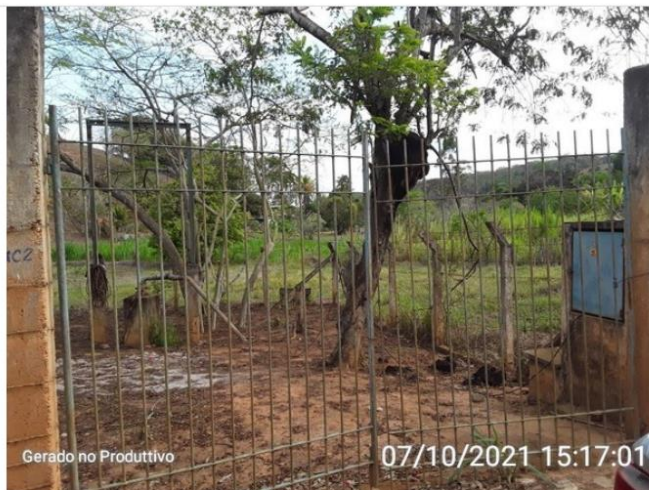
Portão de acesso à área do Poço.
