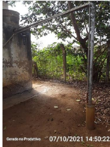
Vista do poço (2).
