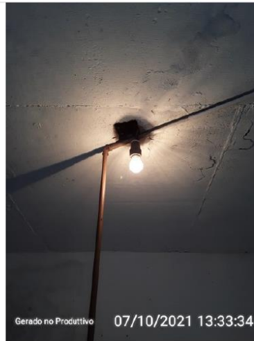
Iluminação para trabalhos noturnos.
