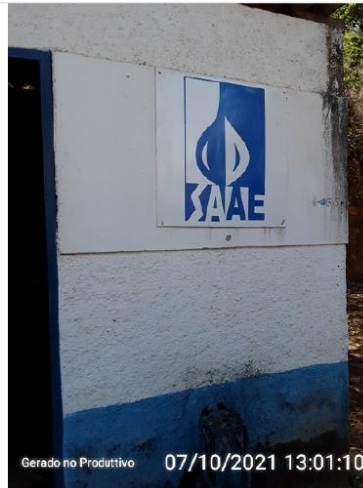
Acesso à EEAT Grotinha
