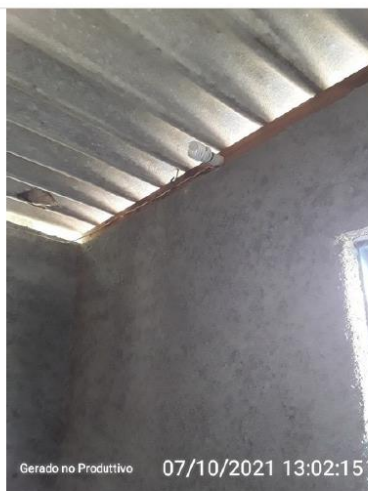
Iluminação para trabalhos noturnos.
