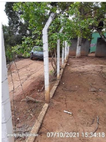
Cercamento da área do reservatório.
