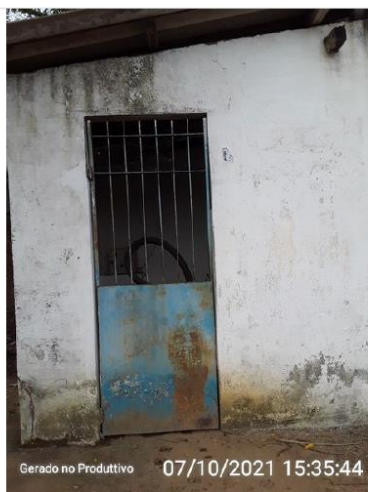
Acesso à EEAT.
