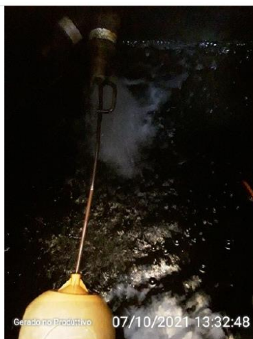
Interior do reservatório de sucção.
