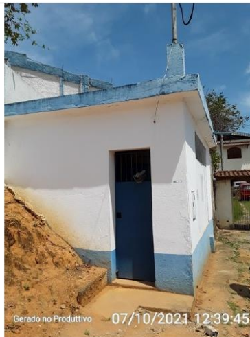
Acesso e cercamento da EEAT.
