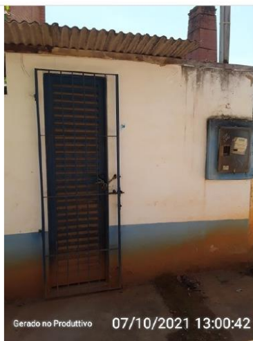
Acesso à EEAT Avenida.
