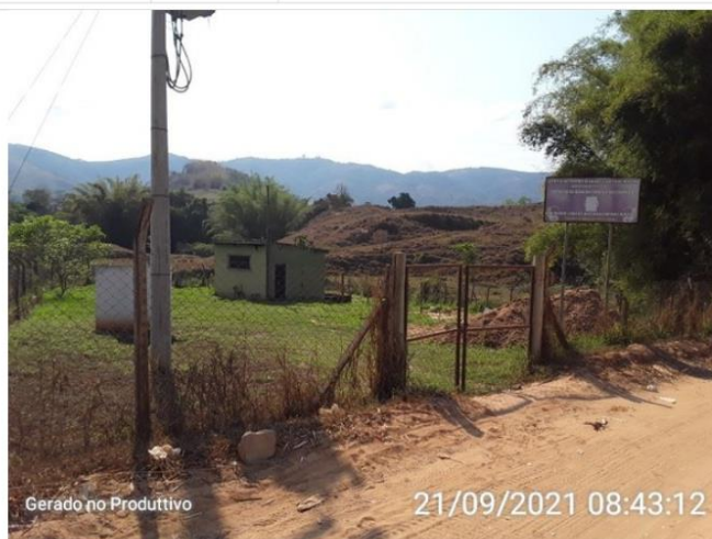
Área da captação
