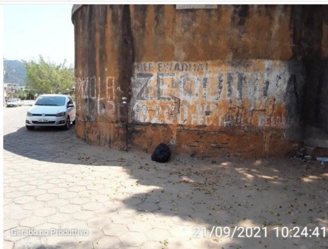
Reservatório Vila Vicentina
