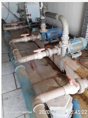
Sistema de drenagem dos pisos
