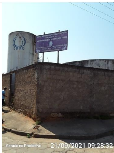
Área do reservatório
