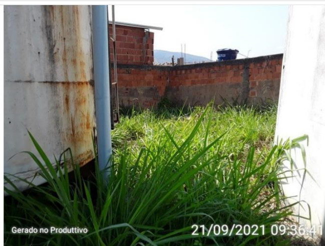
Área do reservatório
