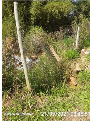
Área próxima ao poço de sucção
