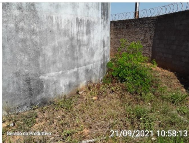
Área do reservatório
