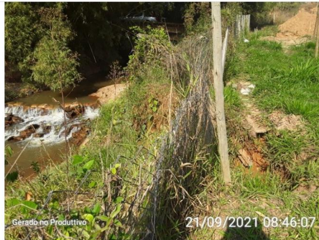
Área da captação
