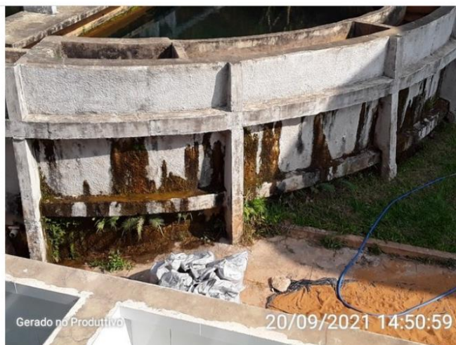
Estrutura dos floculadores e decantador
