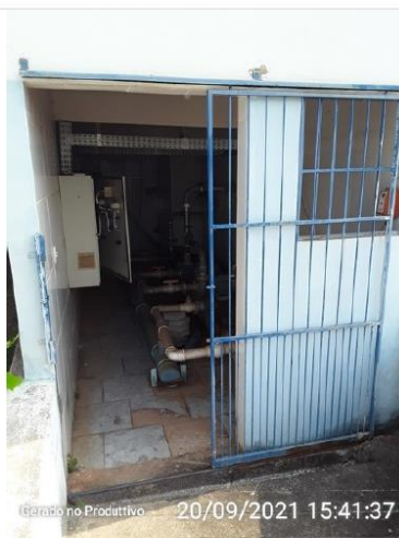
Estação elevatória ETA
