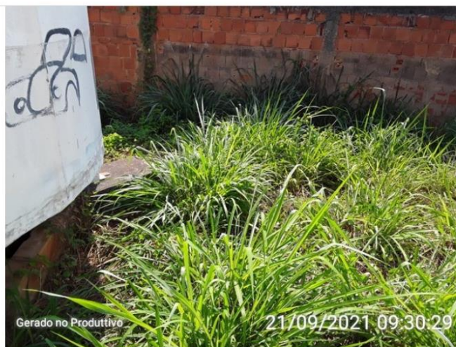
Área do reservatório
