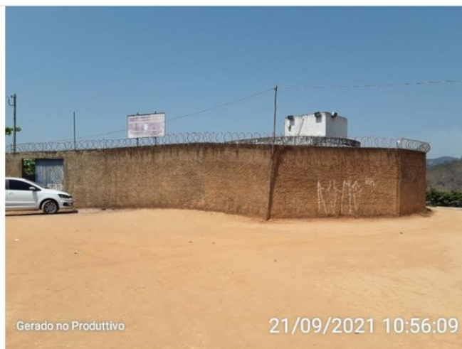
Área do reservatório
