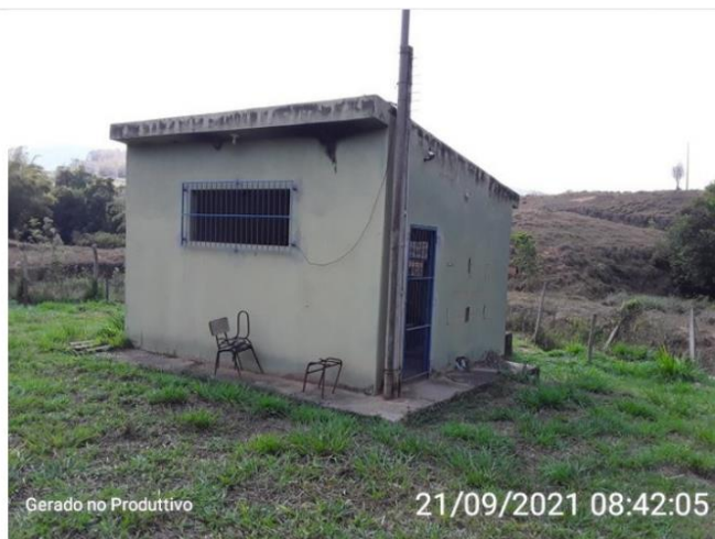
Casa de bombas
