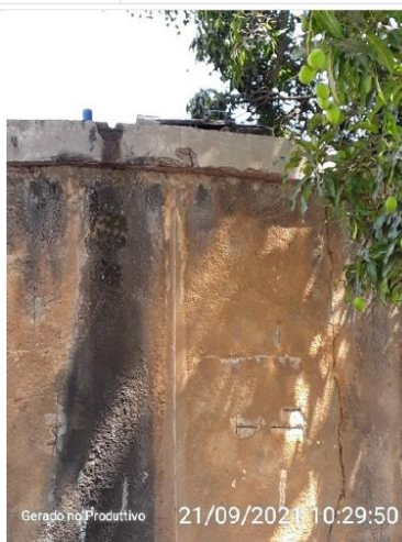
Tampa de inspeção
