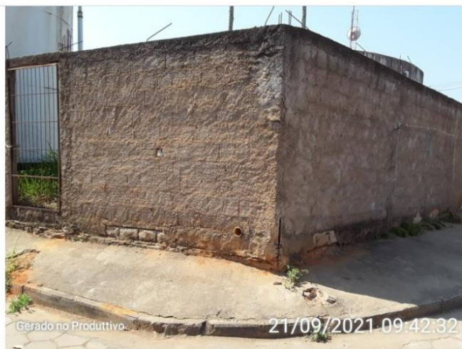
Área do reservatório
