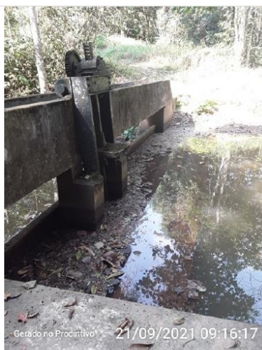
Barragem da captação Tabuleiro
