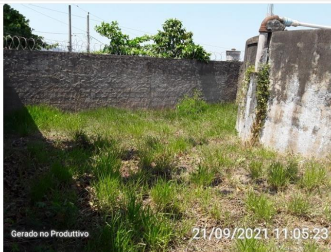
Área do reservatório
