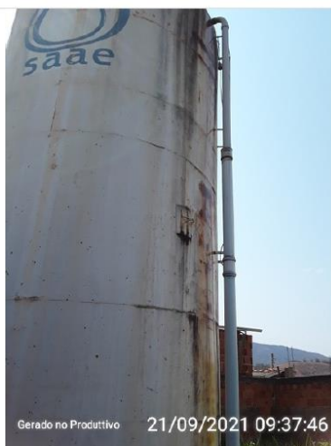
Reservatório de estrutura metálica
