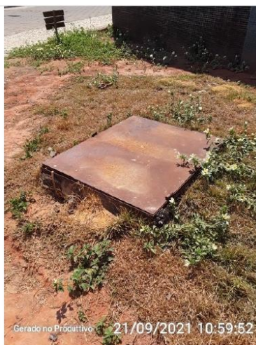
Área do Poço
