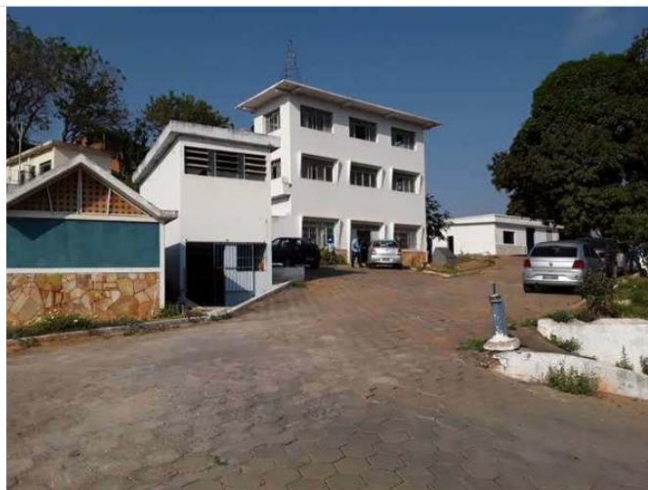
Área da ETA
