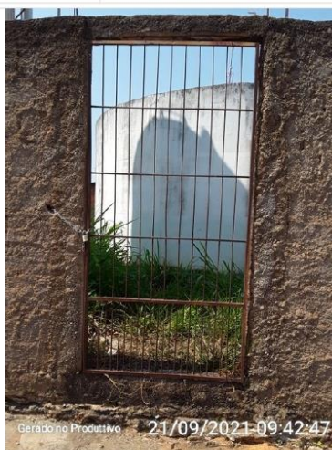
Portão de acesso a área do reservatório
