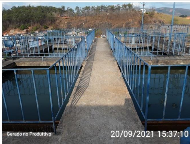
Guarda - corpo na área da ETA
