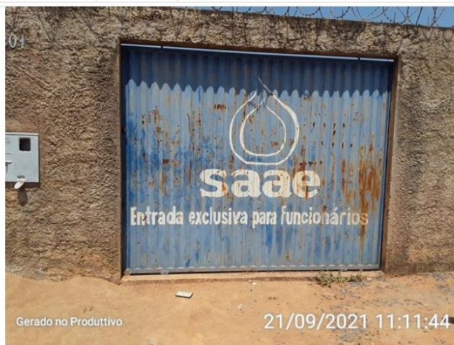
Portão e acesso a área do reservatório
