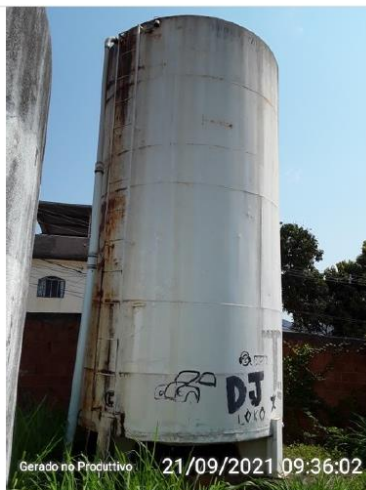
Reservatório de estrutura metálica
