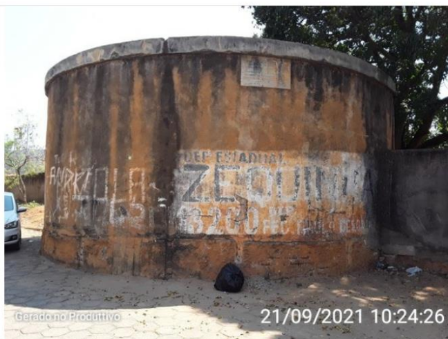
Reservatório Vila Vicentina
