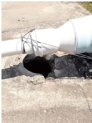
Tubulação de ventilação
