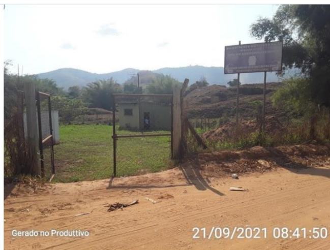
Área da captação no Córrego Cobrador
