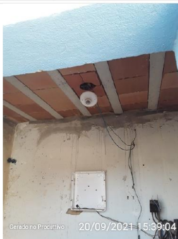
Sistema de iluminação sem a lâmpada
