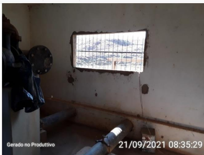
Janela na casa de bomba
