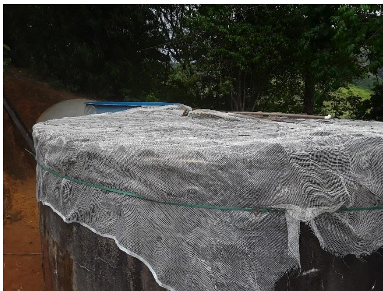
Figura 192 – Cobertura do reservatório de concreto
