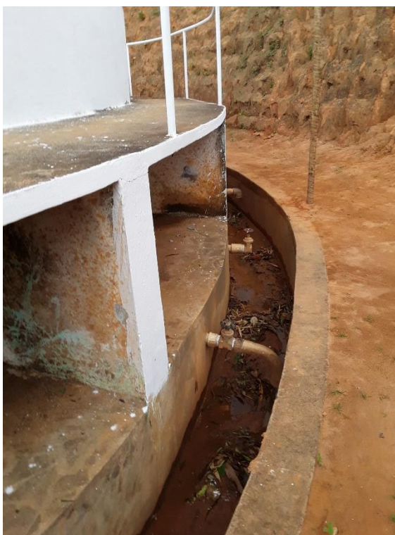
Figura 59 – Registros de descarga
