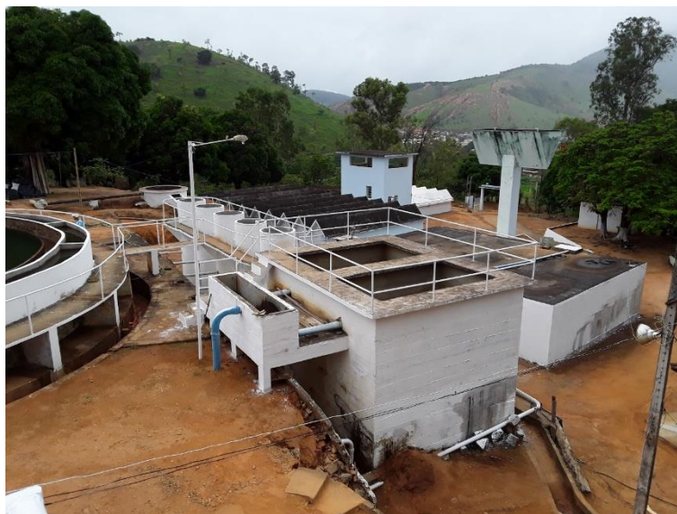
Figura 47 – Área dos filtros
