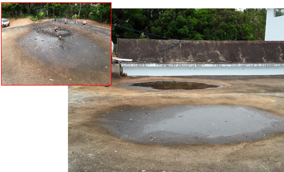
Figura 111 – Cobertura do Reservatório
