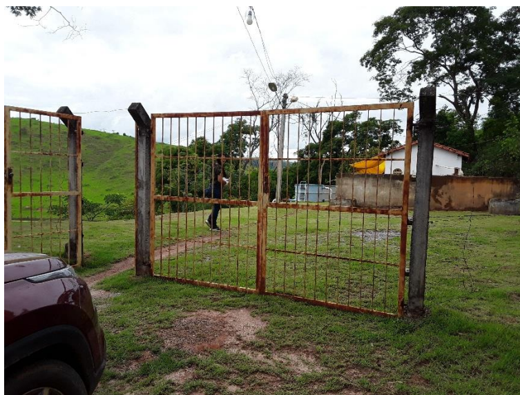
Figura 135 – Portão da ETA mantido aberto
