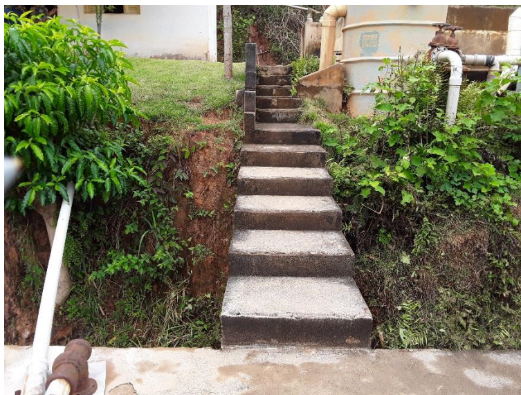
Figura 148 – Escada de acesso à cobertura do reservatório
