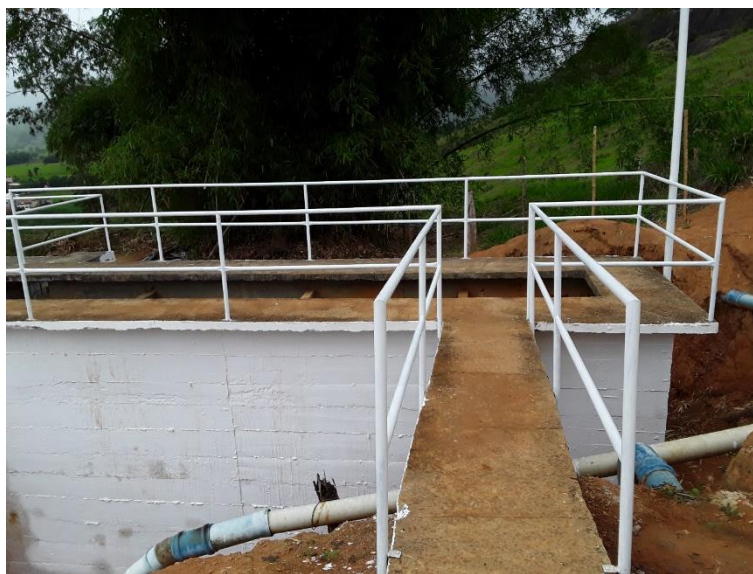
Figura 44 – Rampa de acesso a ETA I
