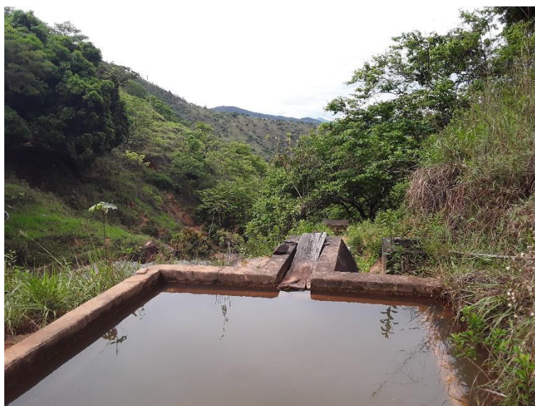
Figura 25 - Desarenador
