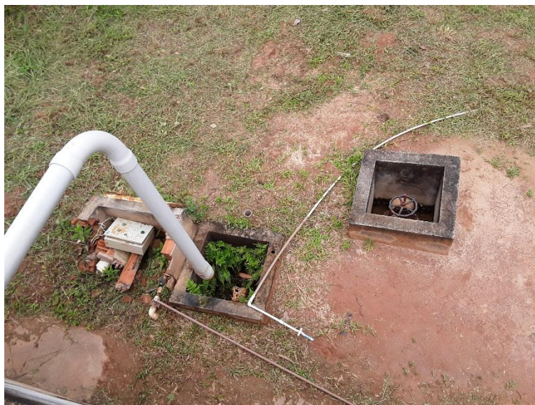
Figura 143 – Tubo extravasor e registro de saída
