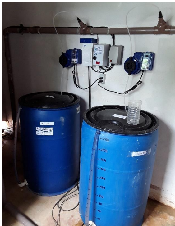
Figura 166 – Aplicação do sulfato de alumínio e do hipoclorito de cálcio
