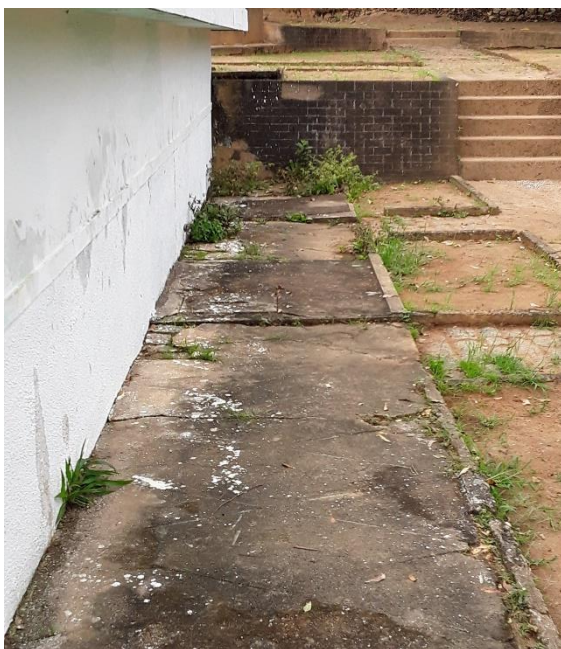
Figura 119 – Lateral do reservatório
