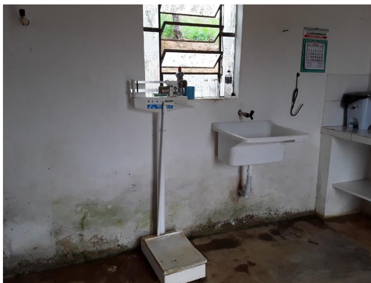
Figura 69 – Balança e tanque
