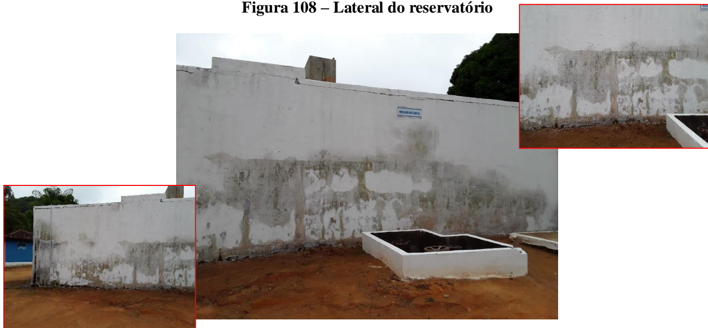
Figura 108 – Lateral do reservatório
