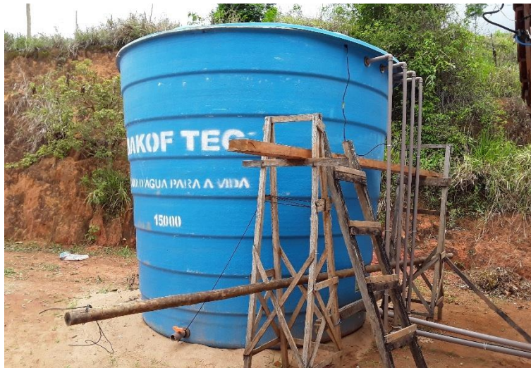
Figura 168 – Andaime utilizado para verificar o interior da caixa
