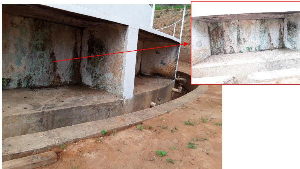
Figura 57 – Lateral da estrutura do decantador
