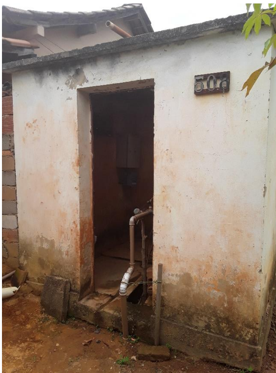
Figura 178 – Área do poço I
