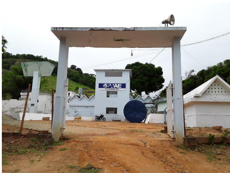
Figura 34 – Entrada das ETAs da Sede de Pocrane
