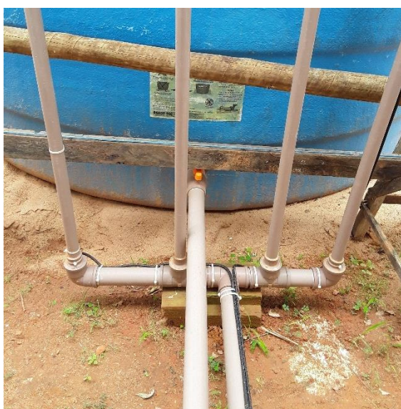
Figura 167 – Ramificação da tubulação após aplicação de produtos
