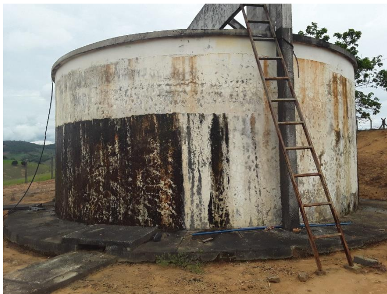
Figura 184 – Reservatório do Povoado de Taquaral
