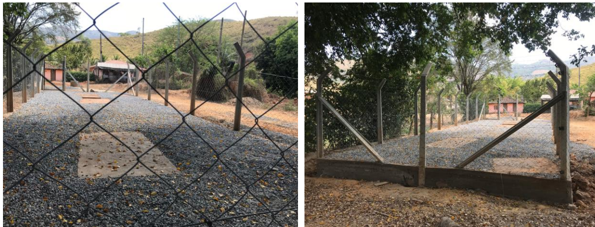
Figura 195 – Área da ETE
