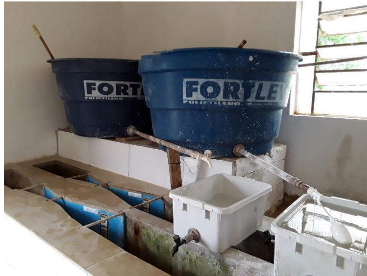
Figura 41 – Calhas Parshall
