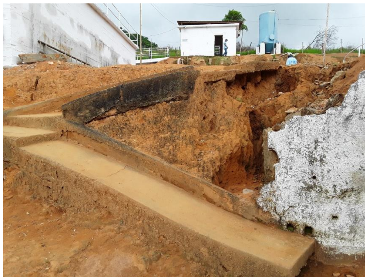
Figura 36 – Rampa de acesso a área de tratamento
