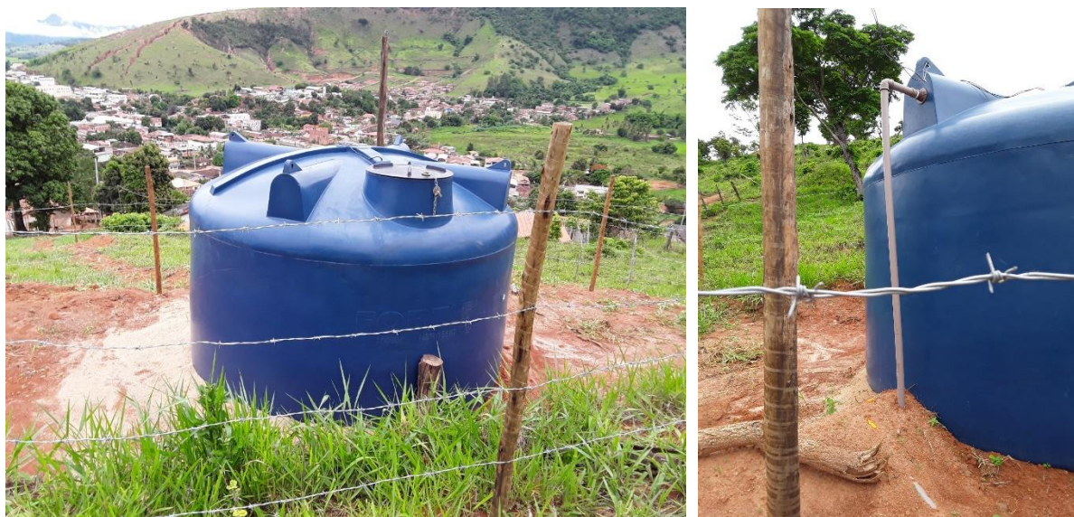
Figura 124 – Reservatório – 15 m 3
