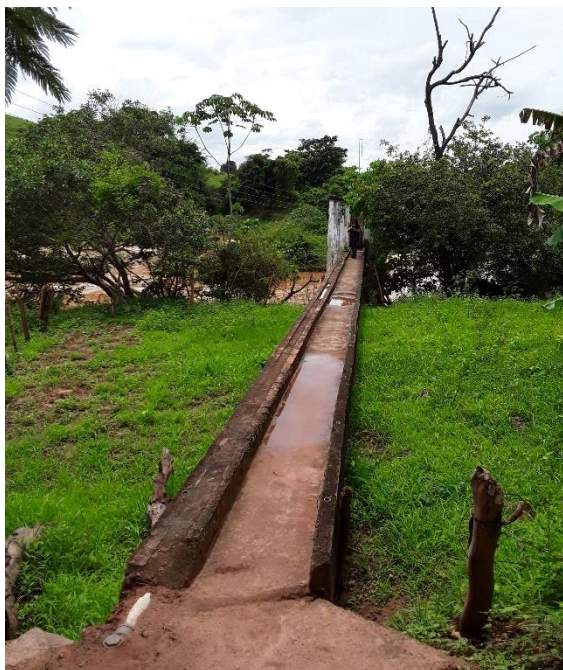
Figura 130 – Acesso à casa de bombeamento
