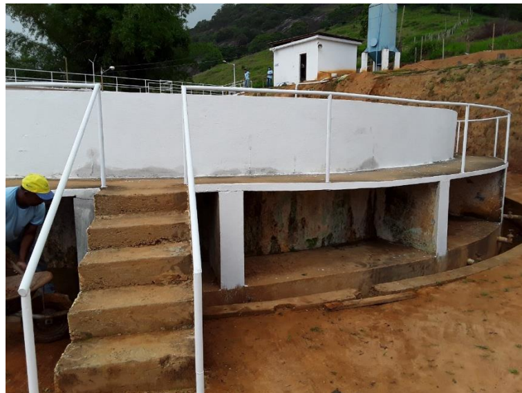
Figura 54 – Escada de acesso a área do decantador
