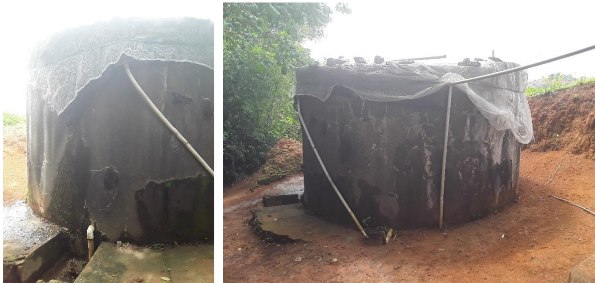
Figura 191 – Reservatório de concreto
