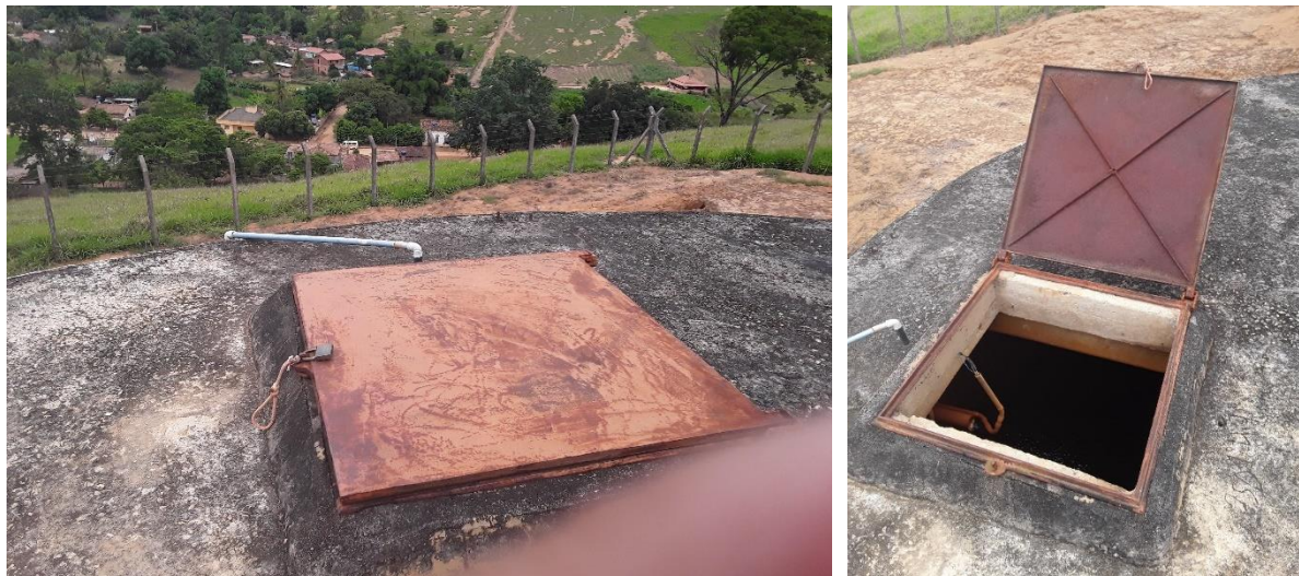
Figura 186 – Tampa de inspeção do reservatório – Taquaral
