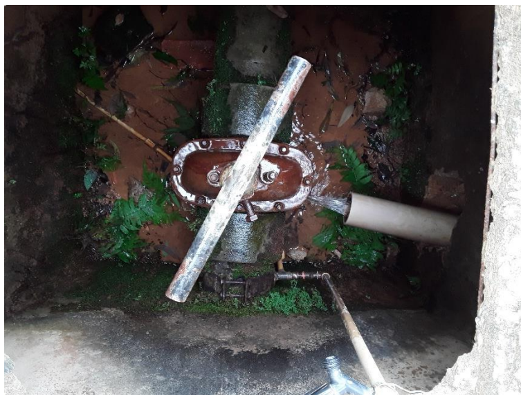
Figura 120 – Válvula de Saída
