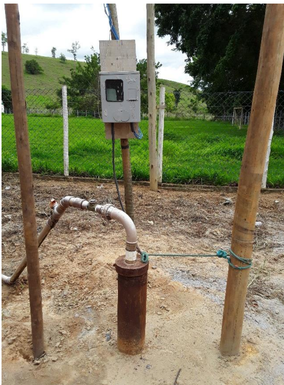
Figura 162 – Captação subterrânea
