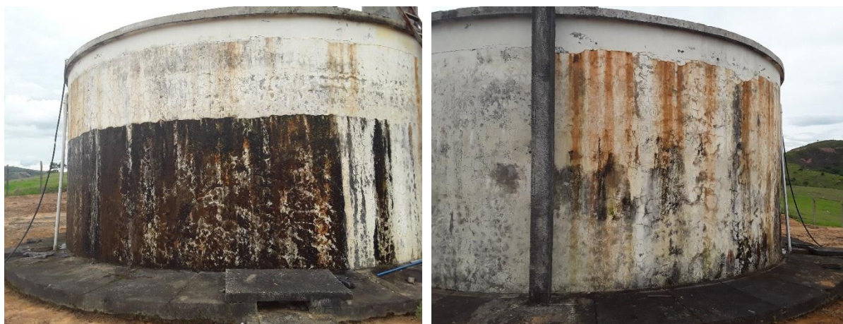
Figura 185 – Lateral do reservatório – Taquaral
