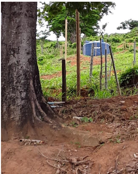
Figura 123 – Reservatório de distribuição – São Mateus
