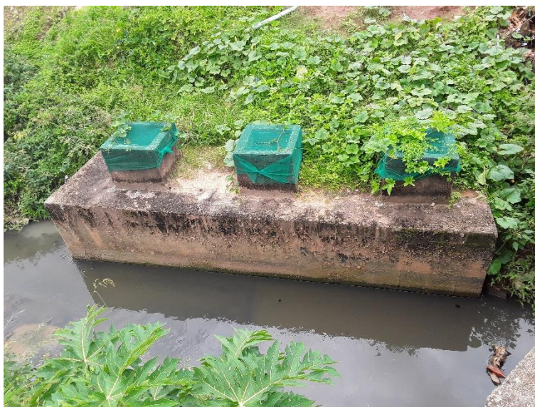
Figura 127 – Estrutura antiga do SES
