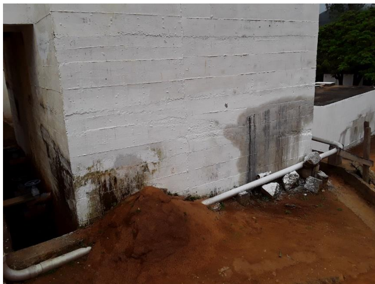
Figura 50 – Lateral dos filtros
