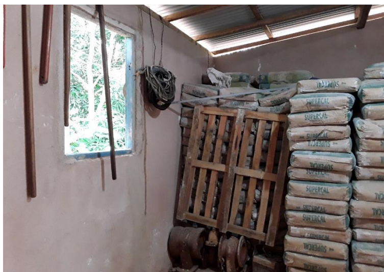
Figura 104 – Janela do almoxarifado
