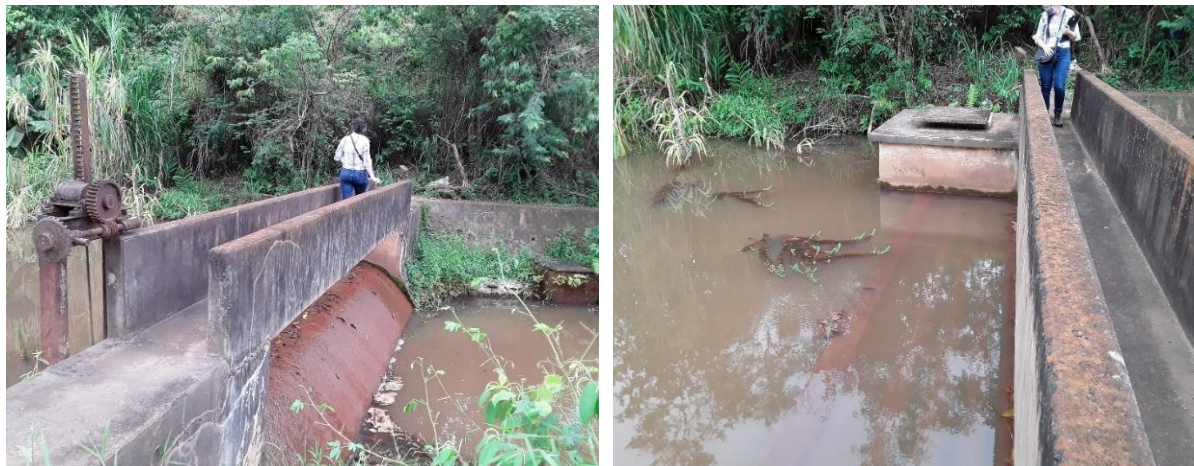
Figura 32 – Barragem de nível – Ribeirão Pocrane
