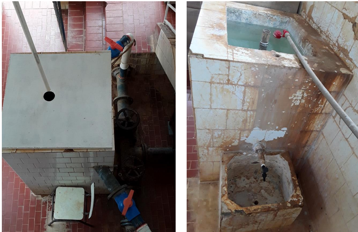
Figura 95 – Antigo local de dosagem do cloro
