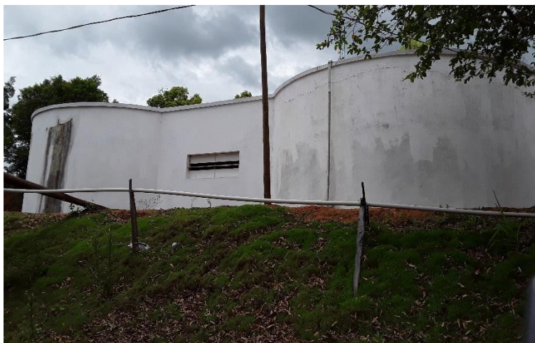
Figura 171 – Reservatório de água tratada
