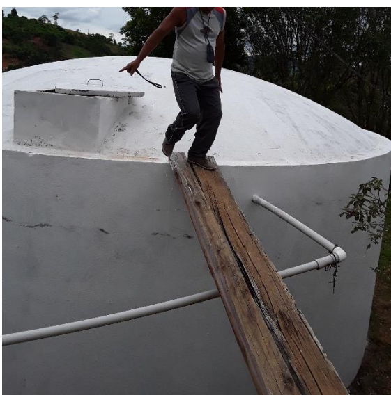
Figura 177 – Acesso à tampa de inspeção
