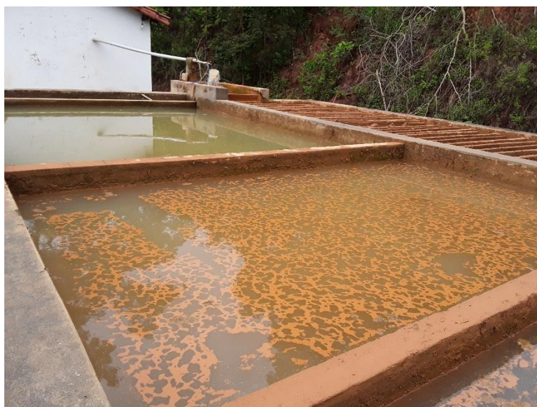
Figura 138 – Decantador
