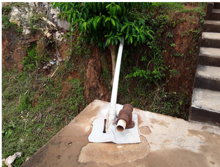
Figura 142 – Local de aplicação do hipoclorito de cálcio
