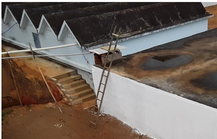
Figura 110 – Escada de acesso a cobertura do reservatório
