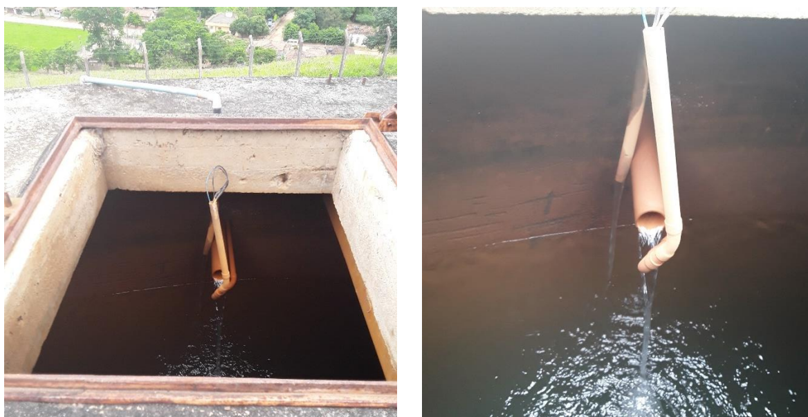
Figura 187 – Área interna do reservatório - Taquaral
