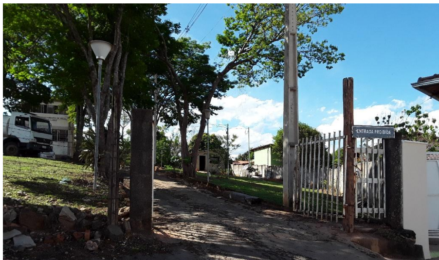
Figura 22 – Entrada da ETA Onofre Pinto
