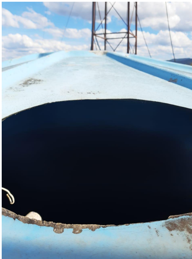
Figura 88 – Tampa de inspeção – Manoel Sampaio
