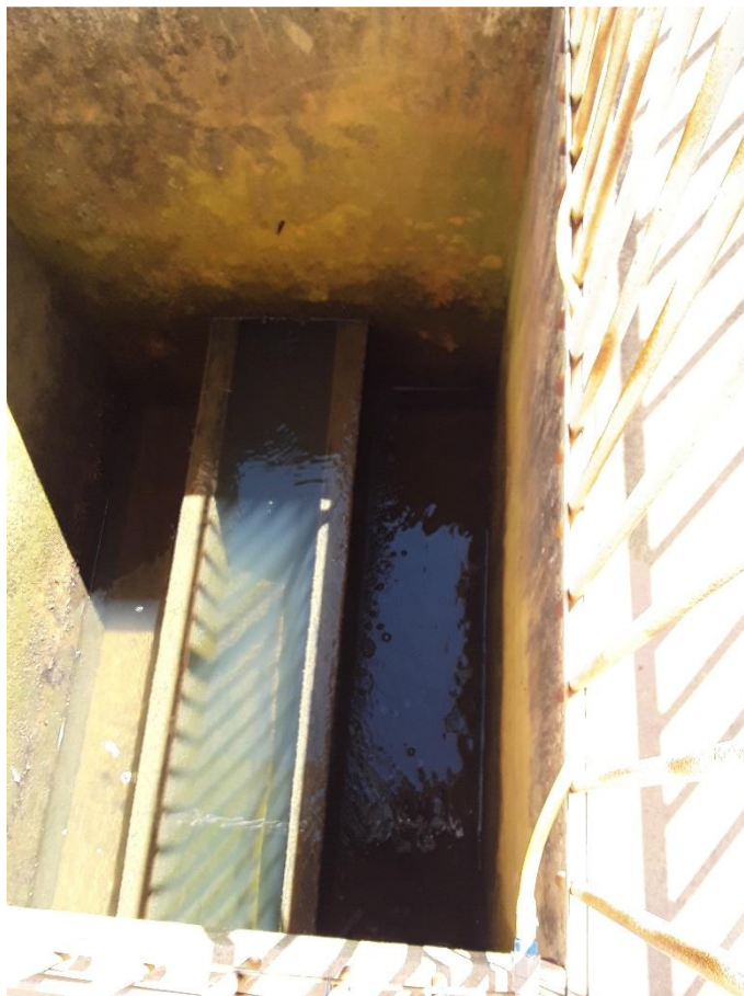
Figura 32 – Filtro rápido
