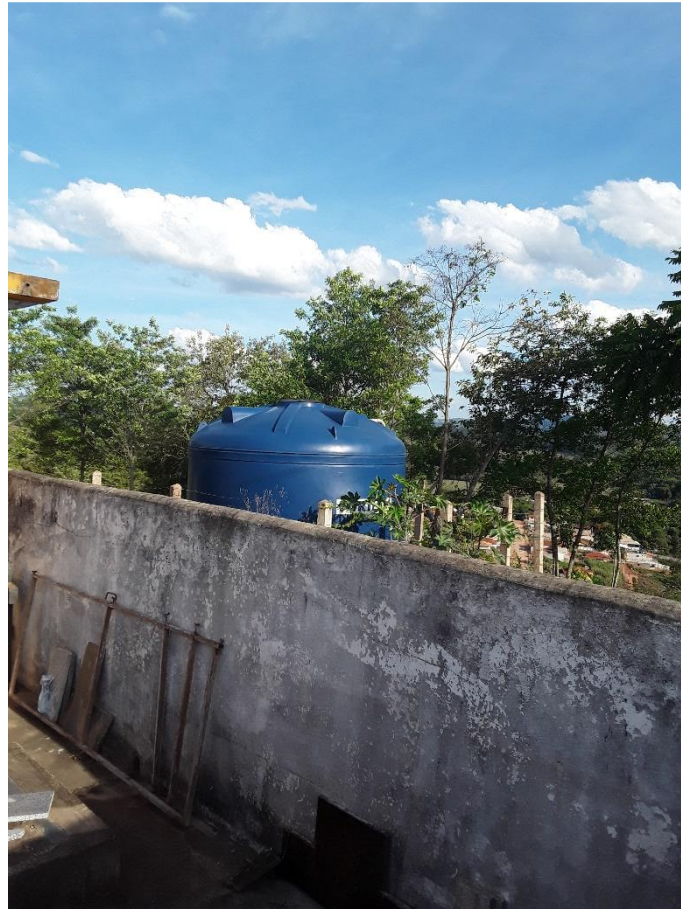
Figura 97 – Área do reservatório Santa Matilde
