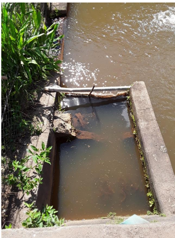
Figura 13 – Captação com gradeamento e tela
