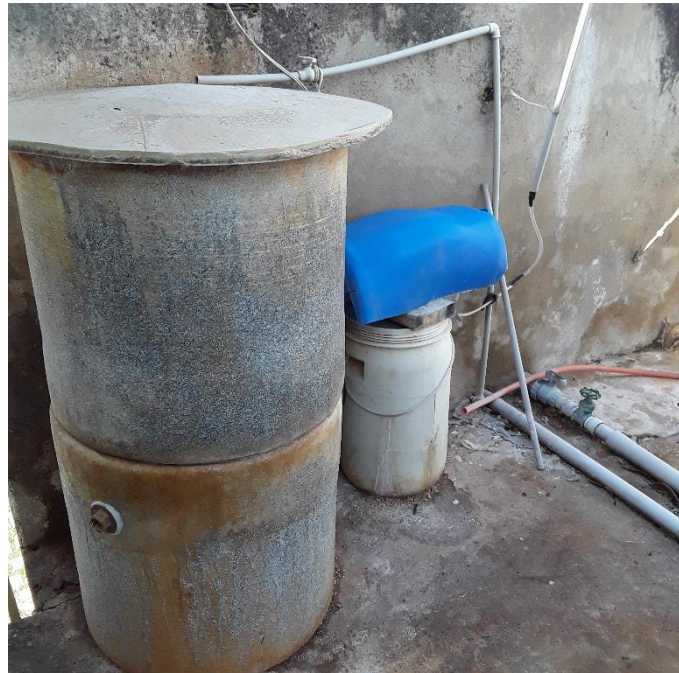
Figura 83 – Recipiente com solução de hipoclorito de cálcio
