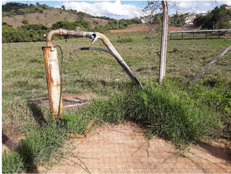
Figura 78 – Poço Morro do Cipó
