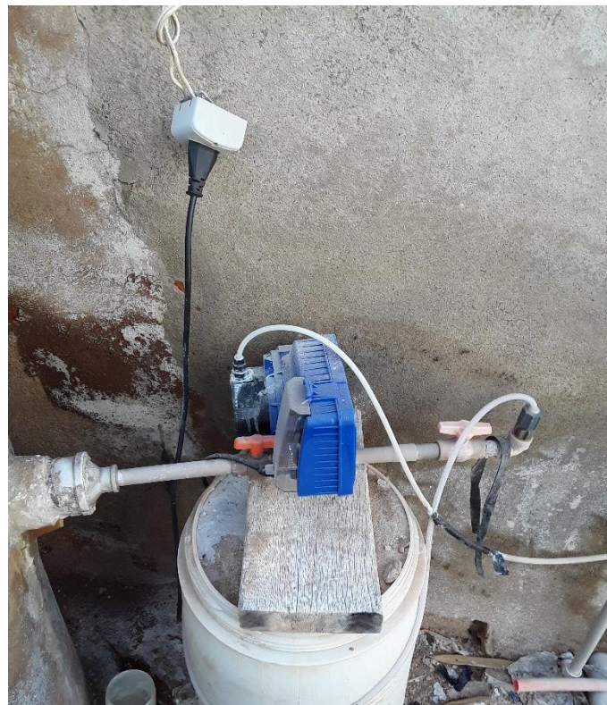
Figura 84 – Bomba Dosadora
