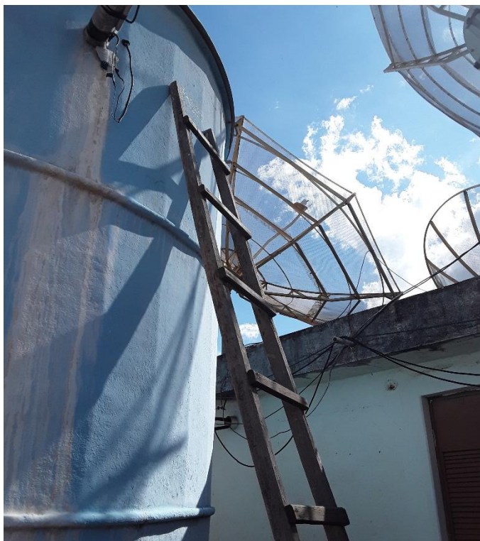
Figura 87 – Escada de acesso ao reservatório
