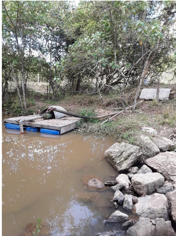
Figura 16 – Captação do Ribeirão da Chácara
