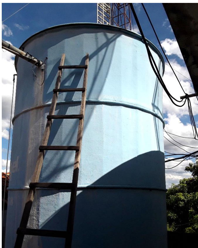
Figura 85 – Reservatório Manoel Sampaio
