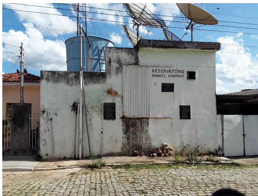
Figura 81 – Área do Reservatório Manoel Sampaio
