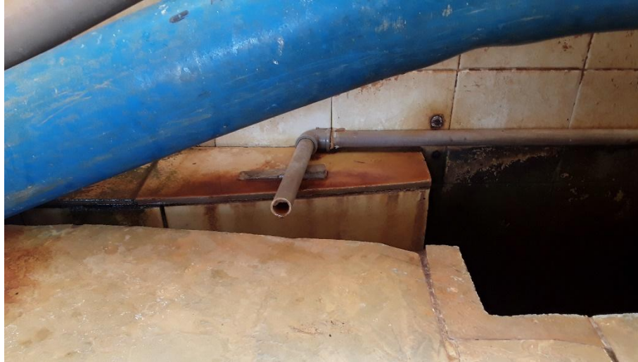
Figura 25 – Adição do coagulante
