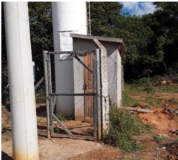
Figura 92 – Portão de acesso ao reservatório – Casas Populares
