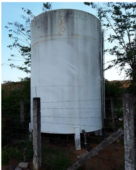
Figura 84 – Área do reservatório – Povoado Grama
