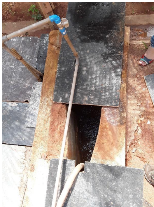
Figura 28 – Calha Parshall durante a reforma
