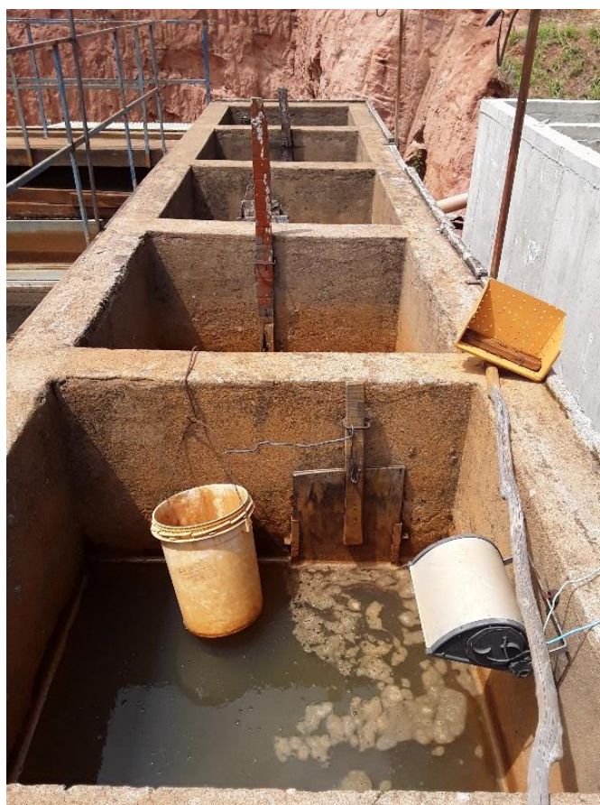
Figura 30 – Câmaras de floculação
