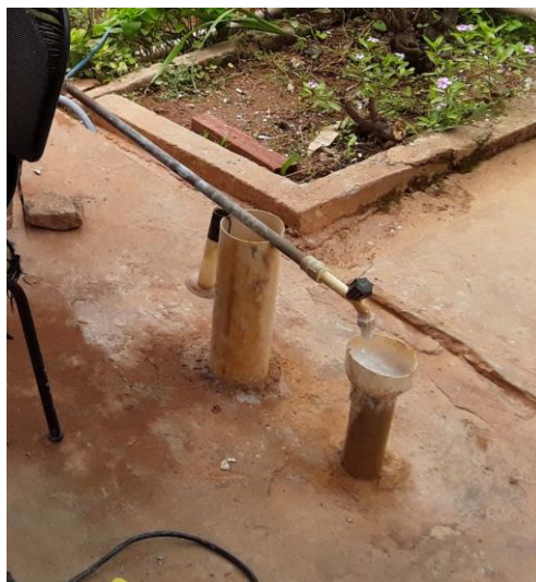
Figura 53 – Dosagem do hipoclorito de sódio
