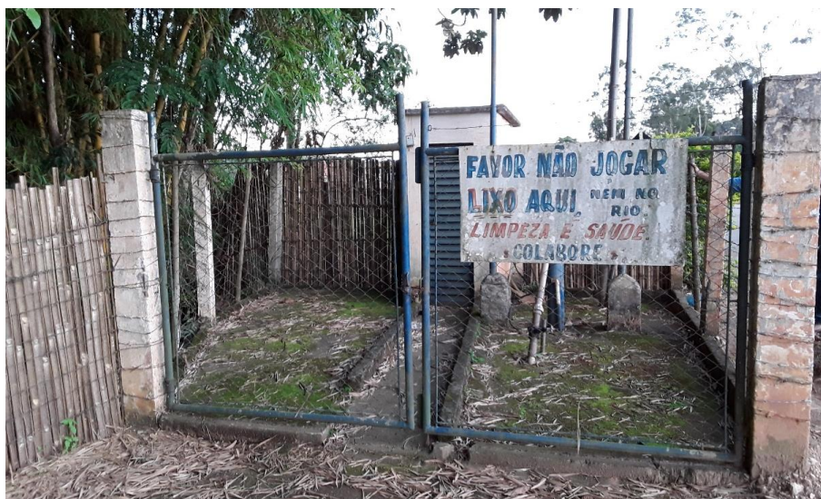
Figura 82 – área da captação de água do povoado Grama
