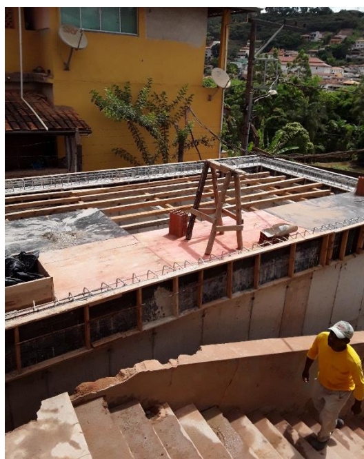
Figura 37 – Tanque de contato em construção
