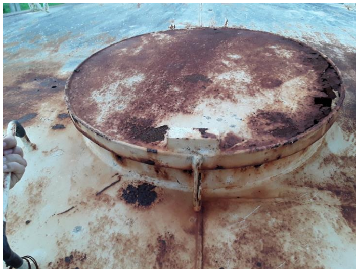
Figura 87 – Tampa de inspeção do reservatório
