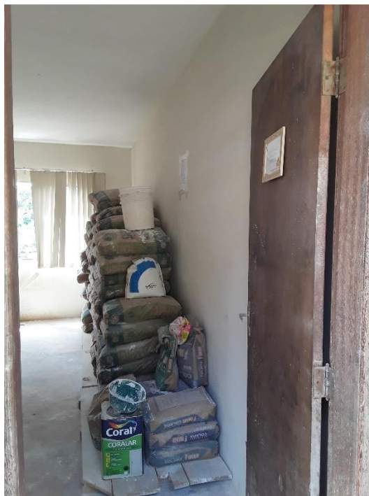
Figura 43 – Acesso ao depósito de produtos químicos
