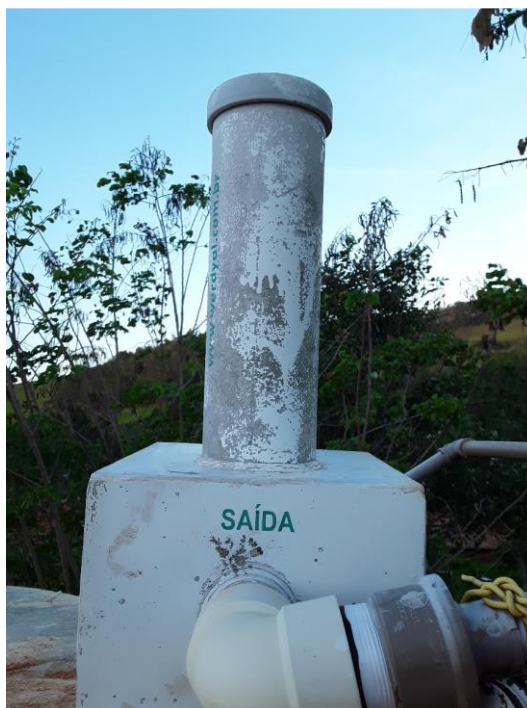
Figura 89 – Sistema de cloro pastilha
