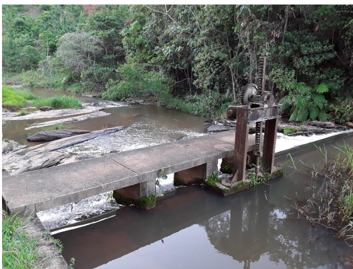
Figura 23 – Barragem para captação
