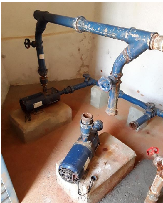
Figura 80 - EEAT São Geraldo
