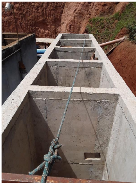
Figura 31 – Construção de novas câmaras de floculação
