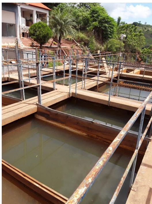
Figura 35 – Estação de tratamento de água
