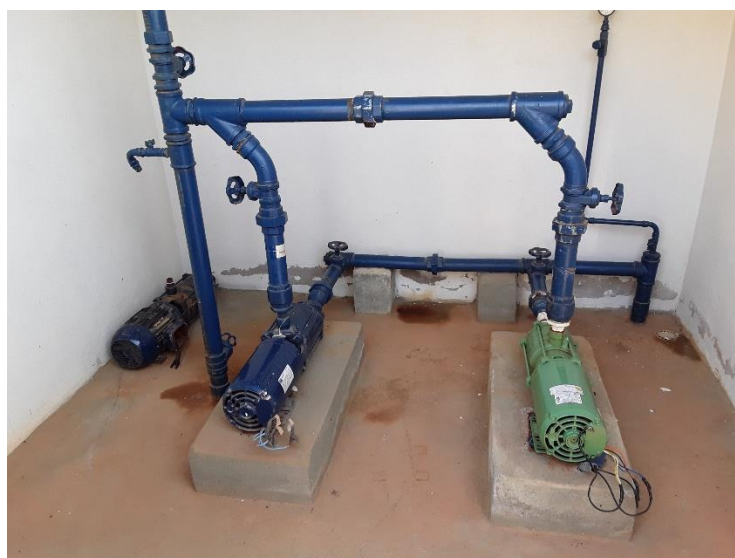
Figura 76 - EEAT Boa Vista
