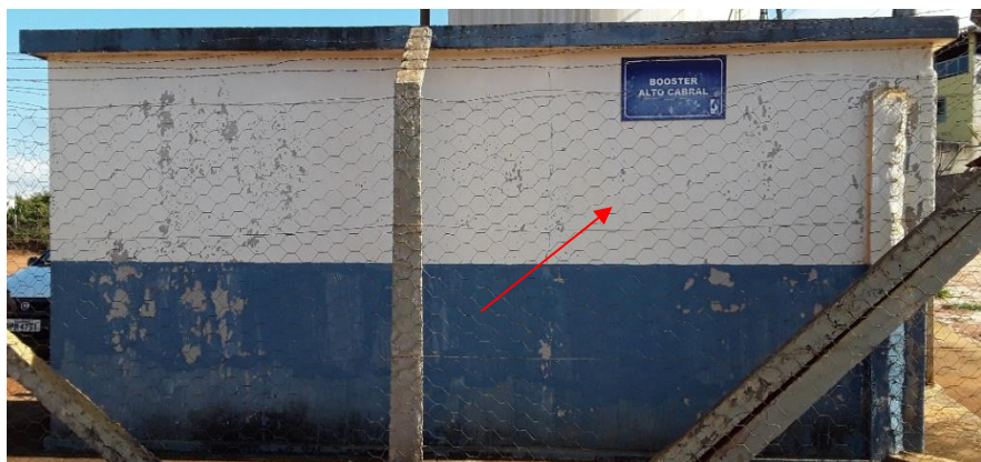
Figura 68 – Estrutura devidamente identificada
