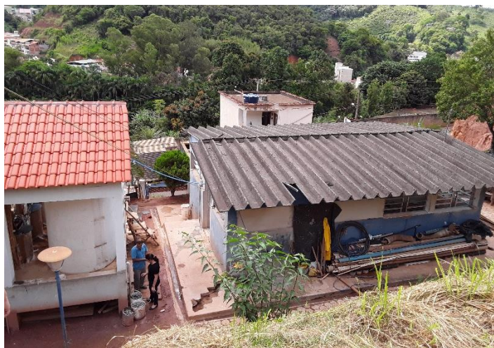
Figura 41 – Área da ETA
