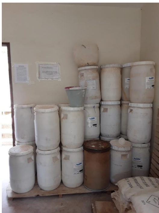
Figura 48 – Armazenamento do hipoclorito de cálcio
