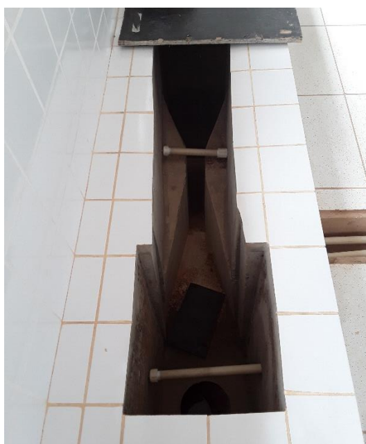
Figura 29 – Calha Parshall após reforma
