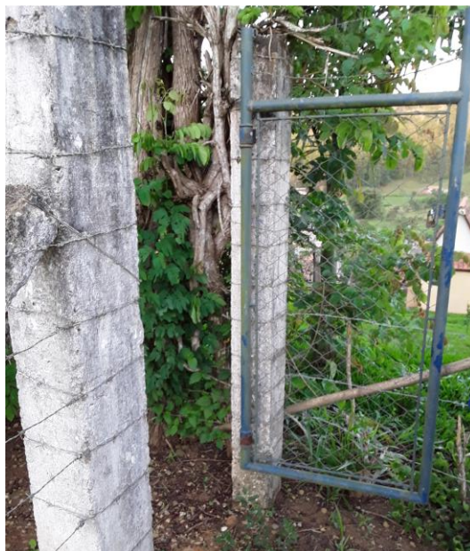
Figura 85 – Portão de acesso ao reservatório – Povoado Grama
