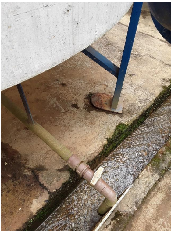
Figura – Descarga do floccodcantador
