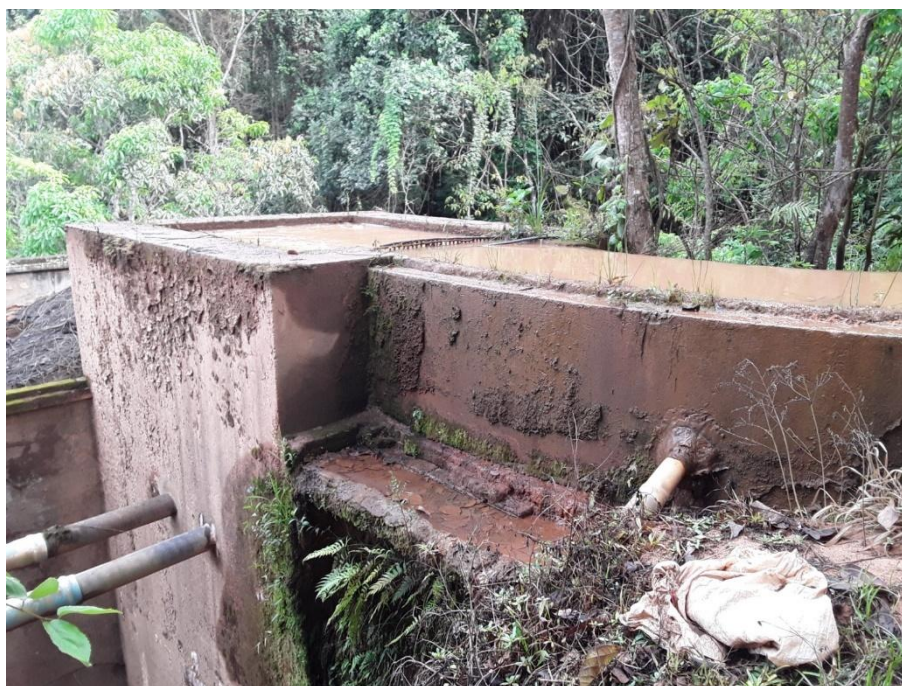
Figura – Estrutura da captação
