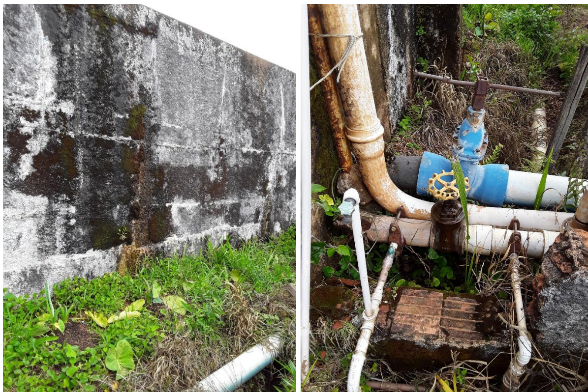
Figura – Lateral do reservatório da ETA – Cantamissa
