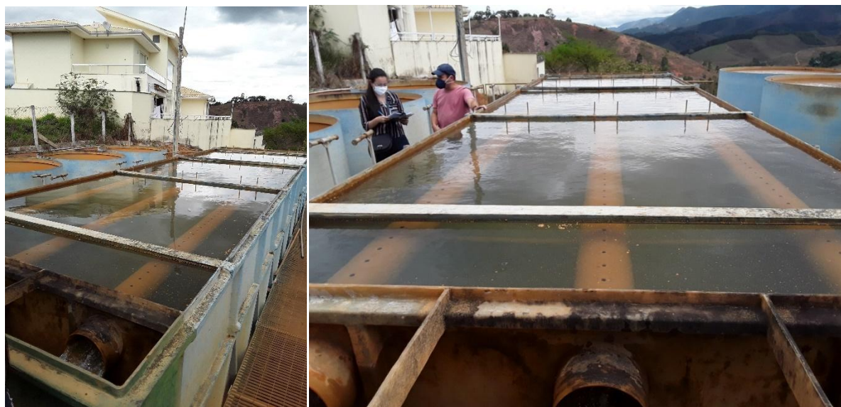
Figura – Decantador
