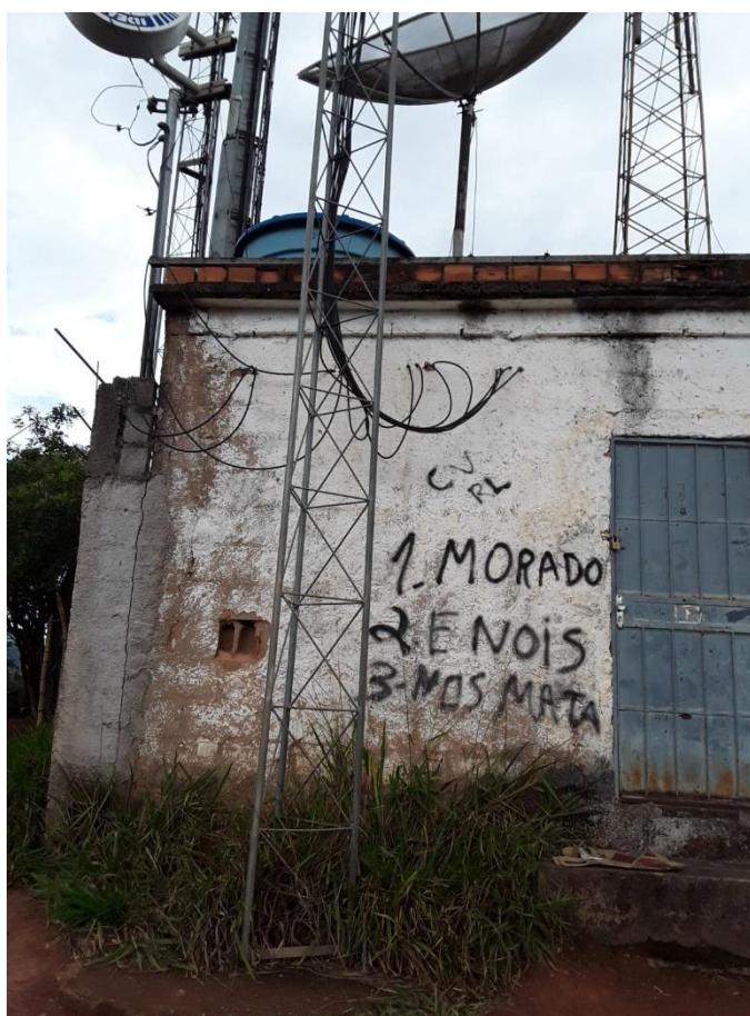
Figura – Reservatório Mangueira e torre de luz utilizada como acesso
