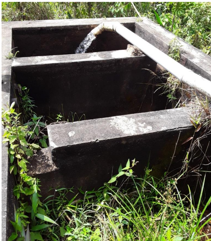
Figura – Antigo desarenador
