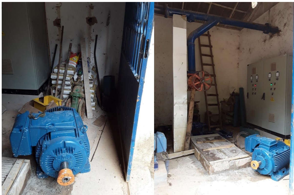
Figura – Instalação de conjunto motobomba - EEAB Usina
