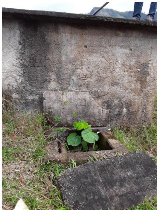
Figura – Caixa de registros de saída – Captação Caatinga
