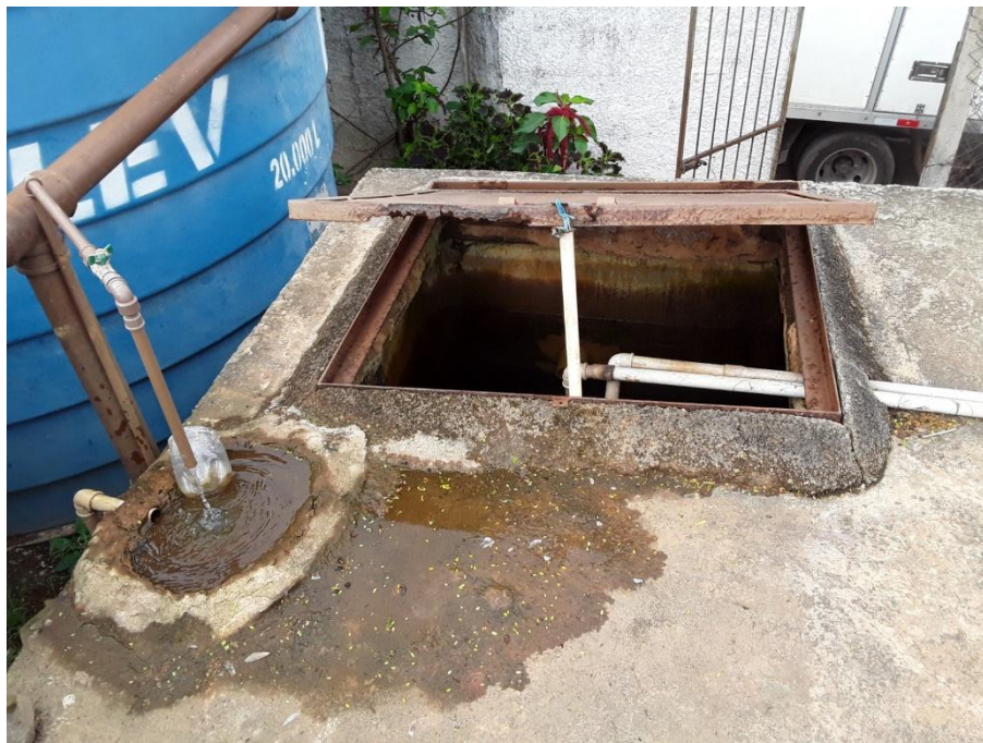
Figura – Tampa de inspeção do reservatório – ETA Nossa Senhora da Penha
