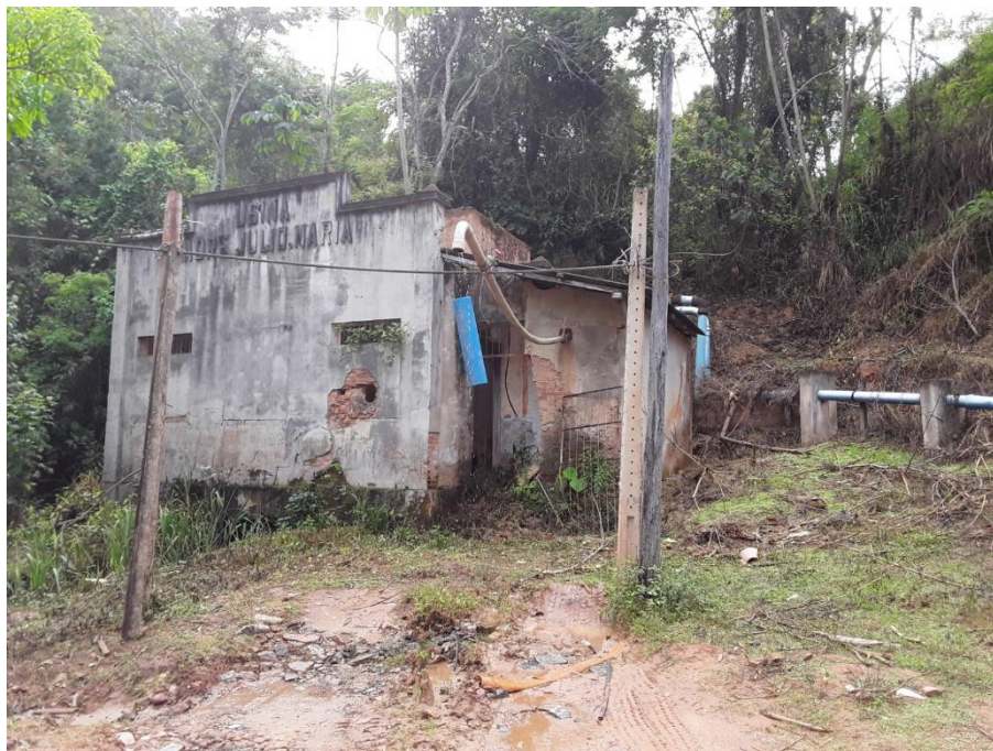
Figura – área da captação “Usina”
