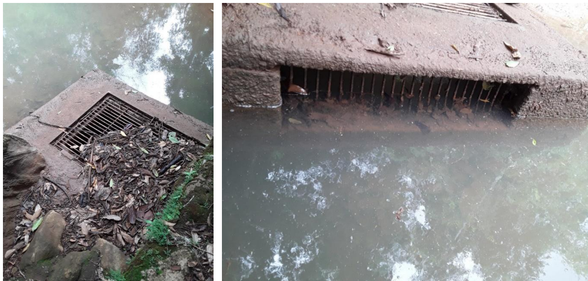
Figura – Sistema de gradeamento – Captação Limeira
