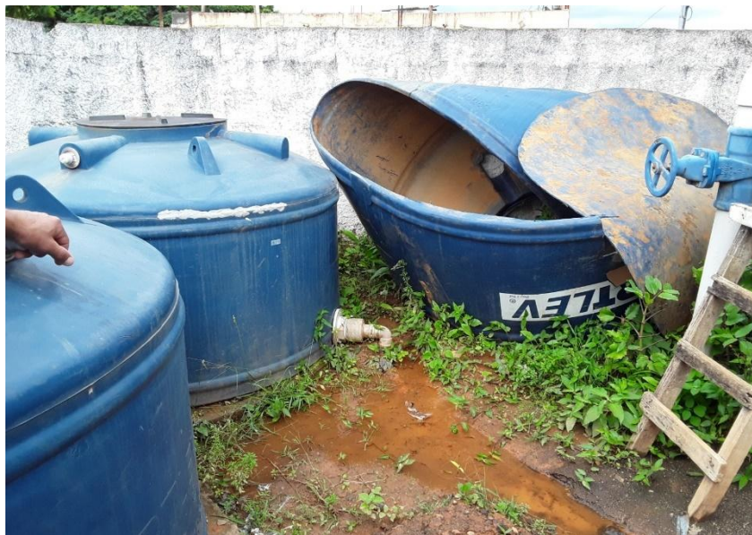
Figura – Caixa d’água danificada – Nossa Senhora da Penha
