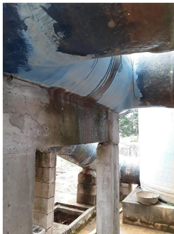
Figura – Tubulação da ETA após reparo
