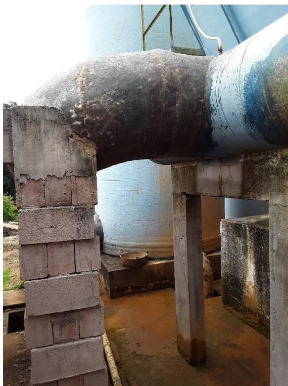
Figura – Tubulação da ETA após reparo
