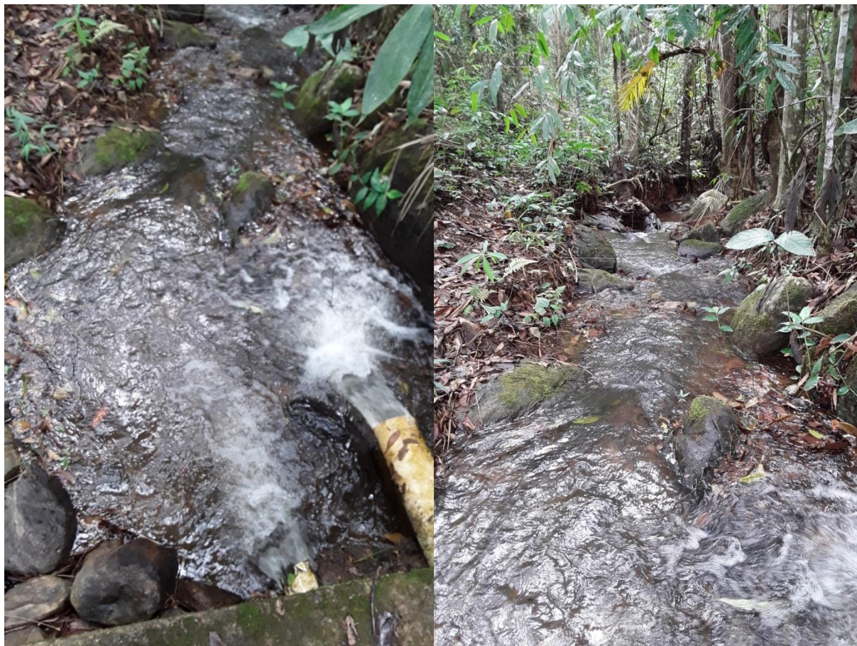
Figura – Canal aberto da captação Caantiga
