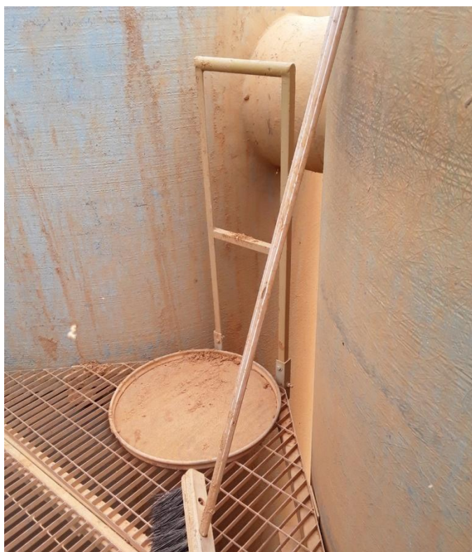
Figura – Estrutura da ETA
