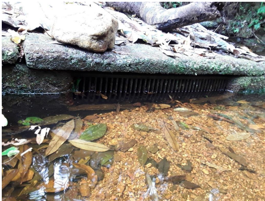
Figura – Gradeamento da captação Sagui
