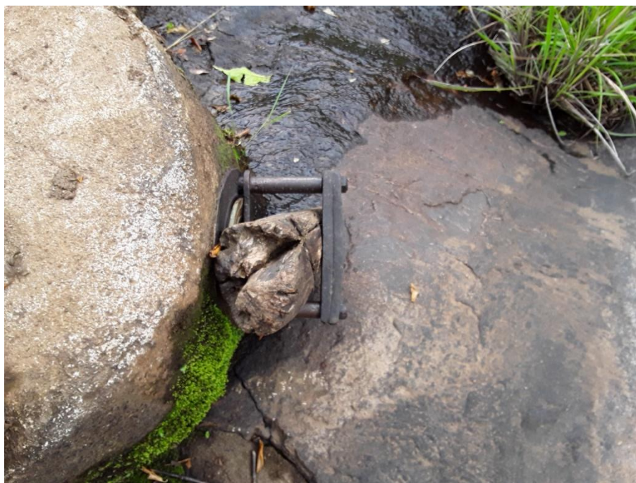
Figura -Descarga de fundo da barragem de captação
