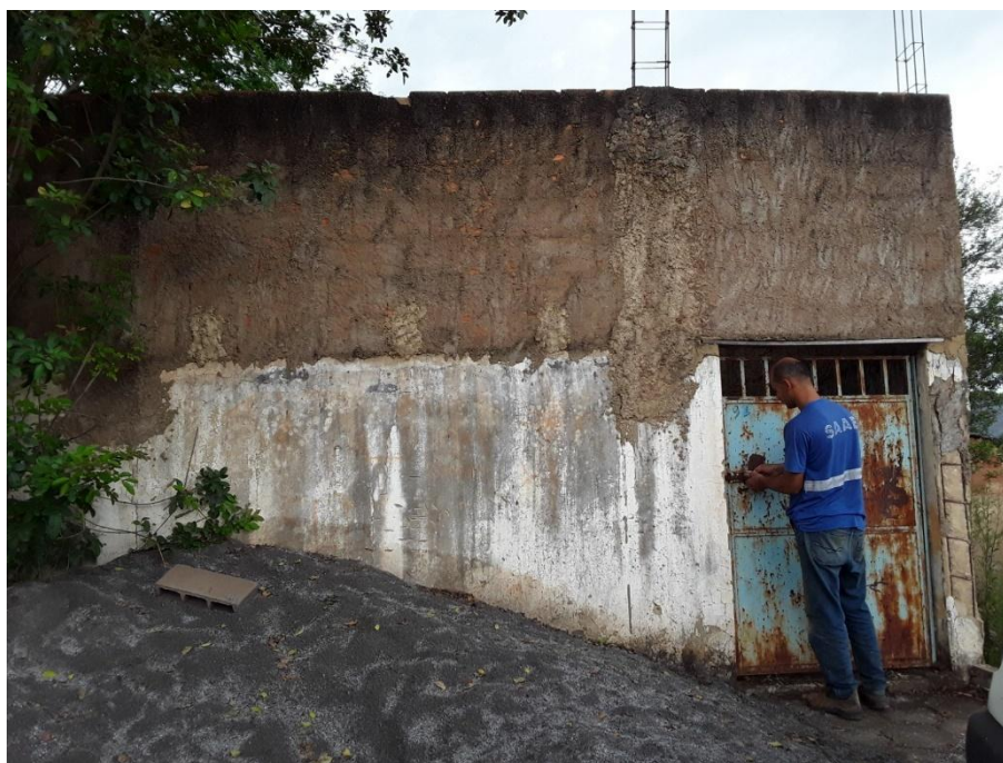
Figura – Área da EEAT Mangueira
