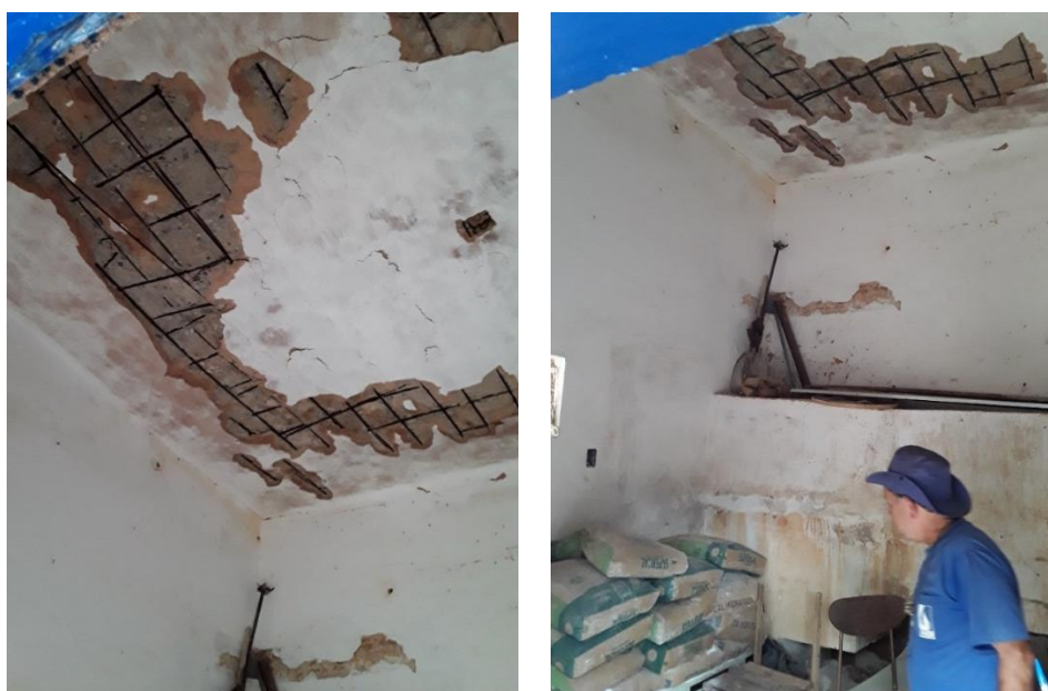
Figura – Cobertura do depósito de produtos químicos
