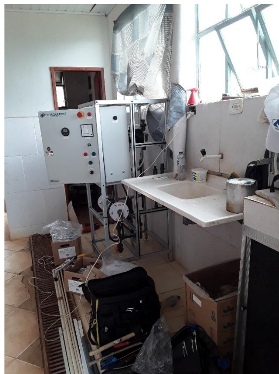
Figura – Instalação do gerador de hipoclorito de sódio
