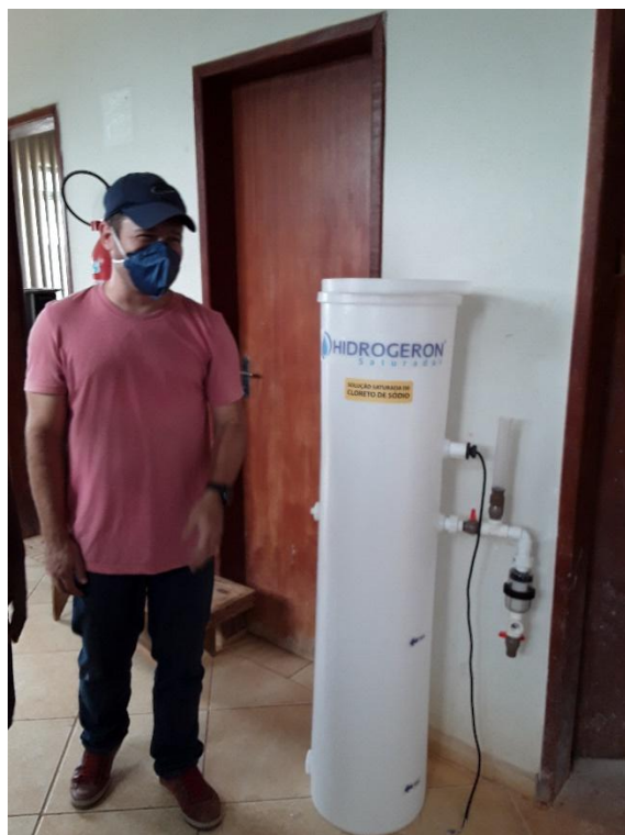
Figura – Instalação do gerador de hipoclorito de sódio
