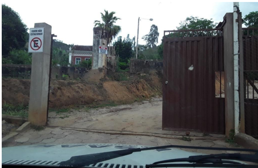
Figura – Acesso a estação de tratamento de água Madre Beatriz
