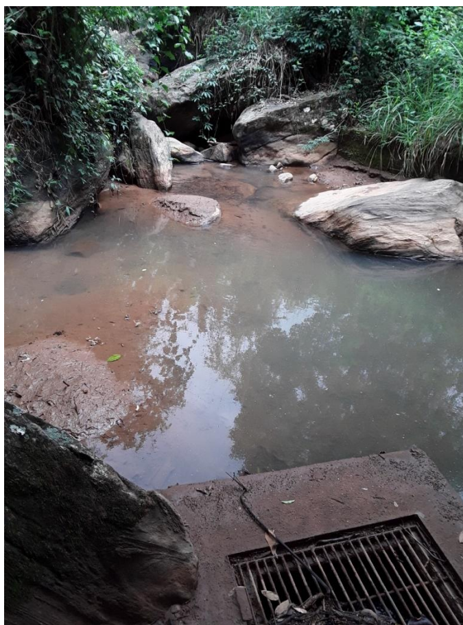
Figura – Área da captação Limeira
