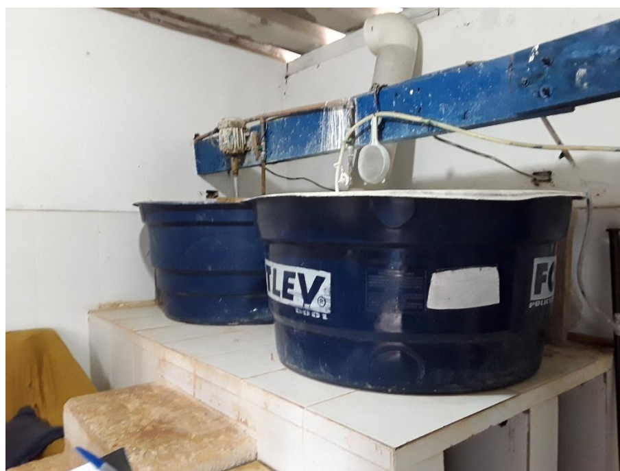
Figura – Área de preparação do sulfato de alumínio
