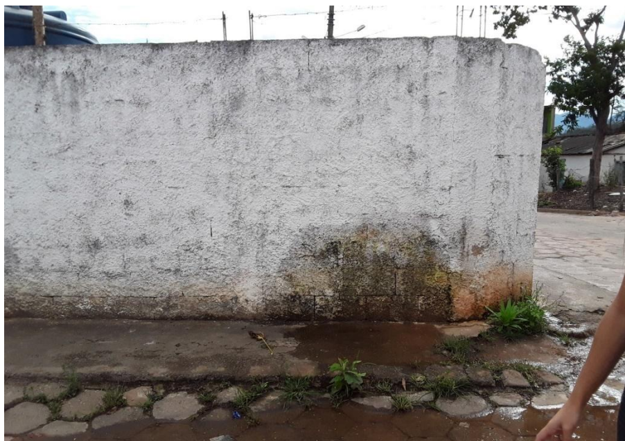
Figura – Muro que cerca a área de tratamento
