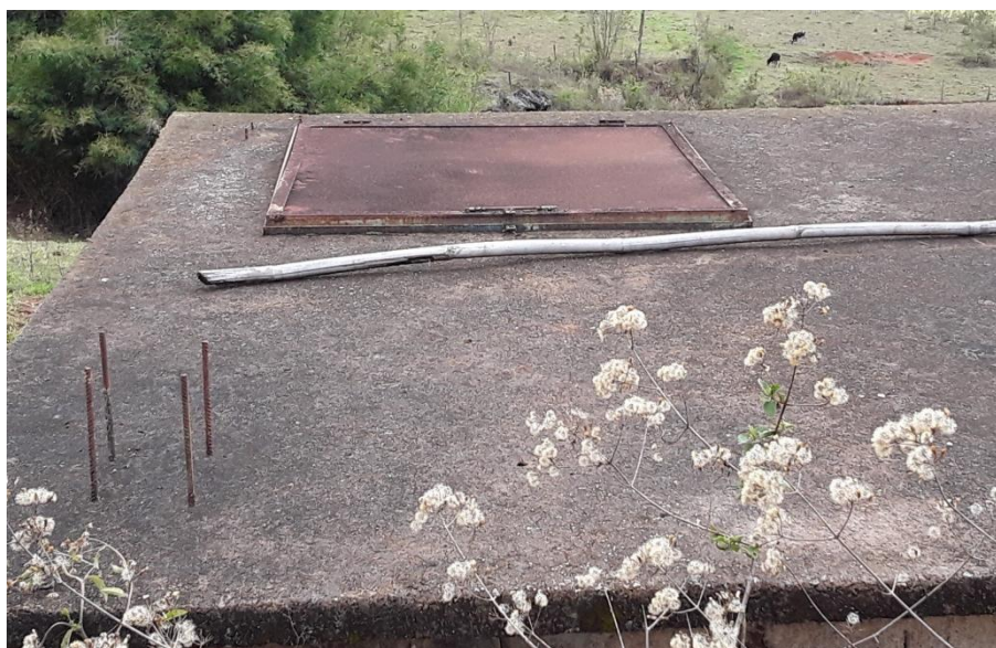
Figura – Cobertura do reservatório de água bruta
