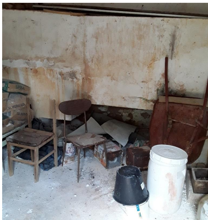
Figura – Área de depósito de produtos químicos
