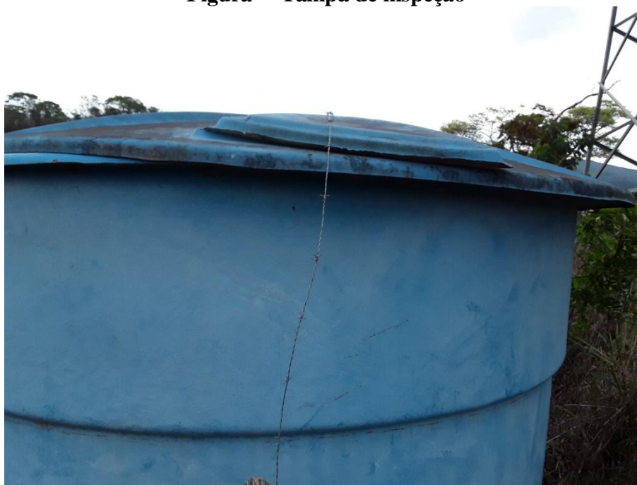
Figura – Tampa de inspeção
