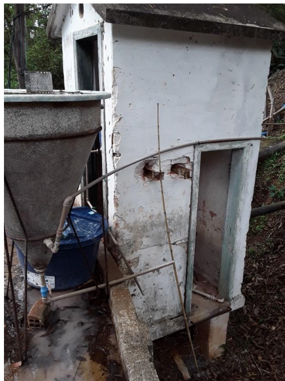
Figura – Extravassamento do tanque de solução de hipoclorito de cálcio
