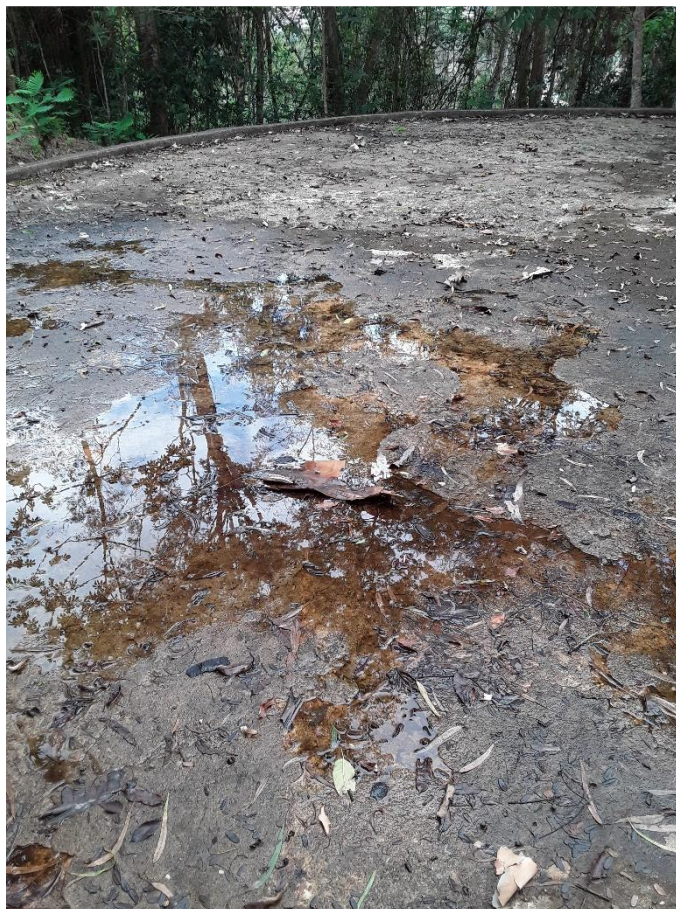
Figura – Cobertura do reservatório – Madre Beatriz
