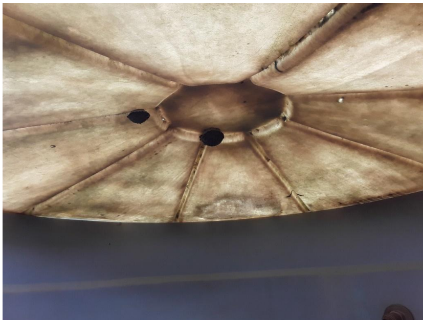
Figura – Visão interna da cobertura do reservatório
