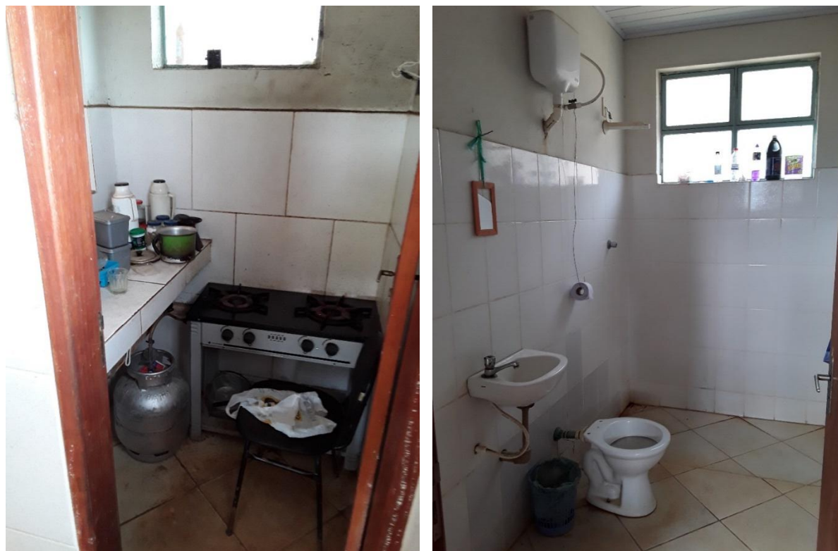
Figura – Cozinha e instalação sanitária
