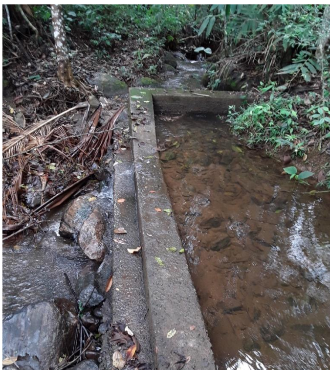
Figura – Barragem da captação Caatinga
