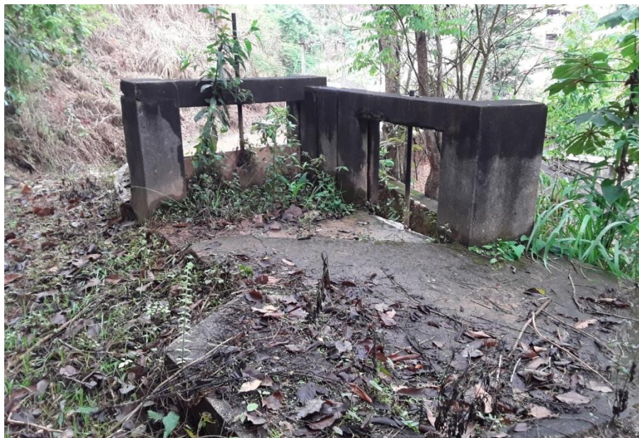
Figura – Comporta da área da captação
