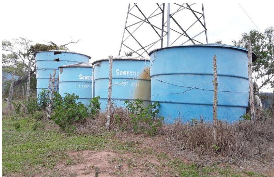
Figura – Área dos reservatório Madre Beatriz/Vila Verde
