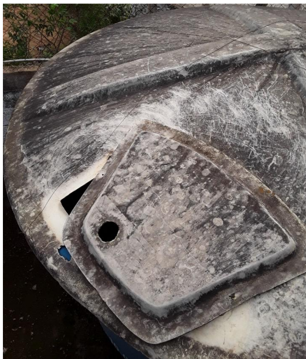
Figura – Cobertura do reservatório de água para lavagem dos filtros - Penha
