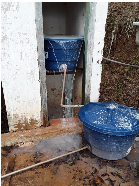
Figura – Extravassamento do tanque de solução de hipoclorito de cálcio
