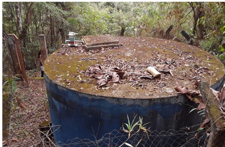
Figura 49 – Tampa de inspeção do reservatório do Maracujá vendando a unidade.
