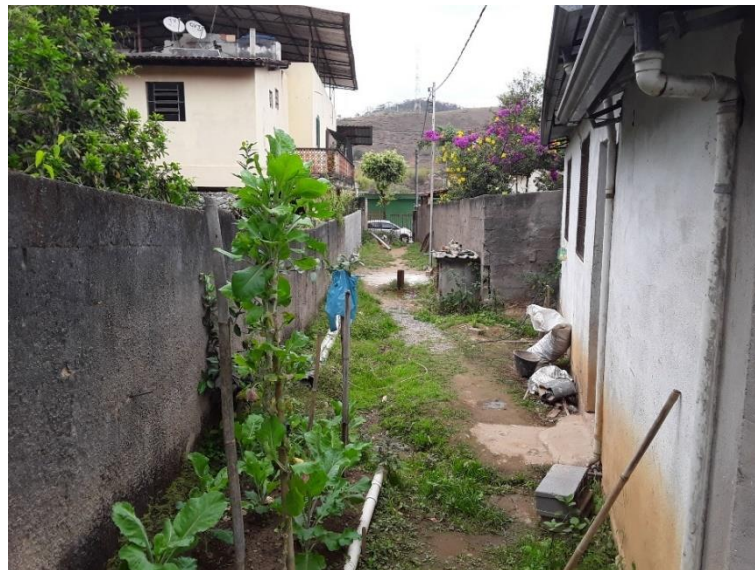
Figura 31 – Vista externa casa de bomba
