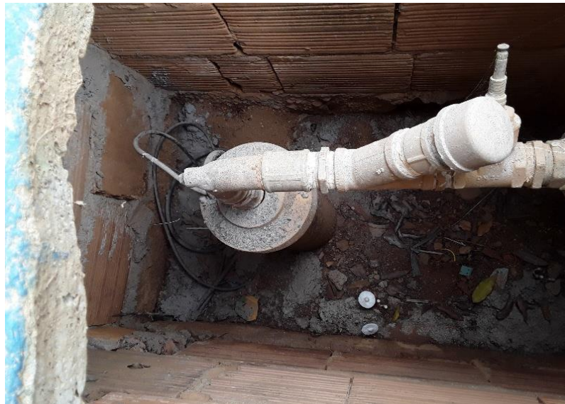
Figura 50 - Área da captação subterrânea Distrito de Palmeiras
