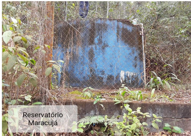
Figura 48 – Reservatório do Maracujá
