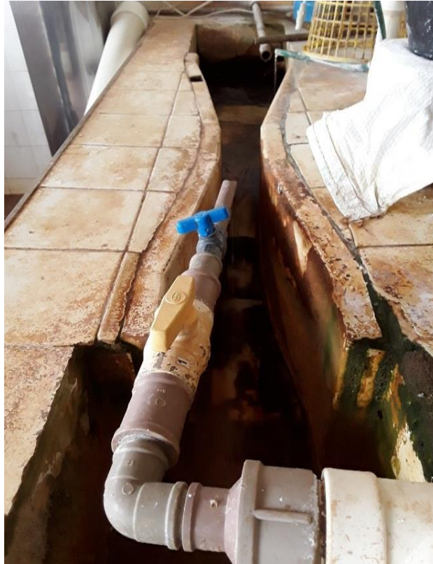
Figura 17 - Vista superior da Calha Parshall
