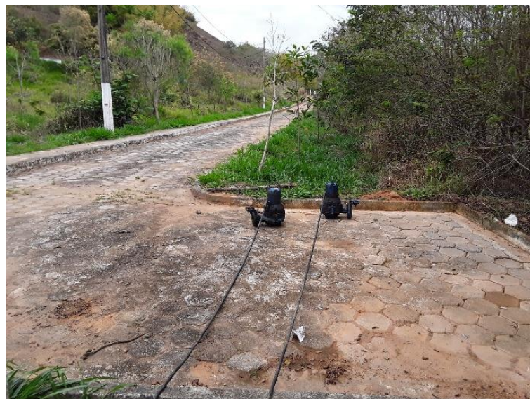
Figura 60 – Bombas responsáveis por levar efluente ao tratamento estavam em manutenção
