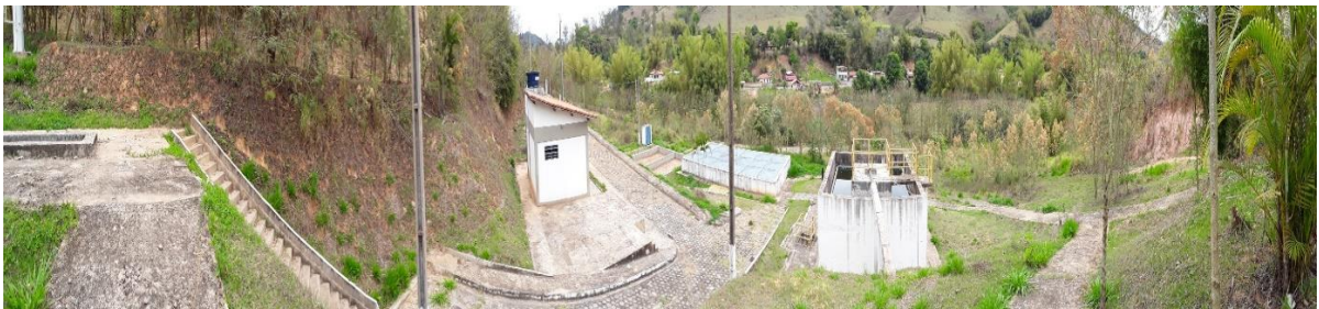
Figura 54 – ETE na Sede de Acaiaca está construída e pronta para operar (Vista Panorâmica).
