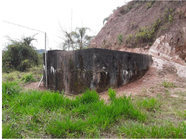
Figura 39 – Reservatório Nova Esperança
