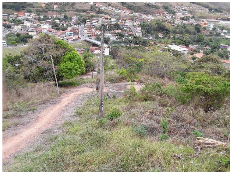
Figura 35 – Área do R2 necessita manutenção
