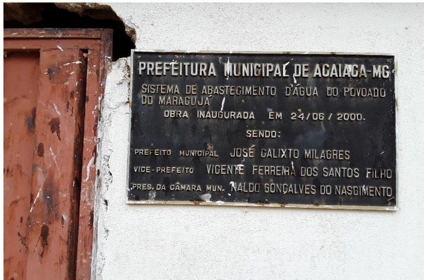
Figura 46 – Placa de inauguração da captação subterrânea
