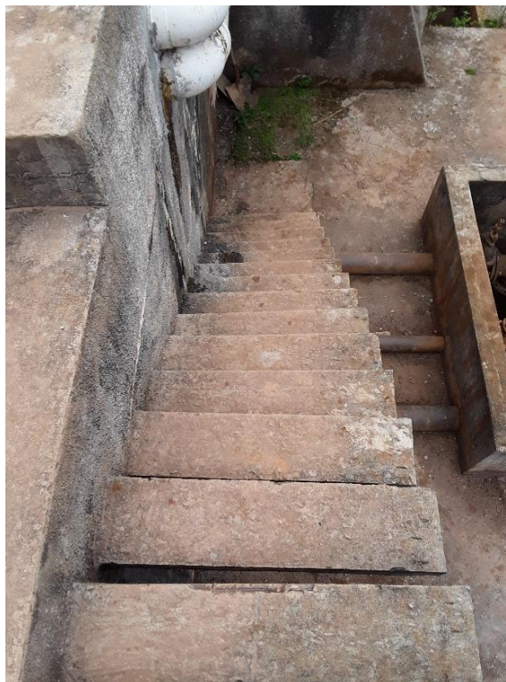
Figura 25 – Escada de acesso a ETA
