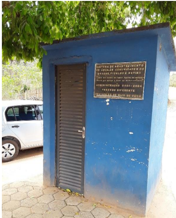
Figura 51 –Local onde foi instalado parte elétrica sem acesso
