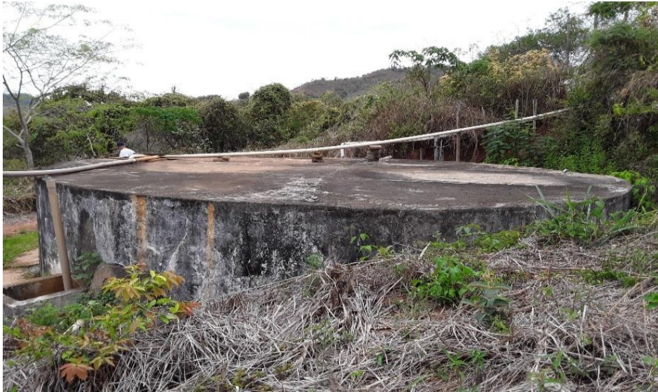
Figura 36 – R2 possui capacidade de armazenamento de 300 m 3
