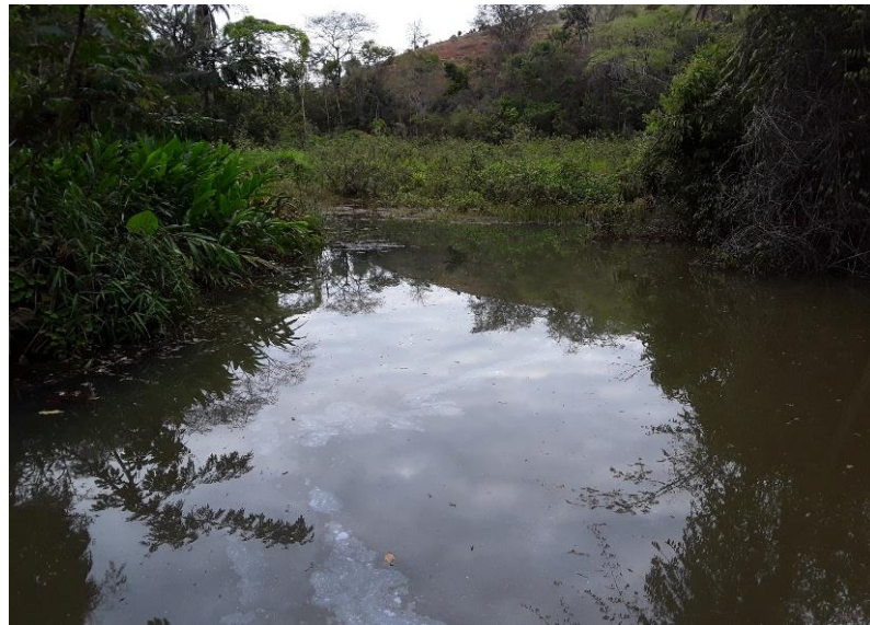
Figura 5 – Barragem de nível – Captação Sede
