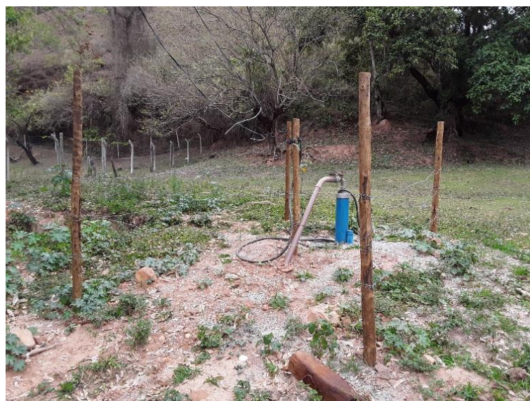
Figura 11 – Poço do Brejão / Adão Bárbara
