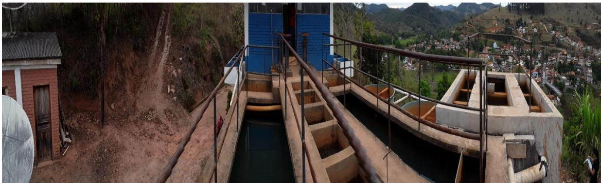
Figura 23 – Visão panorâmica da ETA
