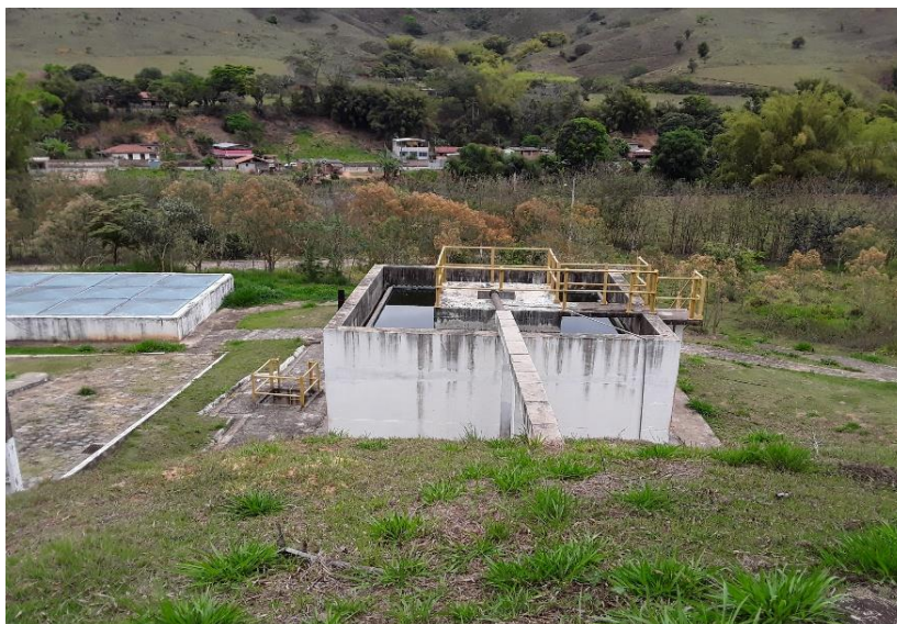
Figura 57 – Reator Anaeróbio DE fluxo ascendente
