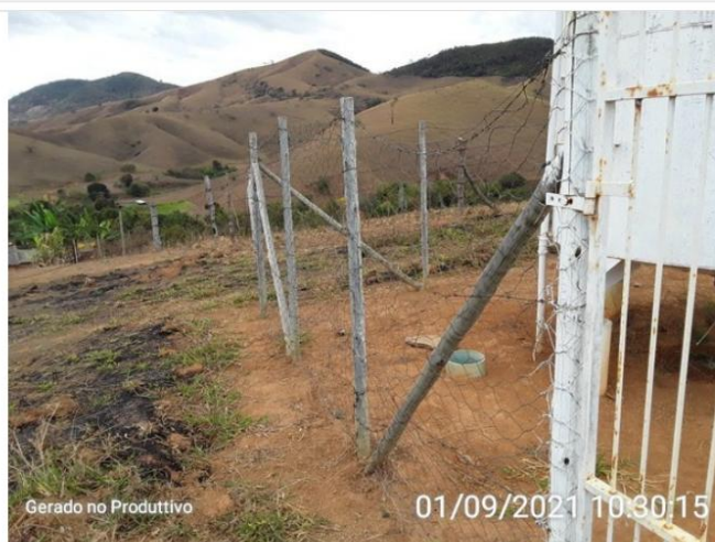
Cercamento da área do reservatório (2).
