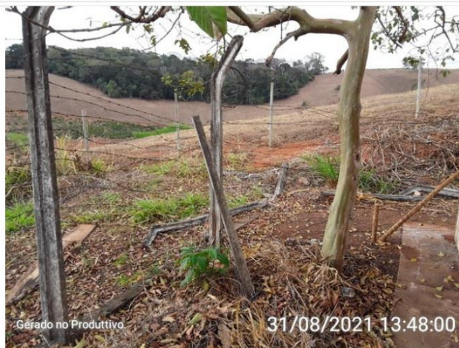
Cercamento do reservatório.
