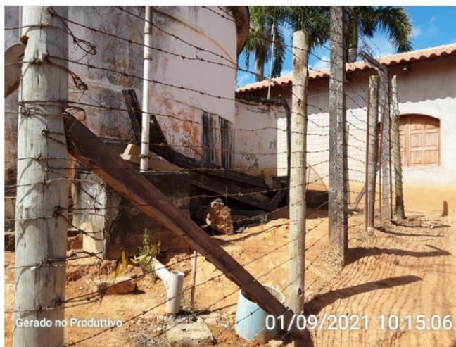
Cercamento da área do reservatório.
