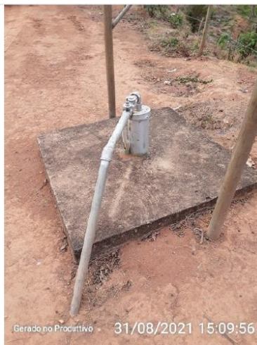
Poço São Sebastião do Óculo (2)
