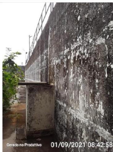
Área lateral da ETA
