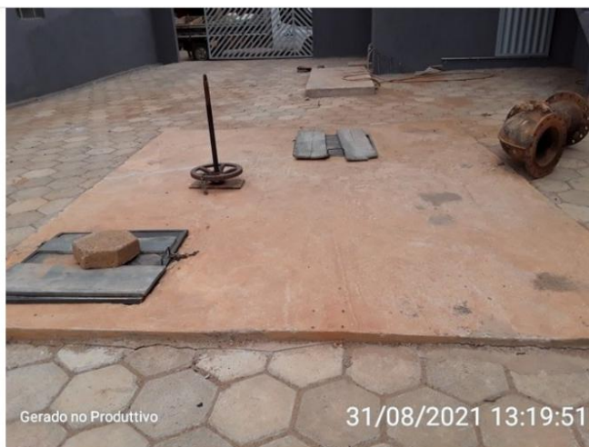
Poço de sucção
