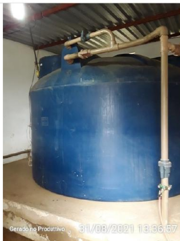
Reservatório de sucção
