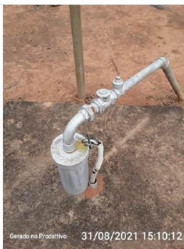
Poço São Sebastião do Óculo (3)
