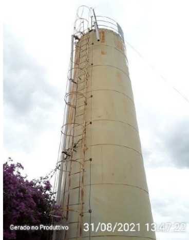
Escada para acesso a cobertura
