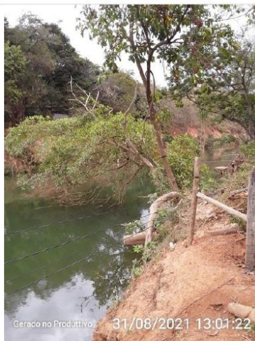
Área da captação
