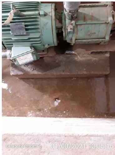
Piso da casa de bombas
