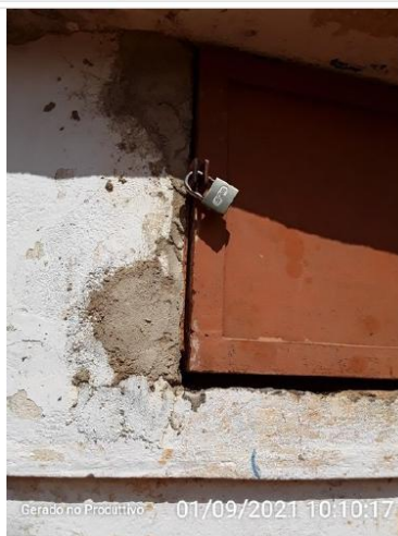
Cadeado da tampa de inspeção do reservatório.
