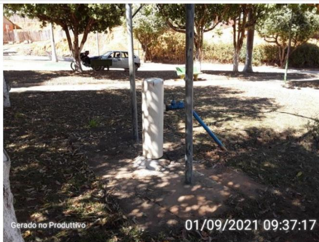
Área sem cercamento.
