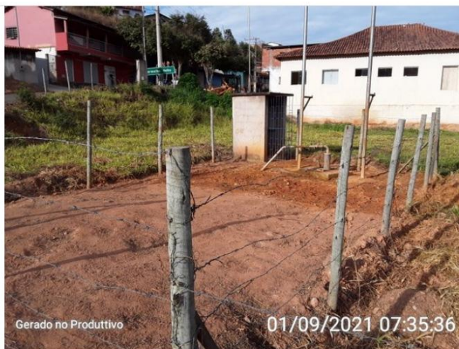
Cercamento da área do Poço
