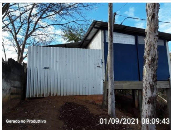
Cercamento da área do reservatório.
