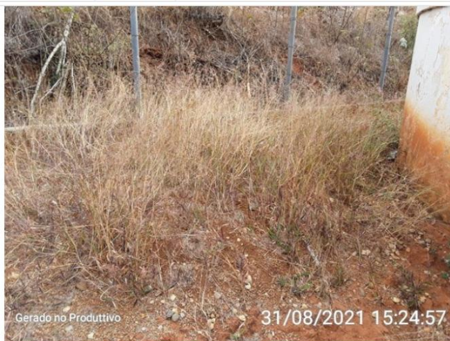
Área do reservatório necessitando de limpeza.
