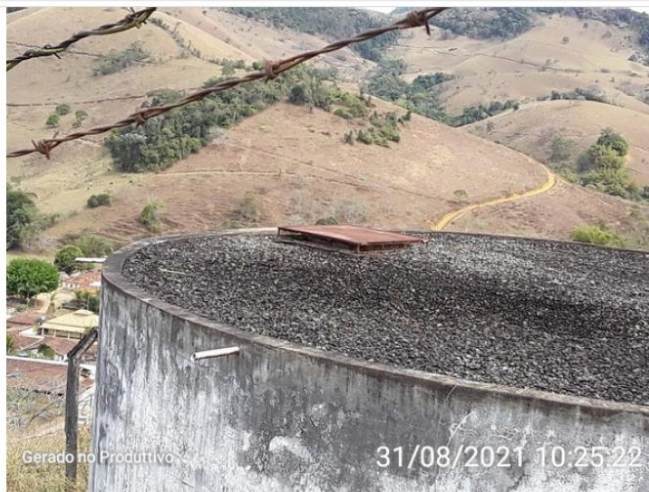
Tampa de inspeção do reservatório.
