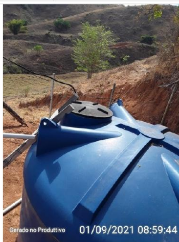
Tampa de inspeção do reservatório.
