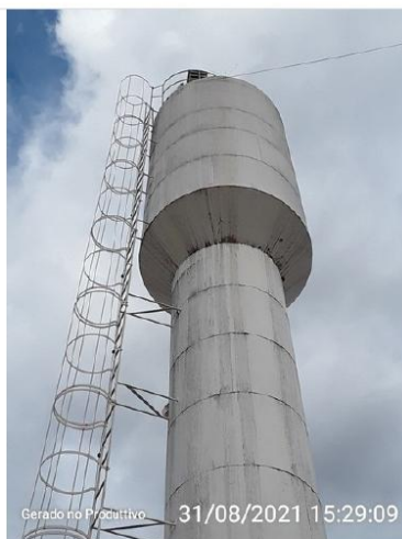
Guarda -corpo na cobertura do reservatório
