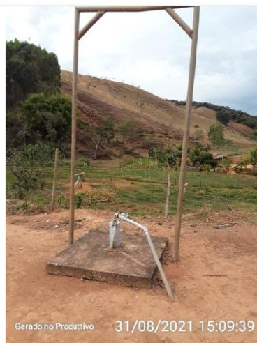
Poço São Sebastião do Óculo
