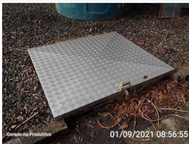
Tampa de inspeção
