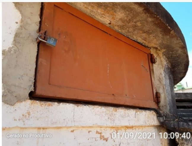
Tampa de inspeção do reservatório.
