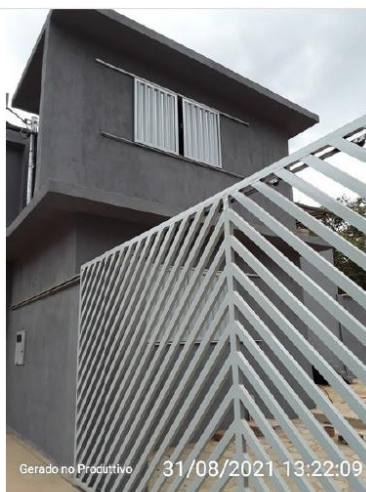
Área da captação
