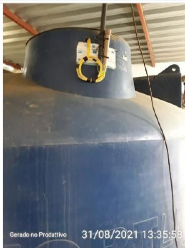
Reservatório de sucção
