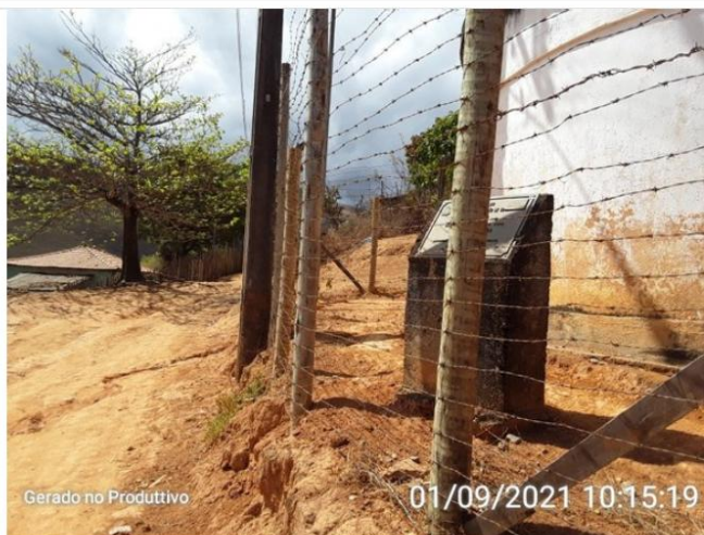
Cercamento da área do reservatório (2).
