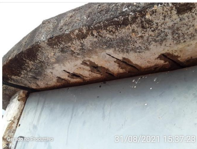
Armadura exposta.
