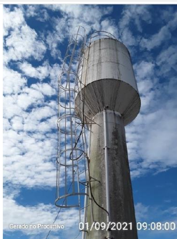
Escada para acesso a cobertura do reservatório
