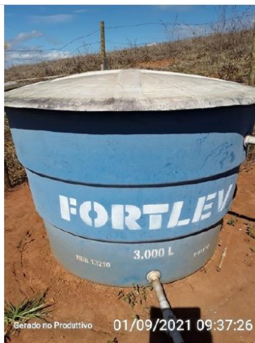
Reservatório - Capitão Martins
