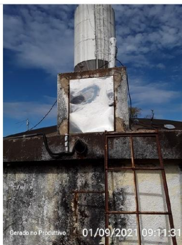
Tampa de inspeção
