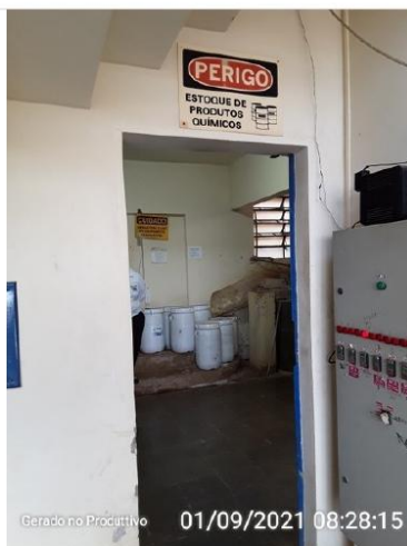
Entrada do depósito de produtos químicos
