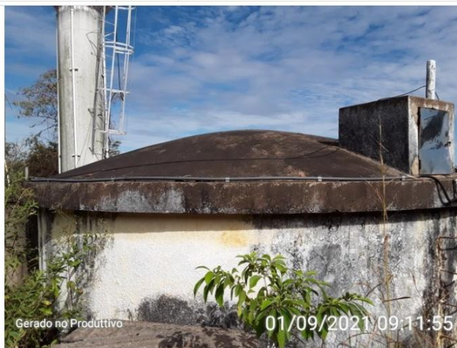
Cobertura do reservatório
