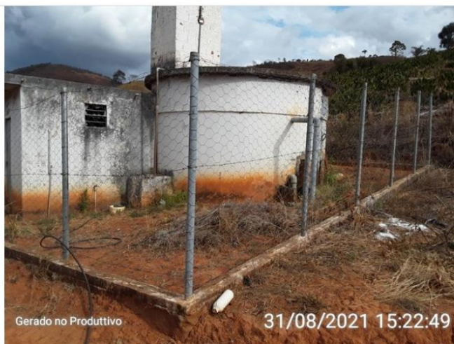
Cercamento do reservatório.
