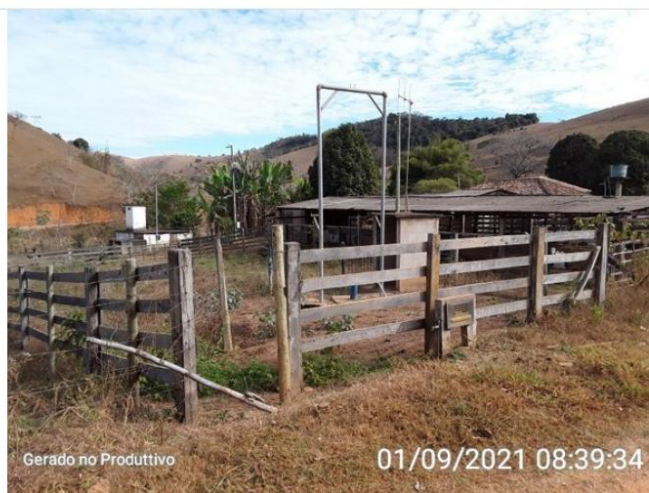
Área do Poço Cornélio Alves
