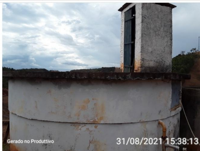
Cobertura do reservatório.
