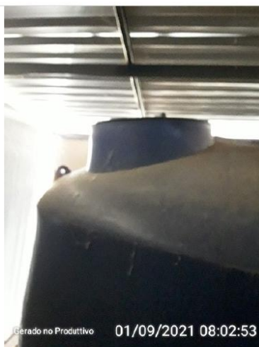
Tampa de inspeção do Reservatório 2
