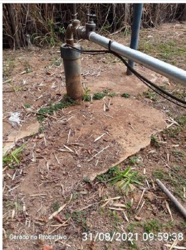
Laje sanitária de proteção.
