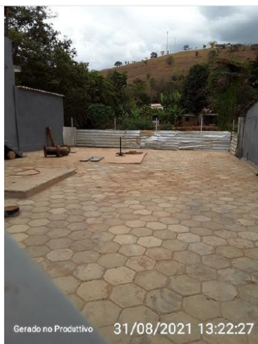
Área da captação
