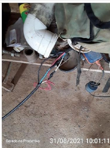
Condições dos cabos elétricos.
