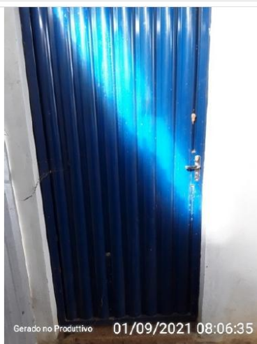
Porta de acesso à sala dos reservatórios.
