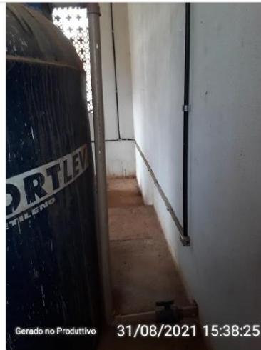
Reservatório de sucção
