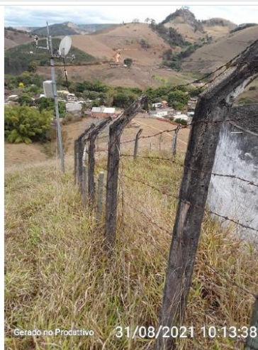
Cercamento da área do reservatório.
