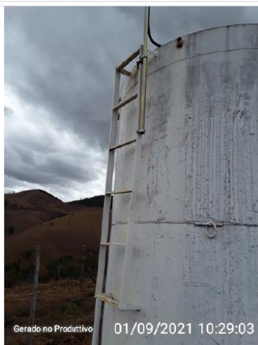
Escada de acesso à cobertura do reservatório.
