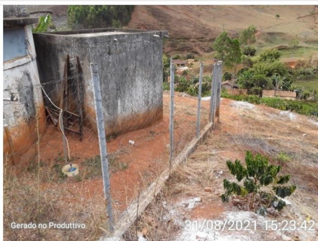
Cercamento do Reservatório (2).
