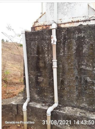
Registro de saída do reservatório
