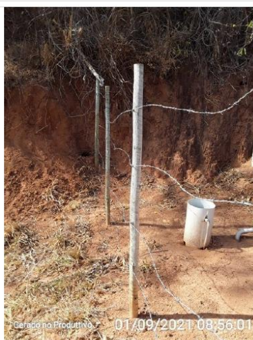
Cercamento do reservatório (2)
