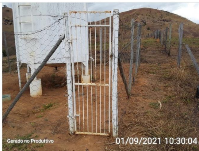
Cercamento da área do reservatório.
