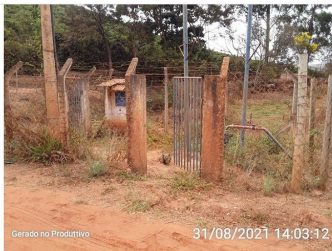
Área do poço.
