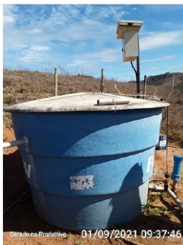
Reservatório - Capitão Martins
