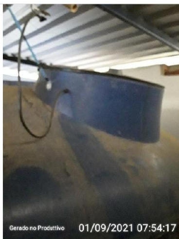
Tampa de inspeção do reservatório.
