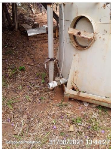
Descarga de fundo
