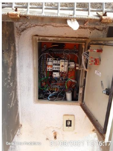
Condições dos cabos elétricos.
