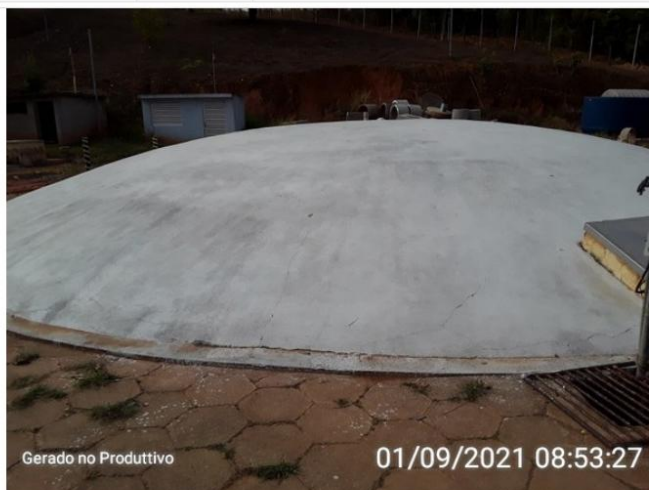
Cobertura do reservatório
