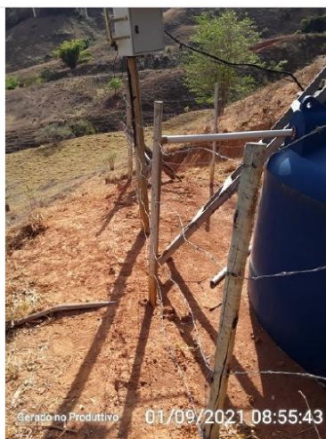
Cercamento do reservatório.
