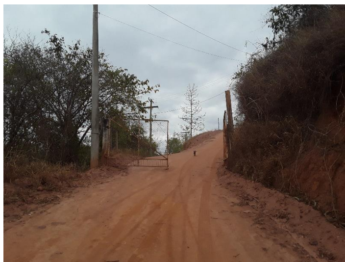
Figura 16 – Portão de acesso a ETA
