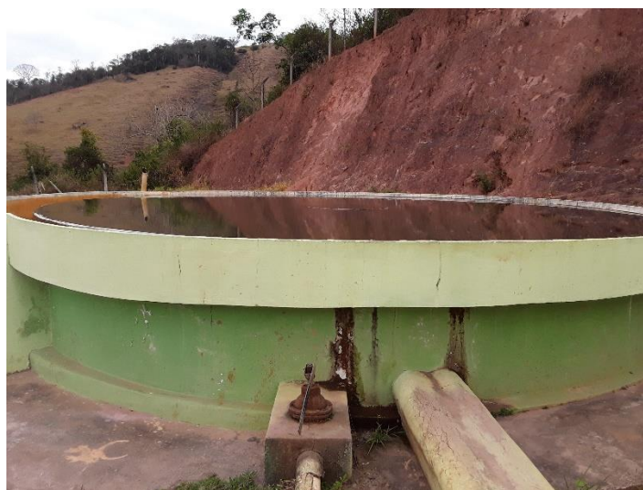
Figura 20 – Decantador - ETA
