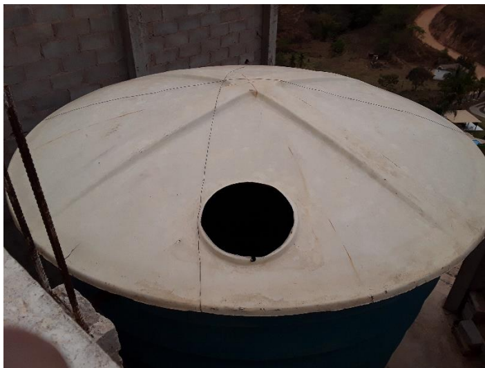
Figura 44 – Cobertura do Reservatório R3
