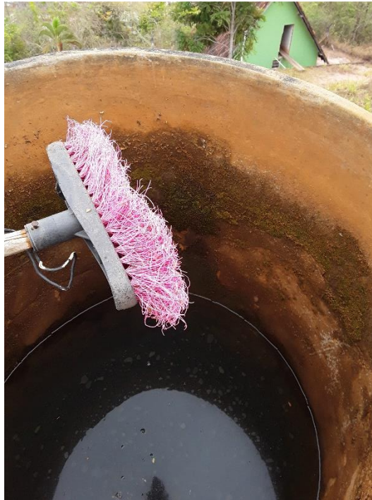
Figura 27 – Equipamento de lavagem dos filtros
