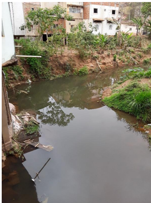
Figura 79 – Lançamento de esgoto no Ribeirão São Domingos
