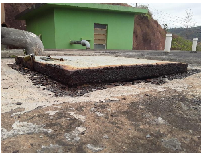
Figura 41 – Tampa de inspeção
