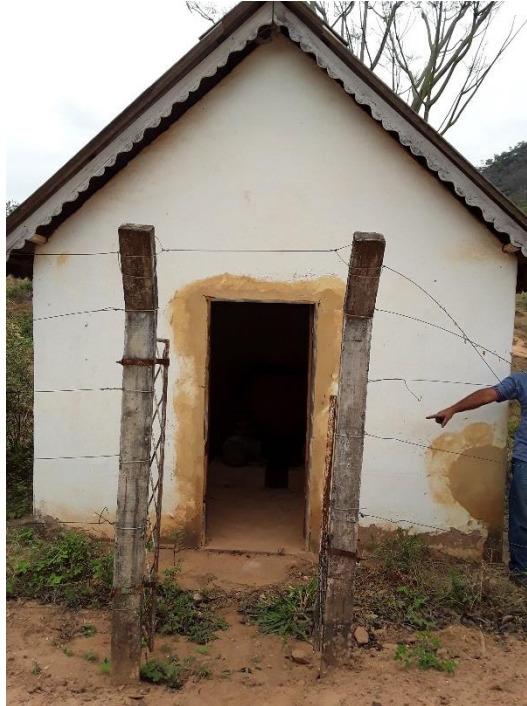
Figura 9 – Estação Elevatório de água Bruta
