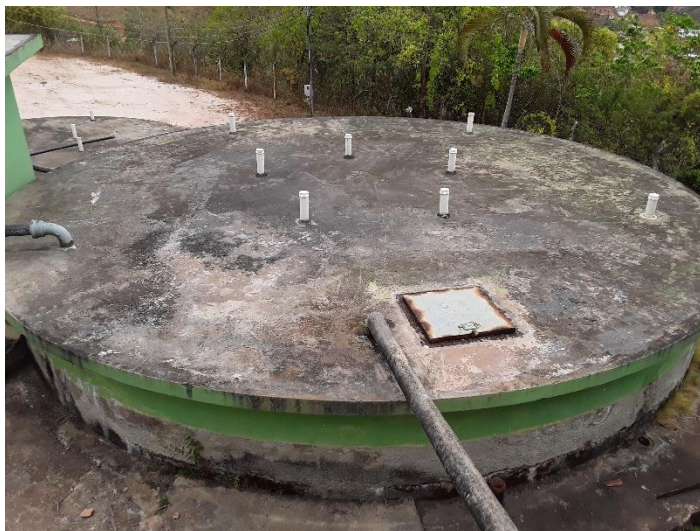
Figura 39 – Reservatório R1 - ETA
