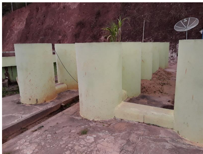
Figura 18 – Flocculadores - ETA
