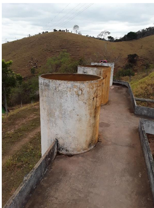
Figura 24 – Plataforma de acesso aos Filtros
