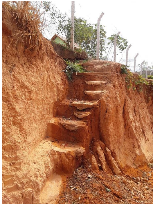
Figura 65 – Acesso a ETA - Distrito de Professor Sperbert
