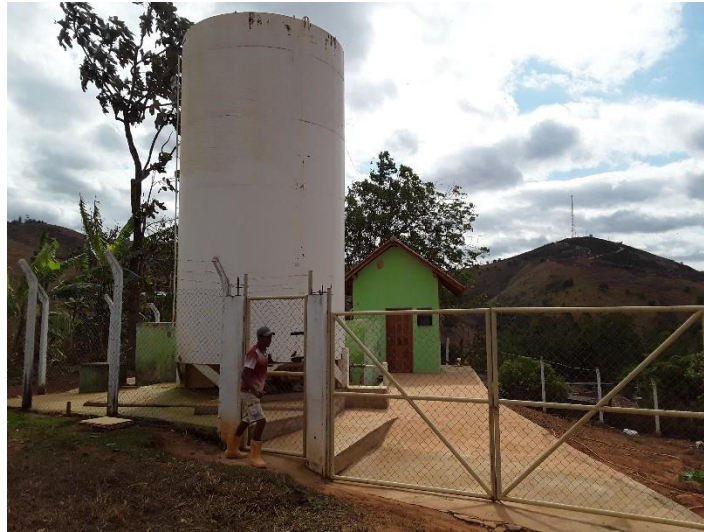
Figura 64 – Área da ETA e reservatório - Distrito de Professor Sperbert
