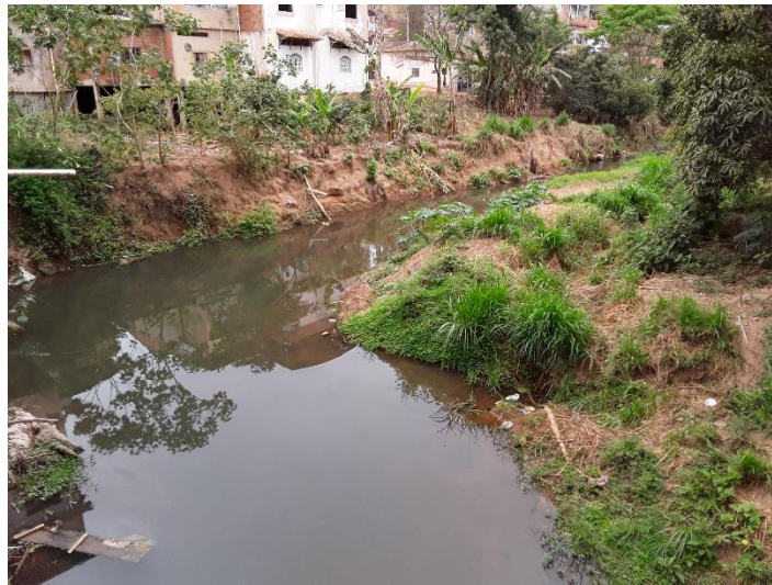
Figura 81 – Lançamento de esgoto no Ribeirão São Domingos
