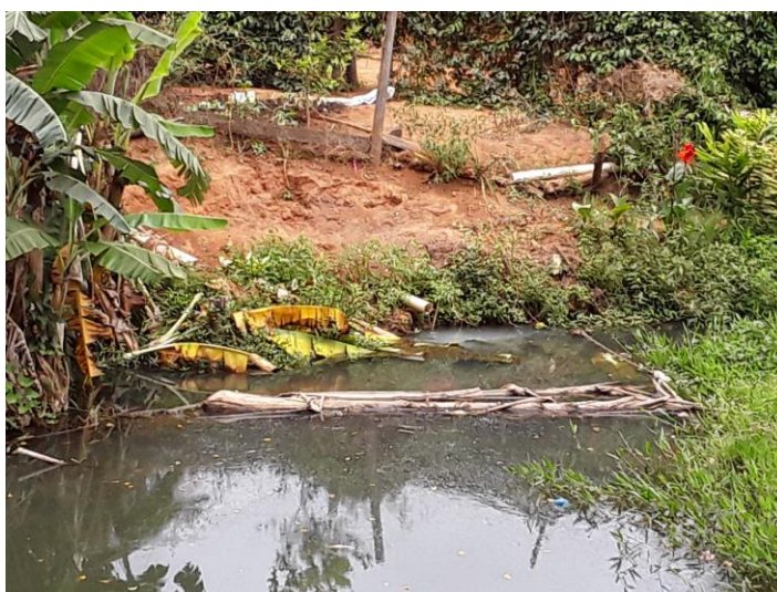
Figura 83 – Lançamento de esgoto no Povoado Água Limpa
