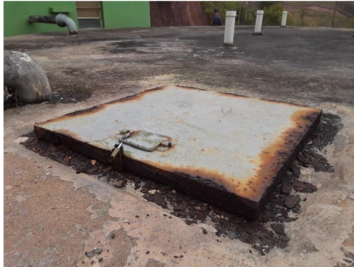
Figura 42 – Tampa de Inspeção
