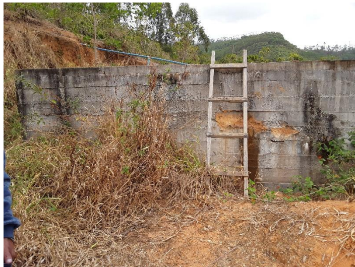
Figura 74 – Reservatório do Povoado Penha do Coco
