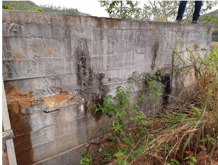
Figura 73 – Reservatório do Povoado Penha do Coco
