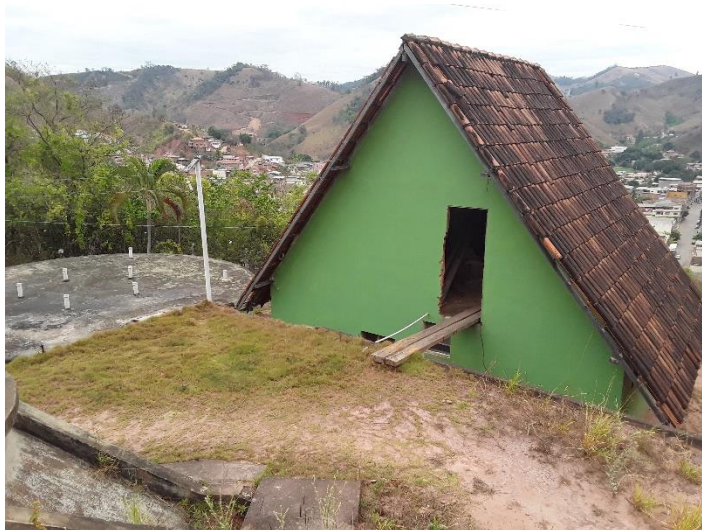
Figura 35 – Área da ETA
