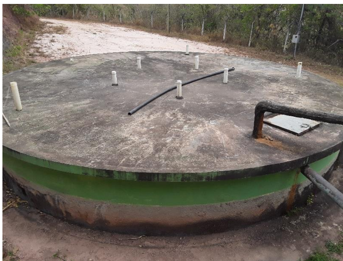
Figura 40 – Reservatório R2 - ETA
