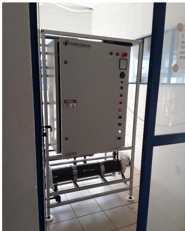
Figura 3 – Gerador de hipoclorito de cálcio na ETA I
