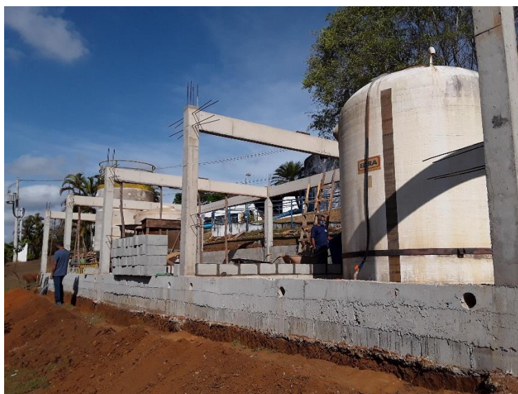
Figura 5 – Parque químico em construção
