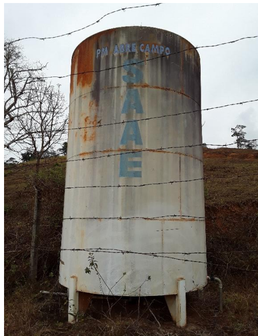
Figura 39 - Reservatório na localidade de Barroso
