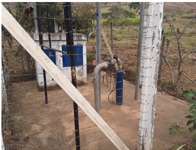
Figura 44 - Poço tubular na localidade de Cachoeira do Livramento.
