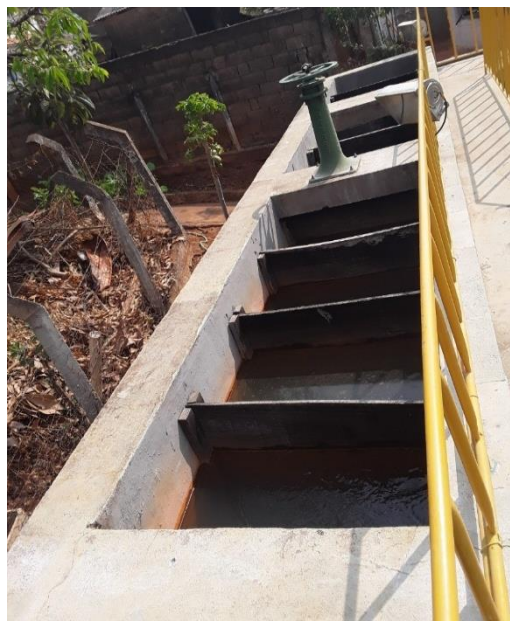
Figura 17 – Floculadores na ETA de Abre Campo
