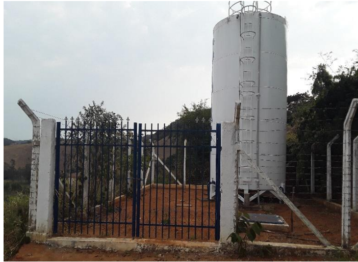
Figura 45 – Reservatório em Cachoeira do Livramento
