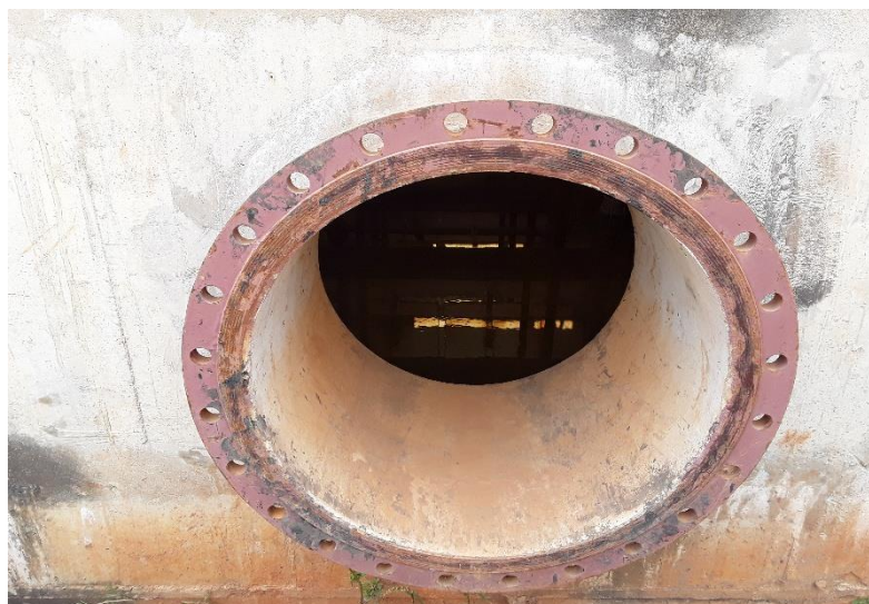
Figura 49 – Abertura na lateral do filtro anaeróbio
