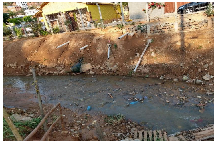
Figura 54 – Tubulações das residências de Abre Campo lançam esgoto in natura nos corpos hídricos que cortam a área urbana da sede do Município.
