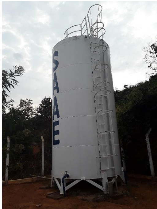
Figura 46 – Unidade do SAA se encontra em bom estado de conservação
