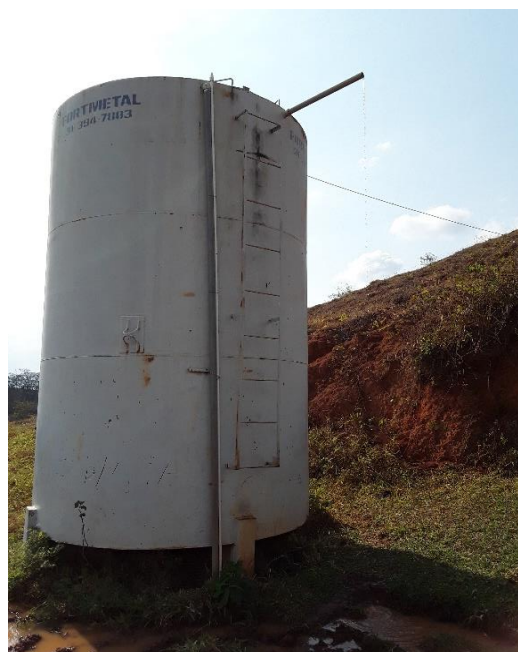
Figura 36 - Reservatório de Santa Efigênia.
