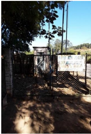
Cercamento da área do poço
