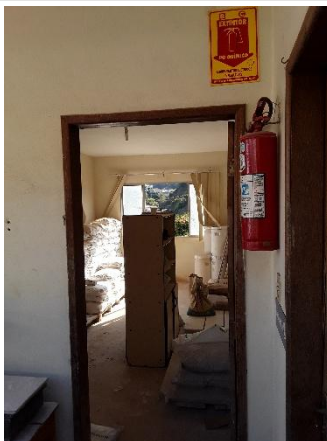
Depósito de produtos químicos, atualmente utilizado pelo SAAE.
