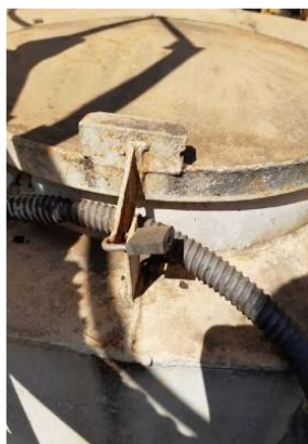
Tampa de Inspeção do Reservatório Cristal
