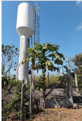
Reservatório Boa Vista
