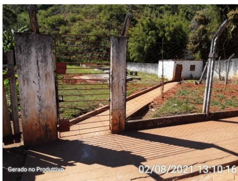
Portão de acesso e cercamento do poço de São Manoel
