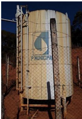
Reservatório do Distrito de São Manoel
