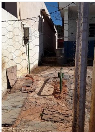
Área do Poço da Escola
