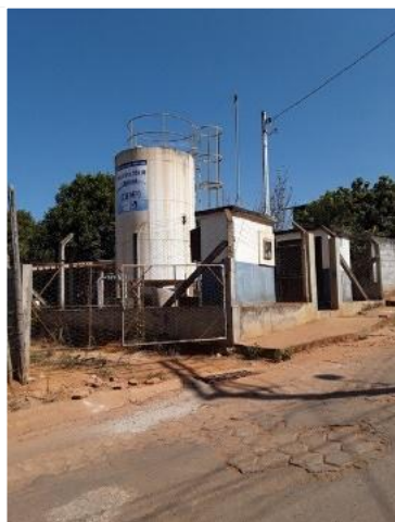
Área do reservatório
