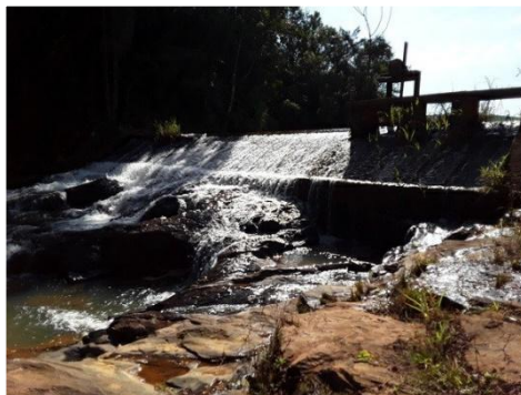
Barragem de captação no Córrego Samambaia
