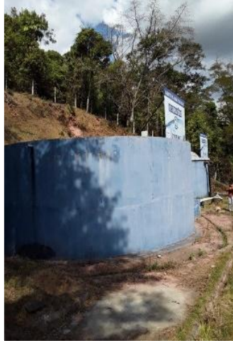
Reservatório ETA II
