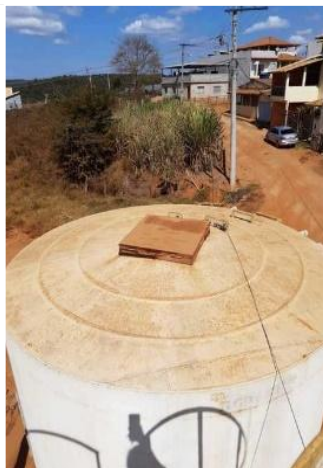
Tampa de inspeção do reservatório do Parque de Exposição 40m 3
