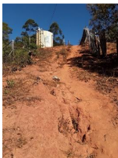
Acesso ao reservatório do Distrito de São Manoel
