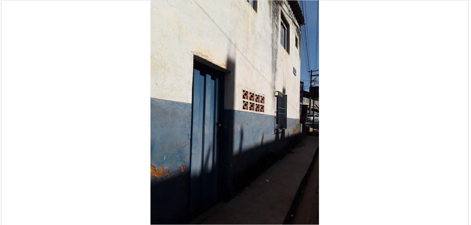
Casa de bomba
