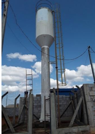
Reservatório Alto Cabral
