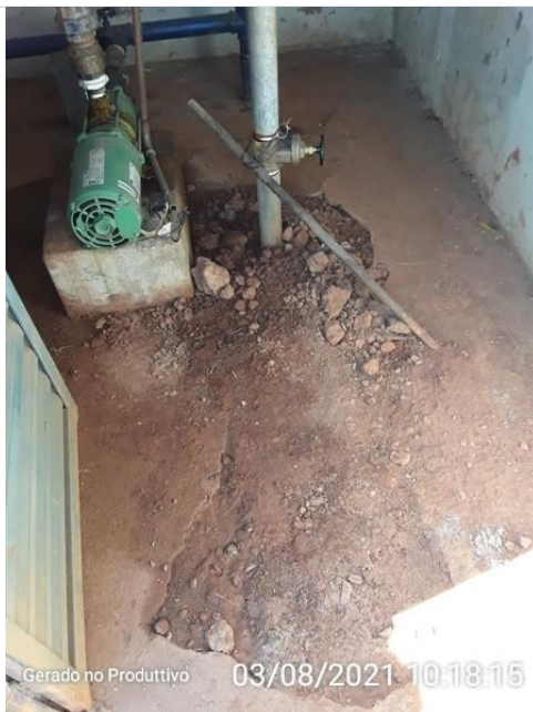
Piso da casa de bomba
