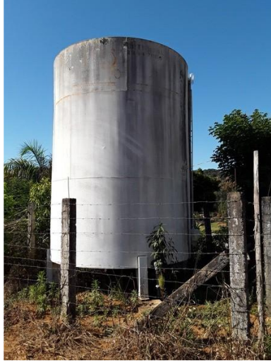
Reservatório do Distrito do Grama
