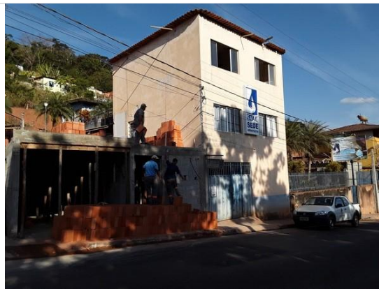
Obras da nova estrutura de atendimento do SAAE
