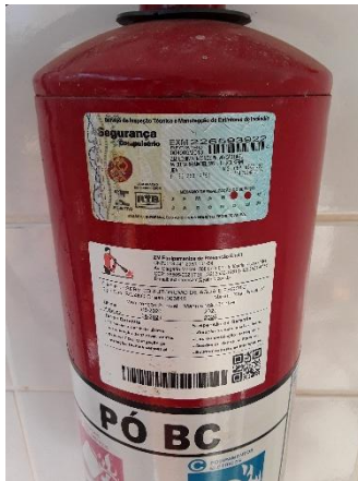
Etiqueta do extintor prevendo manutenção para o mês de junho de 2021.
