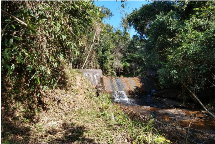
Figura 2 – Barragem na captação do Córrego Samambaia
