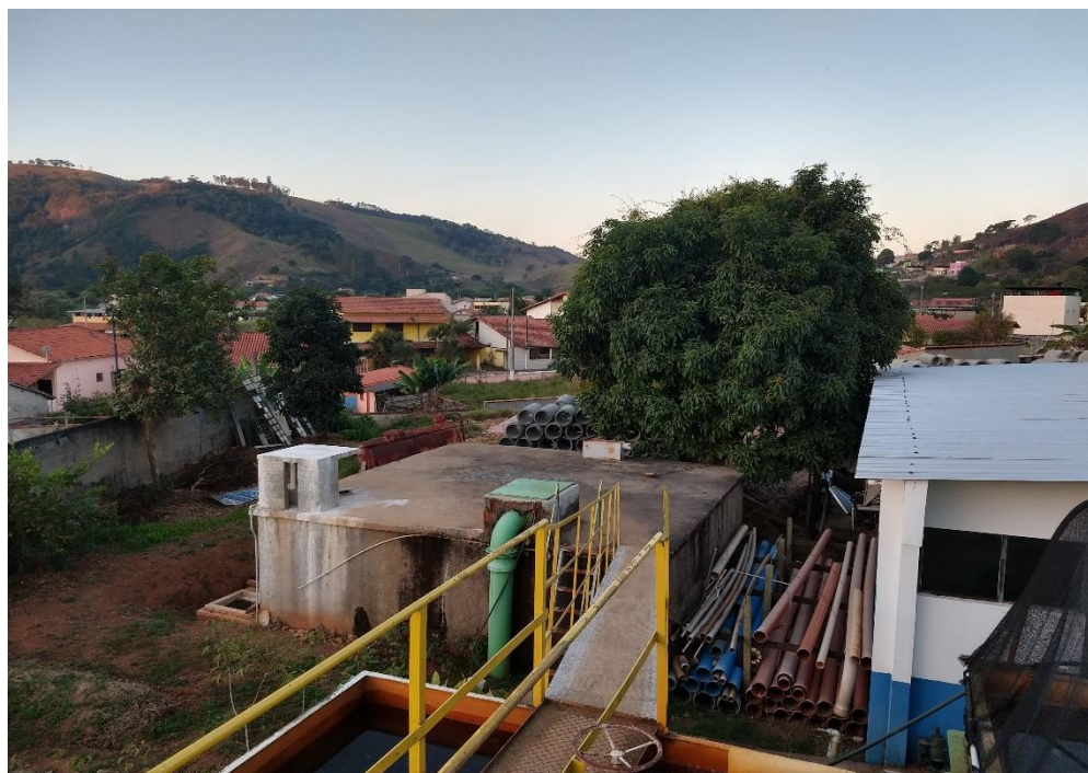
Figura 14 – Pátio da ETA passou por limpeza.
