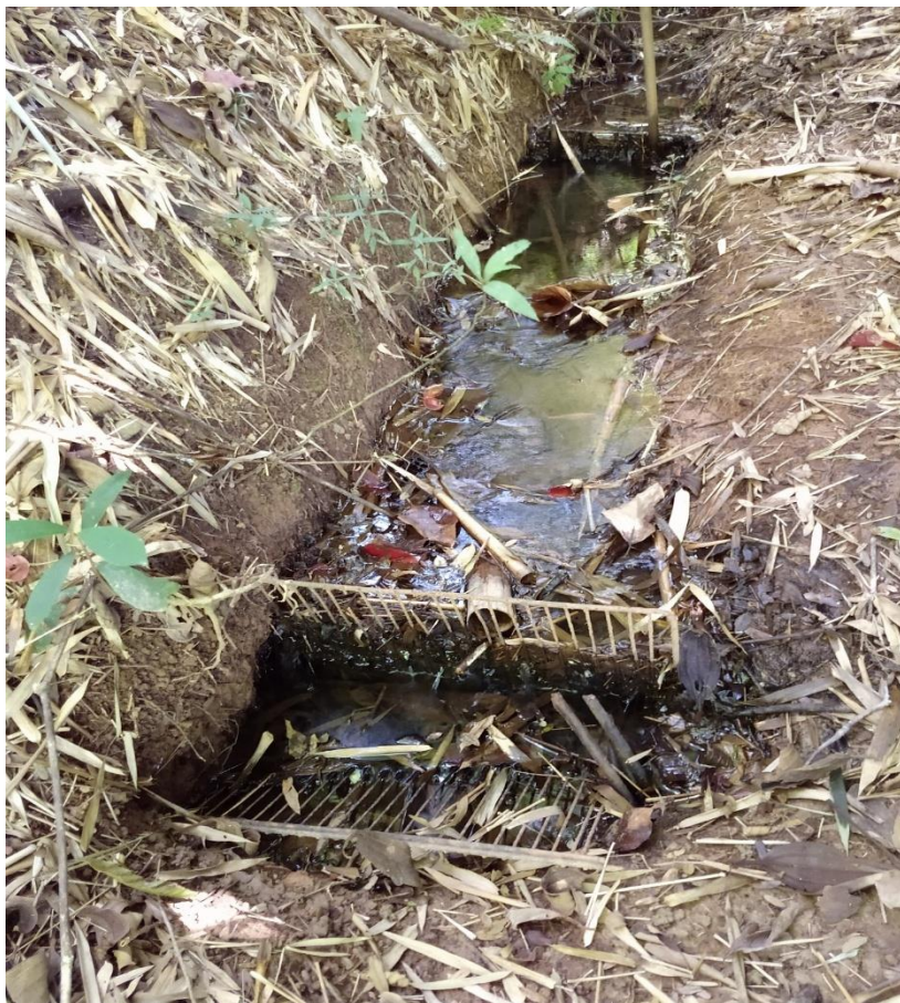
Figura 6 – Ponto de Captação sem identificação e cercamento.
