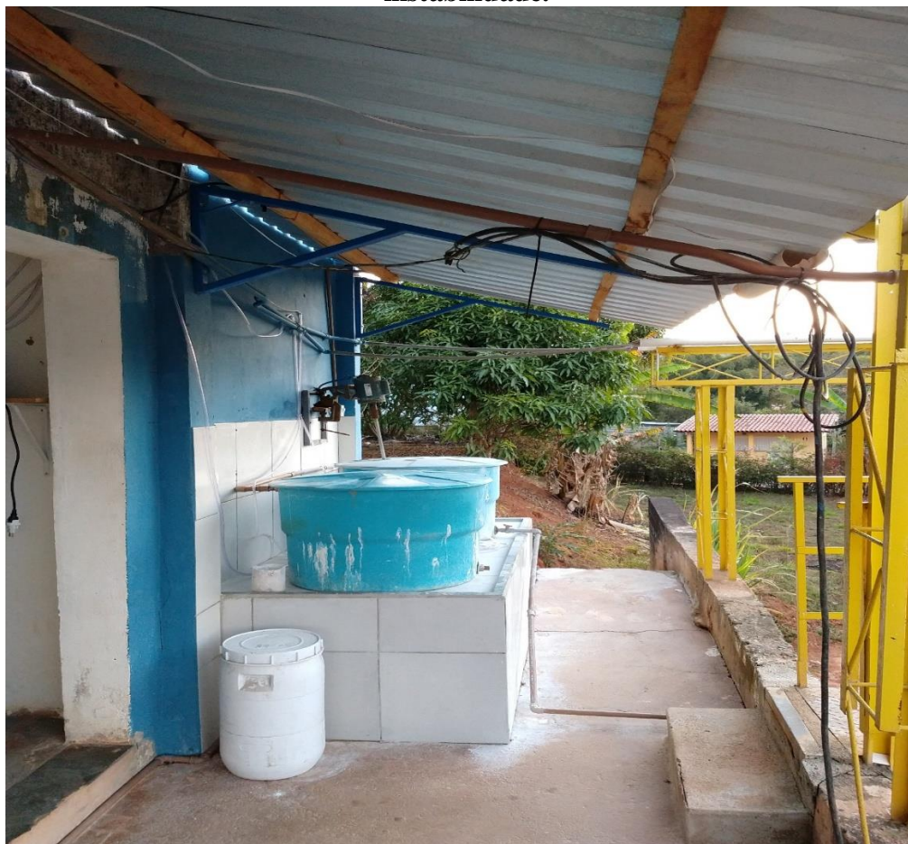
Figura 15 - Hipoclorito de cálcio em um local ao abrigo de luz solar, devido a sua instabilidade.
