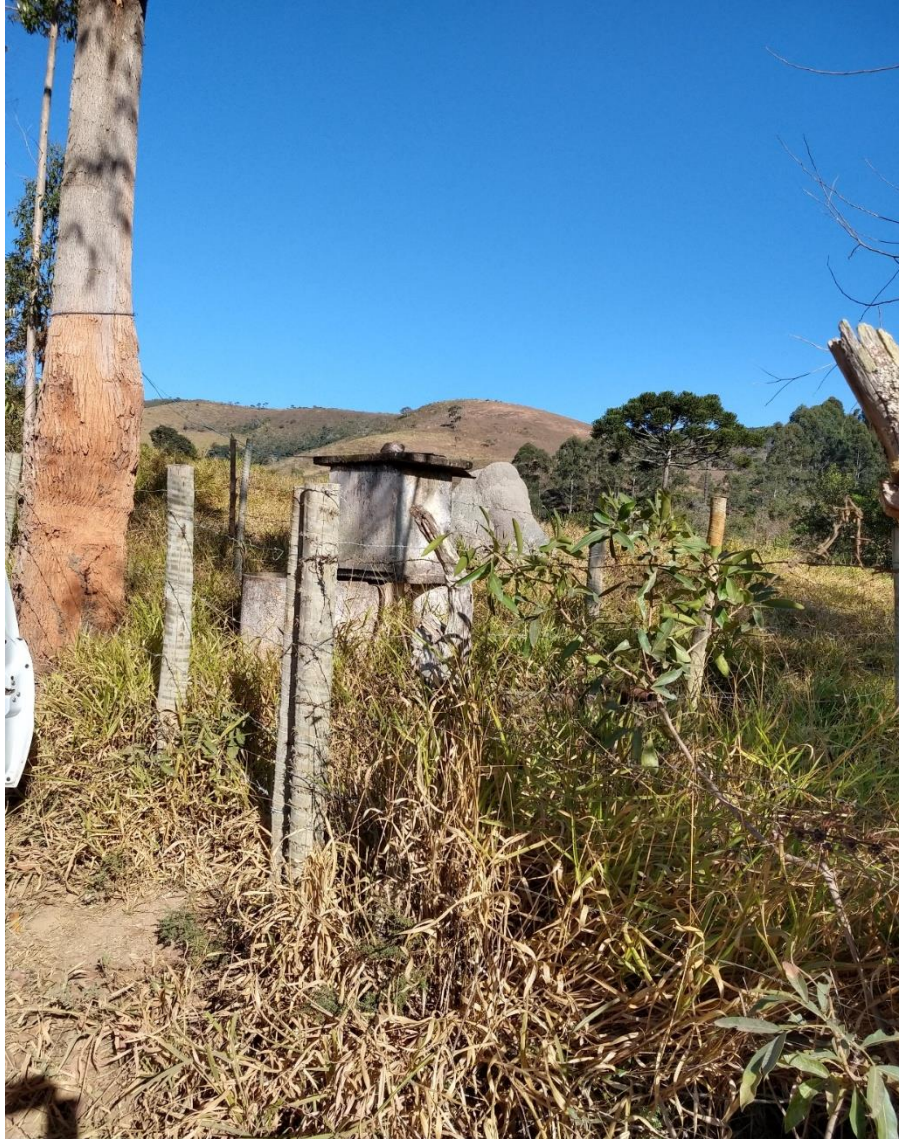
Figura 11 – Local onde é realizada captação em poço tubular sem identificação e com cercamento precário.
