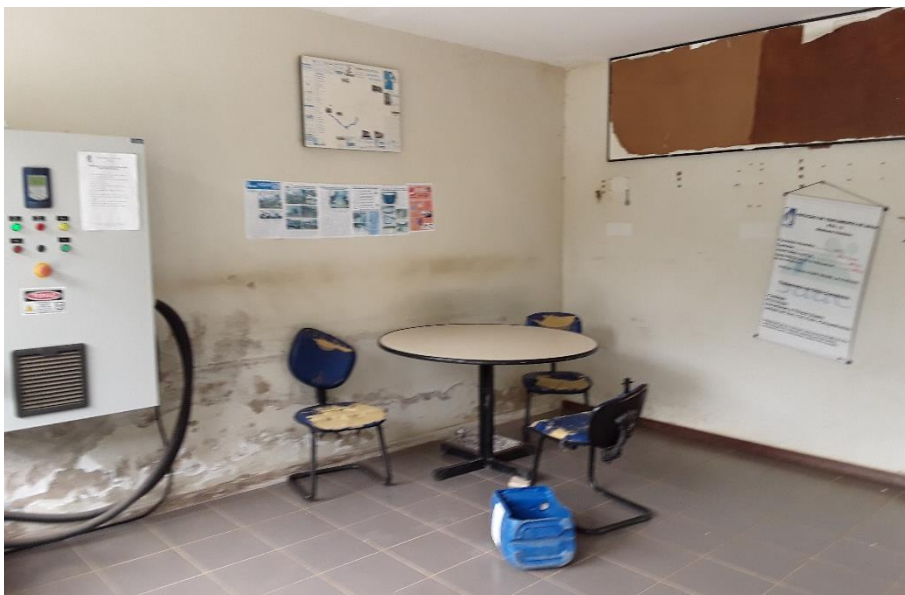
Figura 156 – área da casa de química
