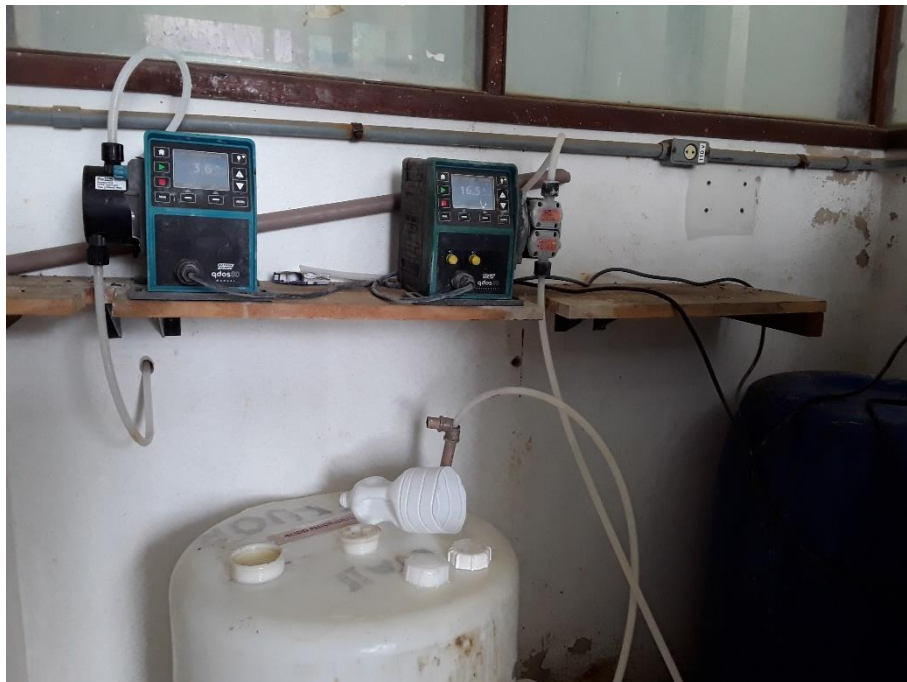
Figura 150 - Bombas dosadoras
