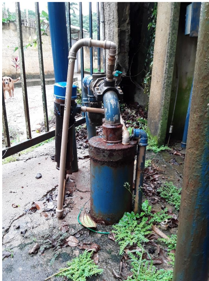
Figura 72 – Poço Tubular - Cristais
