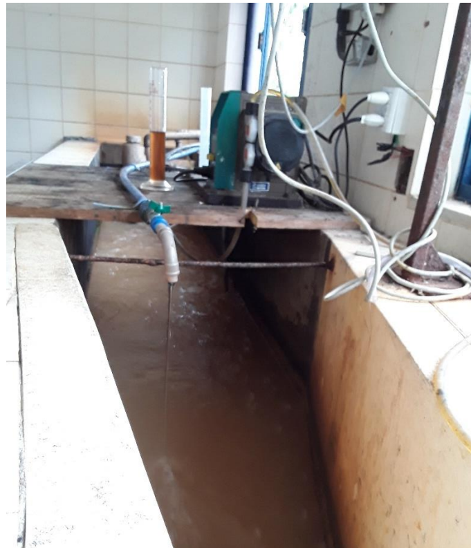
Figura 85 – Adição do Coagulante
