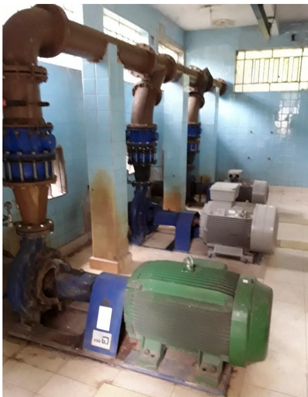
Figura 27 – Conjuntos motobomba 2
