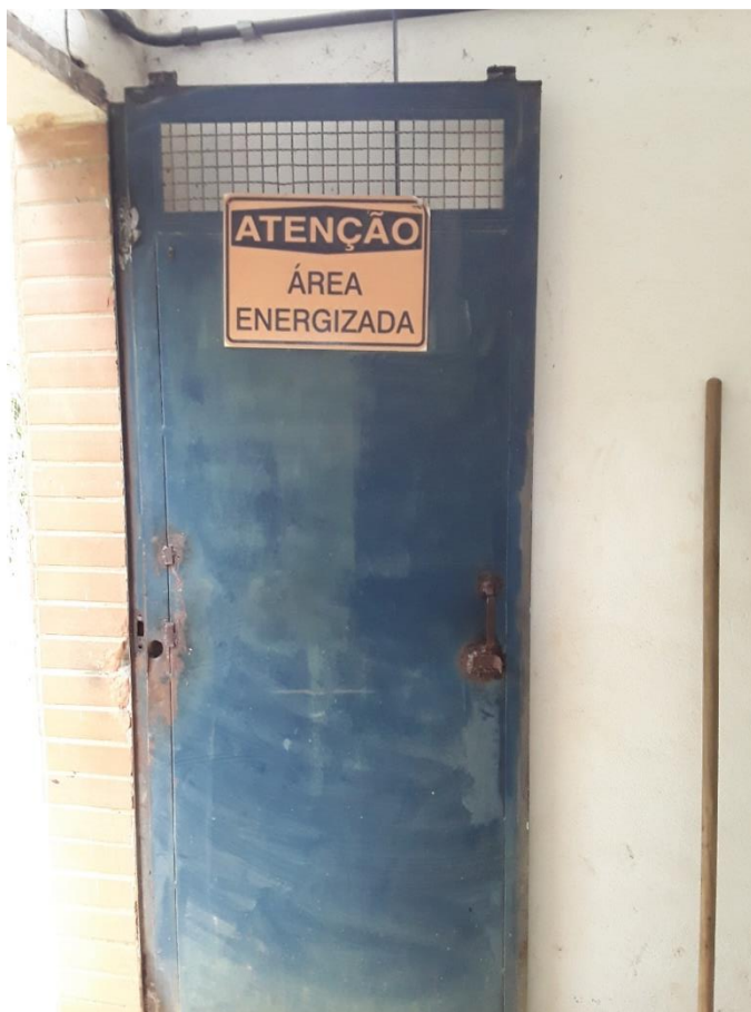
Figura 39 – Porta de acesso a casa de bombas
