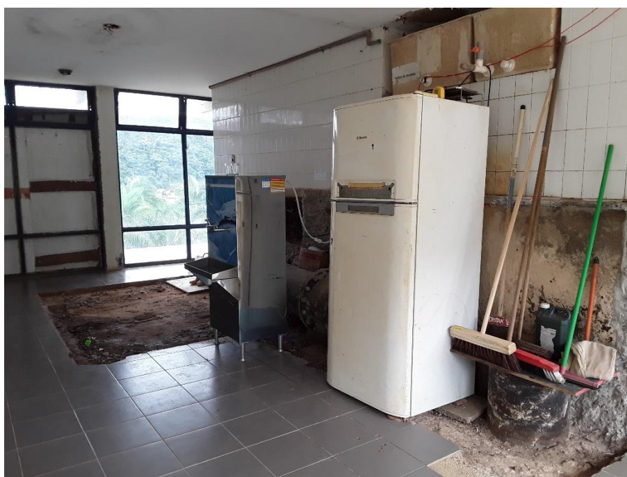
Figura 158 – Área da casa de química
