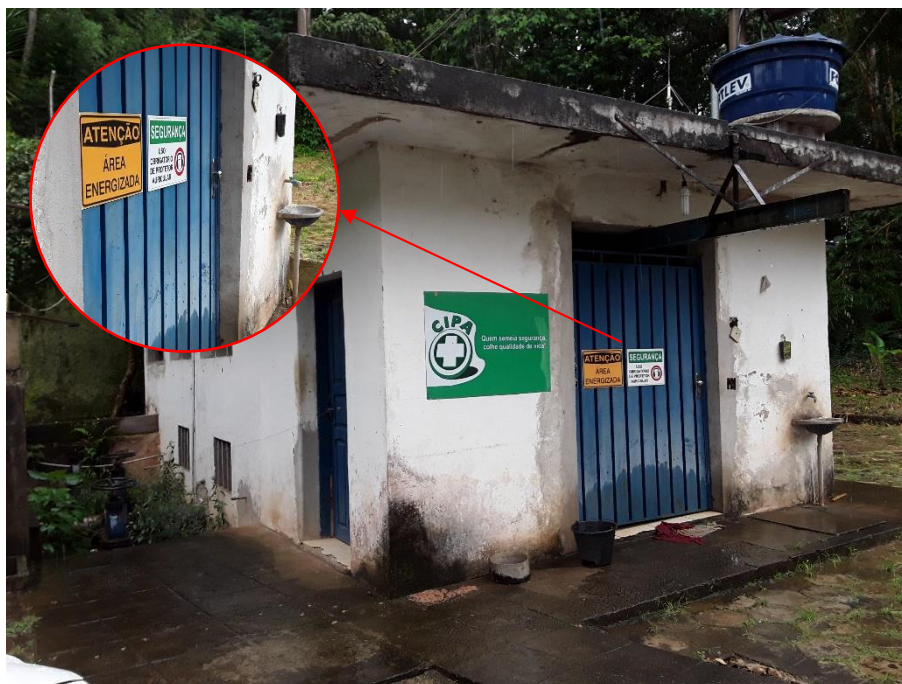
Figura 23 – Estação Elevatório de água bruta
