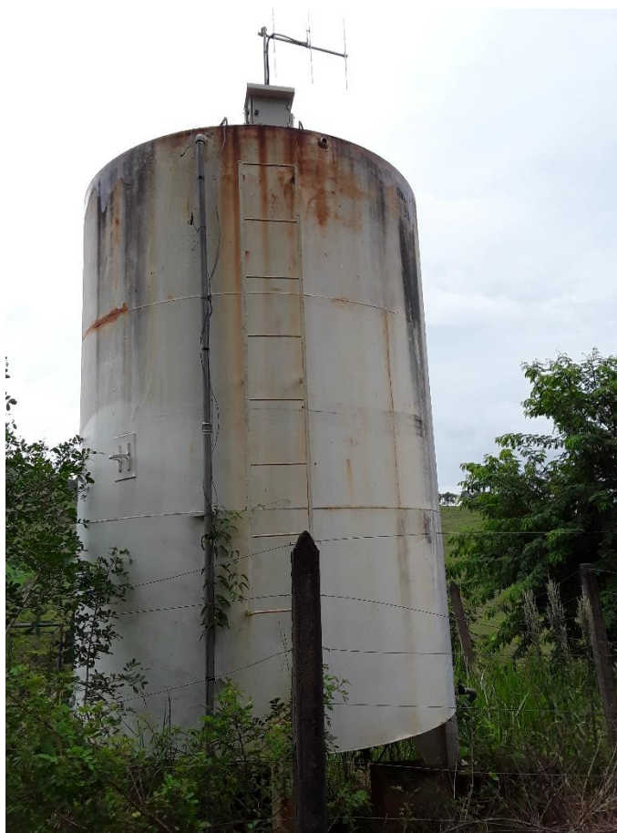
Figura 188 – Reservatório – Pau de Cedro
