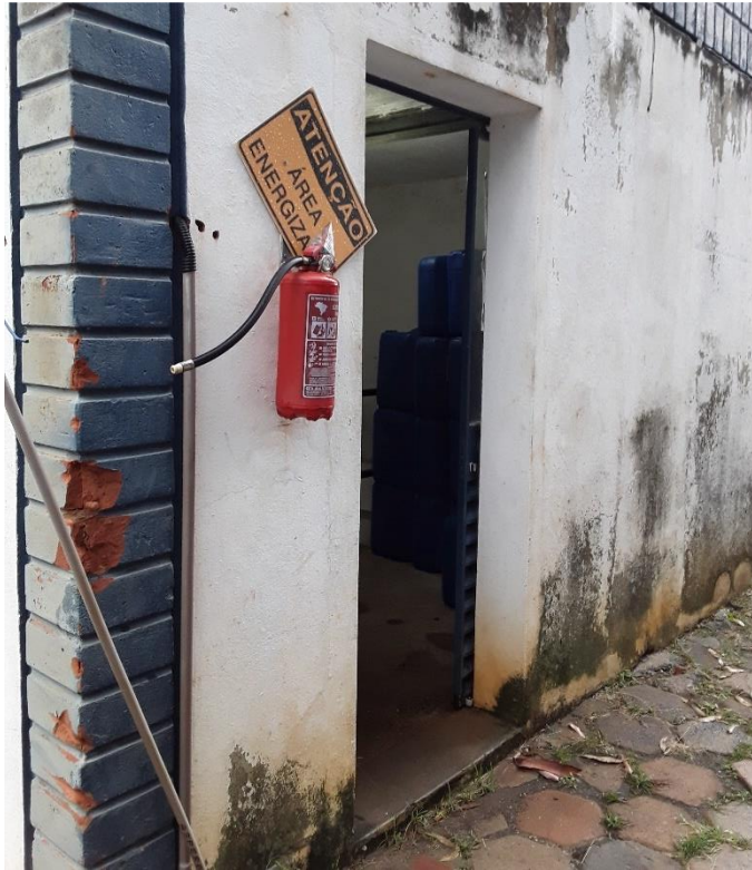
Figura 121 – Entrada da EEAT – ETA I
