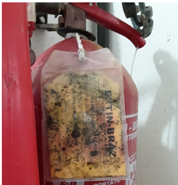
Figura 210 – Extintor de incêndio com a data de validade vencida
