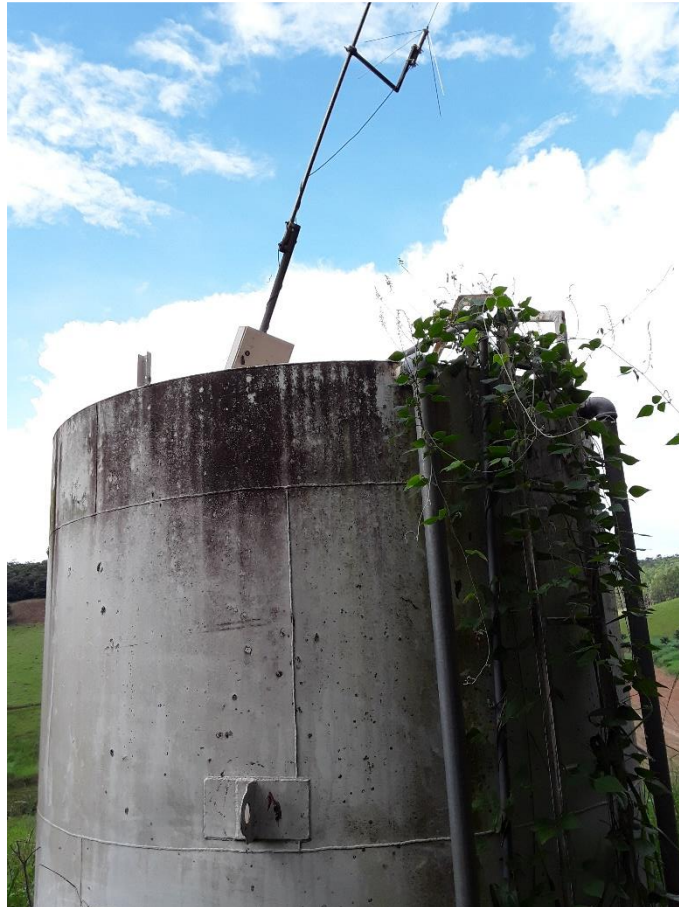
Figura 183 – Reservatório – Córrego São João
