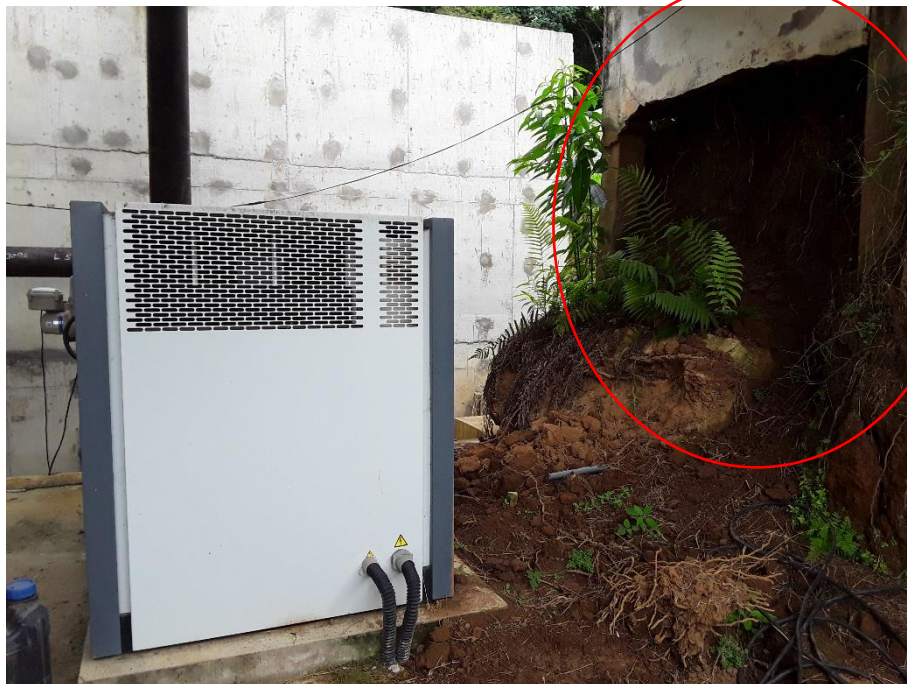
Figura 137 – Área do soprador – ETA II
