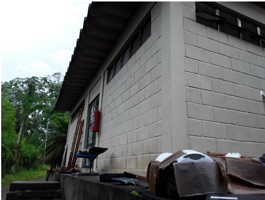
Figura 100 – área externa da antiga estrutura do laboratório microbiológico
