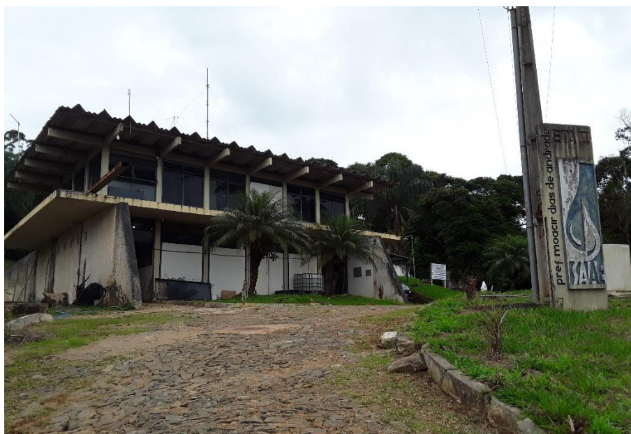
Figura 125 - Estação de tratamento de água – ETA II
