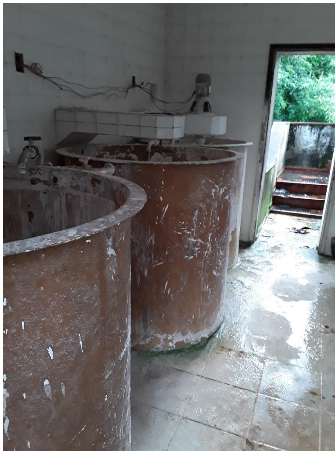
Figura 86 – Acesso ao decantado
