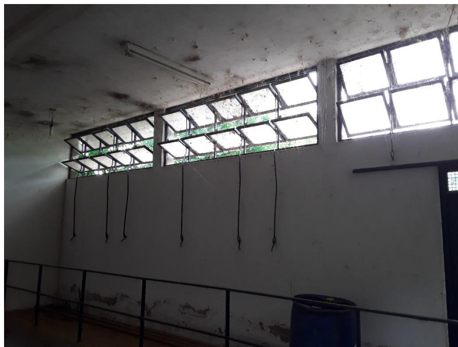
Figura 43 – Área interna da casa de bombas
