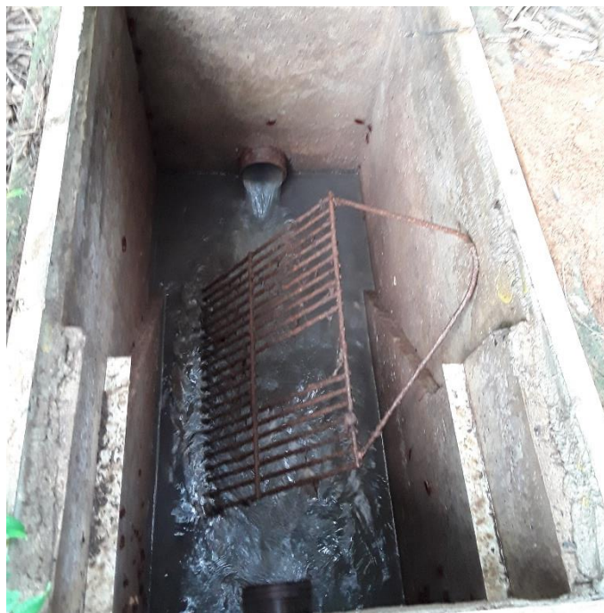
Figura 246 – Sistema de gradeamento – ETE Violeira
