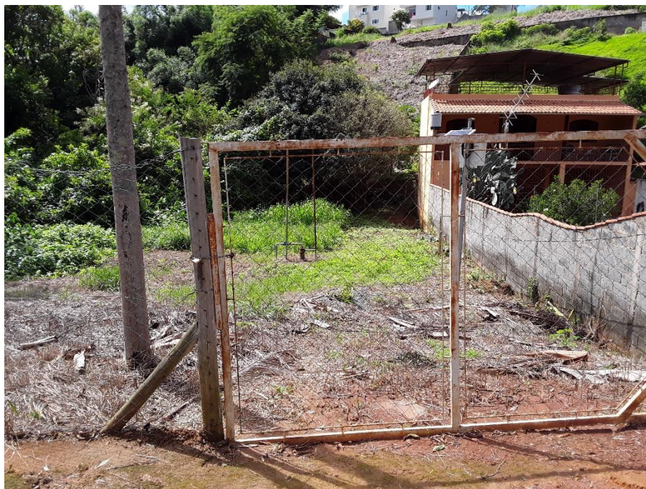
Figura 78 – Área da captação subterrânea – Rua Nova 2
