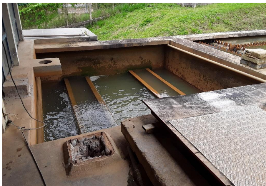
Figura 141 – Área dos filtros sem proteção – ETA II
