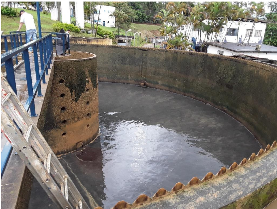
Figura 90 – Decantador sem lavado
