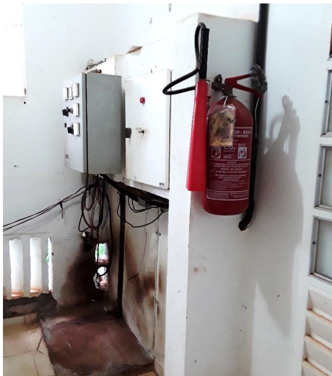
Figura 210 – Extintor de incêndio com a data de validade vencida
