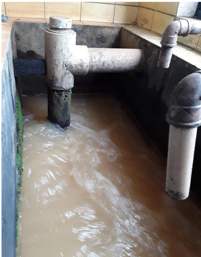
Figura 83 – Calha Parshall – ETA I
