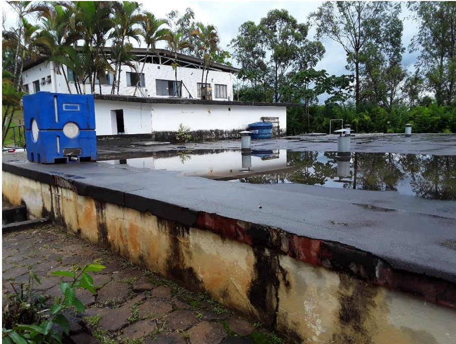
Figura 99 – Reservatório 2 – ETA I
