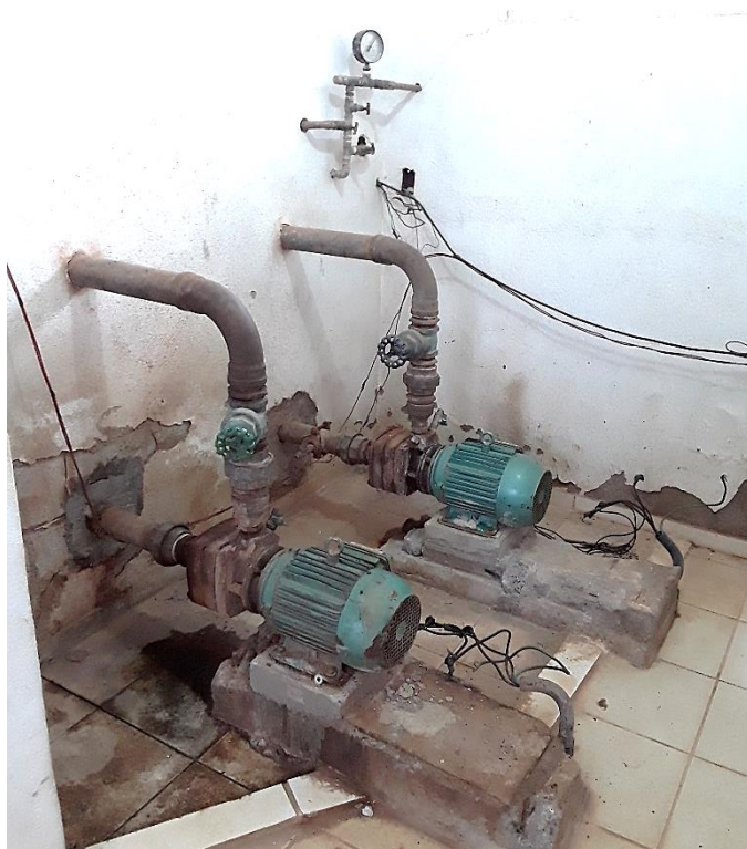
Figura 208 – Conjuntos motobombas
