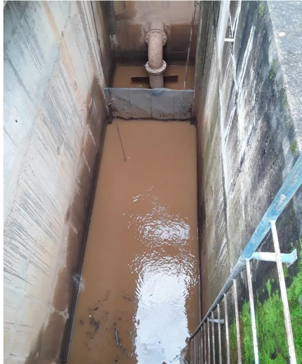
Figura 37 - Desarenador
