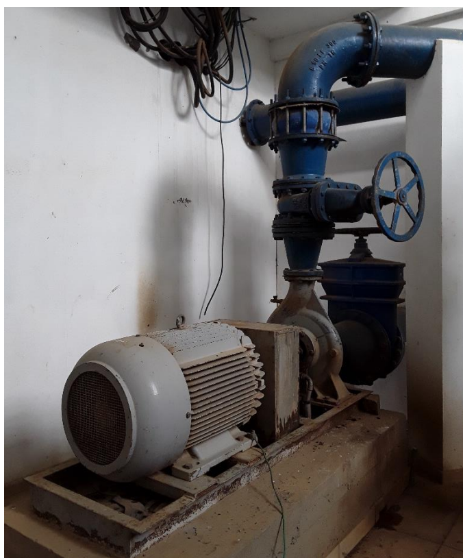
Figura 177 – Conjunto motobomba – ETA II
