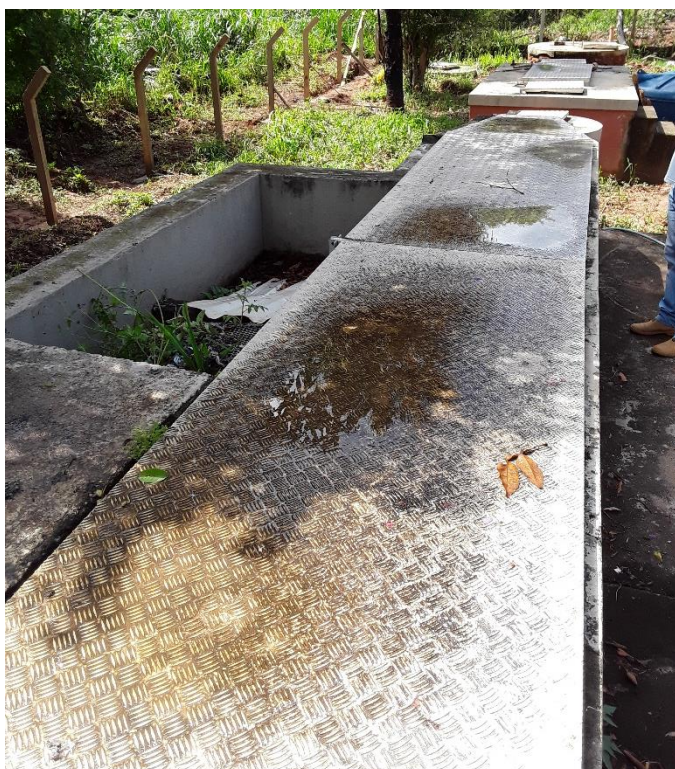
Figura 225 – Sistema de gradeamento e desarenador – ETE Romão dos Reis
