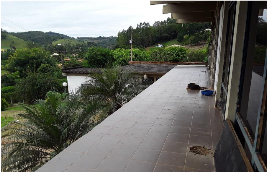
Figura 155 – Área frontal da casa de química
