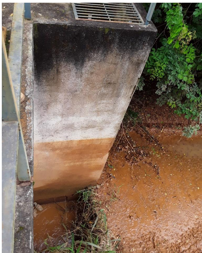
Figura 34 – Marca do nível da água no período de enchente
