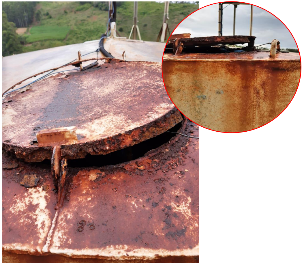
Figura 190 – Tampa de inspeção – Reservatório Pau de Cedro
