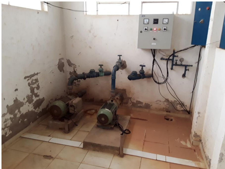
Figura 220 – Conjuntos motobombas
