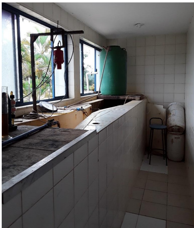
Figura 83 – Calha Parshall – ETA I
