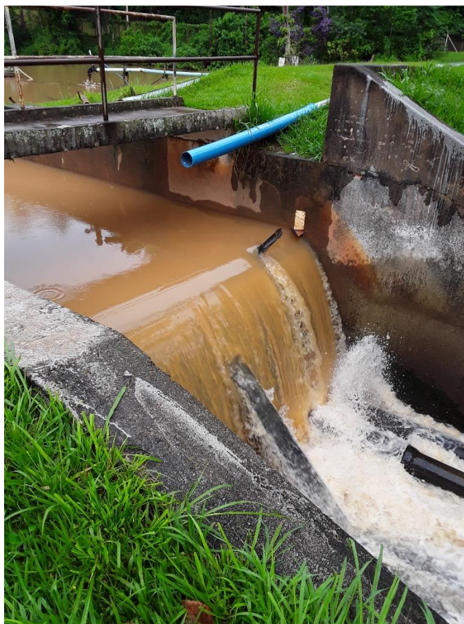
Figura 17 – Barragem de nível
