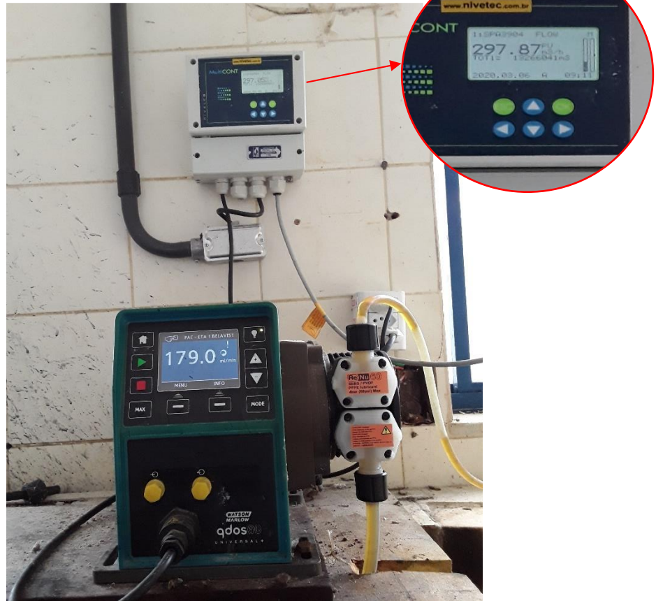
Figura 85 – Adição do Coagulante
