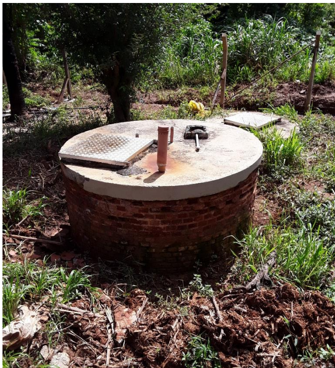
Figura 230 – Filtro anaeróbio– Romão dos Reis
