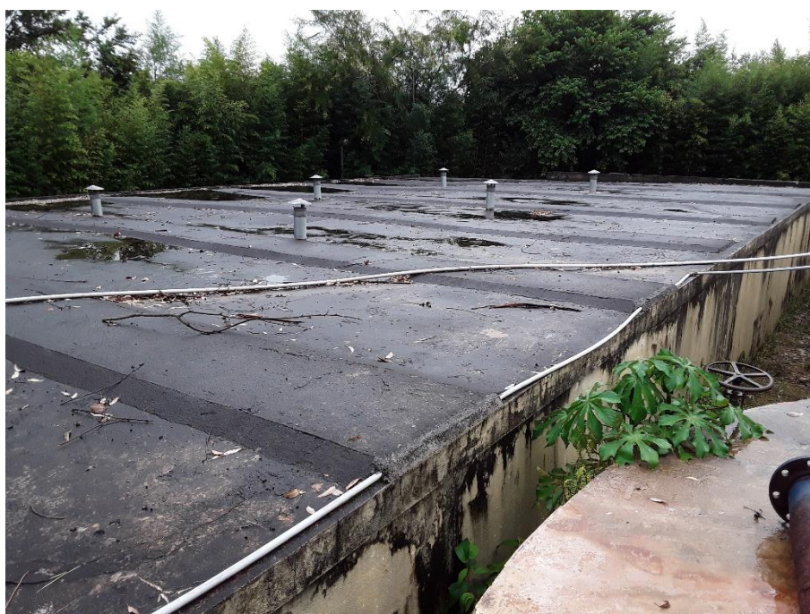
Figura 96 – Reservatório 1 - ETA I
