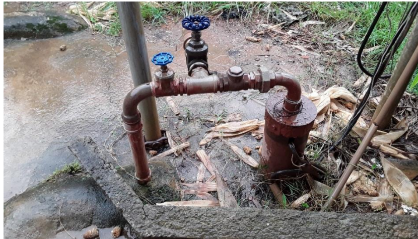
Figura 211 – Poço Tubular
