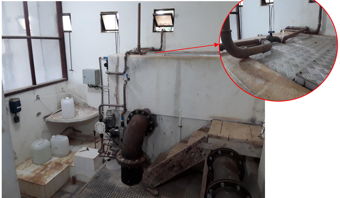
Figura 149 – Adição do hipoclorito de sódio
