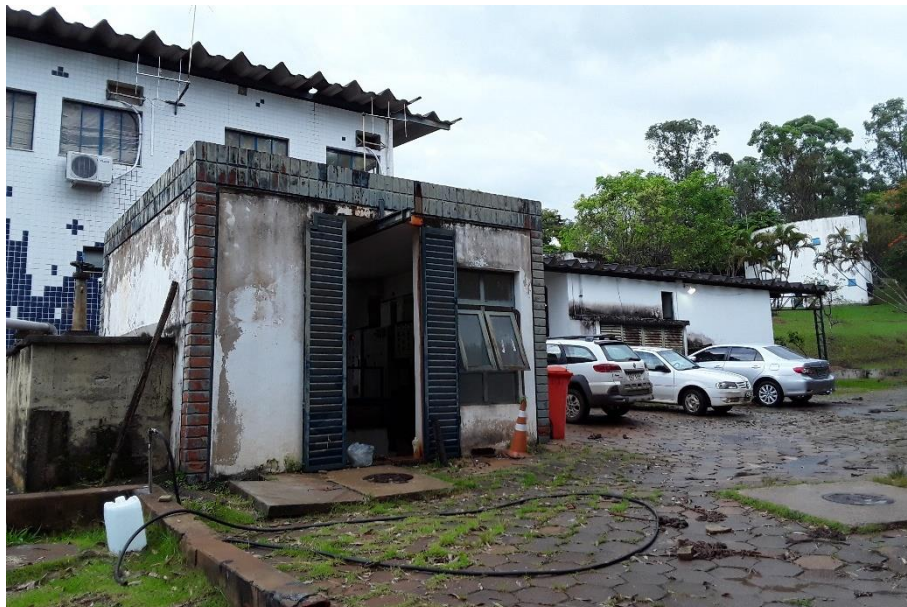
Figura 120 – EEAT – ETA I
