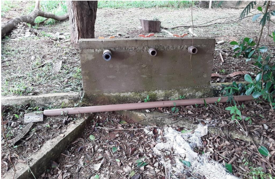
Figura 173 – Local para receber produtos químicos
