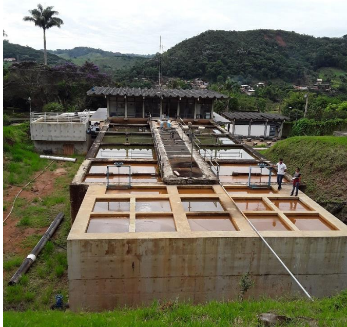
Figura 128 – Vista superior da ETA II
