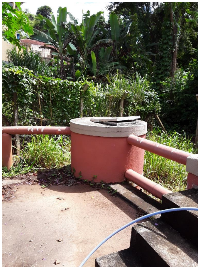
Figura 225 – Sistema de gradeamento e desarenador – ETE Romão dos Reis
