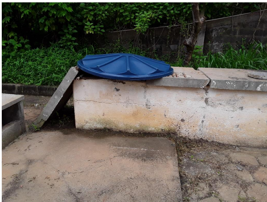
Figura 143 – Tampa do tanque de contato
