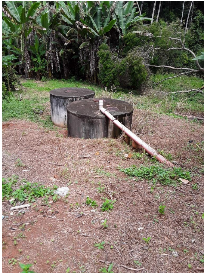
Figura 231 – Área do sistema de tratamento Paraíso
