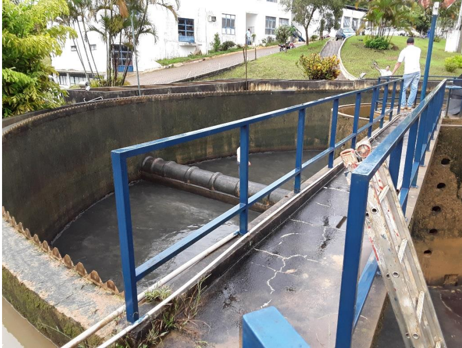
Figura 90 – Decantador sem lavado
