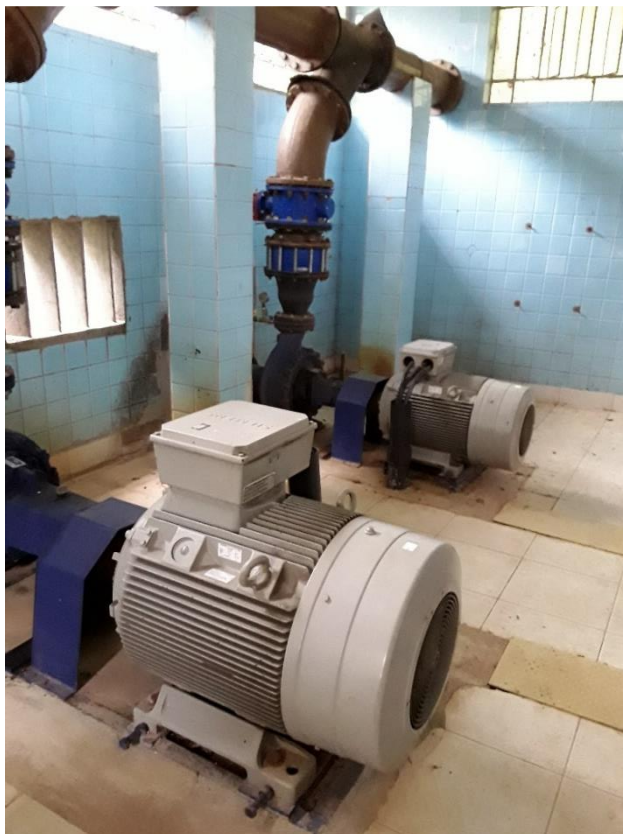
Figura 26 – Conjuntos motobomba 1
