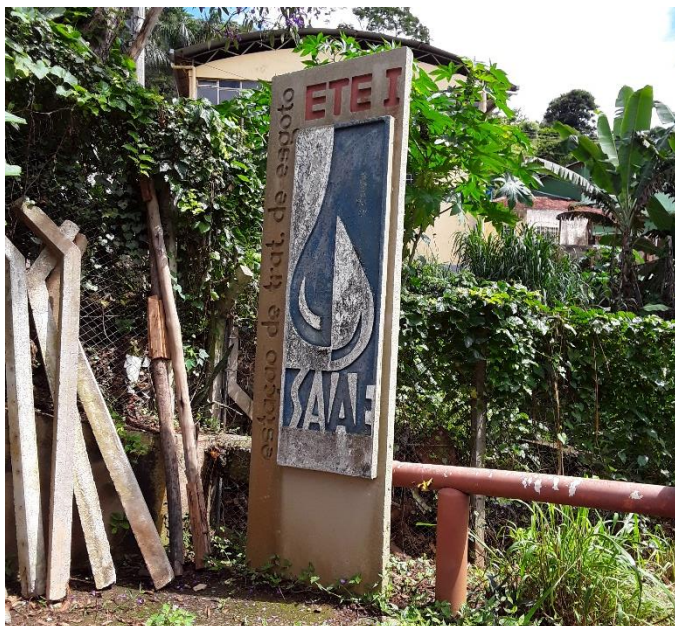
Figura 229 – Placa de identificação da ETE Romão dos Reis
