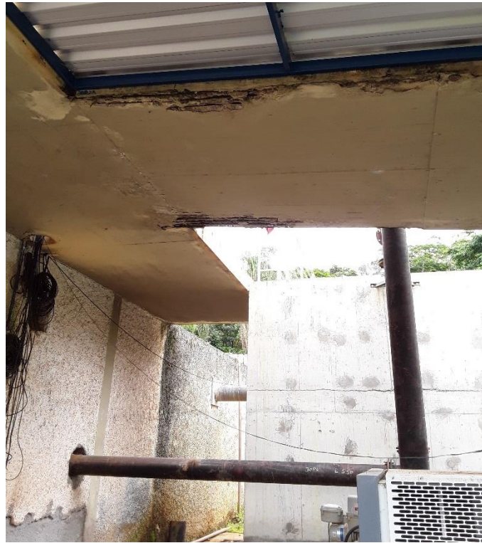
Figura 138 – Rampa de acesso a casa de química
