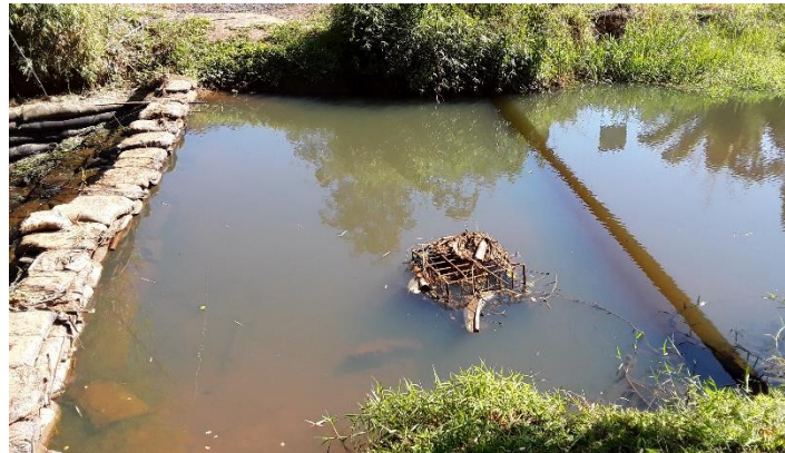
Figura 6 – Barragem de Captação – Rio Turvo Sujo
