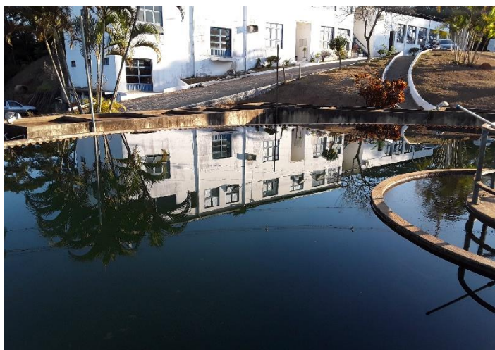
Figura 61 – Decantador – ETA I
