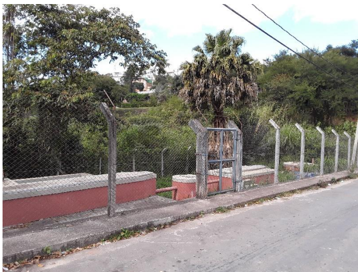
Figura 73 – Área da ETE Romão dos Reis
