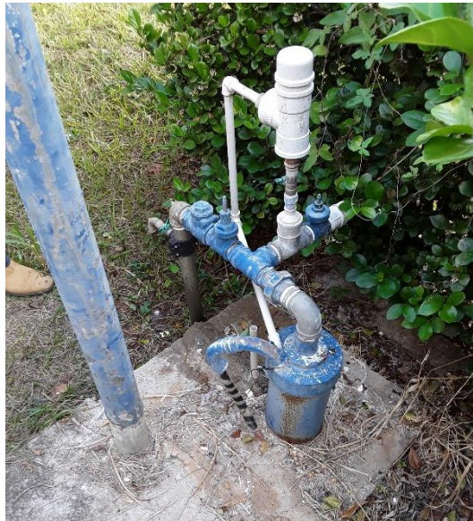
Figura 32 – Captação subterrânea – Octávio Pacheco
