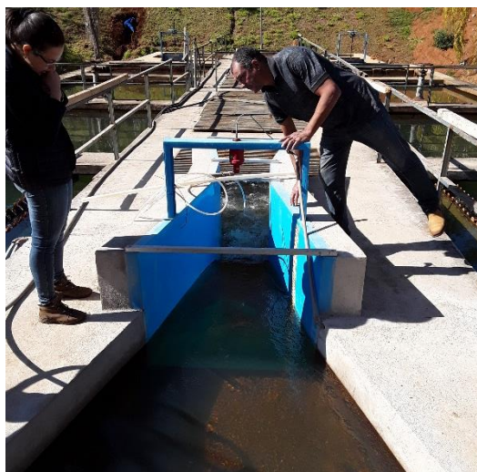
Figura 63 – Nova Calha Parshall – ETA II
