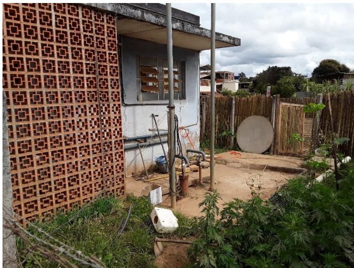
Figura 26 – Área da captação Subterrânea 2 – São José do Triunfo
