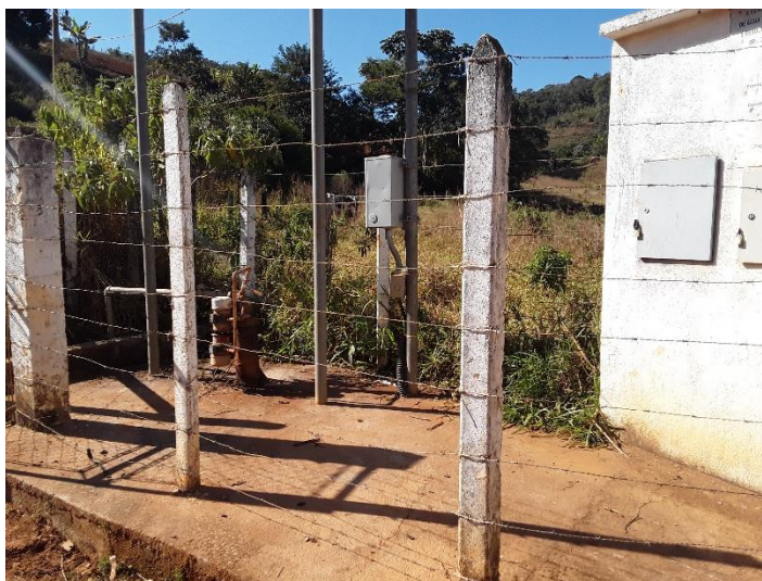
Figura 12 – Área da captação subterrânea – Pau de Cedro
