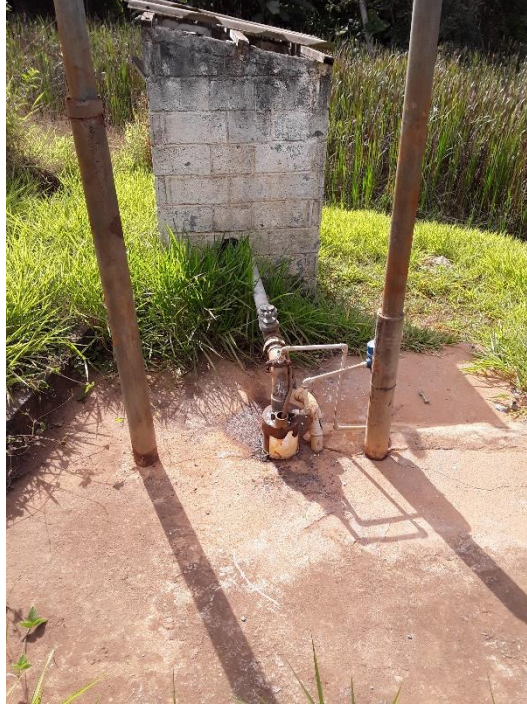
Figura 36 – Área da captação subterrânea – Nova Viçosa
