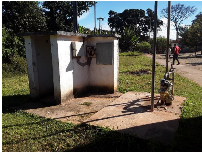
Figura 42 – Área da captação subterrânea – São Francisco de Assis
