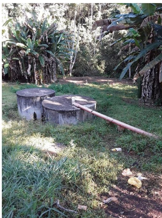
Figura 75 – Área da ETE Paraíso
