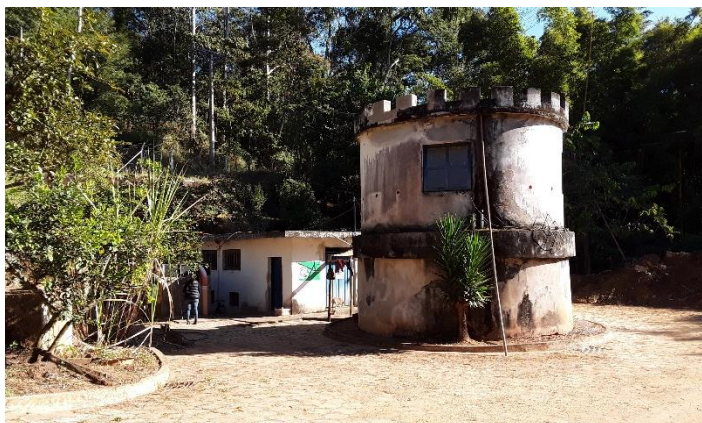
Figura 3 – Área externa da casa de bombas - Ribeirão São Bartolomeu
