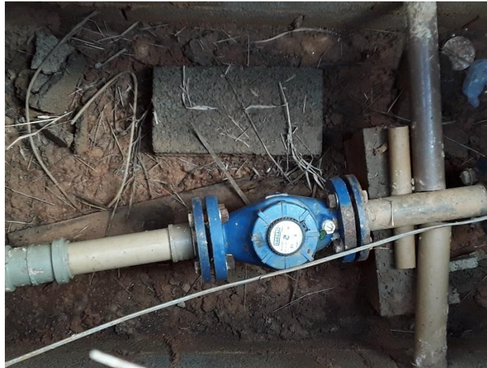
Figura 17 – Macromedidor - Buieié
