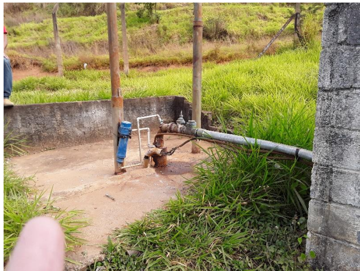
Figura 37 – Área da captação subterrânea – Nova Viçosa
