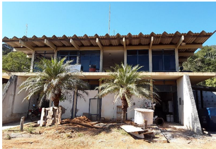
Figura 72 – Vista da fachada – ETA II
