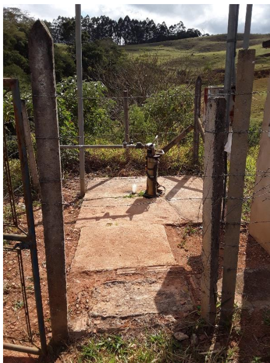
Figura 16 – Área da Captação - Buieié
