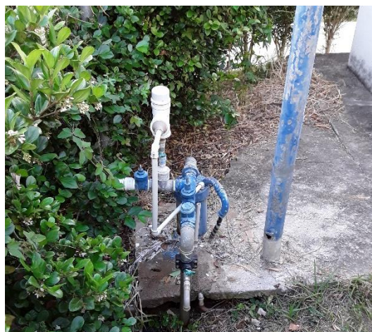
Figura 33 – Área da captação subterrânea – Octávio Pacheco
