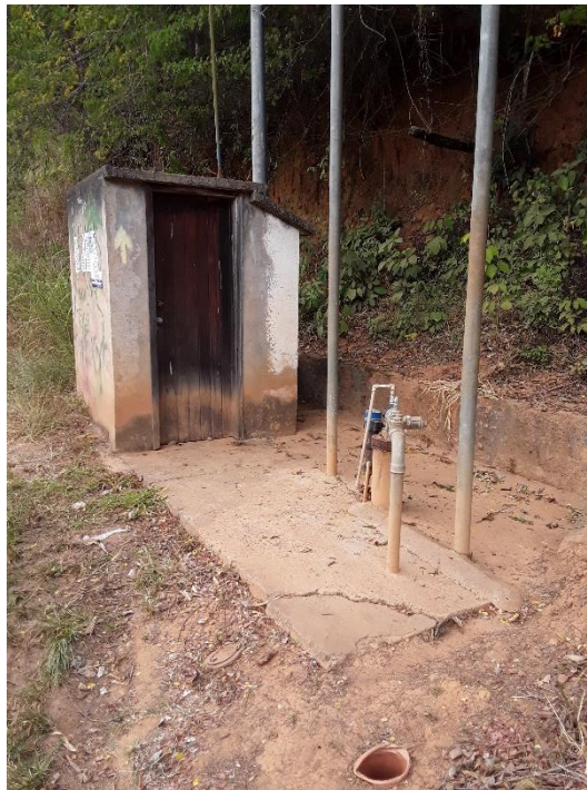
Figura 34 – Captação subterrânea – Romão dos Reis
