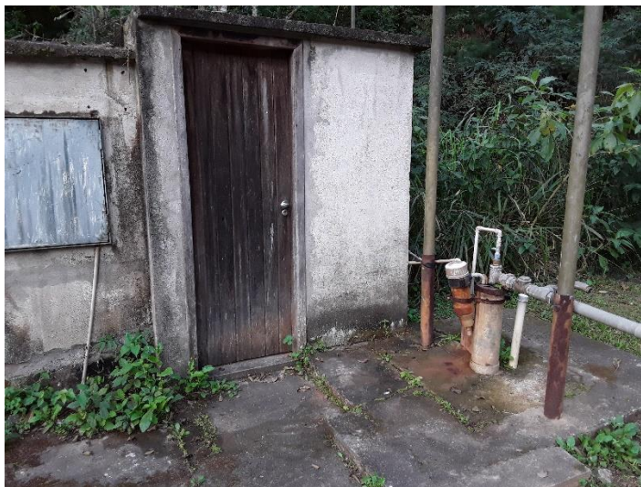
Figura 30 – Área da captação subterrânea – Vila Alves
