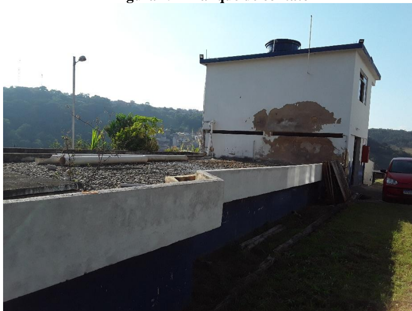
Figura 29 – Tanque de contato
