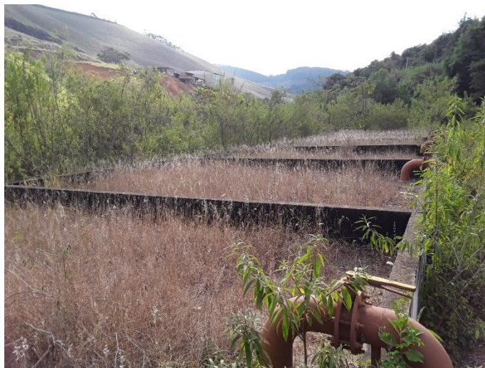
Figura 337 – Leito de secagem
