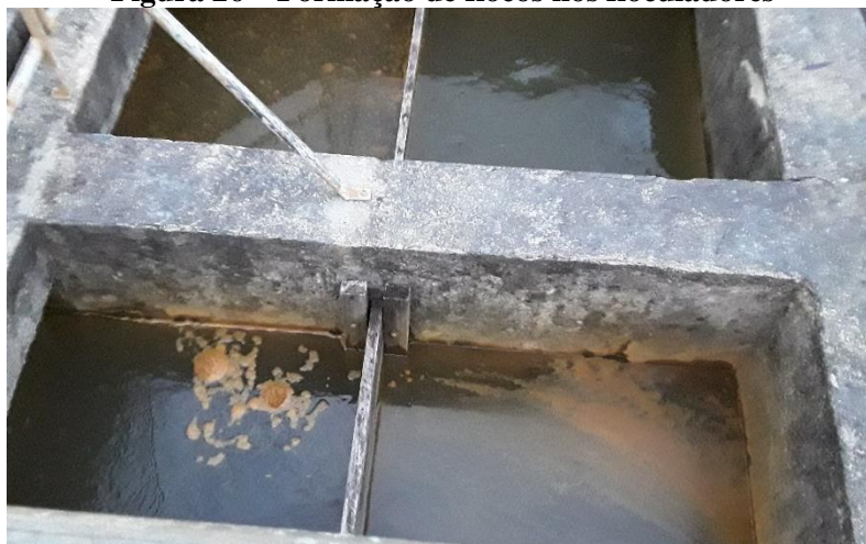
Figura 26 – Formação de flocos nos floculadores
