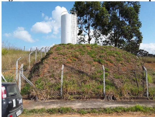
Figura 49 – Reservatório Morada do Campo
