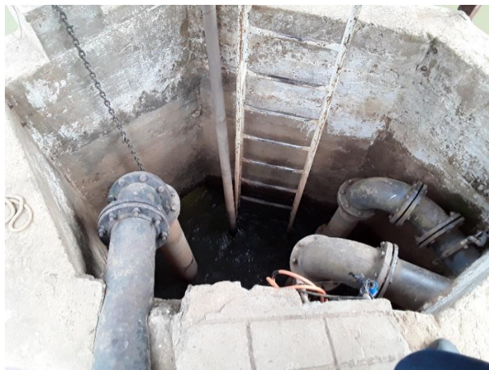
Figura 16 – Estrutura de captação no Rio Manhuaçu.
