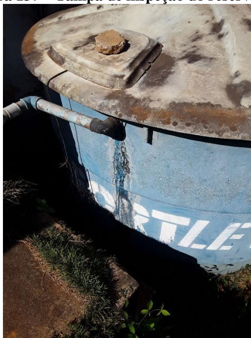
Figura 137 – Tapa de inspeção do reservatório
