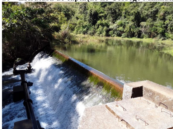
Figura 10 – Estrutura de captação no Córrego Manhuaçuinho
