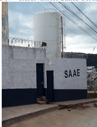
Figura 87 – Reservatório Santa Terezinha II
