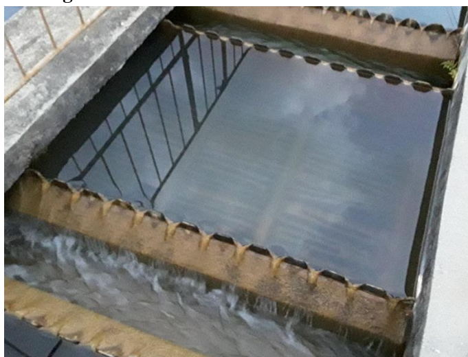
Figura 27 – Funcionamento dos decantadores
