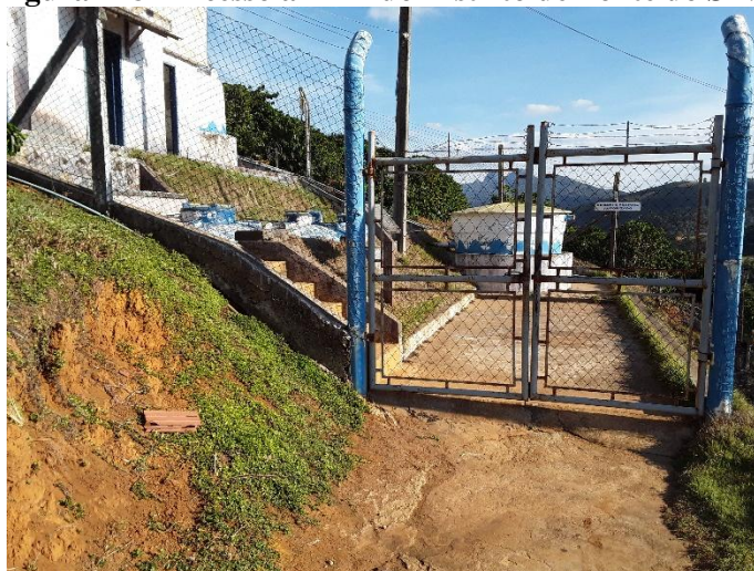
Figura 178 – Acesso à ETA do Distrito de Ponte do Silva
