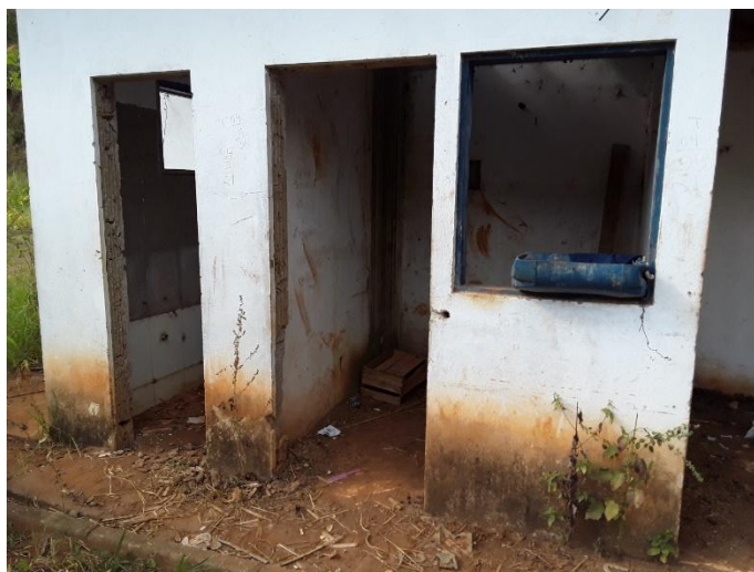
Figura 336 – Local onde seria a estrutura administrativa
