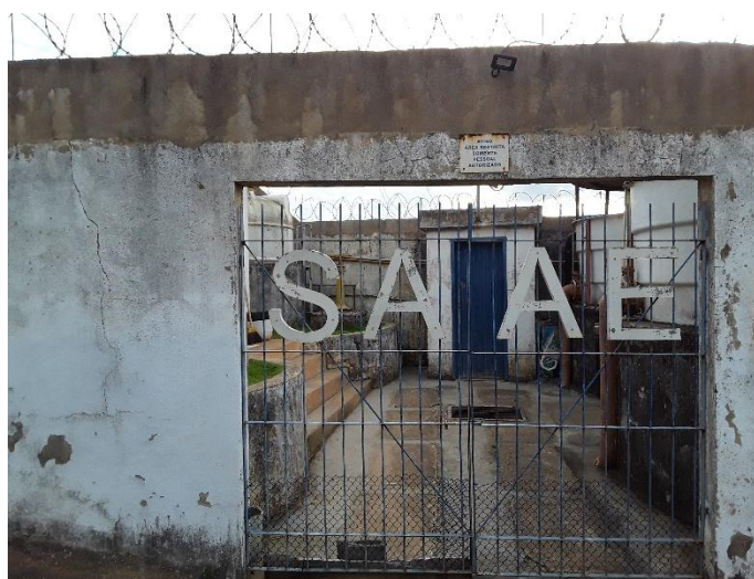
Figura 265 – Entrada da ETA
