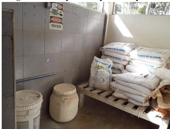
Figura 244 – Depósito de produtos químicos
