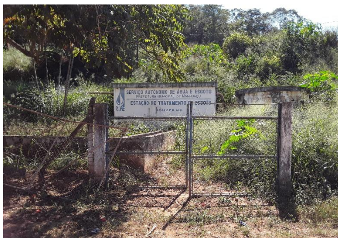
Figura 339 – Portão de entrada na ETE - Realeza
