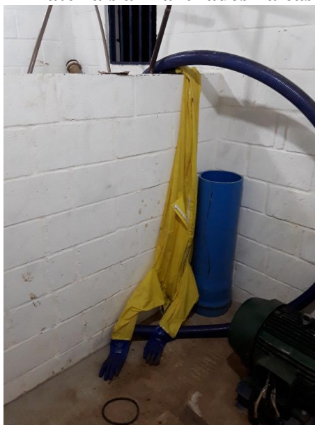
Figura 289 – Materiais armazenados na casa de bomba
