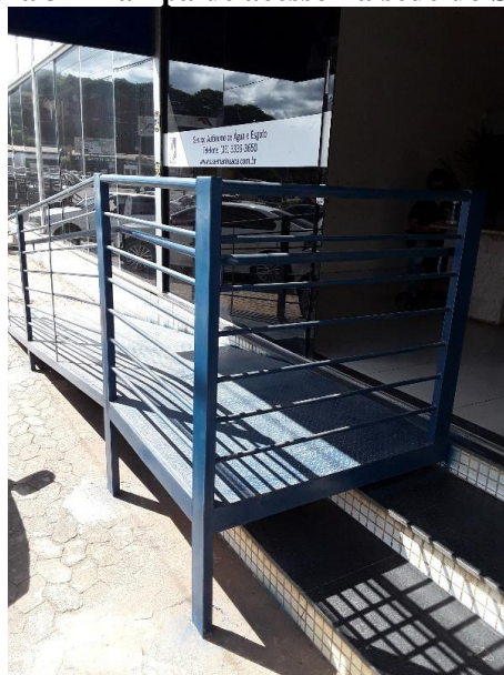
Figura 3 – Rampa de acesso na sede do SAAE
