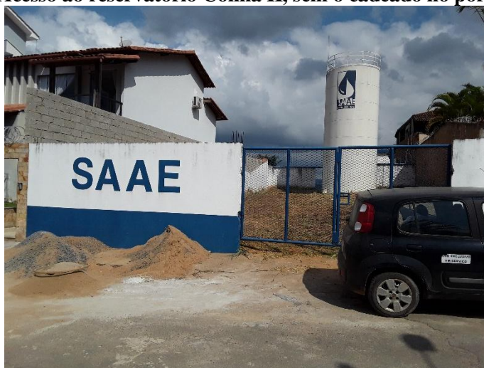
Figura 70 – Acesso ao reservatório Colina II, sem o cadeado no portão de acesso.
