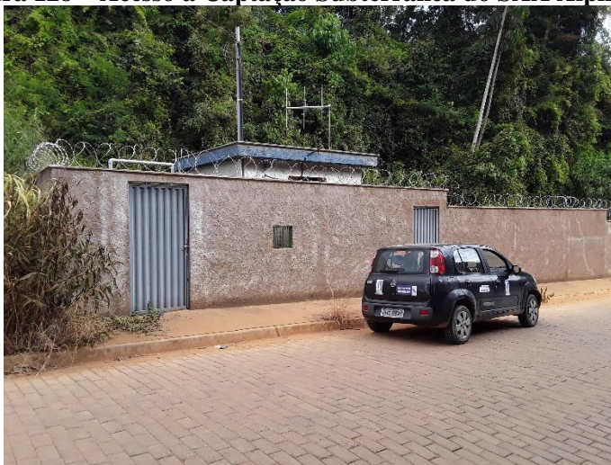
Figura 128 – Acesso à Captação Subterrânea do SAA Alphaville
