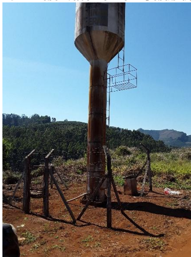
Figura 325 – Reservatório Bom Jesus da Realeza
