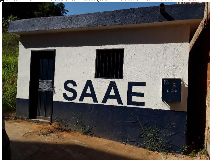
Figura 113 – Acesso à Estação Elevatória Recanto da Aldeia
