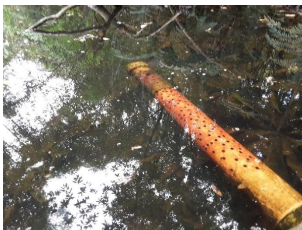
Figura 260 – Sistema para retenção de folhas e sólidos grosseiros
