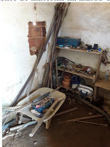
Figura 152 – Armazenamento de matérias na EEAT do Distrito de Dom Corrêa.
