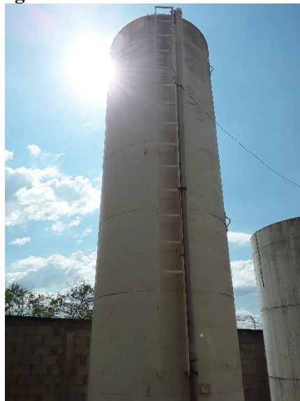
Figura 58 – Reservatório Matinha II
