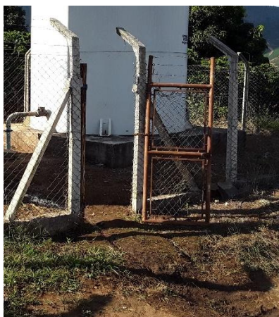
Figura 256 – Portão de acesso a área do reservatório
