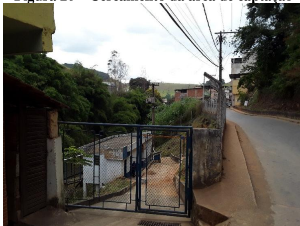
Figura 20 – Cercamento da área de captação
