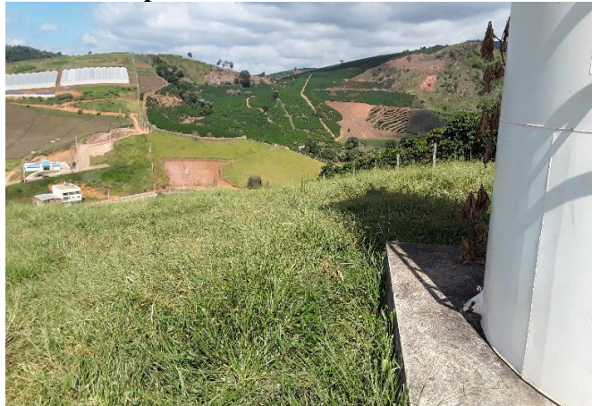
Figura 157 – Ausência de cercamento e sinalização no entorno do reservatório Nossa Senhora Aparecida no Distrito de Dom Corrêa.
