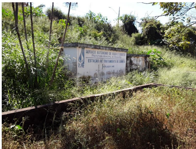
Figura 338 – Área da ETE - Realeza
