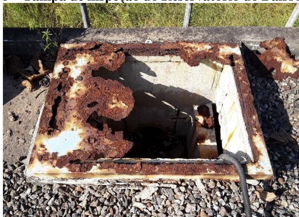
Figura 46 – Tapa de inspeção do Reservatório do Bairro Lajinha.
