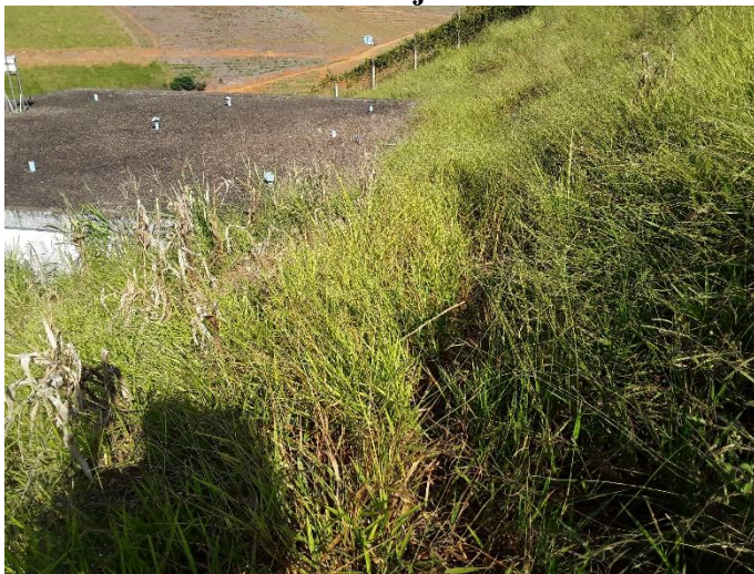
Figura 48 – Área de acesso ao reservatório do Bairro Lajinha.
