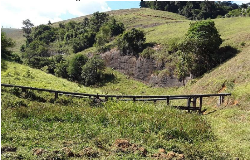
Figura 12 – Adutora de Água Bruta da Captação no Córrego Manhuaçuinho
