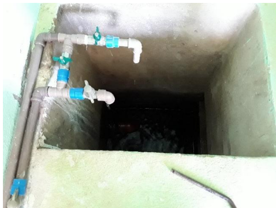
Figura 214 – Tanque de contato sem tampa
