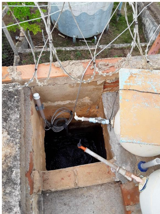
Figura 268 – Tapa de inspeção do tanque de contato
