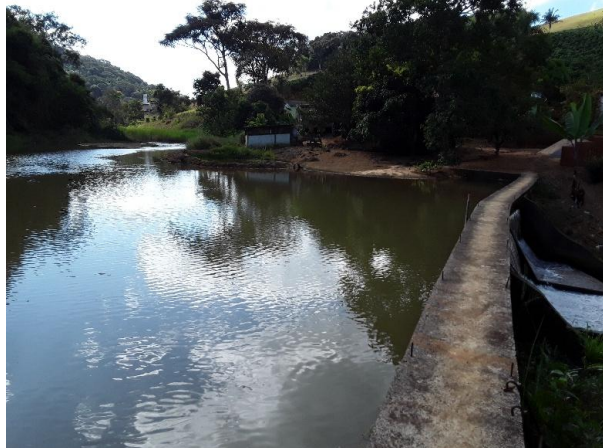
Figura 14 – Condições do entorno do ponto de captação no Córrego São Sebastião
