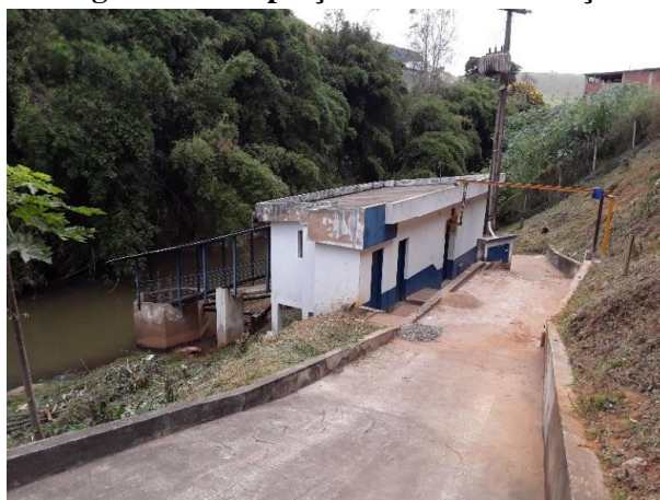
Figura 15 – Captação no Rio Manhuaçu
