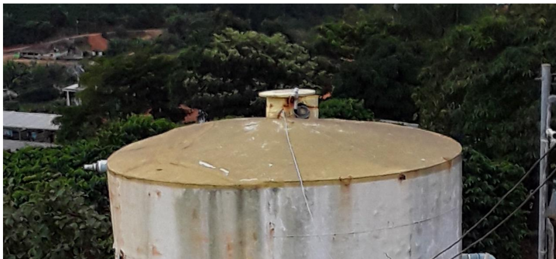
Figura 278 – Tampa de inspeção do reservatório
