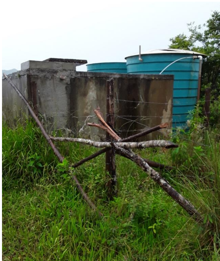
Figura 256 – Reservatório fora de uso
