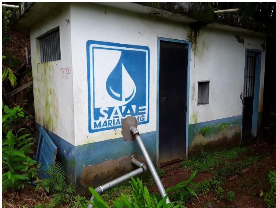
Figura 78 – Área da captação subterrânea Bucão
