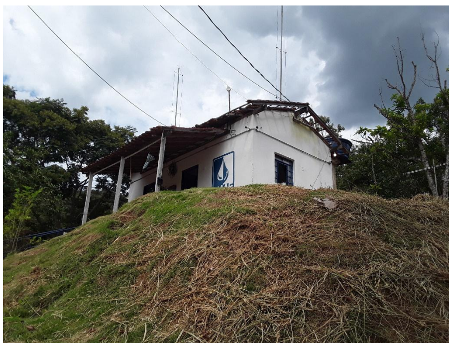
Figura 173 – Casa de química – ETA Santa Rita de Cássia
