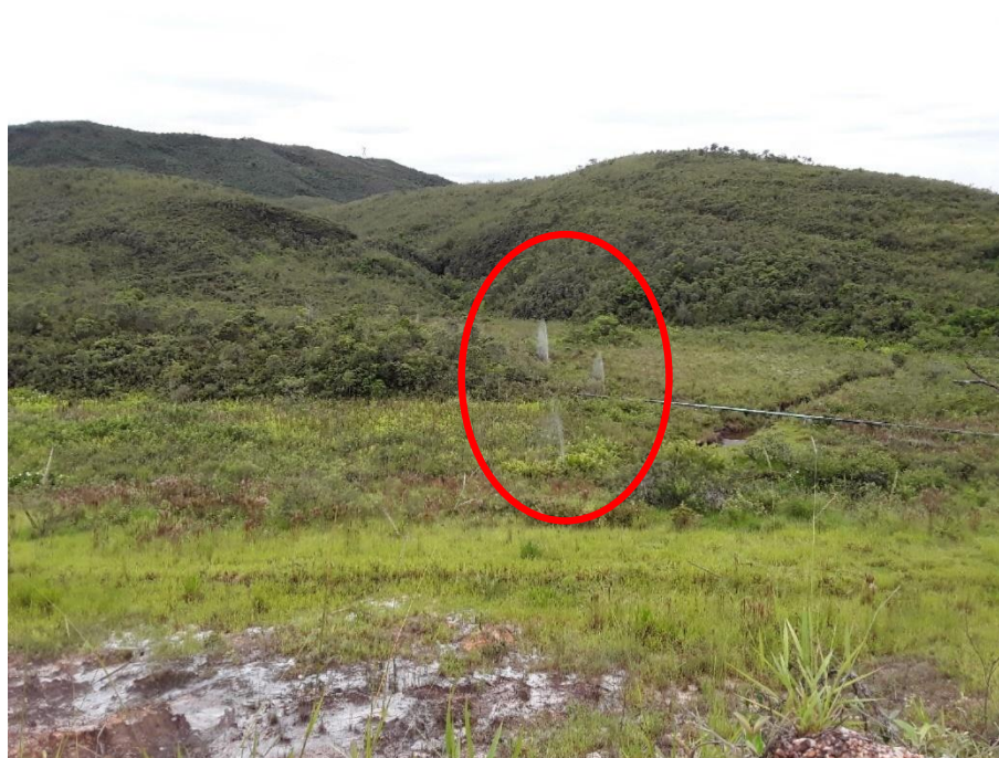
Figura 61 – Ventosas nas adutoras
