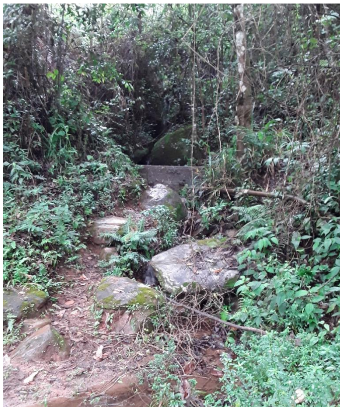
Figura 48 – Captação superficial Dulico
