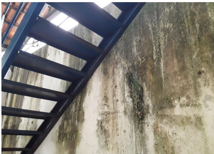
Figura 98 – Lateral da estrutura da ETA
