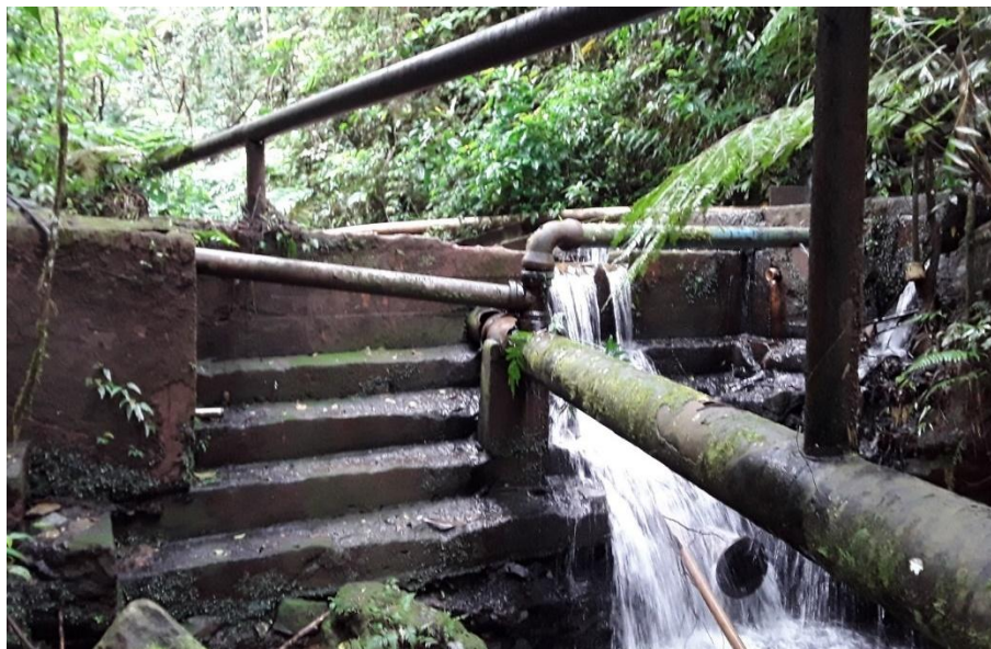
Figura 55 – Área da barragem da captação
