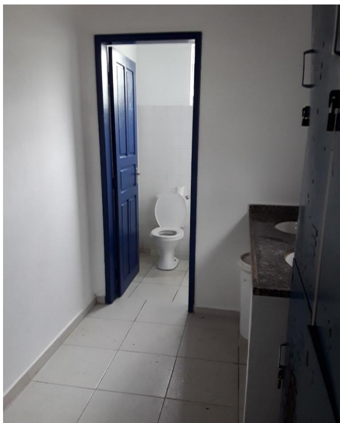
Figura 101 – Banheiro – ETA Sul
