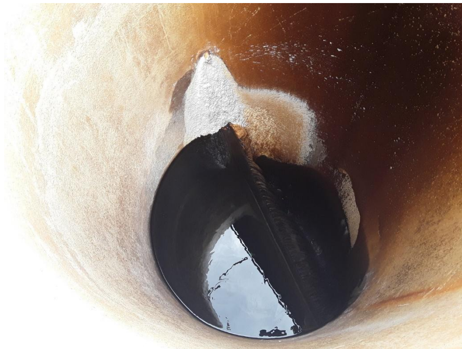
Figura 131 – Filtro sendo lavado – ETA Seminário
