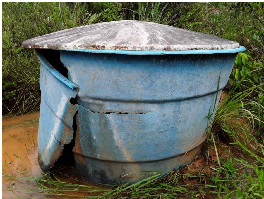
Figura 231 – Caixa abandonada próximo à captação
