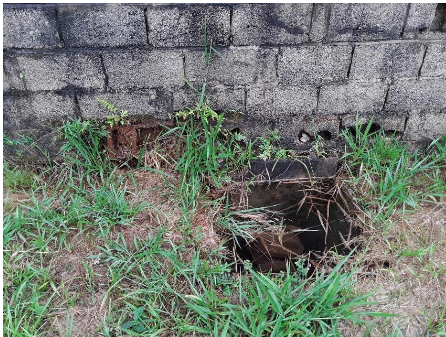
Figura 267 – Vazamento crítico 2
