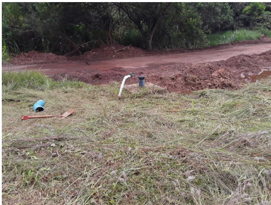
Figura 123 – Área da ETA Seminário sem cercamento
