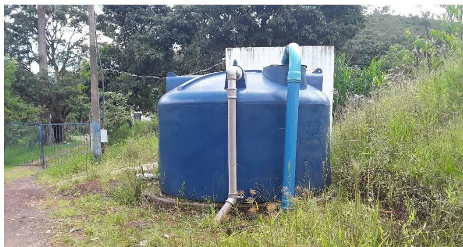
Figura 200 – Reservatório – ETA Matadouro
