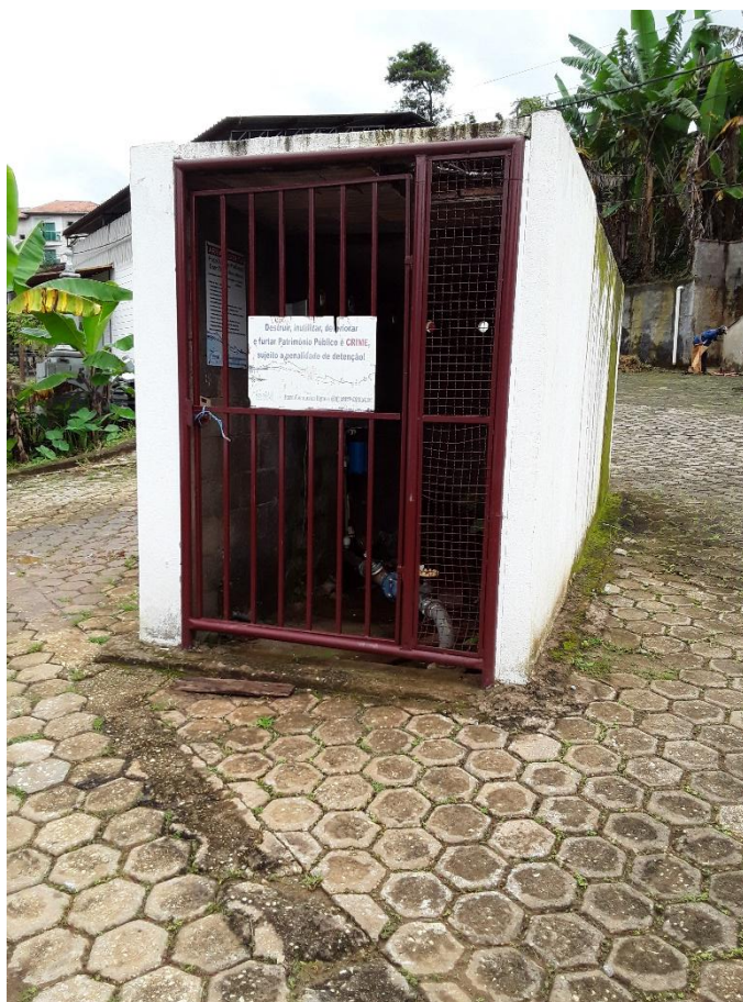
Figura 74 – Área da Captação
