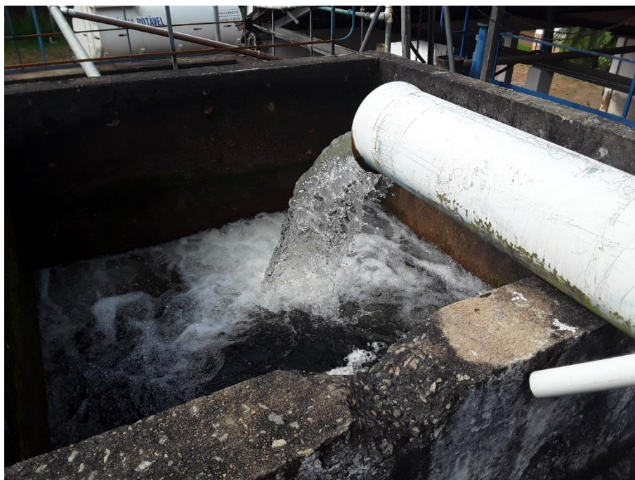
Figura 90 – Caixa de passagem para os floculadores
