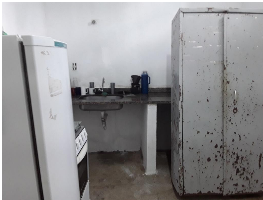
Figura 100 – Cozinha – ETA Sul
