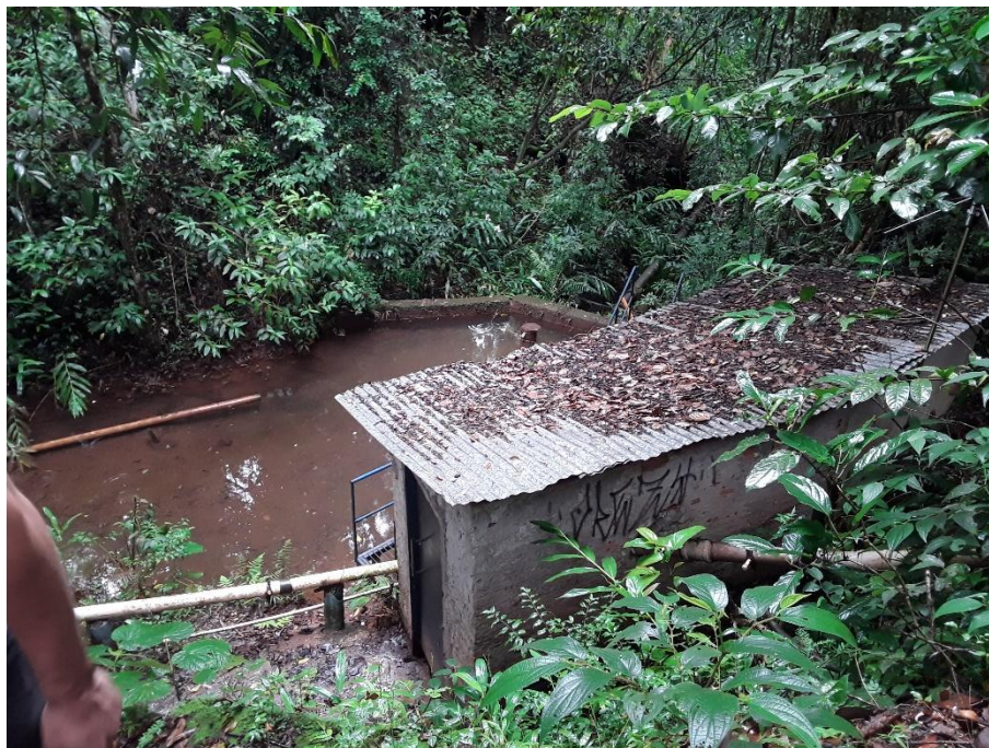
Figura 72 – Área da captação
