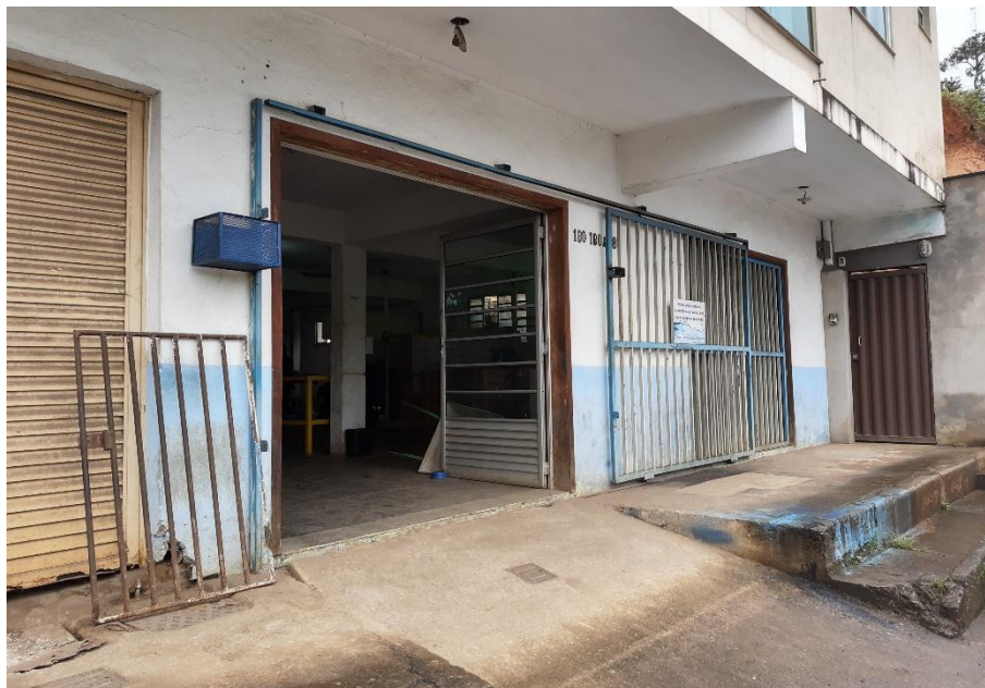
Figura 213 – Fachada do setor de eletromecânica
