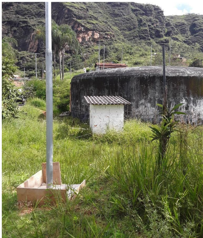
Figura 170 - Área da ETA Santa Rita de Cássia - 2
