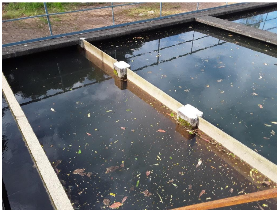
Figura 93 - Decantador
