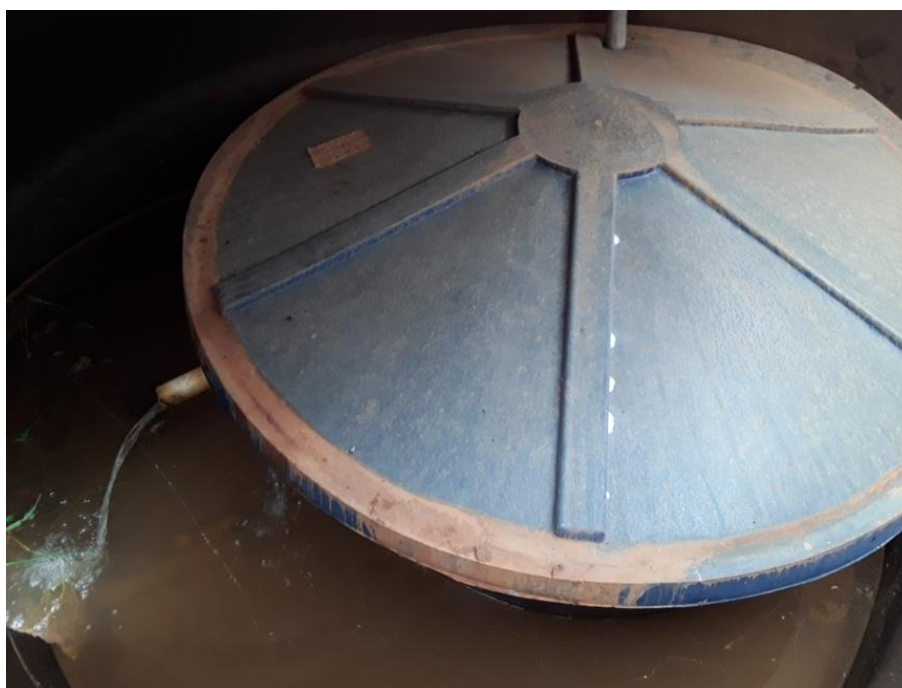
Figura 232 – Caixa no interior da caixa maior
