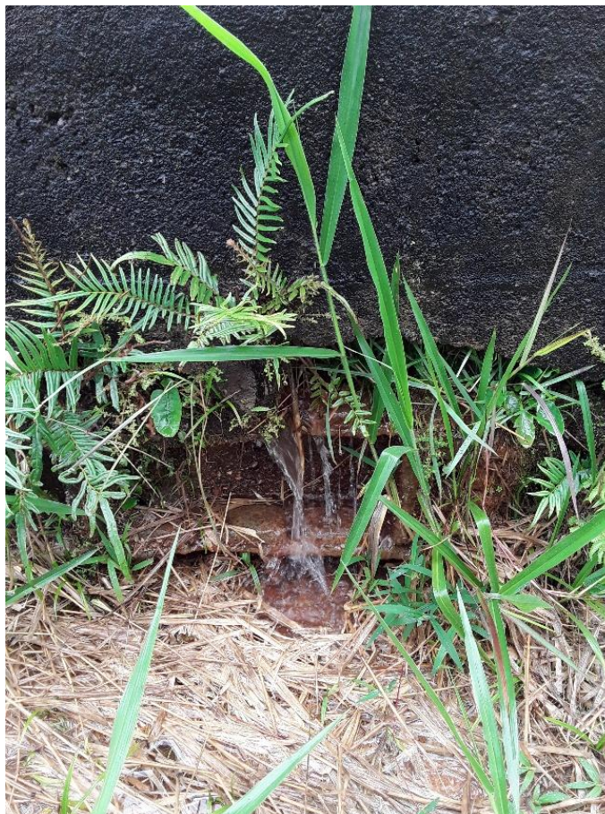
Figura 269 – Vazamento crítico 4
