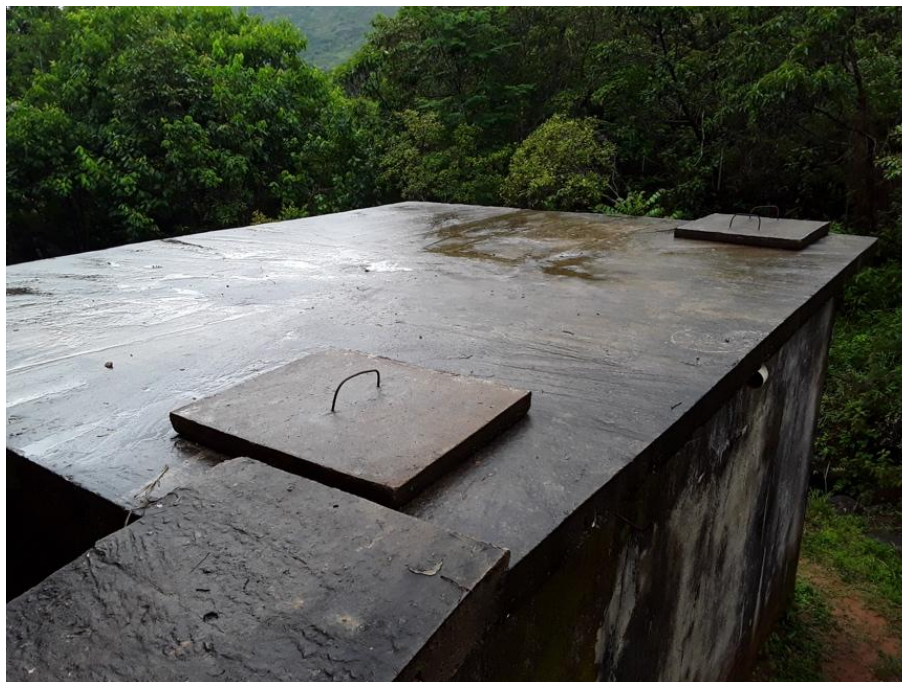
Figura 241 – Tampas de inspeção do reservatório 2
