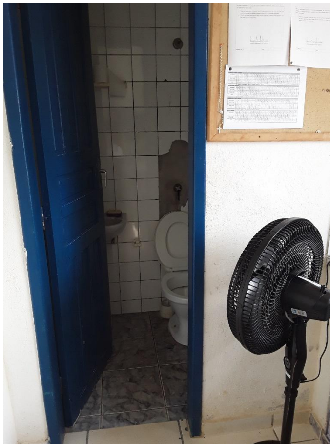
Figura 185 – Acesso ao banheiro - ETA Santa Rita de Cássia
