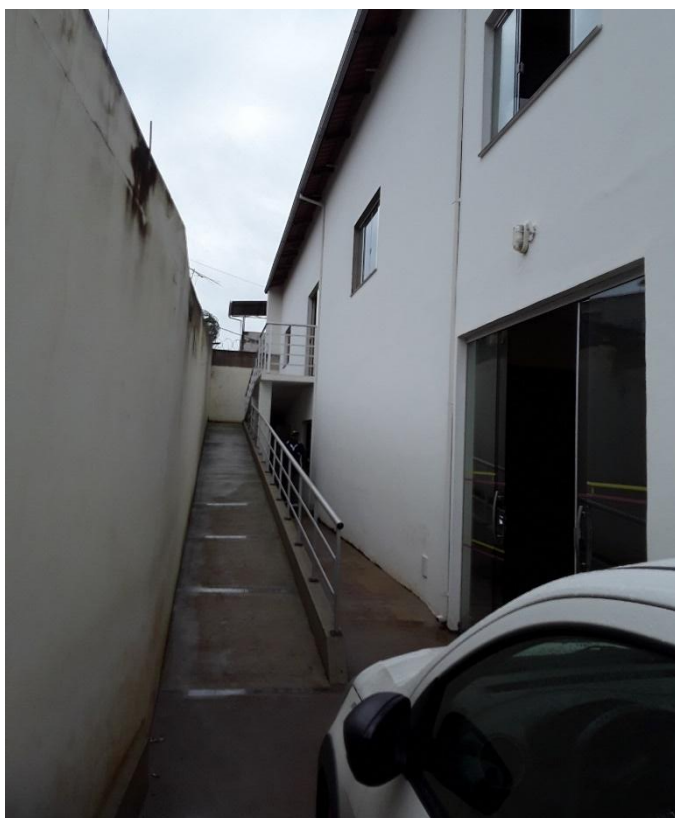
Figura 4 – Rampa de acesso ao prédio administrativo do SAAE
