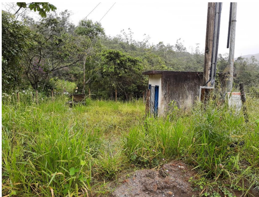
Figura 80 – Área da captação subterrânea Jardim Santana
