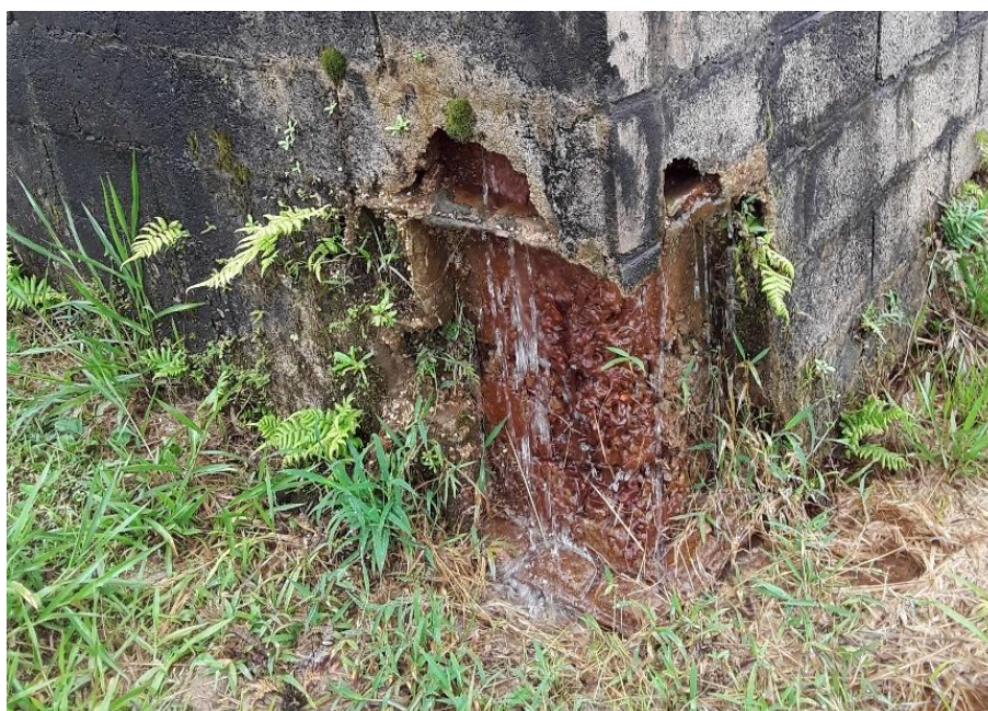
Figura 266 – Vazamento crítico 1
