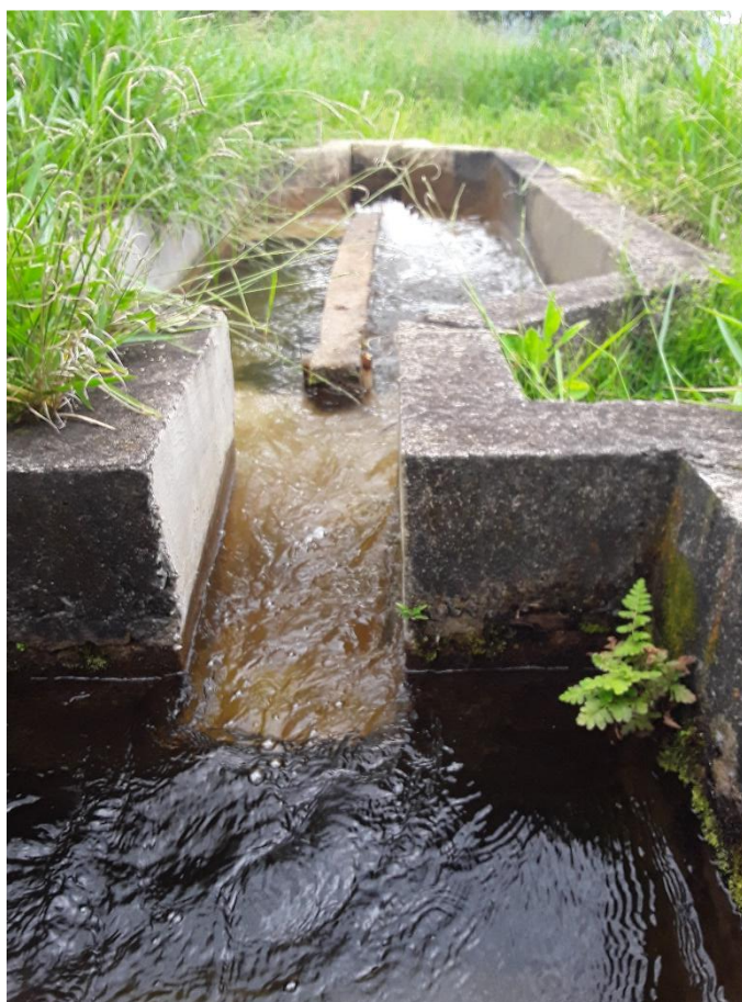
Figura 153 – Chegada da água bruta – ETA Santa Rita de Cássia
