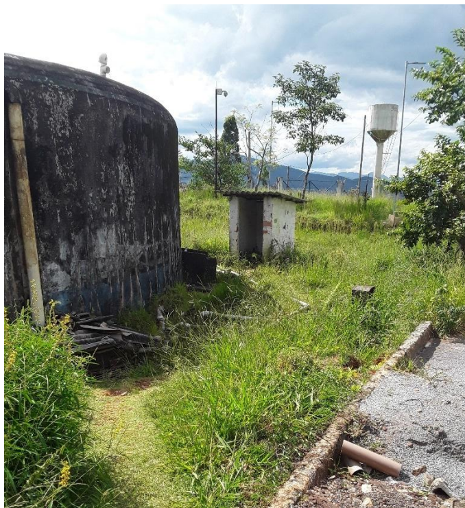
Figura 169 – Área da ETA Santa Rita de Cássia – 1
