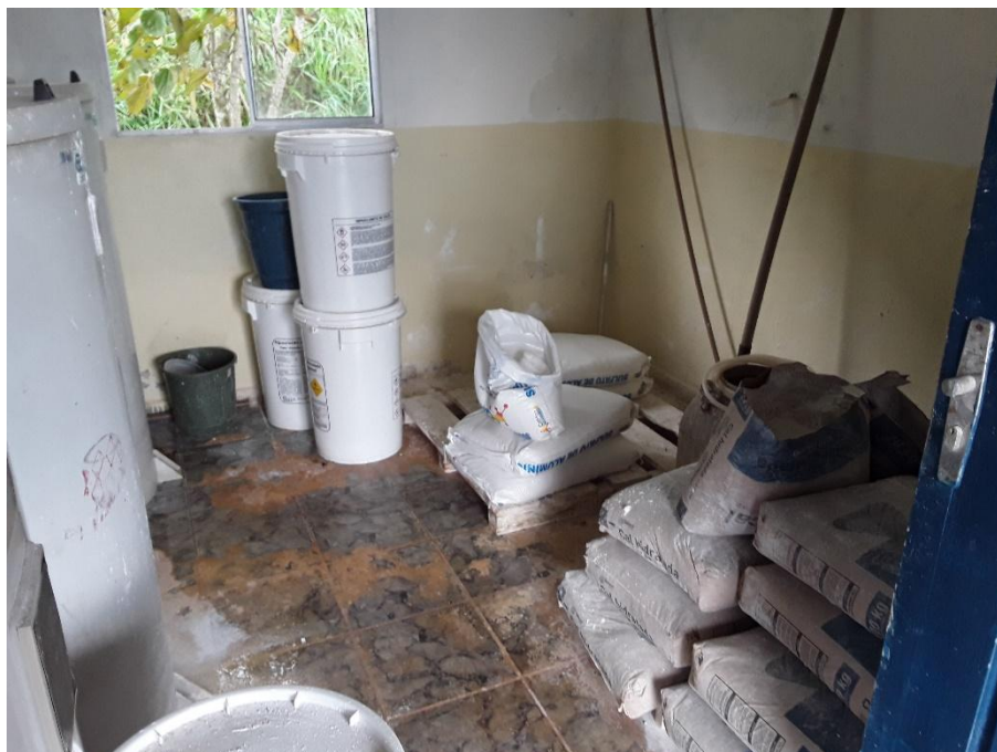
Figura 175 – Área de armazenamento dos produtos químicos
