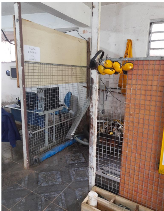
Figura 220 – Entrada da área de solda e corte
