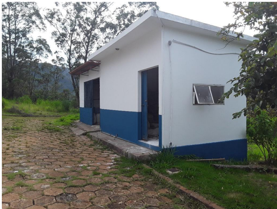
Figura 107 - Depósito de produtos químicos - Secos
