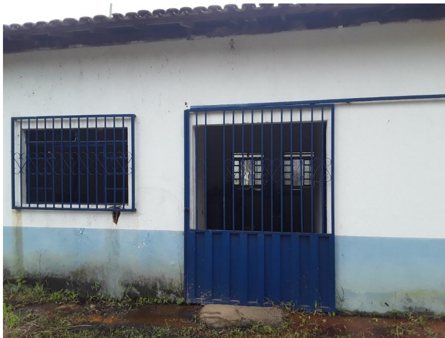
Figura 134 – Casa de bomba – ETA Seminário
