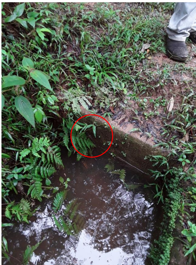
Figura 245 – Captação secundária de Zeca Barbosa
