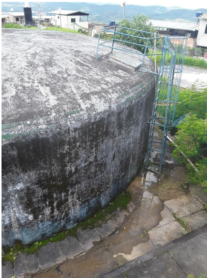
Figura 164 – Escada e guarda – corpo – ETA Santa Rita de Cássia
