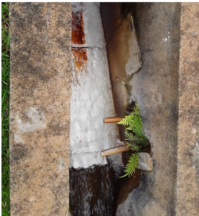
Figura 155 – Adição do Coagulante – ETA Santa Rita de Cássia
