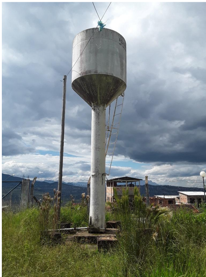
Figura 168 – Reservatório elevado – ETA Santa Rita de Cássia
