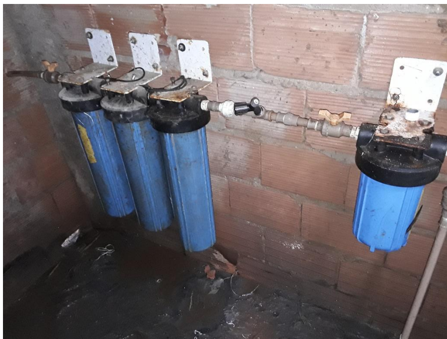
Figura 65 – Dosadores de Cloro pastilha - Captação Del Rey
