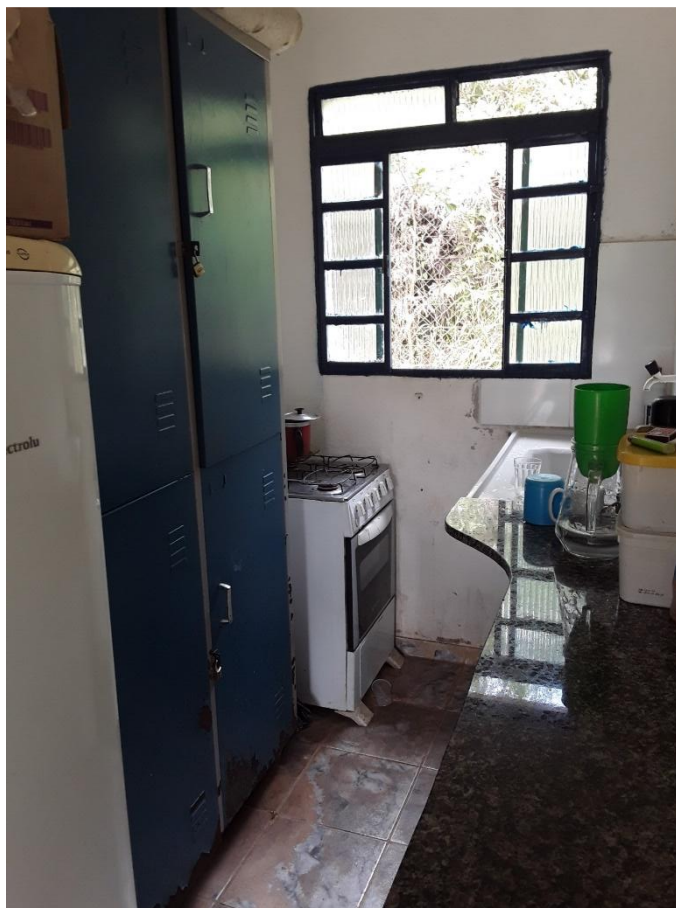
Figura 150 – Cozinha – ETA Seminário
