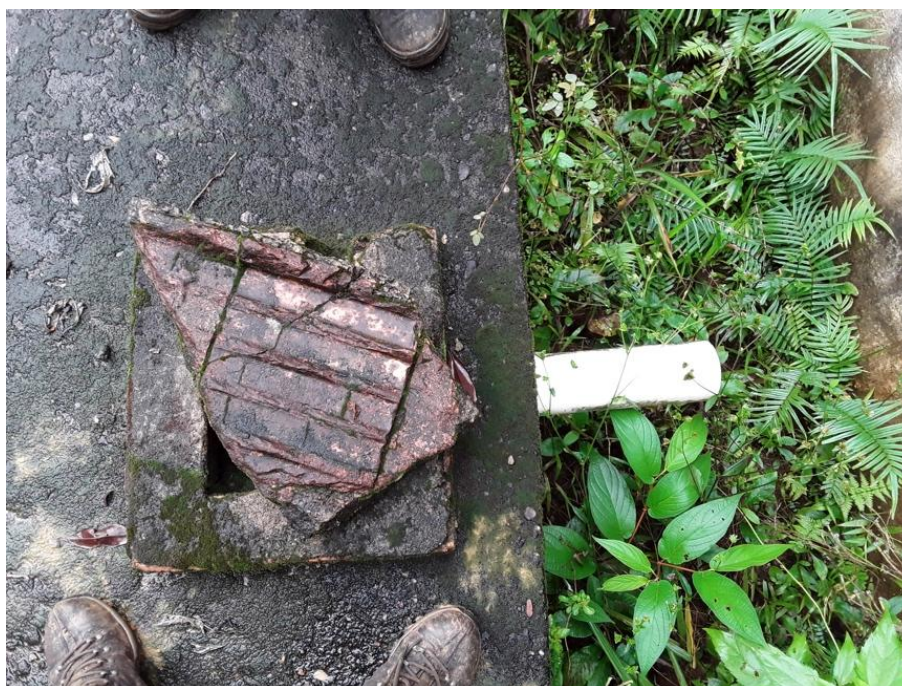
Figura 242 – Tampa de inspeção do reservatório 3
