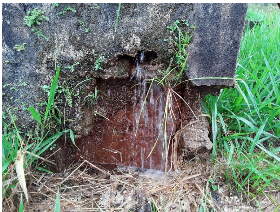
Figura 268 – Vazamento crítico 3
