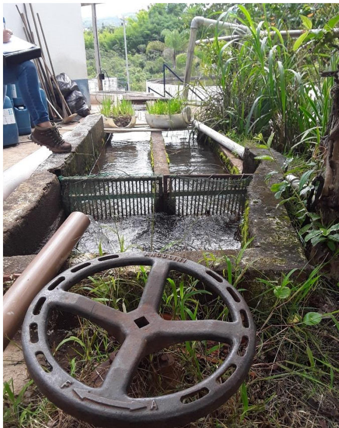
Figura 125 - Gradeamento na chegada da água bruta
