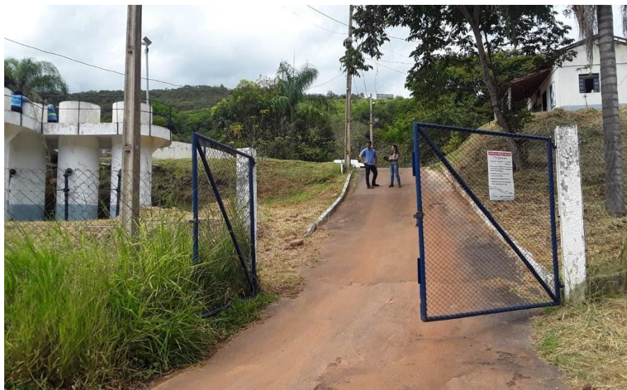
Figura 121 – Entrada da ETA Seminário
