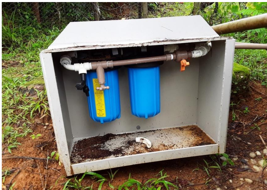
Figura 234 – Clorador Barreira
