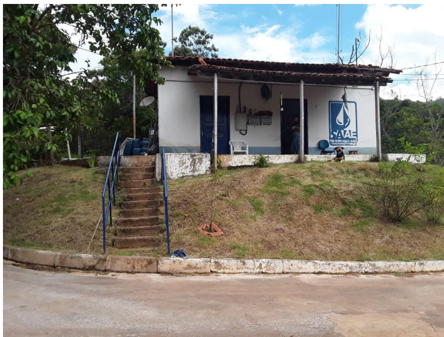
Figura 140 – Área de laboratório e preparo dos produtos químicos – ETA Seminário
