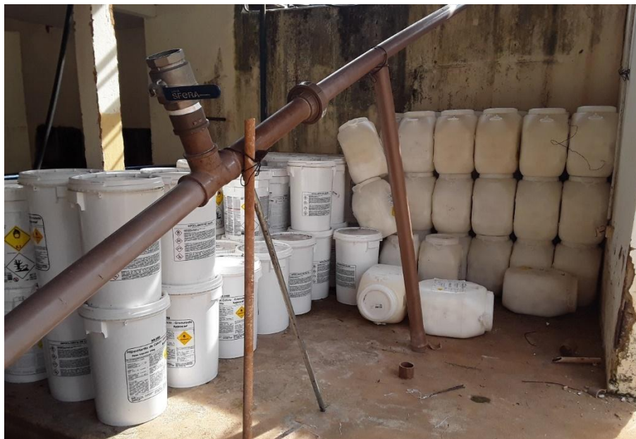
Figura 110 – armazenamento do hipoclorito de cálcio
