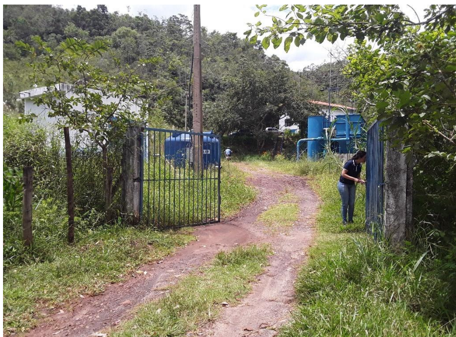
Figura 190 – Entrada da ETA Matadouro
