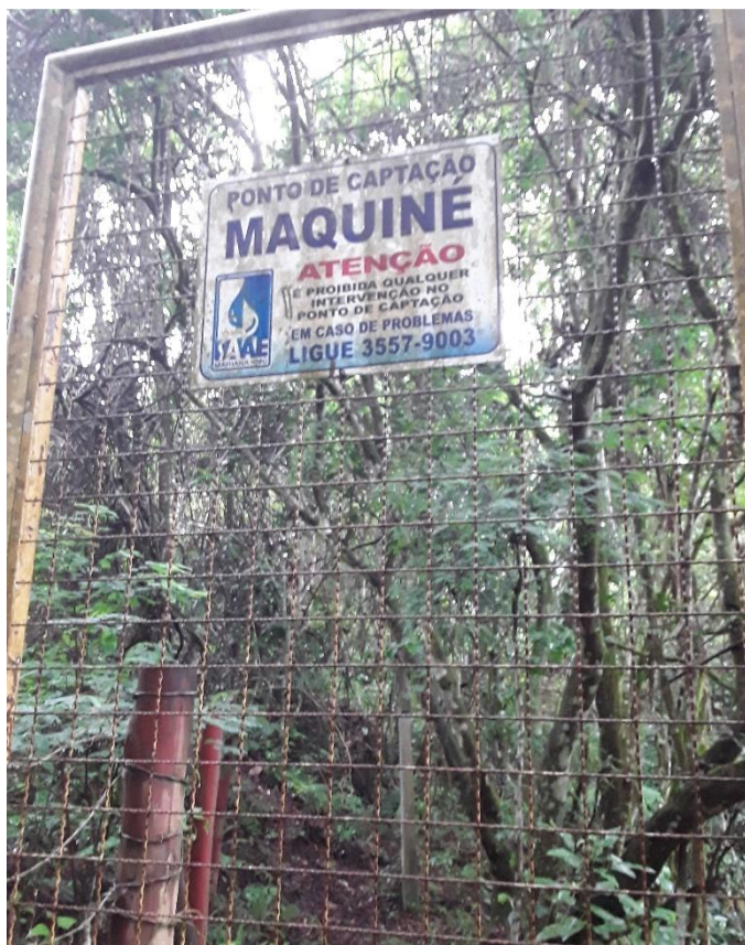
Figura 70 – Portão de acesso a Captação Maquiné
