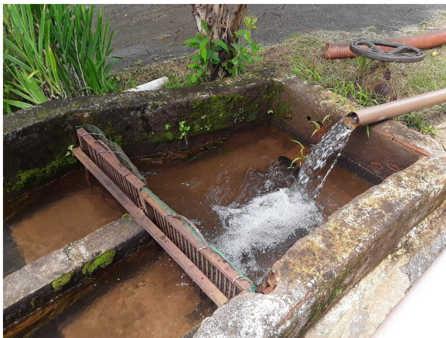
Figura 124 – Chegada da água bruta – ETA Seminário
