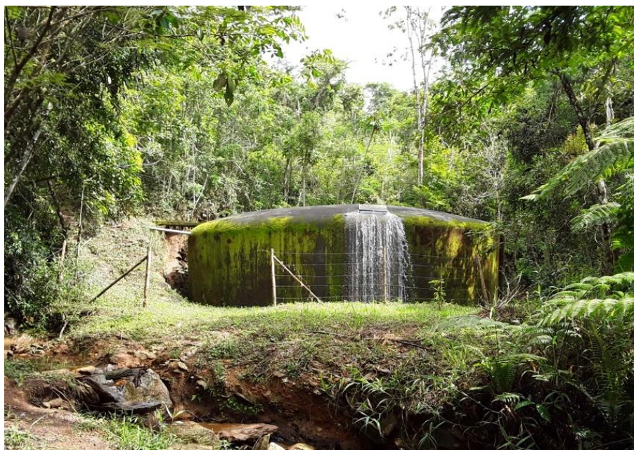
Figura 227 – Reservatório de Bandeirantes
