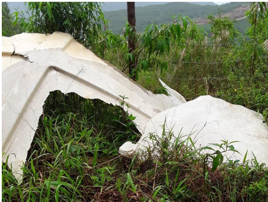
Figura 255 – Cobertura de um dos reservatórios
