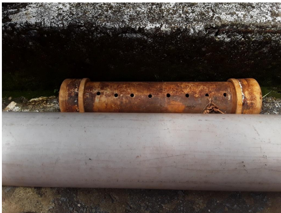
Figura 126 – Sistema utilizado para a pré-cloração
