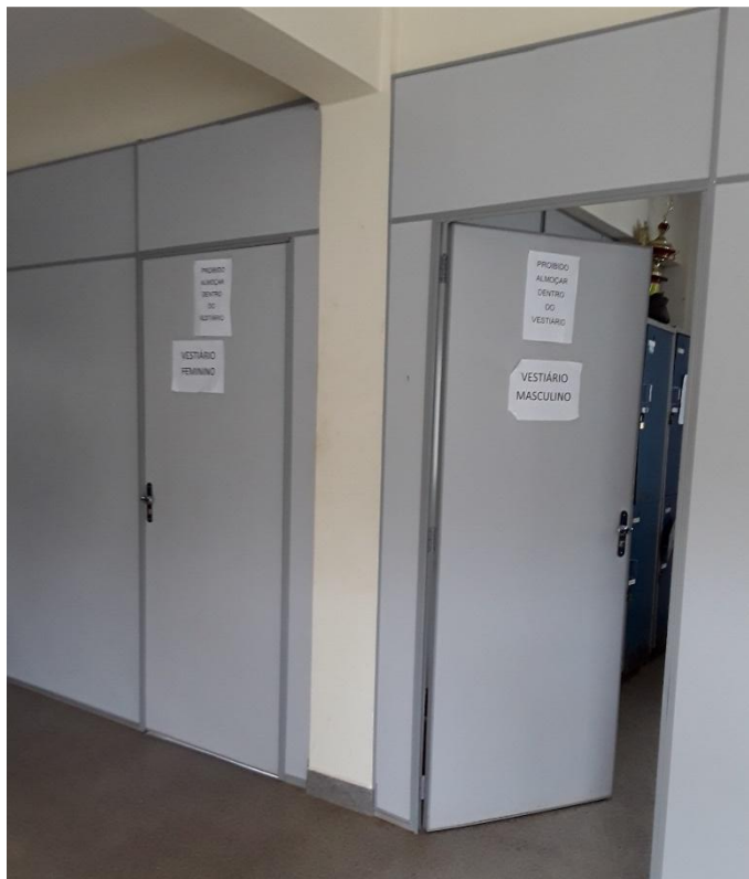
Figura 8 – Porta de acesso aos vestiários
