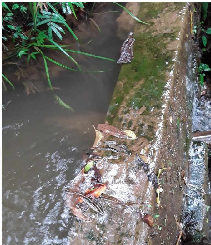
Figura 50 – Barragem da captação Dulico
