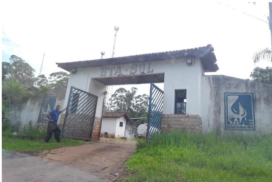
Figura 85 – Portão de acesso a ETA Sul
