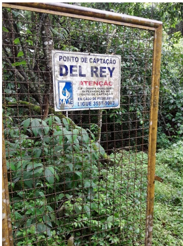
Figura 63 – Acesso a captação Del Rey
