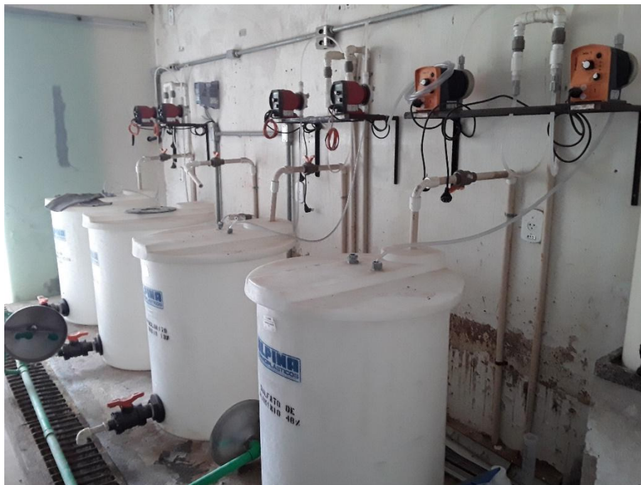
Figura 112 – Bombas dosadoras
