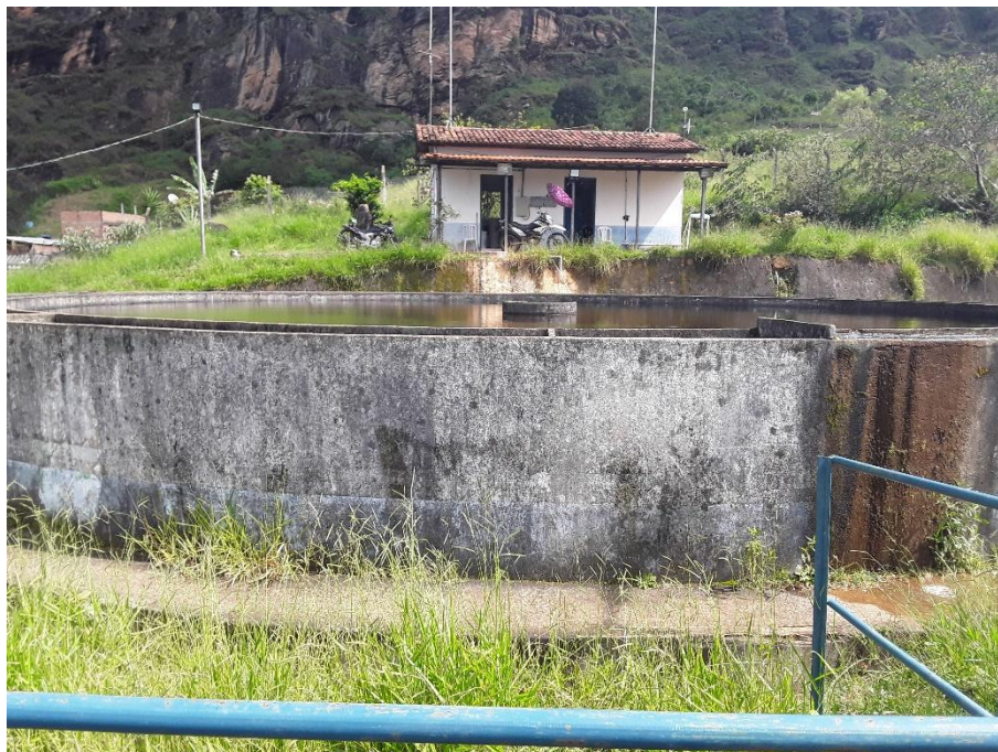
Figura 158 – Vista lateral do decantador – ETA Santa Rita de Cássia
