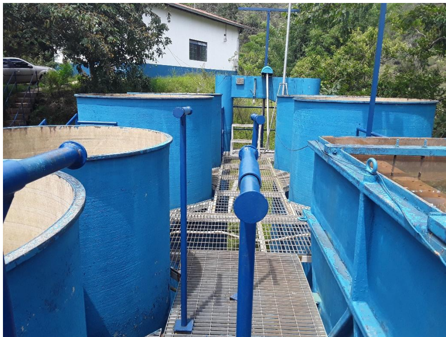
Figura 198 – Área da ETA Matadouro
