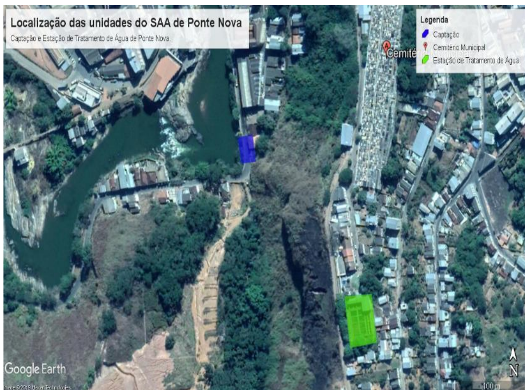
Figura 3 - Captação e Estação de Tratamento de Água
