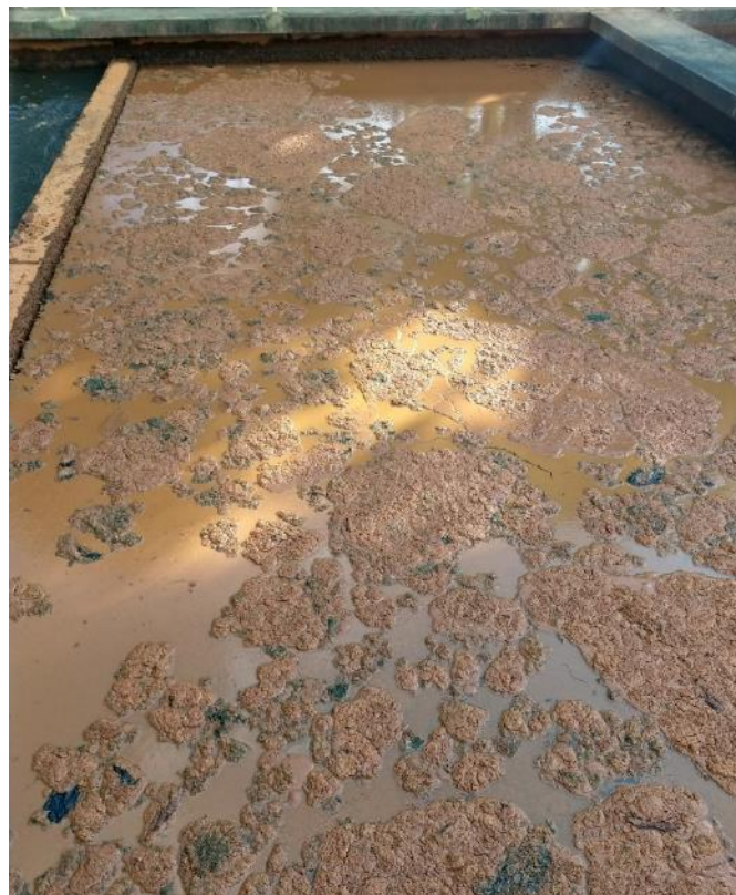
Figura 23 – Água presente no decantador da ETA de Ponte Nova com a presença de lodo.
