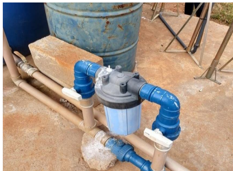
Figura 60 – Dosador de cloro no SAA do Distrito de Santa Helena
