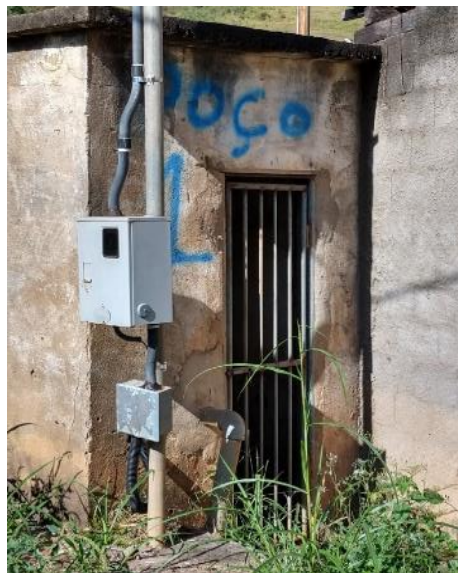
Figura 32 – Estrutura que abriga o Poço 1 - Pontal
