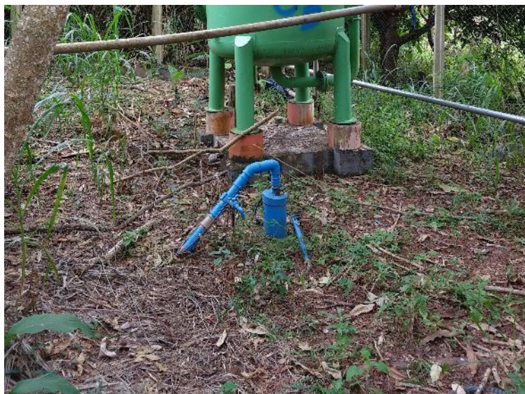
Figura 50 – Poço tubular
