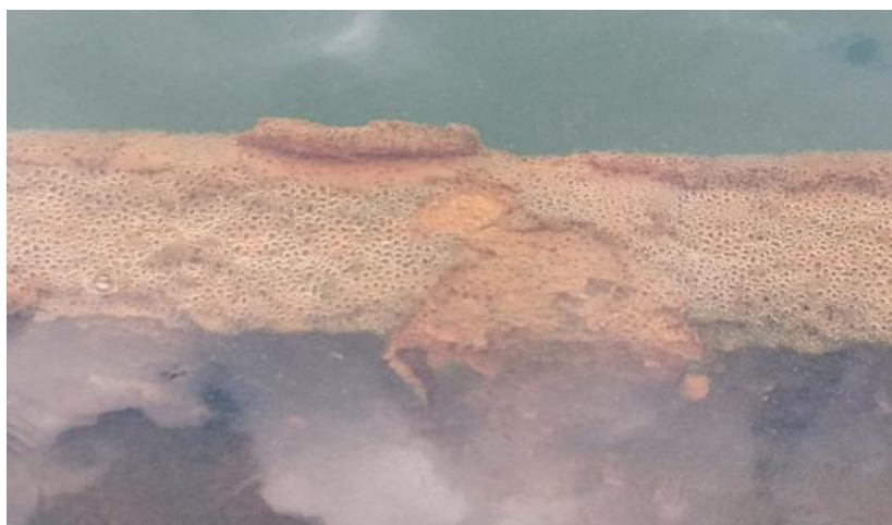
Figura 25 – Limo presente na unidade de filtração da ETA de Ponte Nova
