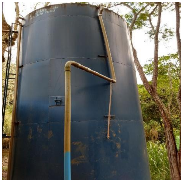
Figura 53 – Tampa de inspeção sem cadeado
