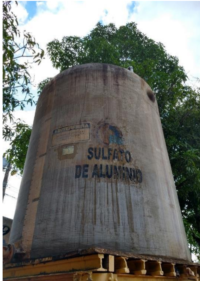
Figura 31 - Reservatório de Sulfato de Alumínio – ETA Sede
