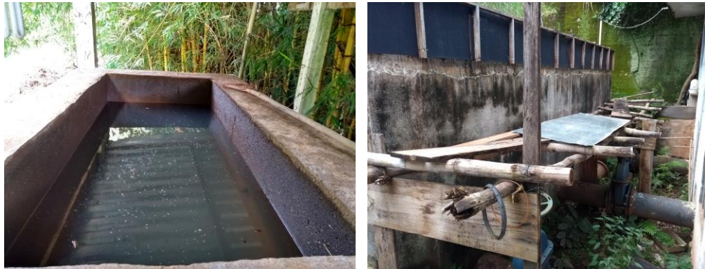
Figuras 42 e 43 – Gradeamento e ponto de sucção da bomba.
