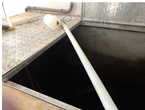
Figuras 212 e 215 – Local de dosagem do ortopolifosfato e do cloro. Destaque para o ponto de coleta na última figura, que permanece fechado.
