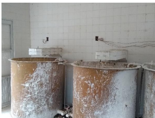
Figuras 122 a 124 – Locais onde funcionavam a calha Parschall, o banheiro da ETA e o preparo de produtos químicos.
