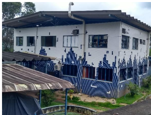
Figura 150 – Visão do prédio onde funciona o laboratório de análises físico-químicas e demais salas.
