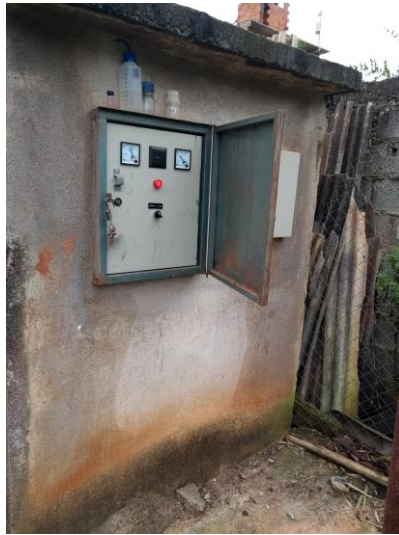
Figuras 80 e 81 – Quadro de comando e reservatório de distribuição no bairro Sol Nascente.
