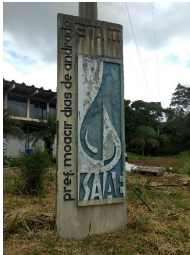
Figura 188 – Identificação da ETA.
