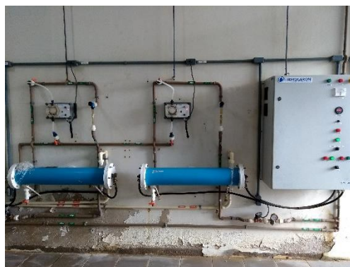
Figuras 202 e 203 – Preparo da solução salina e eletrólise do sal.
