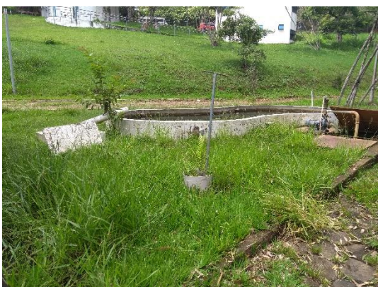
Figuras 96 a 98 – Área externa (filtros).
