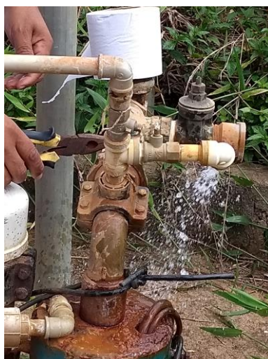
Figura 64 – Detalhe do poço sem os registros.
