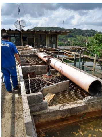
Figuras 174 e 175 – Decantadores e flocladores.
