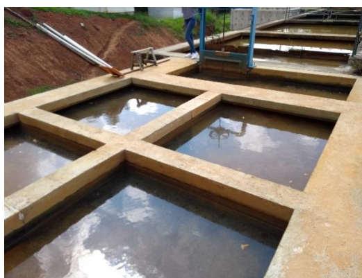
Figuras 174 e 175 – Decantadores e flocladores.
