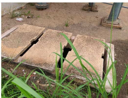
Figura 99 – Área externa (filtros).
