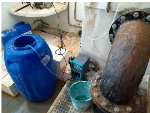
Figuras 212 e 215 – Local de dosagem do ortopolifosfato e do cloro. Destaque para o ponto de coleta na última figura, que permanece fechado.
