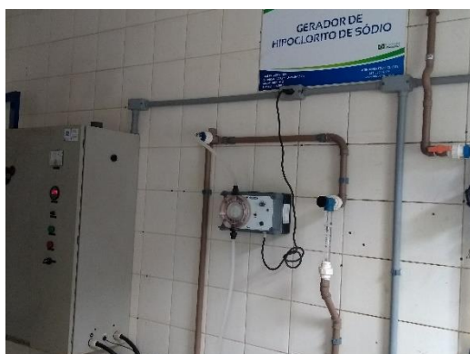
Figuras 143 e 144 – Eletrólise do sal e preparo da solução salina.
