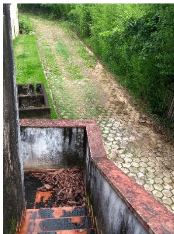
Figura 92 – Acesso ao decantador.
