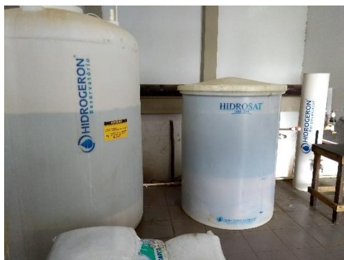
Figuras 202 e 203 – Preparo da solução salina e eletrólise do sal.
