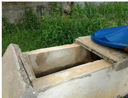
Figuras 182 a 184 – Tanque de contato.
