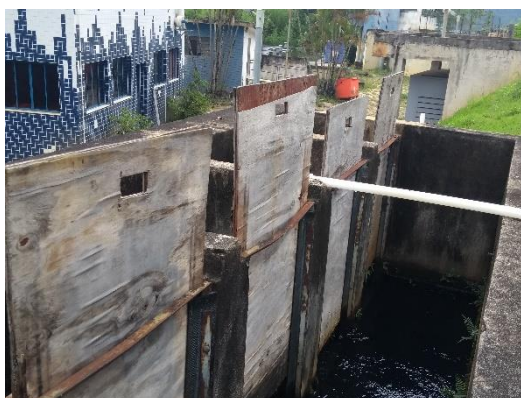
Figura 93 – Distribuição da água para os filtros.
