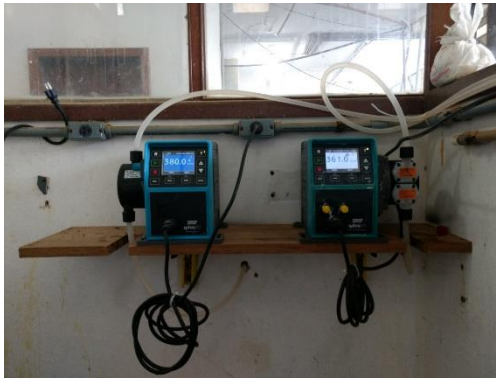
Figuras 210 e 211 – Bombas utilizadas para dosagem e envio do PAC para a calha Parschall e bombas reservas.
