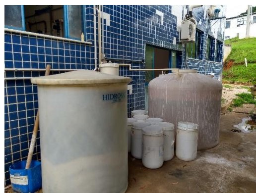
Figuras 143 e 144 – Eletrólise do sal e preparo da solução salina.
