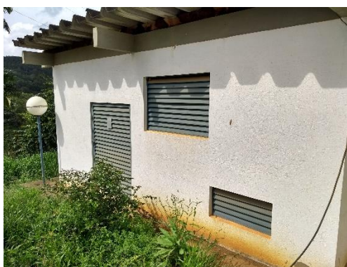
Figura 197 – Área de acesso exclusivo da CEMIG.
