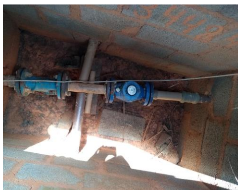
Figuras 21 e 22 – Visão geral e macromedidor da captação na comunidade Buieí.
