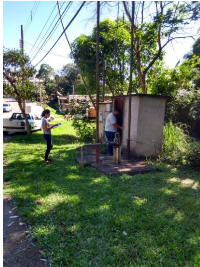
Figura 27 - Captação subterrânea no bairro Vila Alves.
