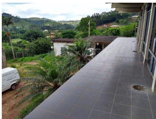
Figuras 178 e 179 – Ausência de guarda-corpos.
