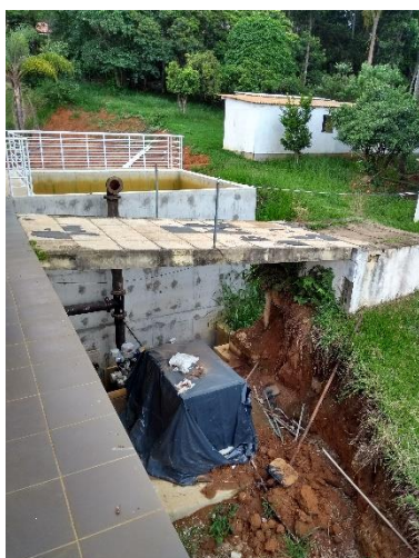
Figuras 178 e 179 – Ausência de guarda-corpos.
