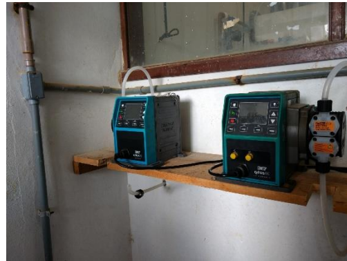
Figuras 210 e 211 – Bombas utilizadas para dosagem e envio do PAC para a calha Parschall e bombas reservas.
