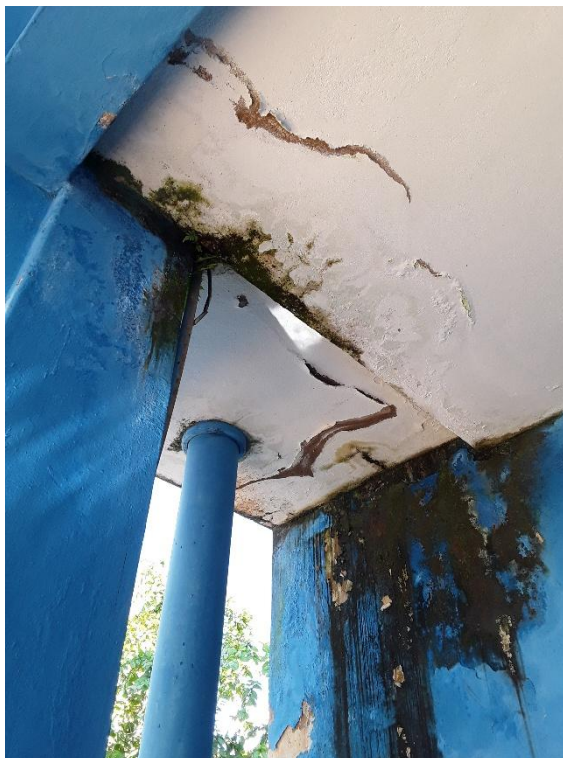
Figura 44 – Tubulação de saída da calha parshall para o flocculador
