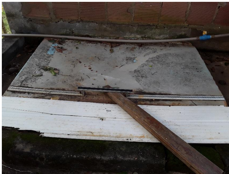
Figura 70 – Tampa de inspeção
