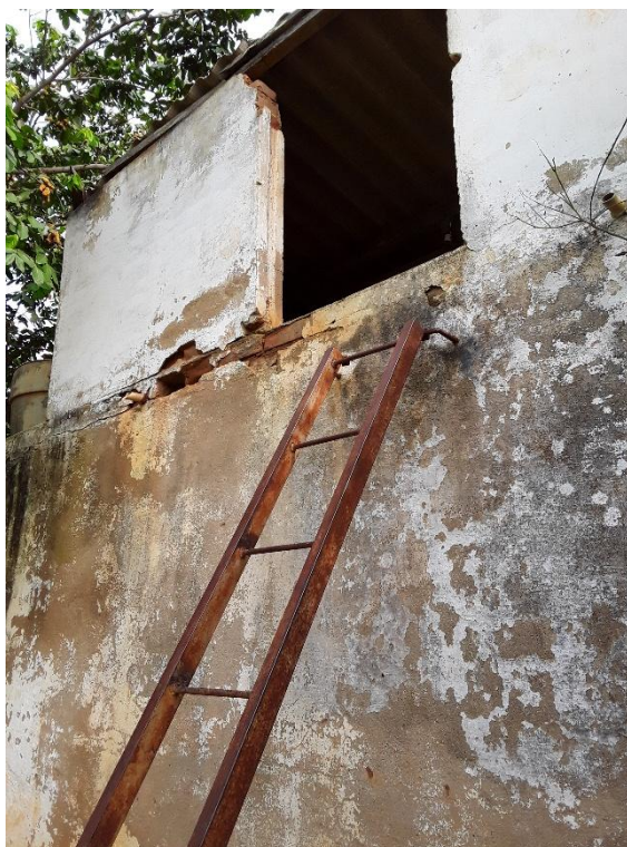
Figura 90 – Acesso ao tanque de contato
