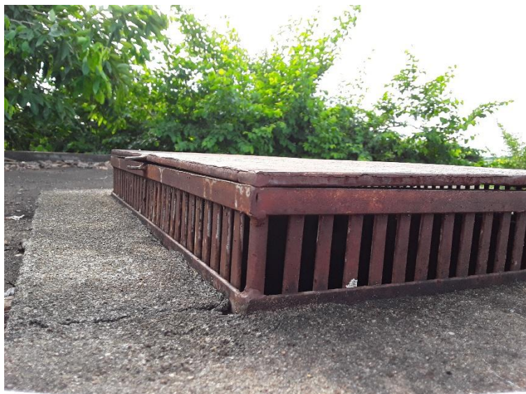
Figura 93 – Tampa de inspeção do reservatório
