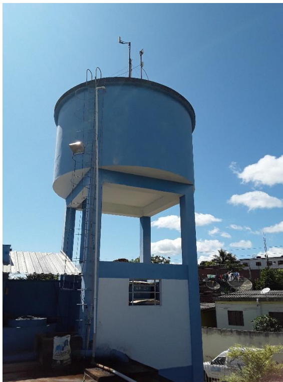
Figura 61 – Reservatório elevado da ETA
