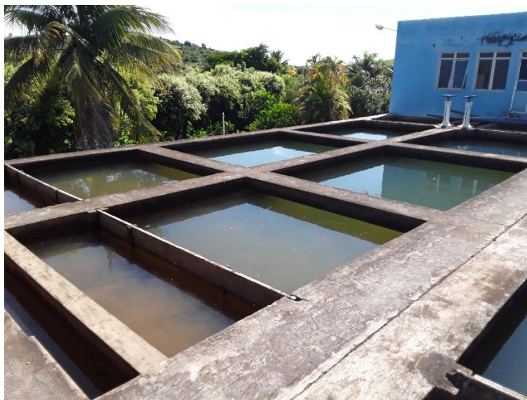
Figura 37 – Decantadores com fluxo de água da esquerda para direita
