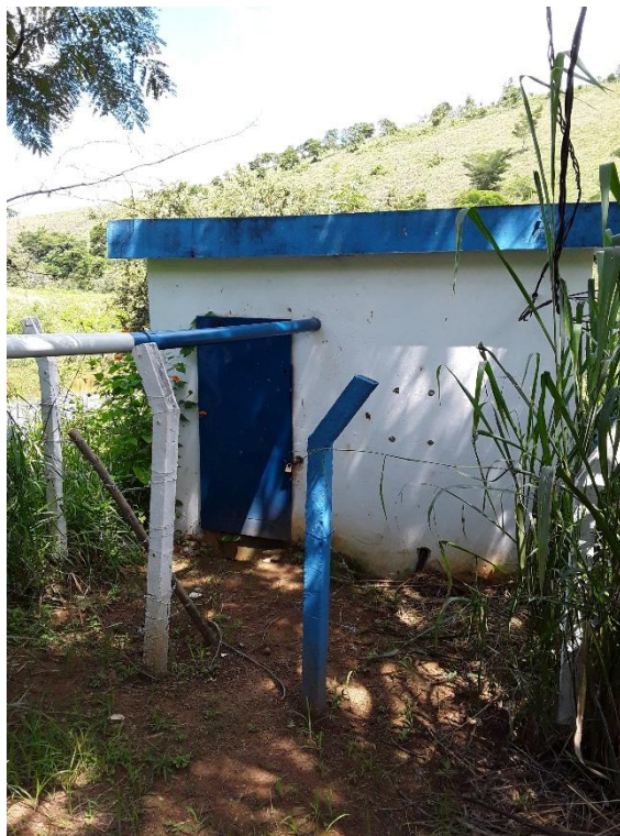
Figura 65 – Elevatória de água bruta
