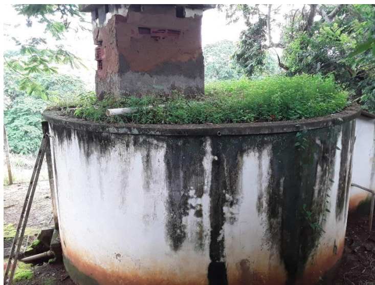
Figura 80 – Cobertura do reservatório com vegetação
