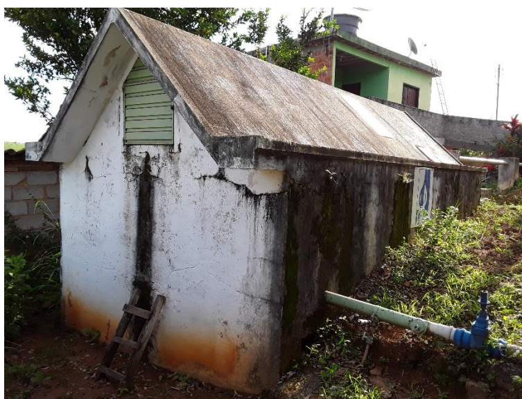
Figura 71 – Reservatório de água tratada
