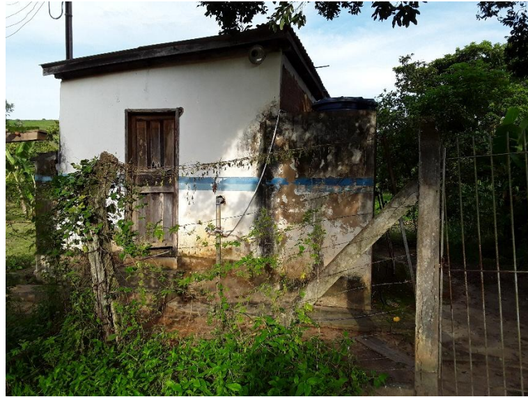
Figura 67 – Casa de bomba
