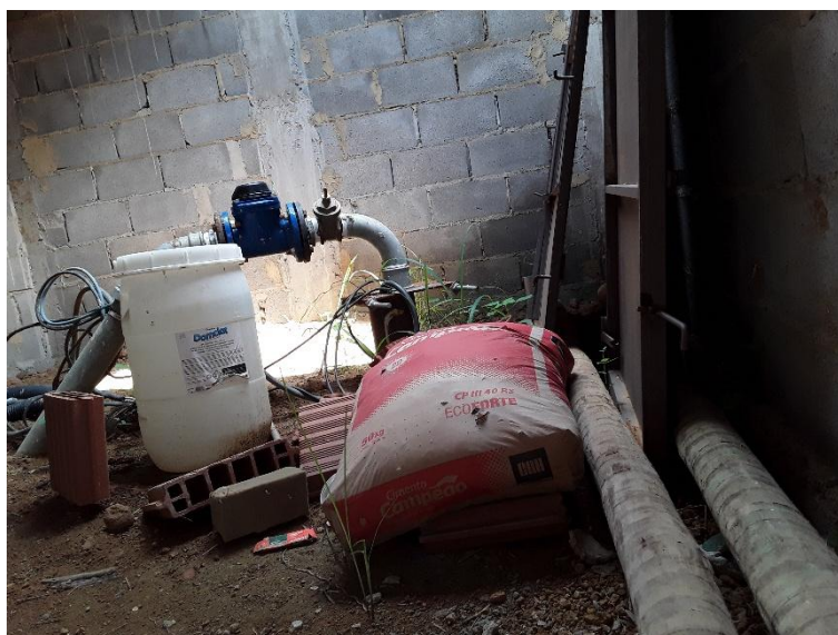
Figura 31 – Interior do local da captação subterrânea
