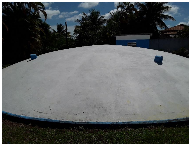
Figura 62 – Reservatório da ETA
