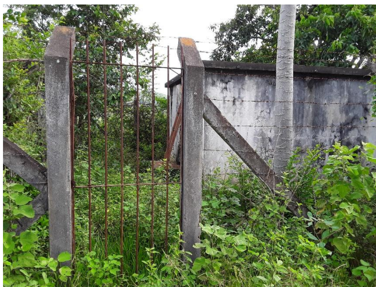
Figura 92 – Reservatório de Barreiros
