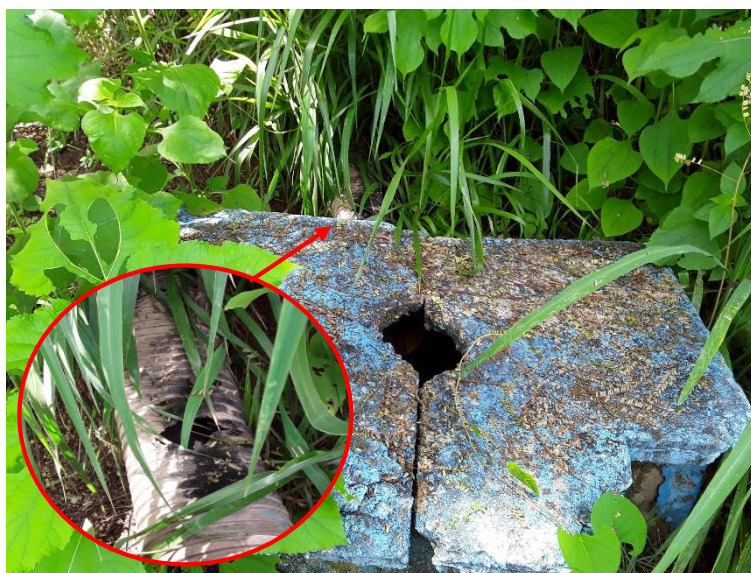
Figura 96 – Caixa coletora da ETE
