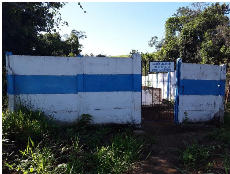
Figura 27 – Exterior da caixa de areia
