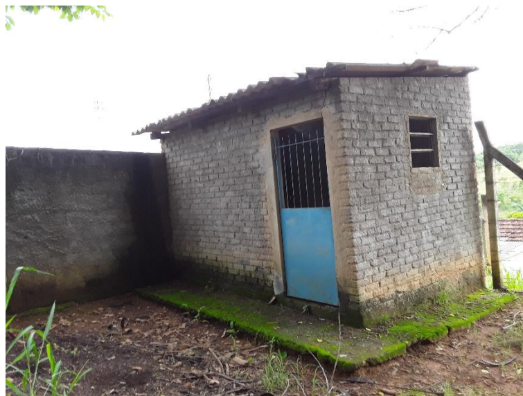
Figura 83 – Depósito na área do reservatório
