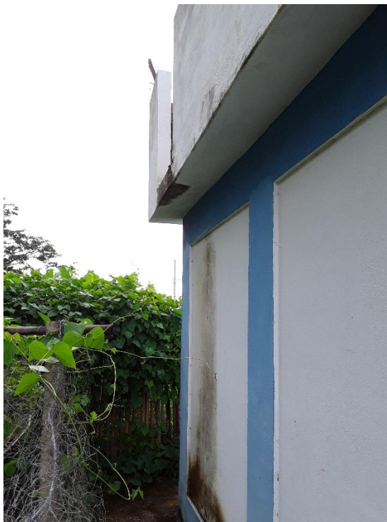
Figura 87 – Local de acesso ao clorador e ao reservatório
