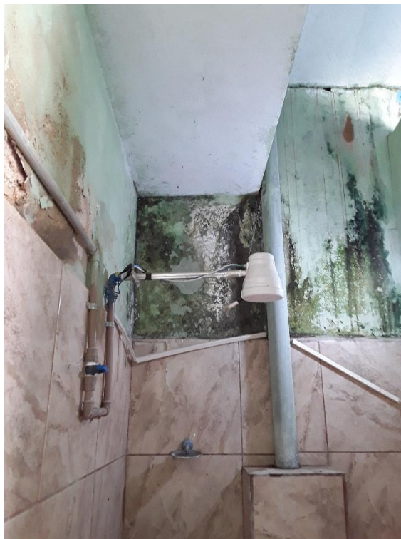
Figura 41 – Banheiro misto da ETA
