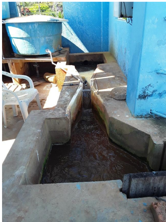
Figura 35 – Calha parshall
