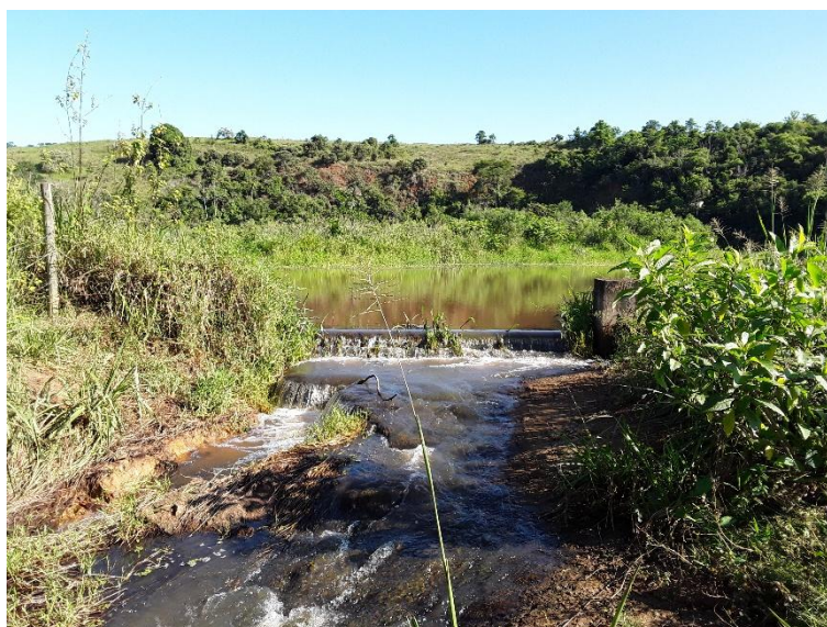
Figura 22 – Barragem de nível da captação
