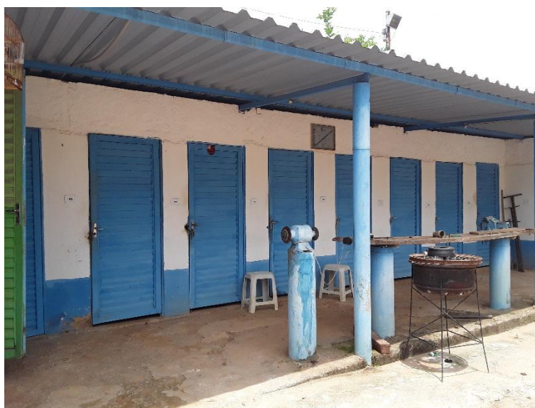
Figura 10 – Conjunto de salas utilizadas como almoxarifado e depósito
