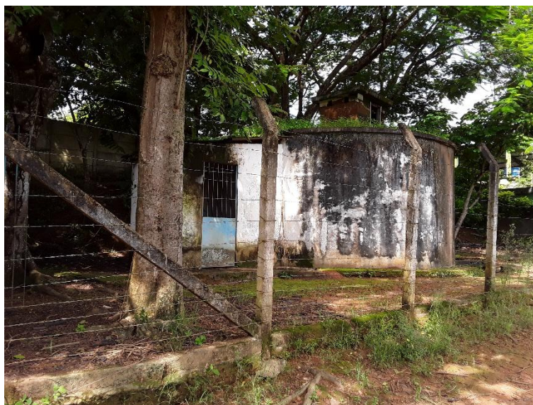
Figura 78 – Reservatório da escola
