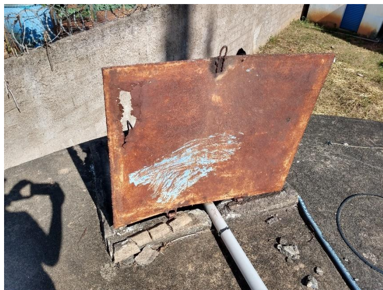
Figura 85 – Tampa de inspeção - Reservatório Bela Vista
