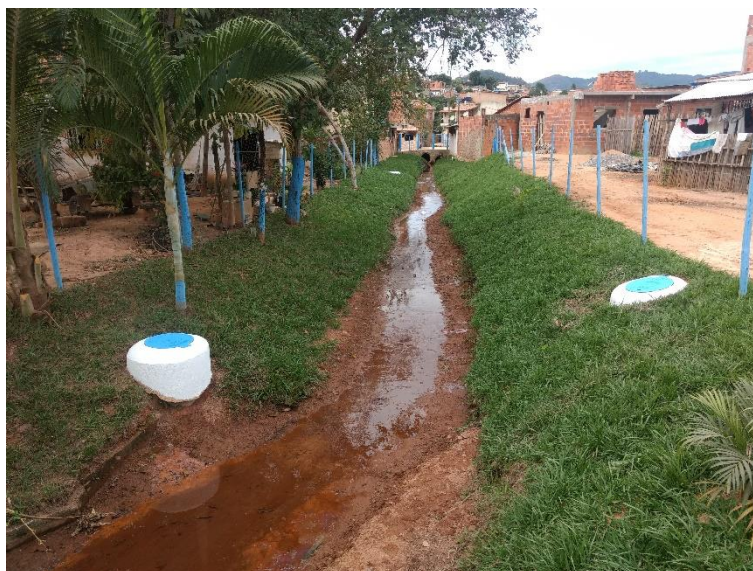
Figura 93 – Obras de coleta de esgoto finalizadas
