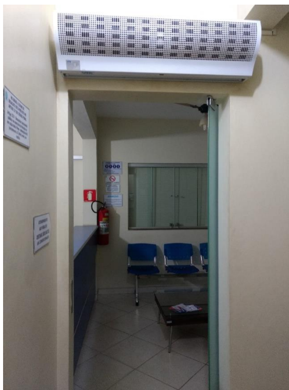
Figura 7 – Ambiente com Ar Condicionado no Atendimento Comercial
