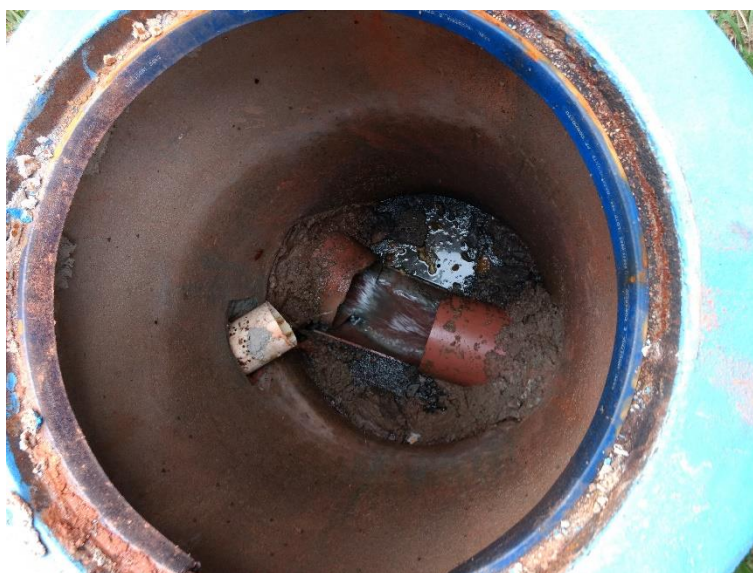
Figura 95 – Poço de Visita das obras realizadas
