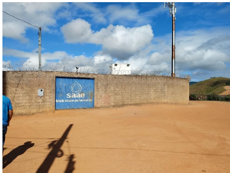
Figura 83 – Área Externa – Reservatórios Bela Vista
