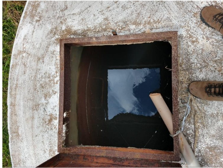
Figura 32 –Chegada da água Captada no Córrego Cobrador
