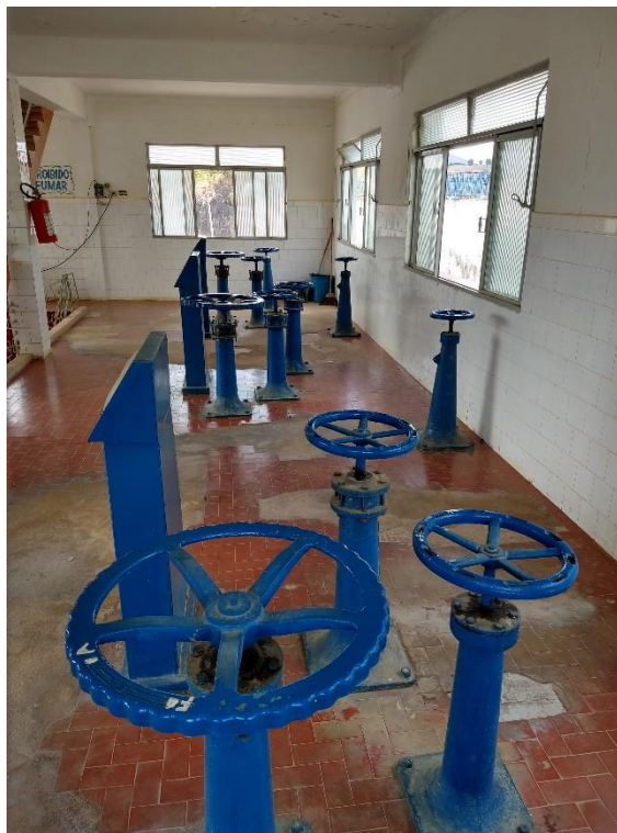
Figura 52 – Registros - ETA Tabuleiro
