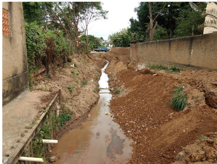
Figura 91 – Obras para coleta do esgoto
