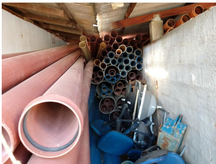
Figura 76 – Armazenamento de Tubos - ETA
