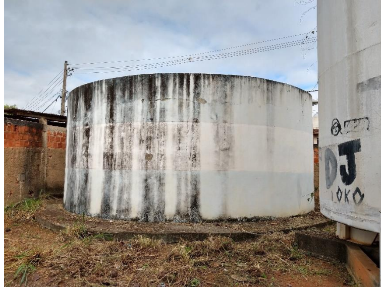
Figura 82 – Reservatório Nova Cidade
