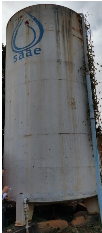
Figura 80 – Reservatório Nova Cidade
