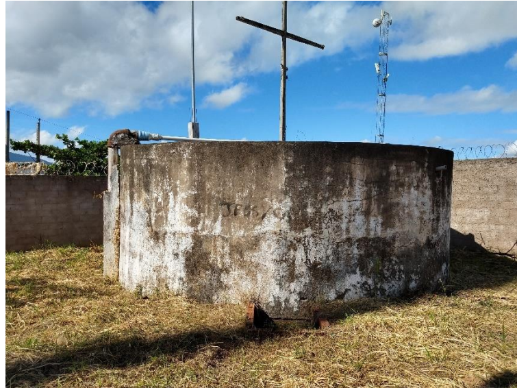
Figura 84 –Reservatório Bela Vista
