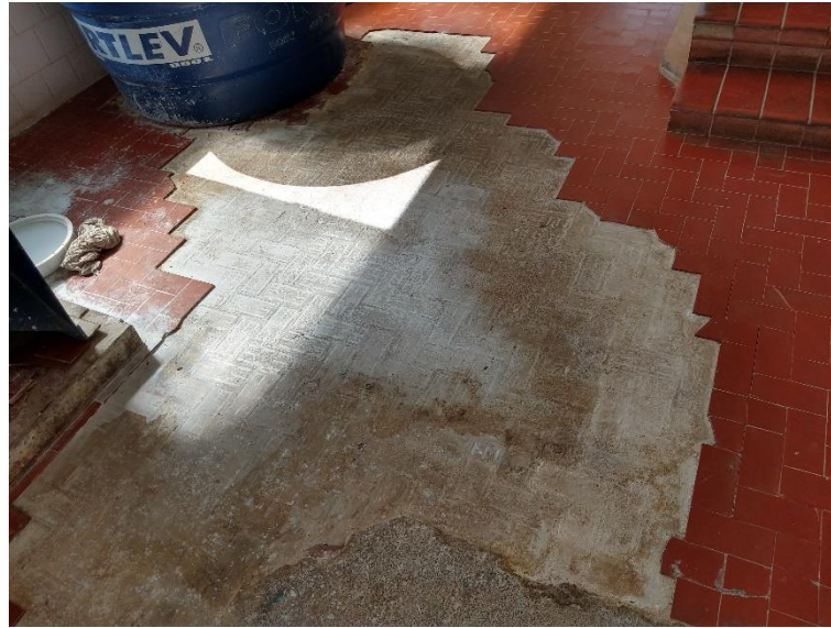
Figura 57 – Piso da ETA Tabuleiro
