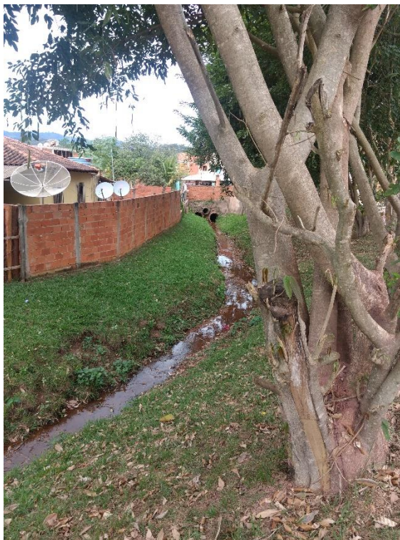
Figura 92 – Obras de coleta de esgoto finalizadas
