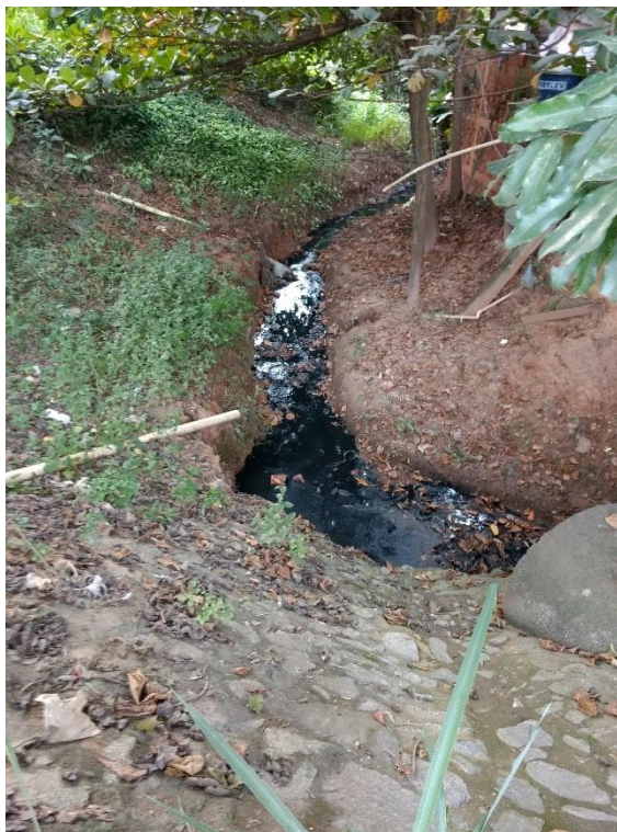
Figura 89 – Descarte de esgoto doméstico no Córrego Maria Pinto
