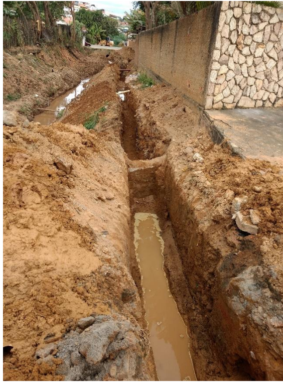
Figura 90 – Obras para coleta do esgoto
