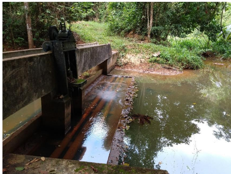
Figura 16 – Captação Córrego Tabuleiro - Barragem
