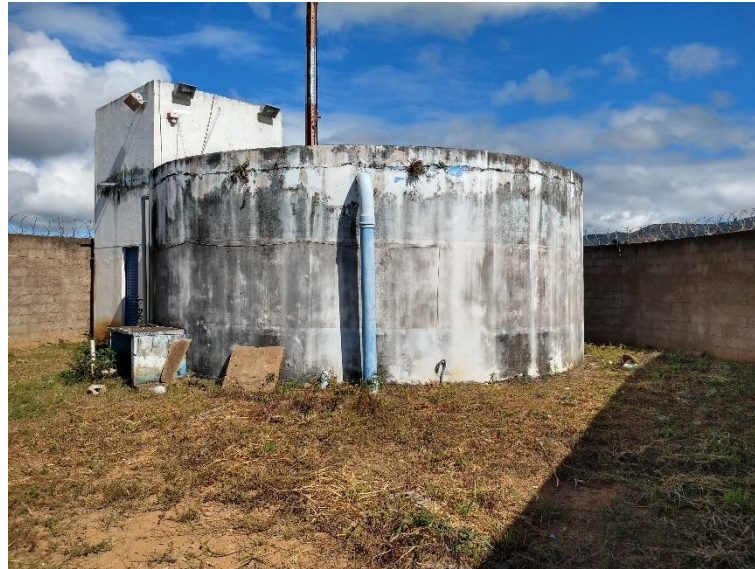
Figura 86 –Reservatório Bela Vista
