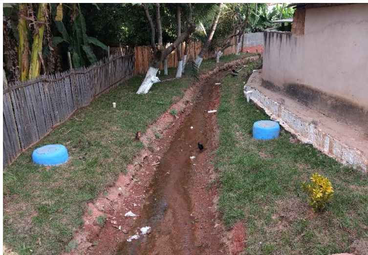
Figura 94 – Obras de coleta de esgoto finalizadas
