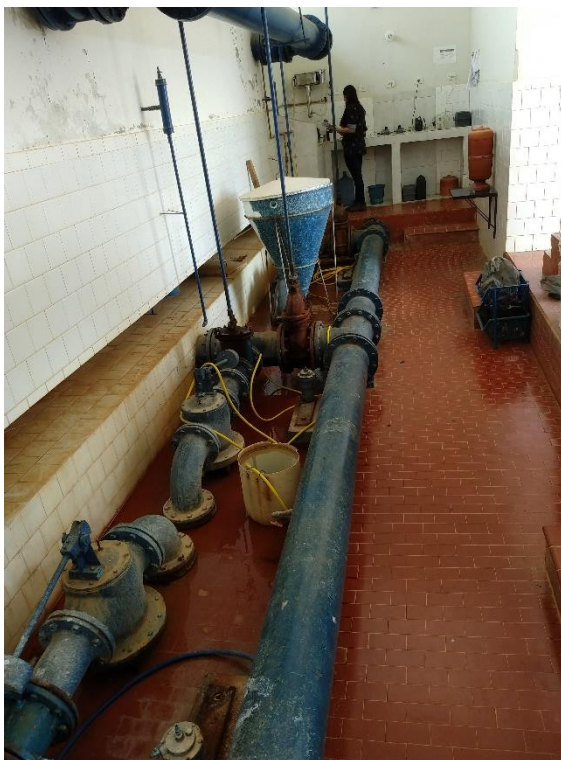
Figura 49 – Registros - ETA Tabuleiro
