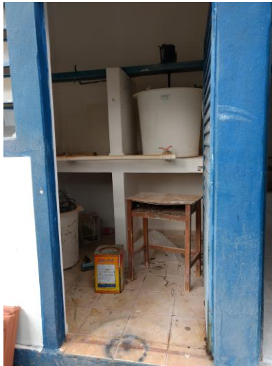
Figuras 36 e 37 – Preparo e dosagem do hipoclorito de cálcio, respectivamente.
