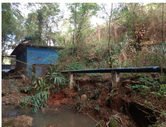
Figuras 11 e 12 – Placa de restrição de acesso na entrada e caixa de passagem e tubulação responsável por levar a água por gravidade até a casa de bombas.
