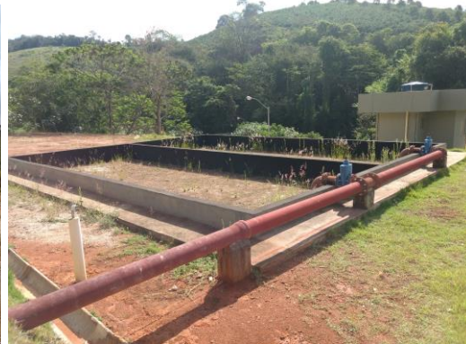
Figuras 42 a 45 – ETE do município. Chegada do esgoto, tratamento preliminar, filtro anaeróbico e leito de secagem.
