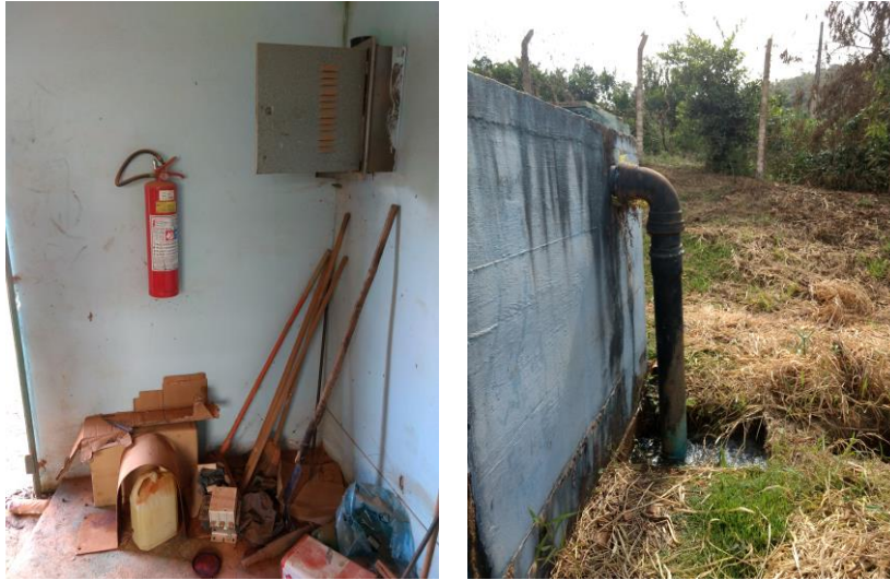
Figuras 14 a 17 – Casa de bombas.
