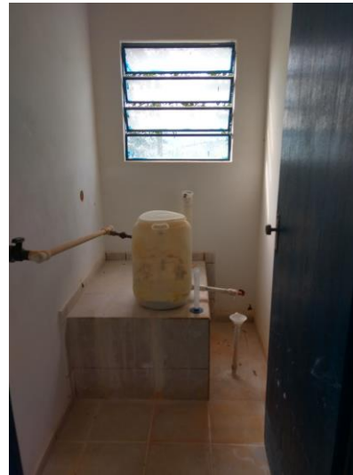
Figuras 36 e 37 – Preparo e dosagem do hipoclorito de cálcio, respectivamente.
