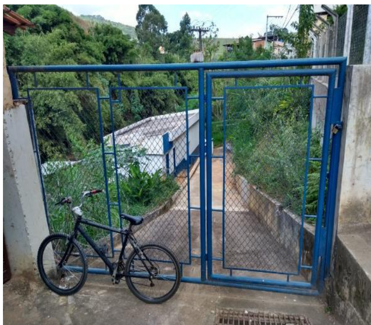
Figura 6 – Acesso a Captação do Rio Manhuaçu
