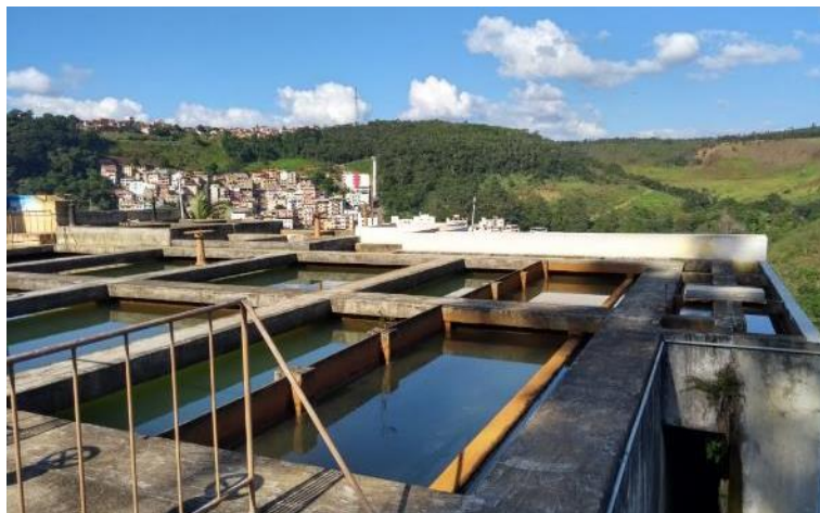
Figura 31 - Estrutura da ETA - Sede
