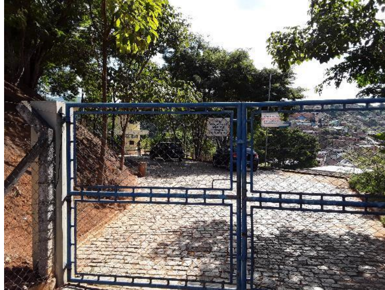
Figura 106 – Entrada da ETA de São Pedro do Avaí
