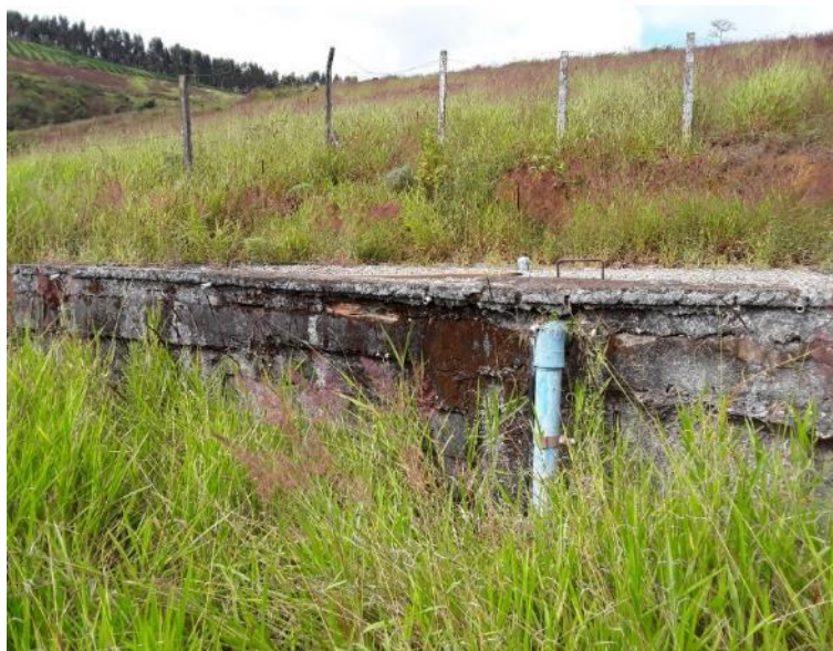
Figura 97 - Reservatório semienterrado feito em concreto
