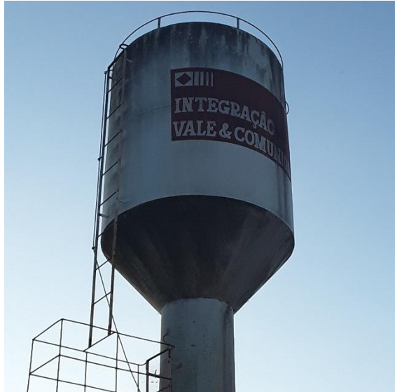
Figura 160 – Reservatório – Bom Jesus da Realeza
