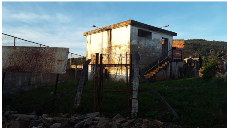
Figura 150 – Casa de bomba da quadra no SAA Fiscalizado
