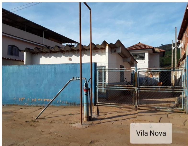
Figura 140 – Poço 1 localiza-se em área pública sem qualquer tipo de proteção
