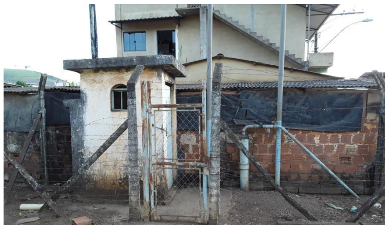
Figura 141 – Poço 2 – Vila Nova
