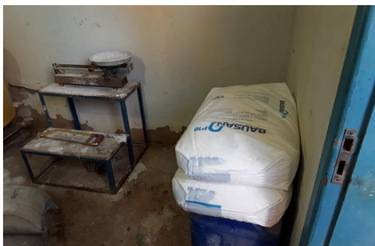
Figura 145 – Armazenamento inadequado de produtos químicos na ETA
