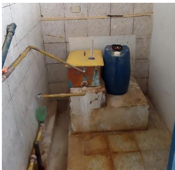
Figura 67 - Casa de Química na ETA de Dom Corrêa
