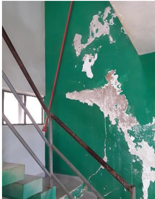
Figura 113 – Estrutura da ETA – SAA São Pedro do Avaí
