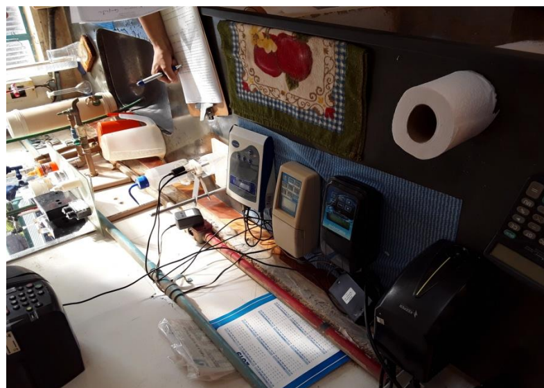
Figura 144 –Bancada no laboratório da ETA de Vila Nova
