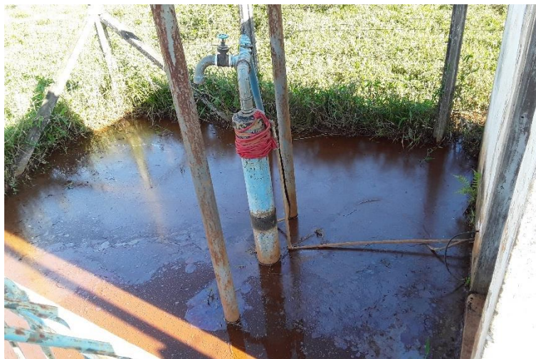
Figura 155 – Captação – Vila Formosa
