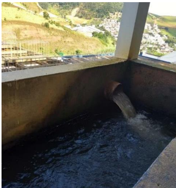
Figura 26 - Local de Chegada das águas das captações
