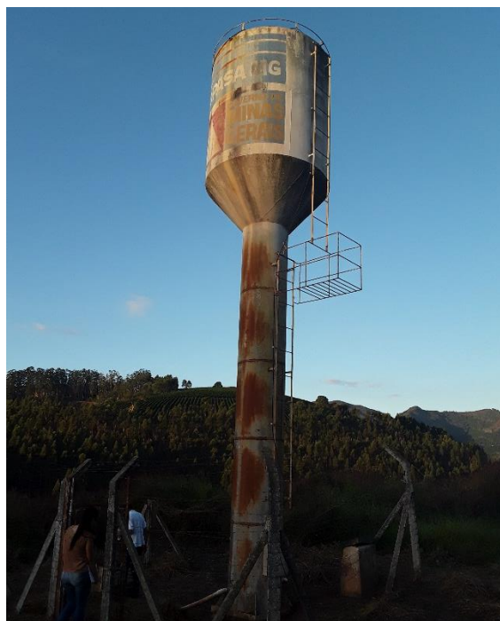
Figura 161 – Reservatório – Bom Jesus da Realeza
