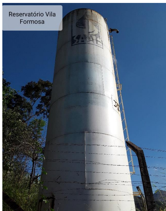
Figura 156 – Reservatório – Vila Formosa
