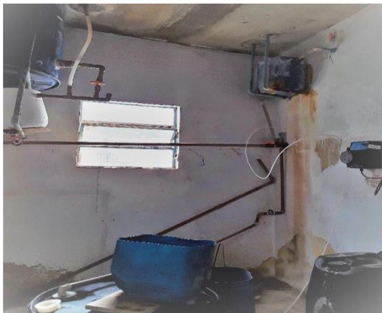
Figura 94 - Dosadores de Hipoclorito de cálcio e fluossilicato de sódio
