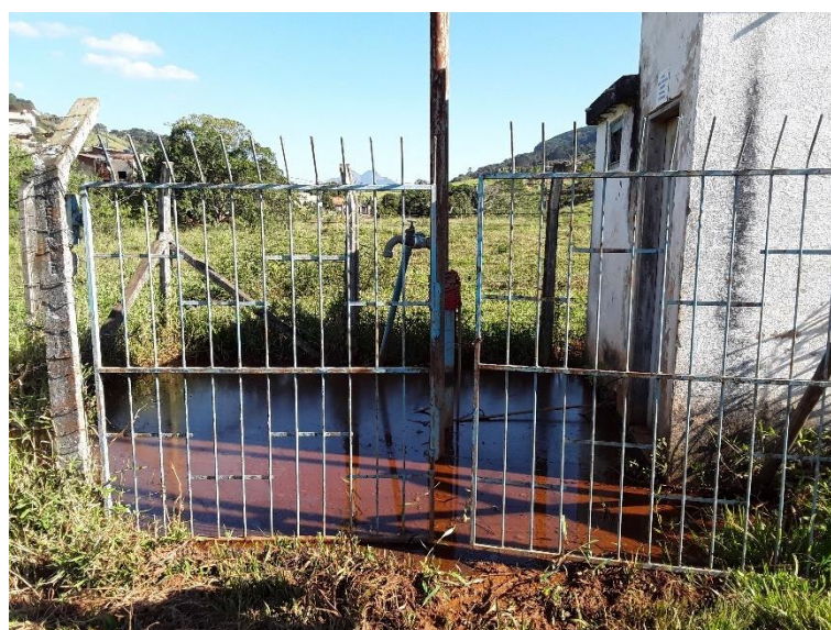
Figura 154 – Captação – Vila Formosa
