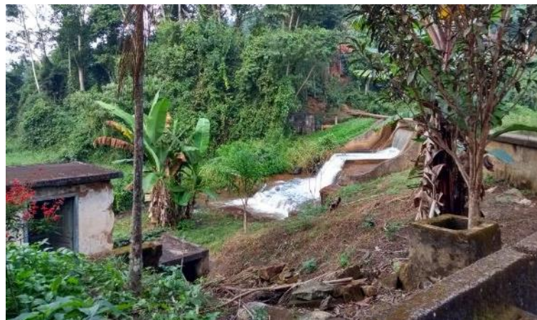
Figura 17 - Captação no Córrego São Sebastião
