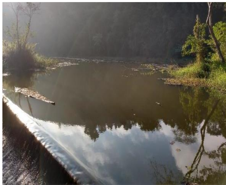
Figura 16 - Barramento - Captação no Córrego Manhuaçuinho
