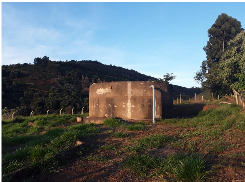
Figura 152 – Reservatório 250m 3 no Distrito de Vila Nova
