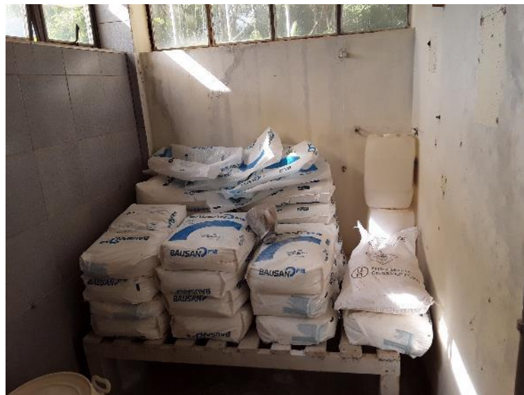
Figura 114 – Armazenamento de CAL – SAA São Pedro do Avaí
