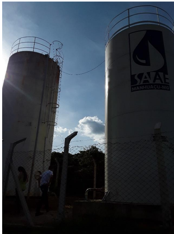
Figura 122 – Reservatórios de estrutura metálica – SAA São Pedro do Avai
