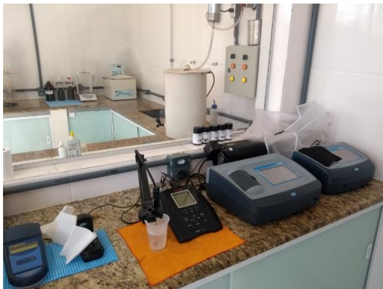
Figura 39 – Equipamentos de controle - ETA Sede
