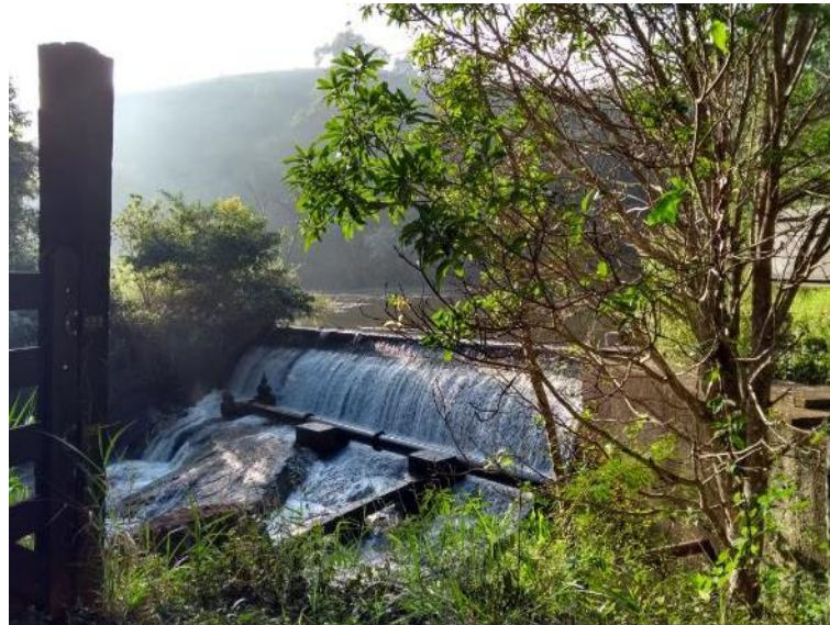
Figura 15 - Captação no Córrego Manhuaçuinho
