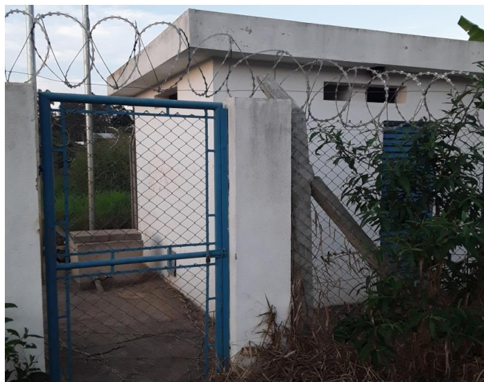
Figura 142 – Poço 3 na localidade fiscalizada
