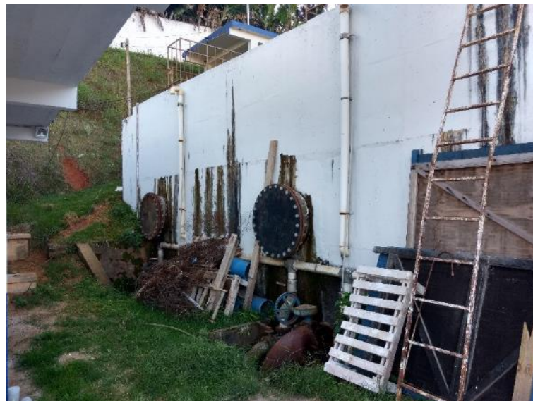
Figura 44 – Área externa – ETA SEDE
