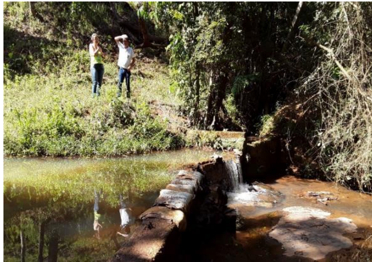
Figura 63 - Manancial onde é feita captação de água no Distrito de Dom Corrêa
