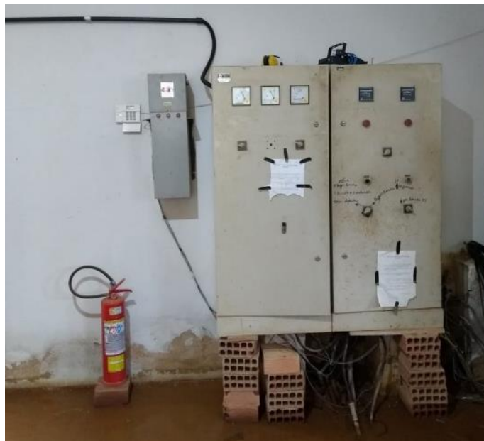
Figura 12 – Extintor de incêndio – Captação Manhuaçu
