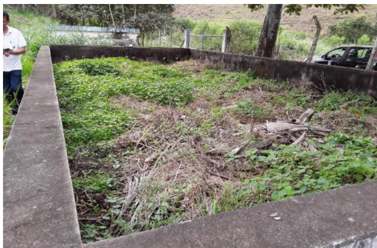
Figura 172 - Vegetação rasteira encontrada no leito de secagem de lodo na ETE de Realeza
