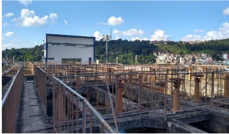
Figura 30 - Estrutura da ETA - Sede
