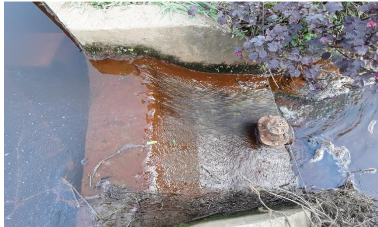
Figura 138 – Captação de água bruta do SAA local
