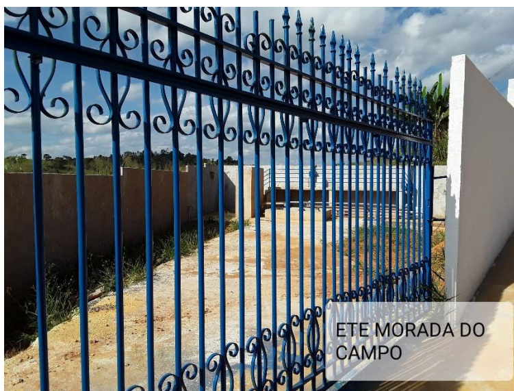
Figura 162 – ETE em Construção – Morada do Campo
