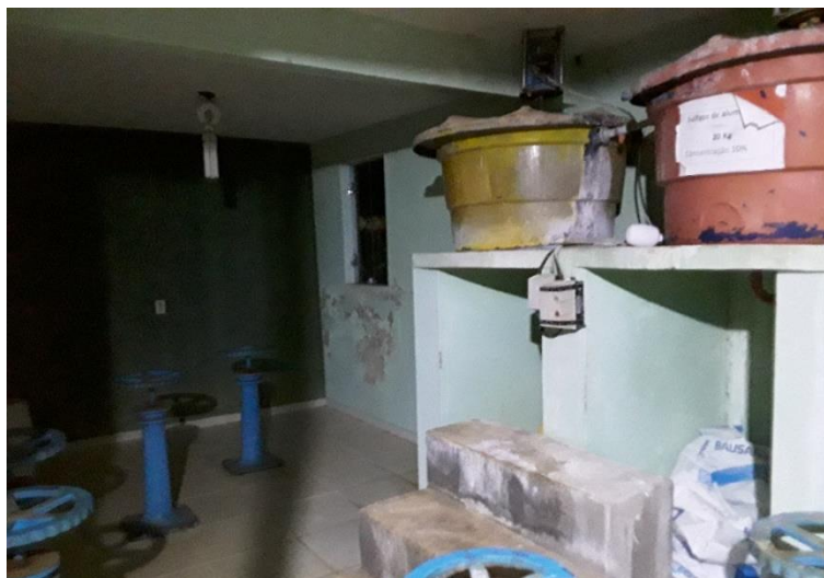
Figura 101 - Casa de Química na ETA de Santo Amaro de Minas.
