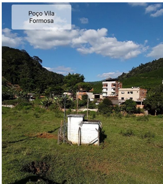
Figura 153 – Captação – Vila Formosa
