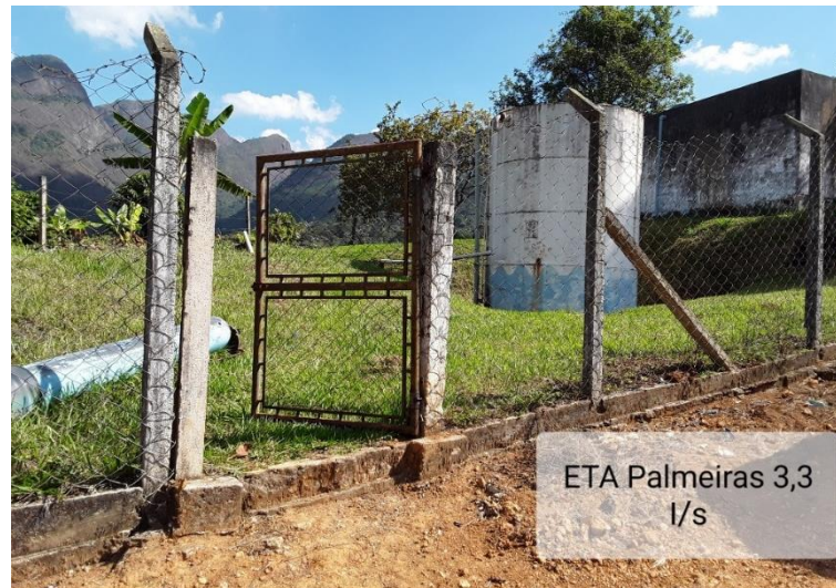
Figura 77 - ETA de Palmeiras do Manhuaçu
