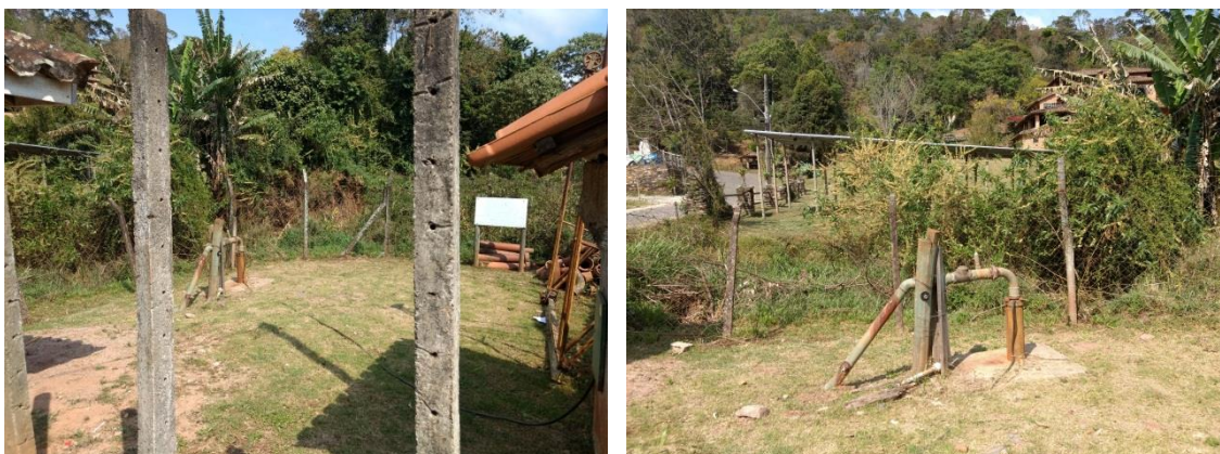
Figura 5 - Captação subterrânea no Rio Grande.
