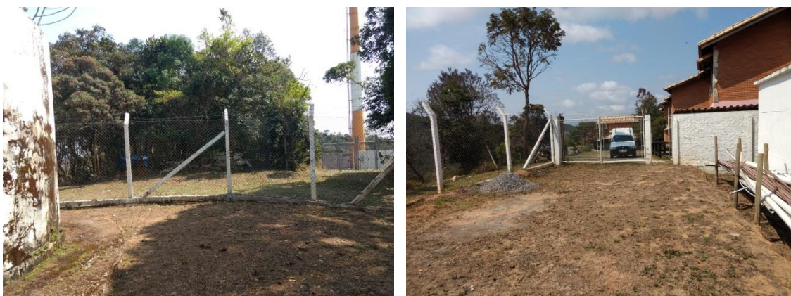
Figura 21 – Área externa da ETA.
