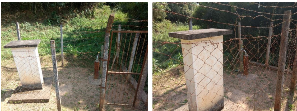
Figura 4 – Captação subterrânea no Rio Grande.
