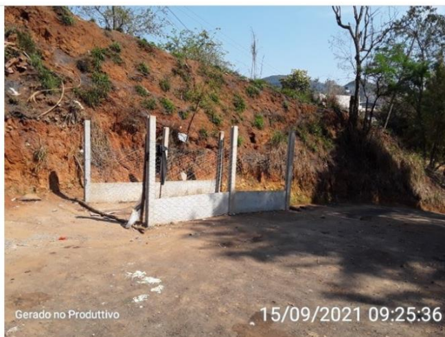
Área de transbordo do distrito de Dom Corrêa
