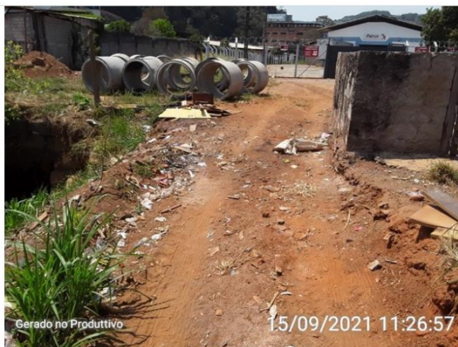
Área ao lado da estação de transbordo
