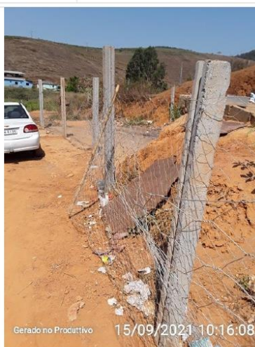
Cercamento da área de transbordo
