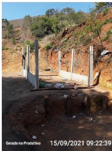
Área de transbordo do distrito de Dom Corrêa
