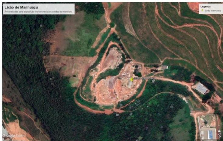
Área do lixão do município de Manhuaçu
