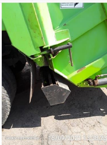
Calha coletora de chorume
