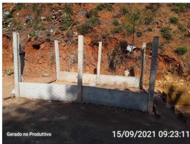
Área de transbordo do distrito de Dom Corrêa
