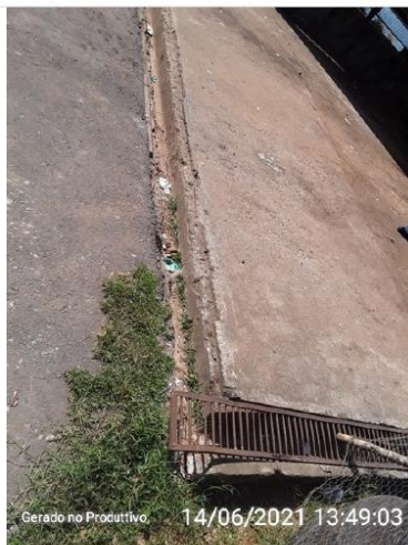
Calhas de Drenagem
