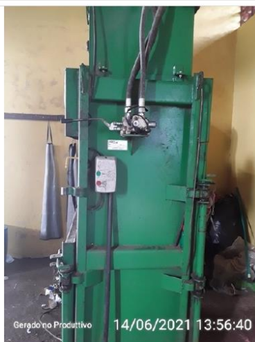
Parte elétrica da prensa hidráulica.
