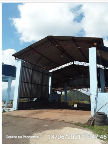
Altura do Galpão de Triagem
