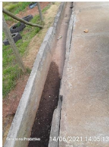
Canaletas no pátio.
