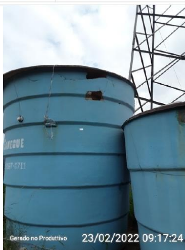
Estrutura do reservatório
