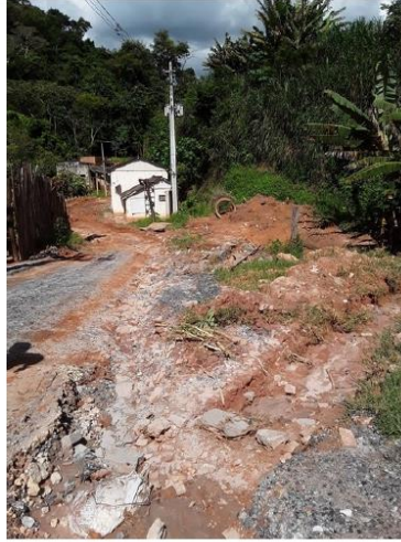
Acesso a EEAB
