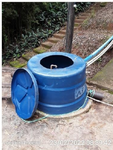
Tampa de inspeção
