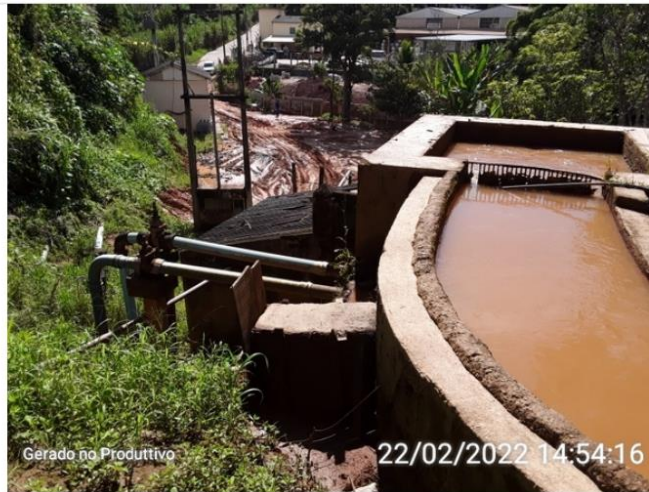
Sistema de gradeamento
