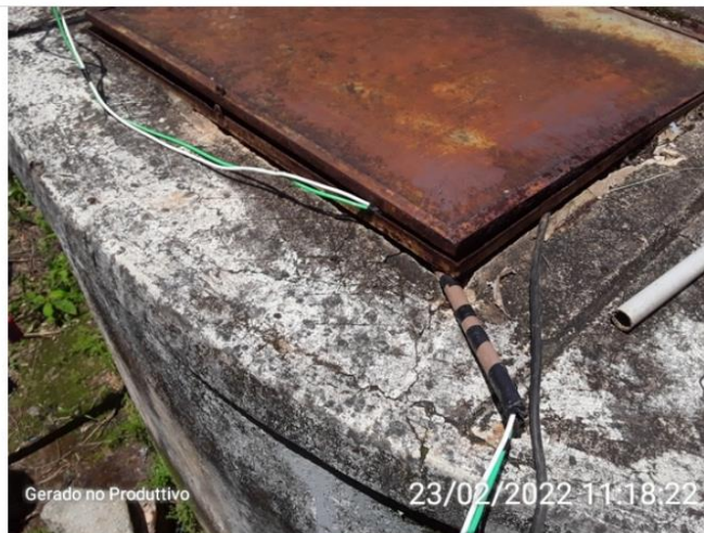
Tampa de inspeção
