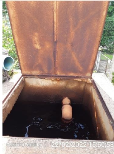
Tampa de inspeção
