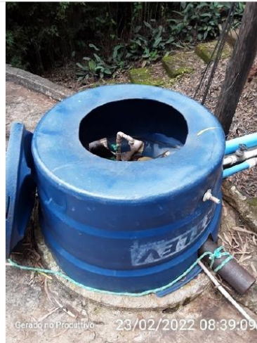
Tampa de inspeção
