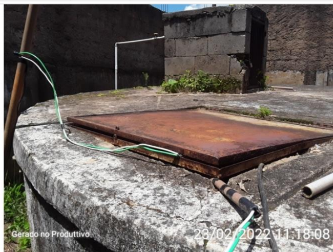
Tampa de inspeção
