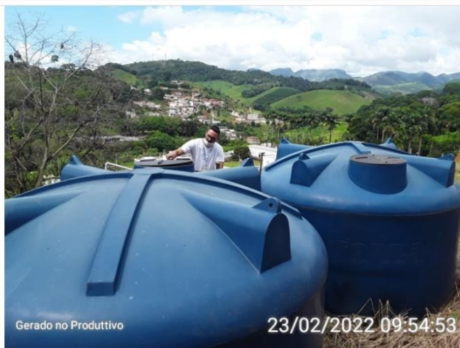
Cobertura do reservatório
