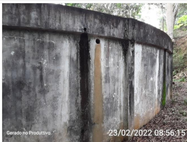
Estrutura do reservatório
