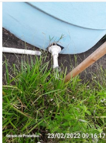
Tubo de descarga de fundo
