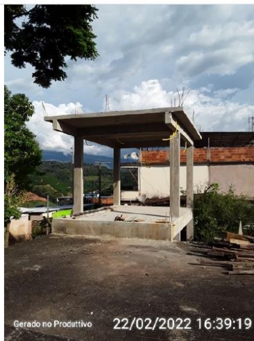
Estrutura para abrigar o reservatório
