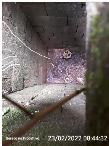
Descarga de fundo
