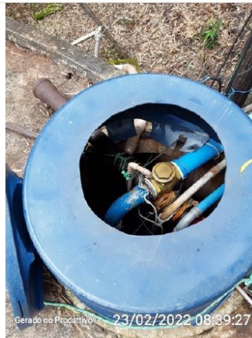
Tampa de inspeção
