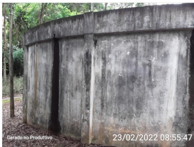
Estrutura do reservatório
