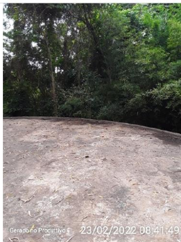
Cobertura do reservatório
