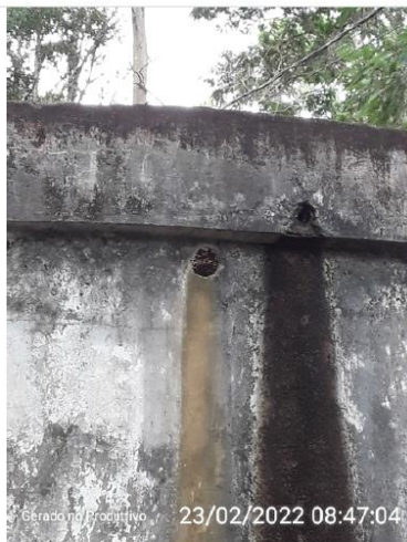
Aberturas de ventilação
