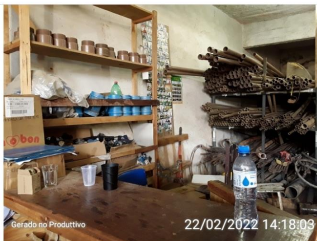
Armazenamento de materiais
