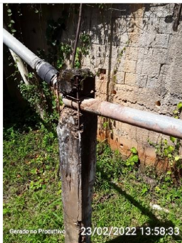
Apoio para a tubulação
