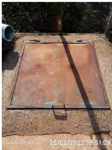
Tampa de inspeção
