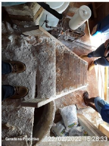
Escada para acesso a área de preparação de produtos químicos
