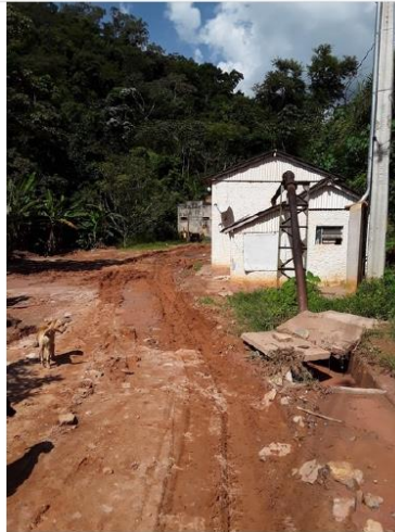
Acesso a EEAB
