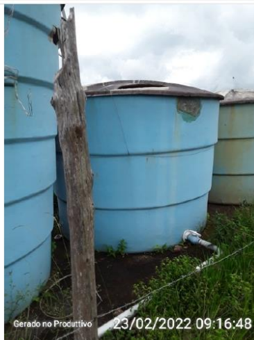
Tampa de inspeção
