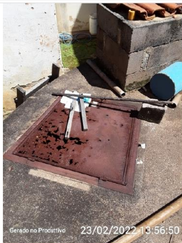
Tampa de inspeção
